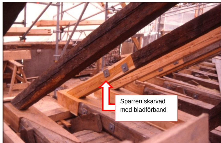
Figur 49 Skarvning med bladförband, exempel
