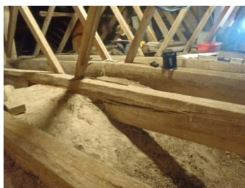
Figur 22 De takstolar som man har lagt så mycket möda på att hugga har senare kommit att döljas av murade valv. Fotot visar bindbjälkar som har huggits ur för att ge plats åt murverket då kyrkan valvslogs. Forshems kyrka. Foto: Bengt Bygdén.
