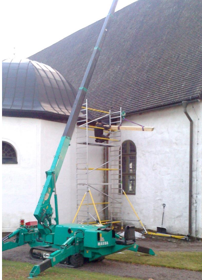
Nya bindbjälken till späntakstolen winchas in under takstolarna
