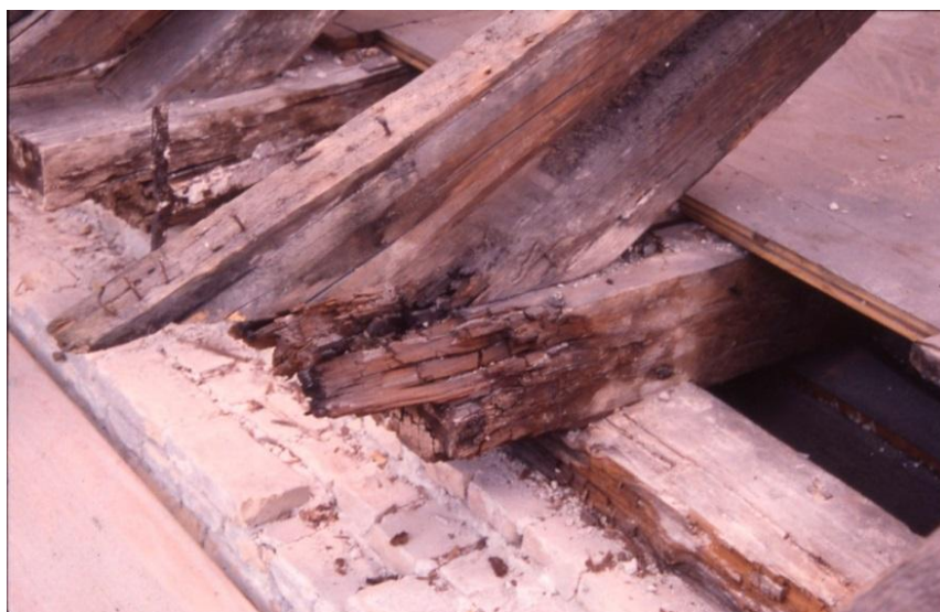
Figur 47 Rötskada, exempel.
