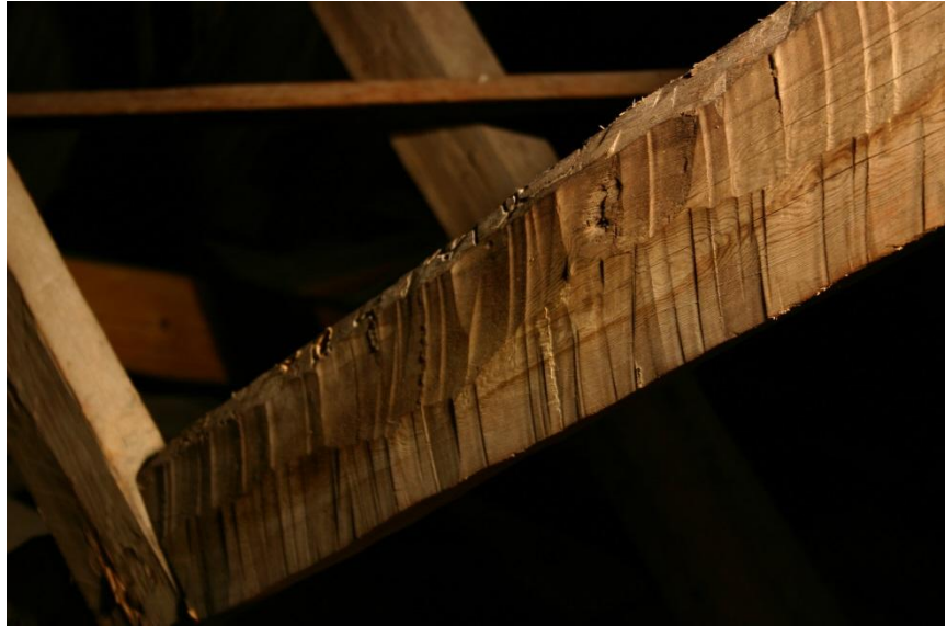
Figur 26 Det medeltida virket är framställt med yxa. Huggningen lämnar karakteristiska spår som kan studeras i släpljus. Figuren visar sprätthugget virke i Asby kyrka, Östergötland. Foto: Carl Thelin.
