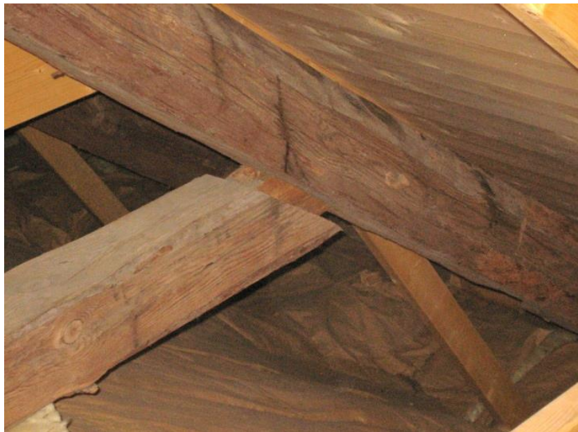
Figur 34 Isärdraget förband. Foto: Laine Montelin.
