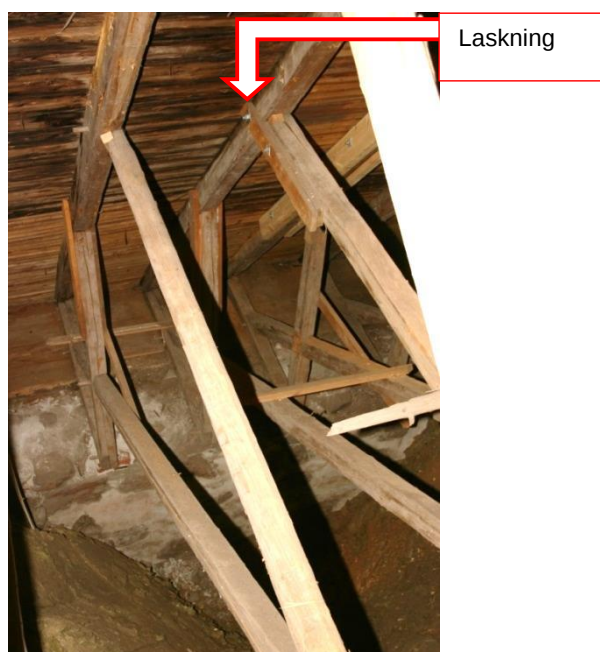
Figur 50 Lagning med laskning. Foto: Carl Thelin.
