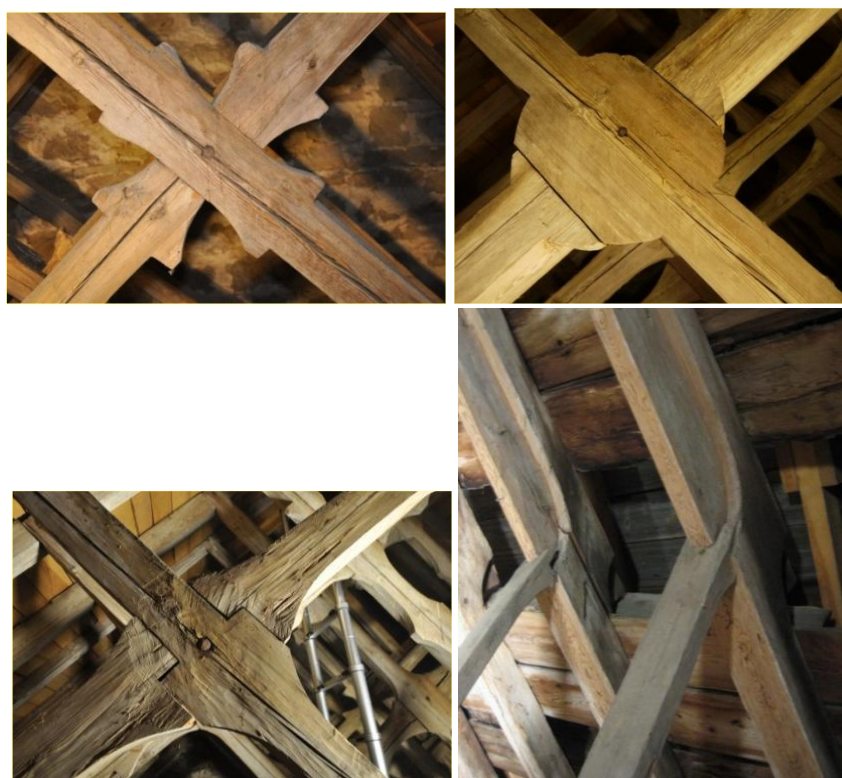
Figur 24 Man kunde konsten att skapa komplexa och dekorativa former med yxa ur ett enda virkesstycke redan under tidig medeltid. Överst och nere till vänster detaljer från Gökhem kyrka. Foto: Kristina Linscott. Nere till höger: möte mellan stödben och sparre i Garda kyrka, Gotland. Foto: Ylva Sandin.
