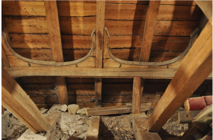
Figur 1 Redan på 1100-talet var träbyggnadshantverket högt utvecklat. Timmermännen kunde skapa omsorgsfullt utformade detaljer med ett fåtal verktyg. Timmerman Daniel Eriksson har tagit bilden ovan och berättar: "Figuren visar fint bearbetade bågnän (rotknän), ursprungligen 56 stycken. De är även dekorationsmålade och taklaget är dendrodaterat till ca 1123, Knista kyrka, Strängnäs stift."
