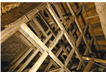
Figur 11 Den tidiga medeltidens kyrka avslutades uppåt av ett sadeltak som ofta hade omkring 45 graders lutning. Från kyrkorummet såg man takkonstruktionerna ända upp till taktäckningens insida. Takstolarnas delar bildade rutmönster, olika i olika kyrkor. Väversunda kyrka, Östergötland. Foto Carl Thelin
