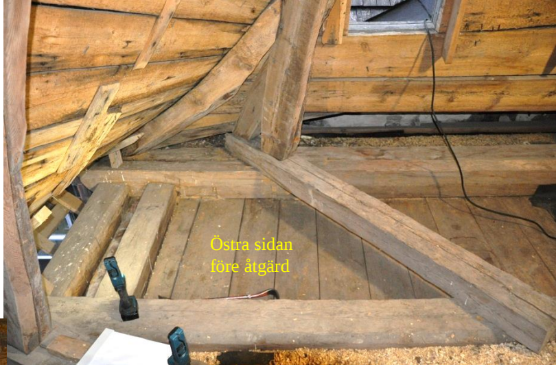
Takkonstruktionen från 1749 inhugget i hjärtstocken
