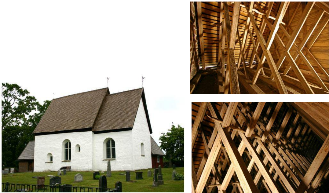
Figur 12 Jäts gamla kyrka, Småland. a) Sadeltak och taktäckning av trä (spån eller falor) var komponenter i den medeltida byggnadens yttre gestalt. b) Takkonstruktionernas intrikata ruttmönster som har varit synliga från kyrkorummet under tidig medeltid. Foto Carl Thelin.
