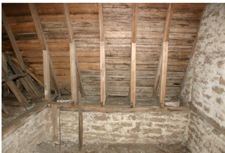
Figur 17 Taktro (grov träpanel) på takstolarna i Rogslösa kyrka, Östergötland. Foto: Carl Thelin.
