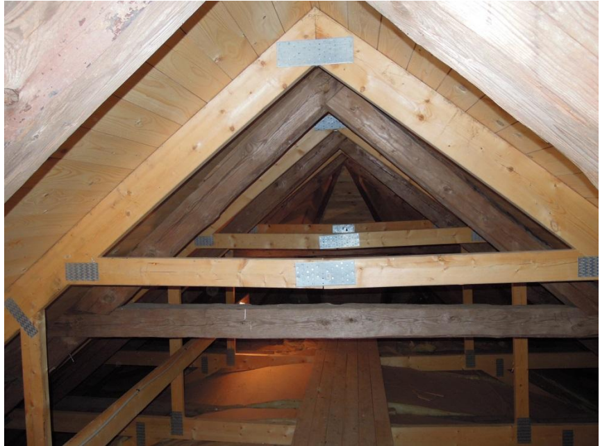
Figur 53 En kyrkvind där nya takstolar har byggts in och tar lasten, medan de gamla står kvar mer som museiförmål. Att bygga in nya bärverk bredvid de gamla kan tolkas som en varsam åtgärd: man sparar ju originalkonstruktionen. Å andra sidan påverkas upplevelsen av den gamla konstruktion starkt. Intrycket kan bli att timmermännen som byggde originalkonstruktionen inte har lyckats skapa extremt hållbara konstruktioner i det här fallet. Den gamla konstruktionen verkar inte tåla belastning. Intrycket hade troligen blivit annorlunda om man hade valt att återställa den gamla konstruktionens ursprungliga verkningssätt. Foto: Folke Höst/Laine Montelin.
