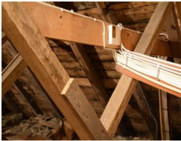
Kabeldragning. Foto: Robin Gullbrandsson
