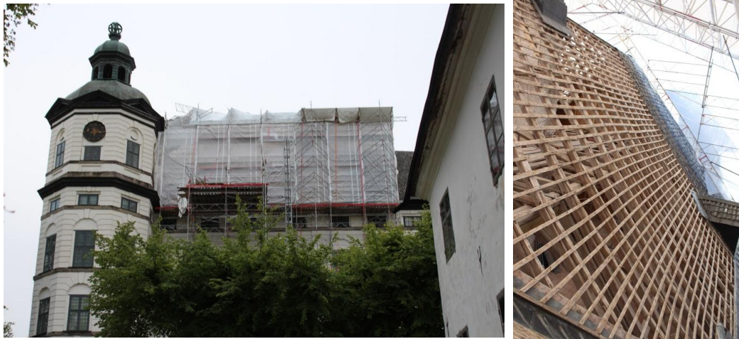
Figur 46 Väderskydd för takarbeten på Skoklosters slott. Förutsättningar ges för en bättre arbetsmiljö. Foto: Carl Thelin.
