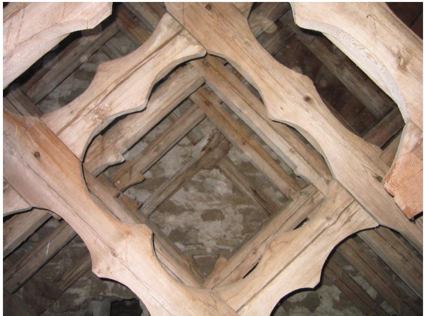
Figur 2 Vissa tidiga takkonstruktioner är dekorativt huggna och kan betraktas som träskulpturer. De är byggda för att synas från kyrkorummet. Gökhem kyrka. Foto: Carl Thelin.
