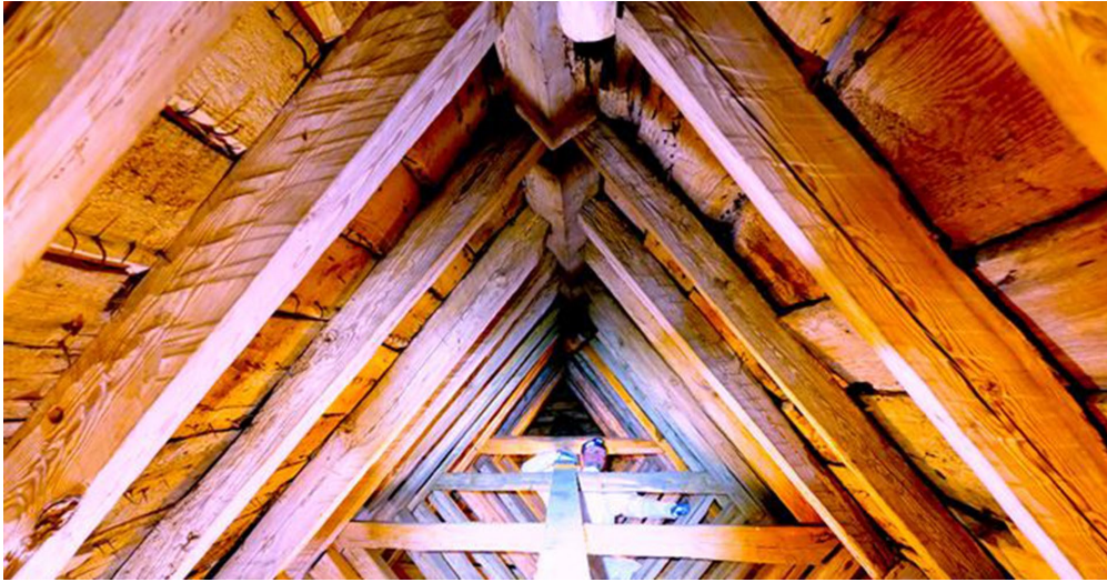
Ett fördjupningsprojekt under 2020-2021 har resulterat i rapporten "Medeltidens glömda rum – nya studier av taklag och torn i Skara stifts kyrkor". Foto: Mattias Hallgren
