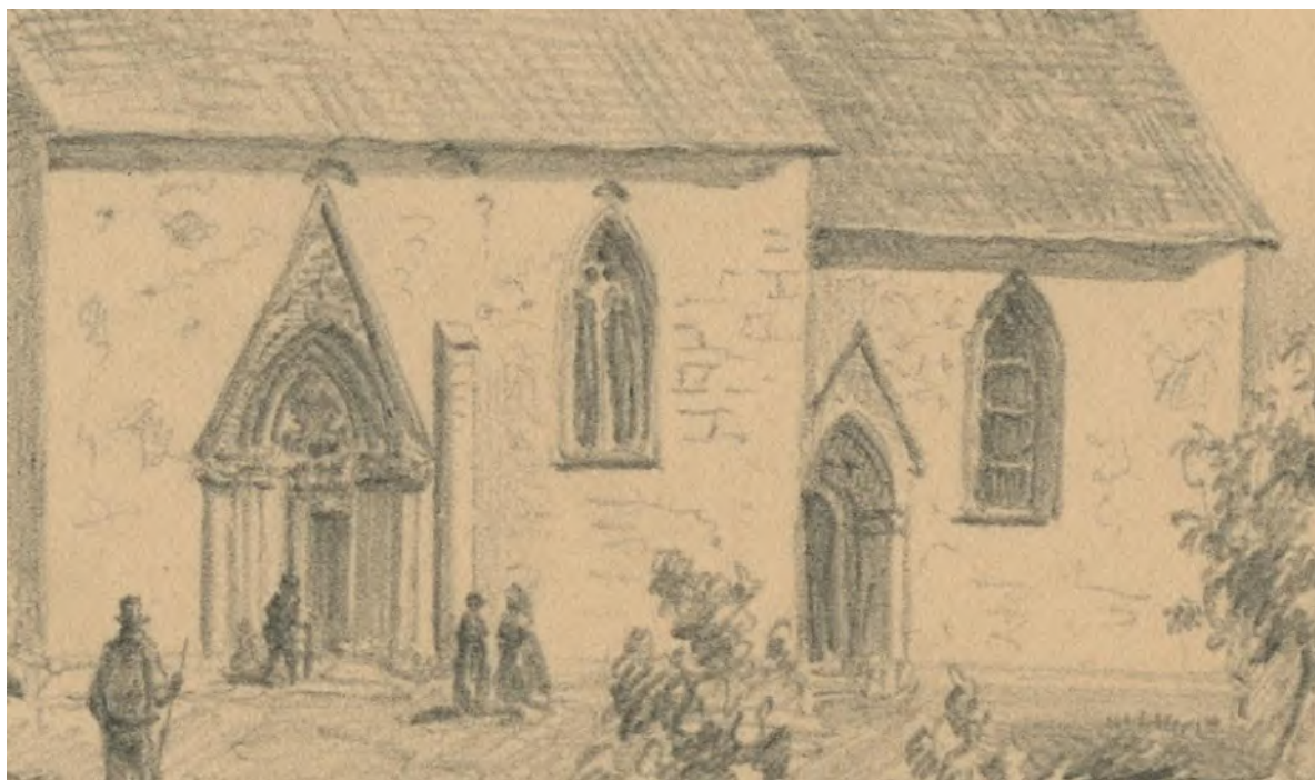
Detalj av Säves teckning från 1852, visande masverkens skick innan de restaurerades på 1860- eller 1880-talet, samt murverket med synliga inmurade äldre fönsteromfattningar.
