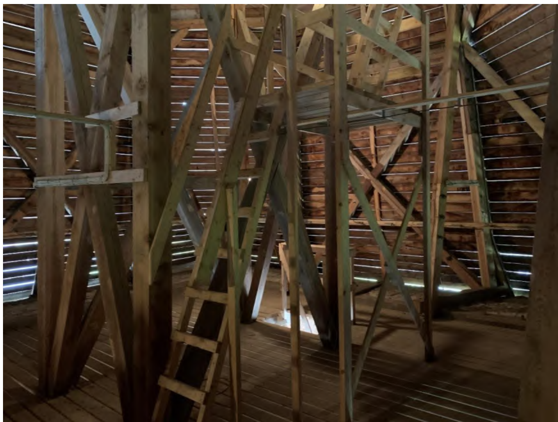
Tornhuvens nedre del, sedd mot sydväst. Foto JL 2020.
