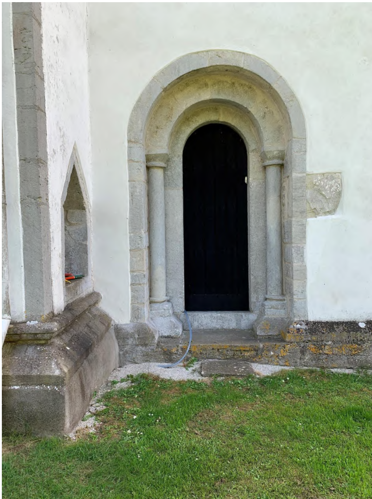
Tornets nordportal. Foto JL 2020.
