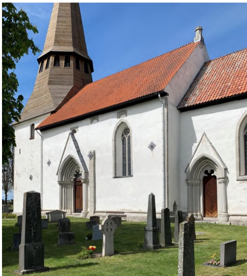
Sydfasaden från sydöst. Foto JL 2020.
