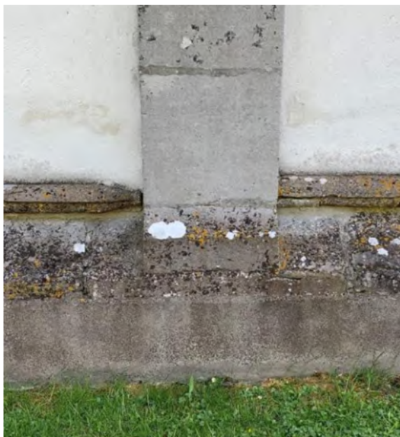
Kontreforten på norra långhusfasaden. Bas och anslutning till långhusets sockel. Foto JL 2020.
