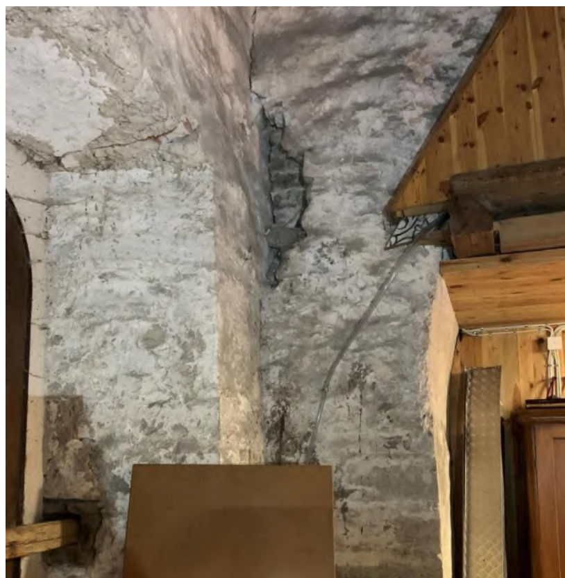
Tornets bottenvåning. Rummets nordöstra del sedd mot öster. Till vänster nordportalens, till höger tornbågen. Urgröpningen i murverket visar hur tornets mur till vänster har fortsatt österut utan avbrott vidare i det lika breda tidigare långhuset. Foto JL 2020.
