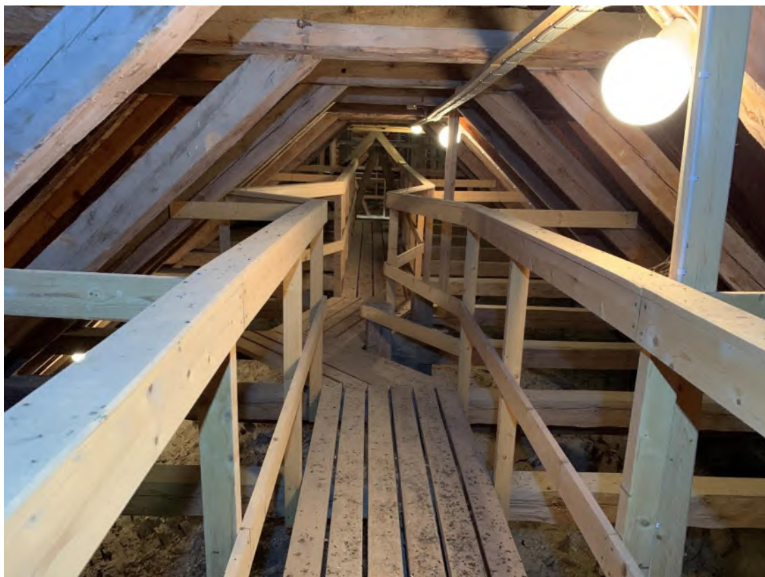
Långhusvindens övre del sedd mot väster. Foto JL 2020.
