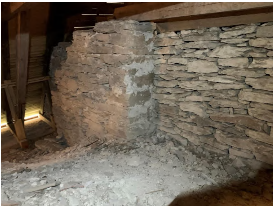
Igenmurning mellan tornets andra övervåning och långhusvinden, sedd från långhusvinden mot sydväst. Foto JL 2020.
