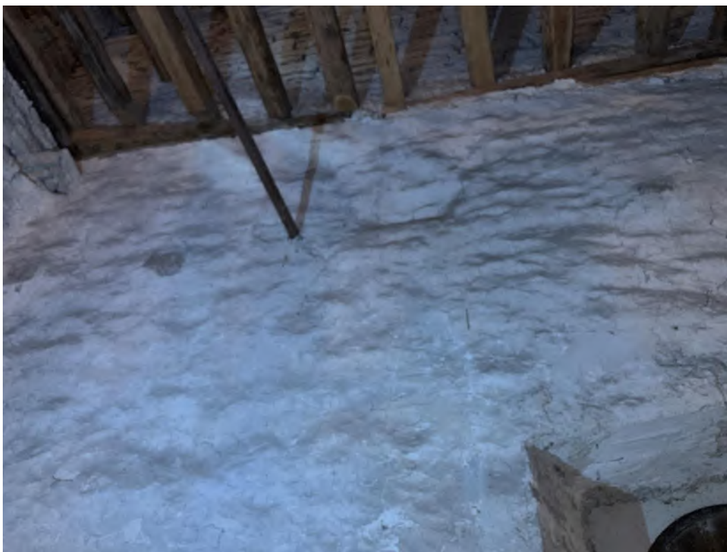
Tornets bottenvåning, sedd uppåt mot norr. I bildens mitt visar muren platsen för en valvkonsol. I den vänstra kanten anas ett valvanfang i rummets nordvästra hörn. Foto JL 2020.
