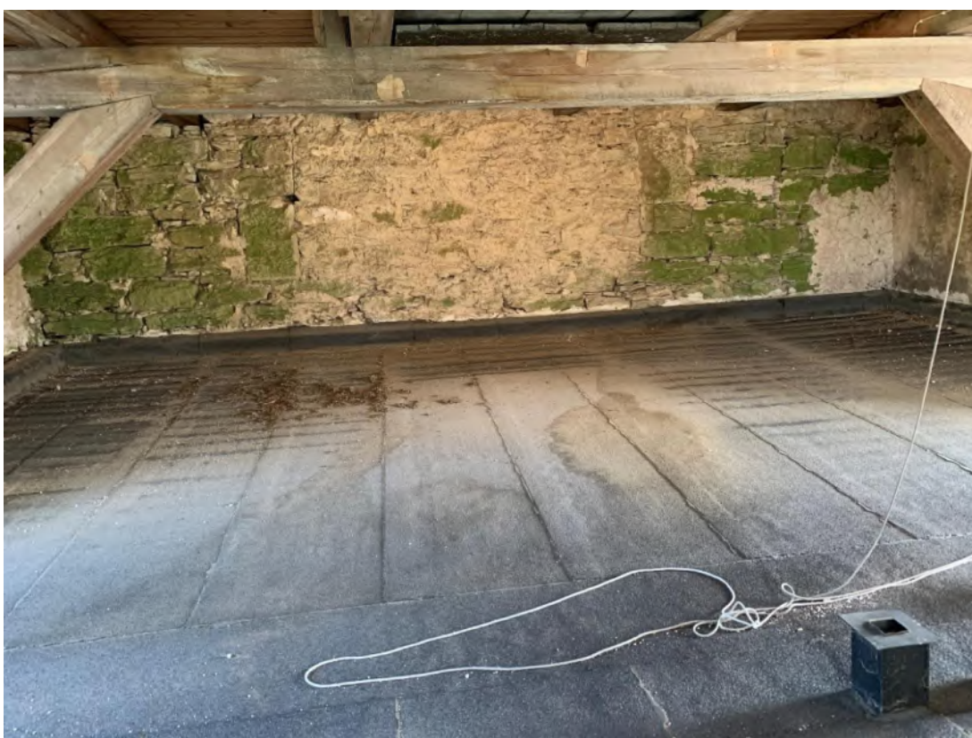
Tornets andra övervåning mot öster med igenmurad tidigare öppning mot nuvarande långhusvinden. Foto JL 2020.
