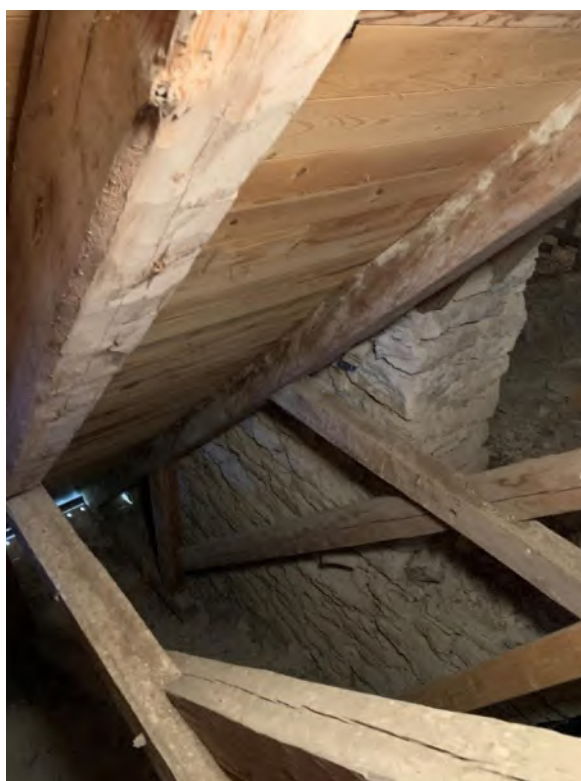
Triumfbågmurens röste. Den murade öppningens bärande högben sett mot norr med äldre panelbrädor. Till höger triumfbågmuren röste, södra delen sedd från korvinden. Foto JL 2020.
