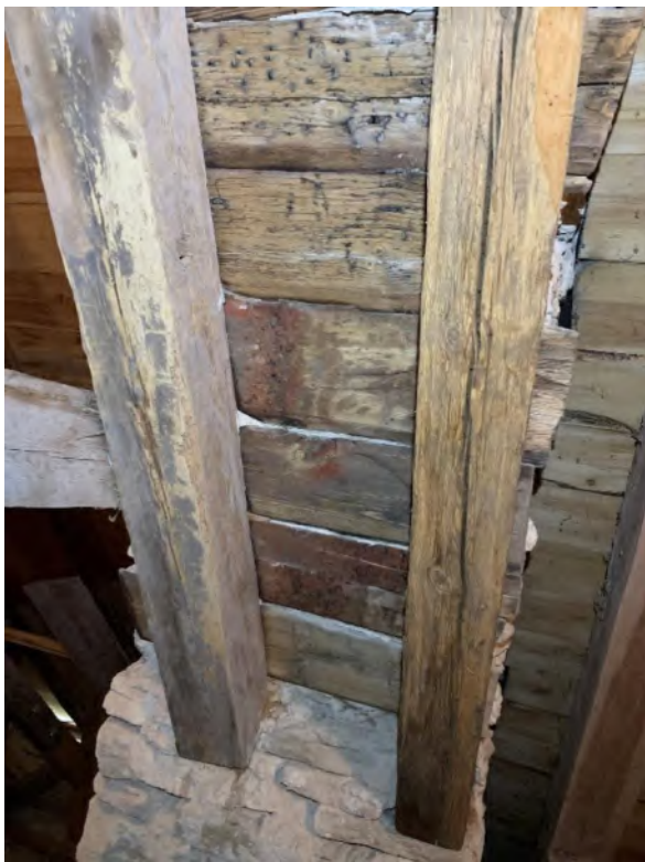
Triumfbågmurens röste. Den murade öppningens bärande högben sett mot norr med äldre panelbrädor. Till höger triumfbågmuren röste, södra delen sedd från korvinden. Foto JL 2020.
