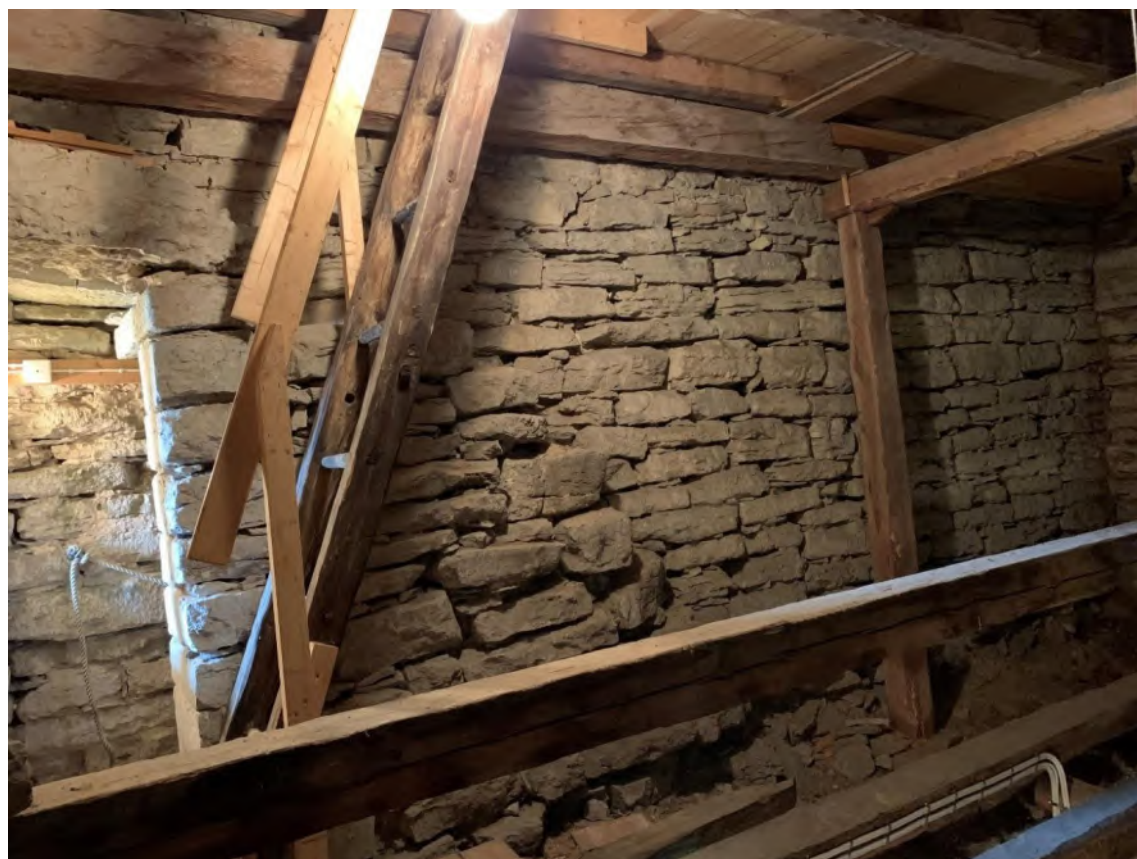
Tornets första övervåning mot väster. Den västra muren är tunnare ovanför bjälklaget, men bredare vid murtrappans mynning. Foto JL 2020.
