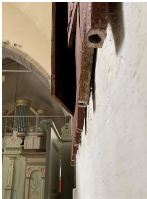
Sakramentsskåpet invändigt samt den nedre foderbrädan sedd underifrån med tapphål under varje båganfang, möjligen för kolonner som med bågarna bildat en arkad. Det kan inte uteslutas att brädan är äldre än fronten och återanvänd från annat sammanhang. Foto JL 2020.
