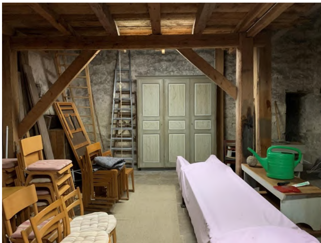
Tornets bottenvåning, interiör mot väster. Foto JL 2020.
