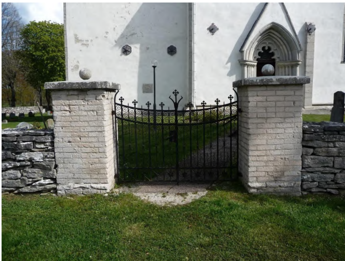
Ingången i söder med en vacker grind i smidesjärn och stolpar i murad kalksten med klot. Foto ES 2020.
