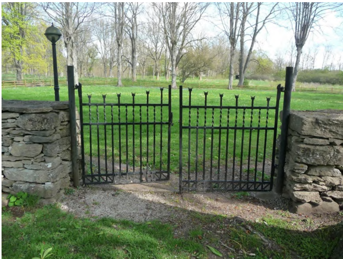
Ingången från norr har en järngrind i smidesjärn och järnstolpar. Foto ES 2020.
