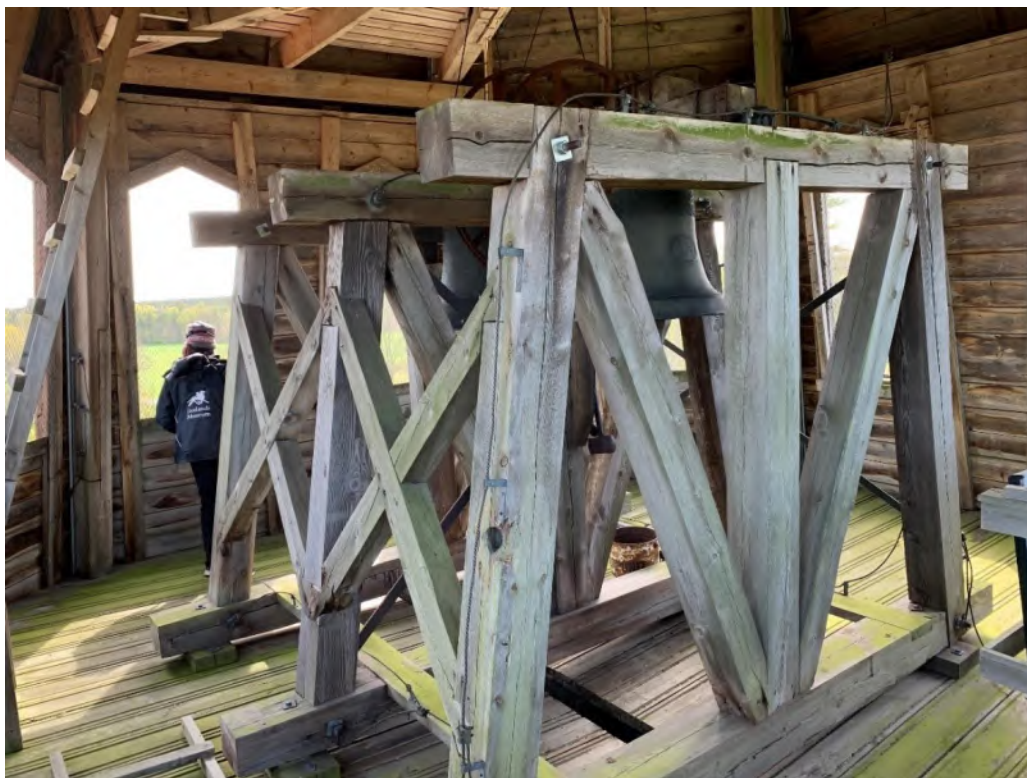
Klockvåningen mot sydväst. Foto JL 2020.
