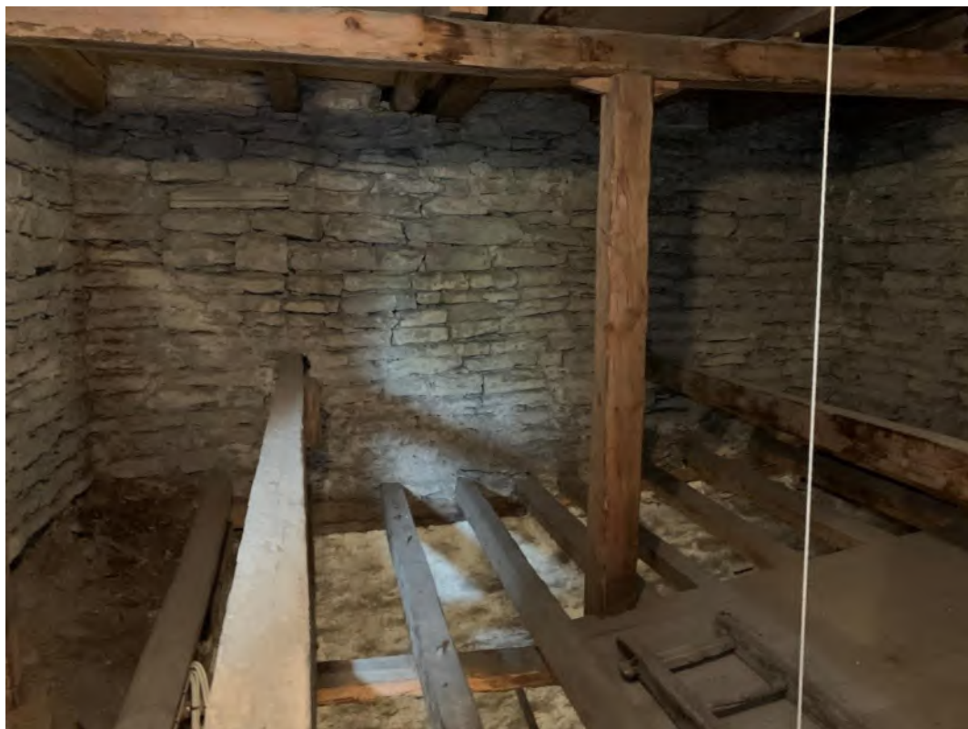
Tornets första övervåning mot norr. Foto JL 2020.
