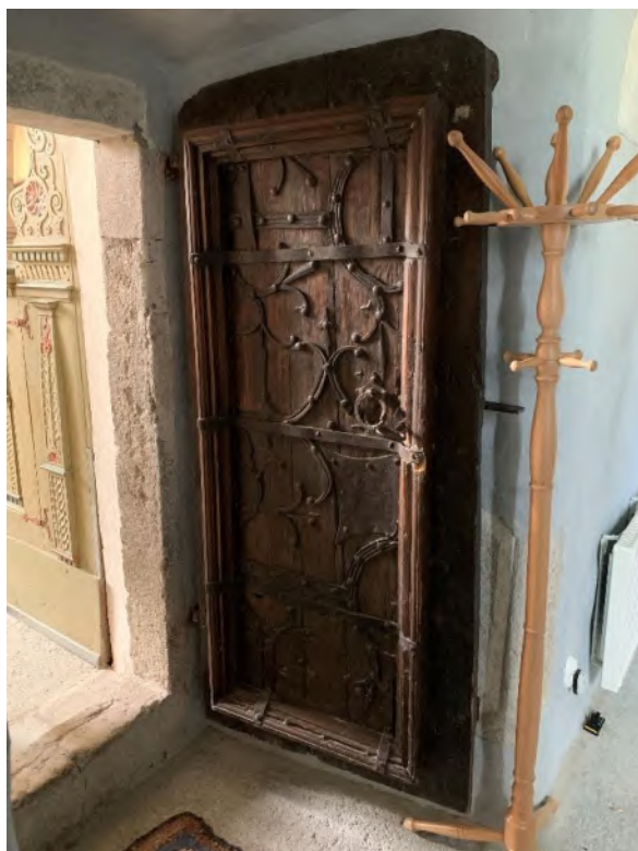
Sakristiedörren med medeltida järnbeslag. Dörren troligen formad av delar till en dörr i en större portal. Foto JL 2020. Till höger reliefhugget block i sakristieingångens innersmyg. Foto Rebecka Svensson 2008, Visby stift.
