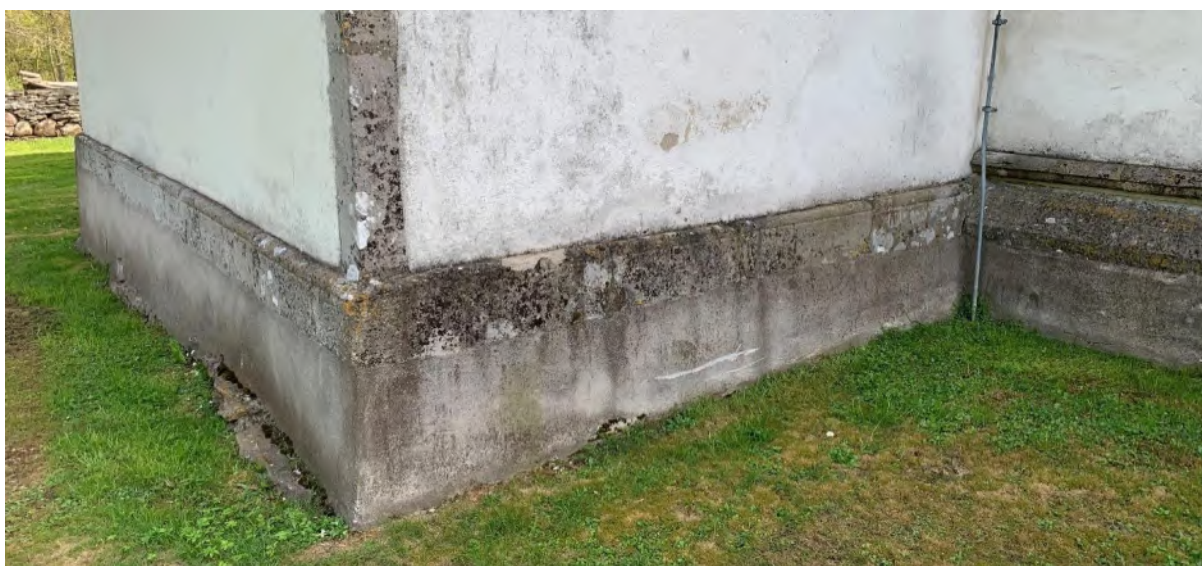
Kontreforten på norra långhusfasaden. Bas och anslutning till långhusets sockel. Foto JL 2020.
