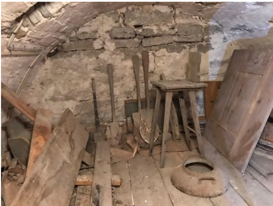
Tornets första övervåning mot öster. Foto JL 2020.
