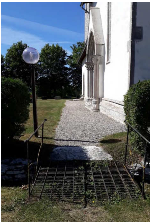
Den östra ingången med en färist (järngaller) och räcken. Foto ES 2020.
