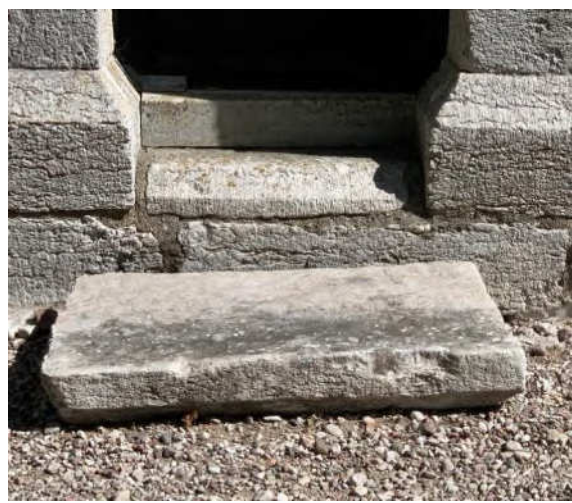
Tornets nedre del från väster samt trampstenar i tornportalen, den närmast troligen altarsten, därovanför del av rundad sockel från en absid, vilken visar att kyrkan hade sådan. Foto JL 2020.
