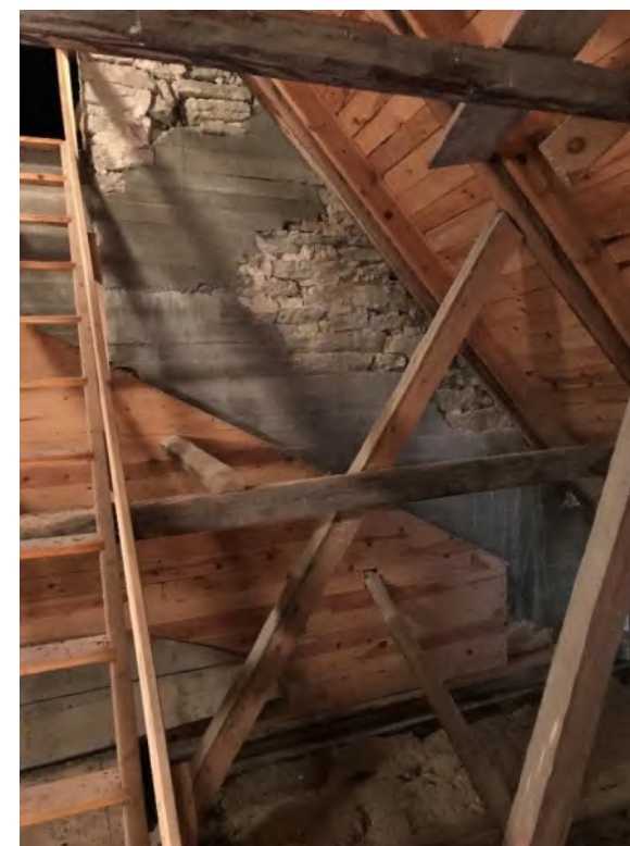
Triumfbågmuren sedd mot öster och sydöst. Gavelröset förstärkt med betong 1965. Foto JL 2020.
