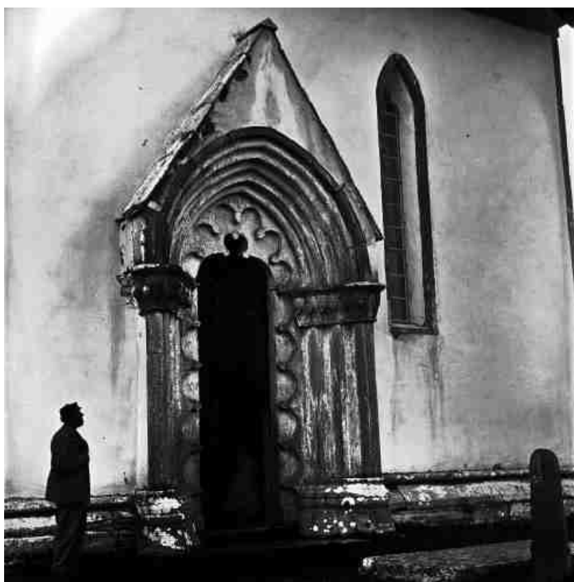
Korportalen och korets södra fönster från sydväst under senare delen av 1800-talet. Kolonnetter saknas och delar av omfattningen är putsad. Vimpergens avtäckning i bilden antyder, i högre grad än i dag, att den förändrats och sannolikt ursprungligen varit högre. Foto C. F. Lindberg 1875, ATA, RAÄ Kulturmiljöbild.
