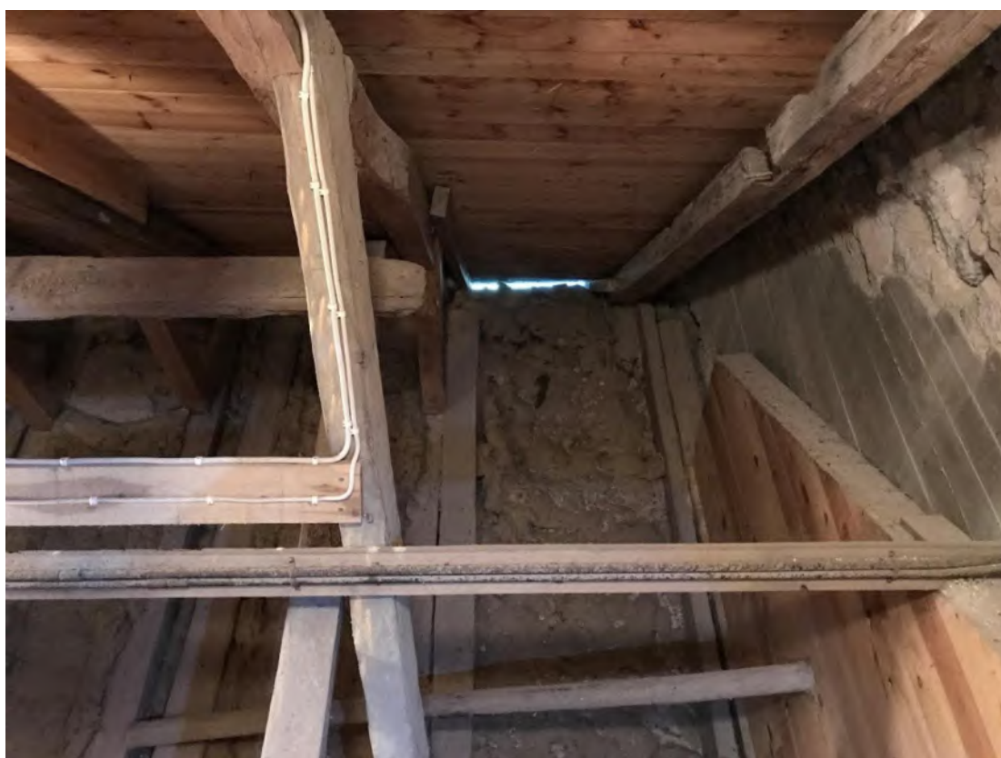
Långhusvindens östra del ovanför långhusförlängningen, sedd mot nordöst. Foto JL 2020.
