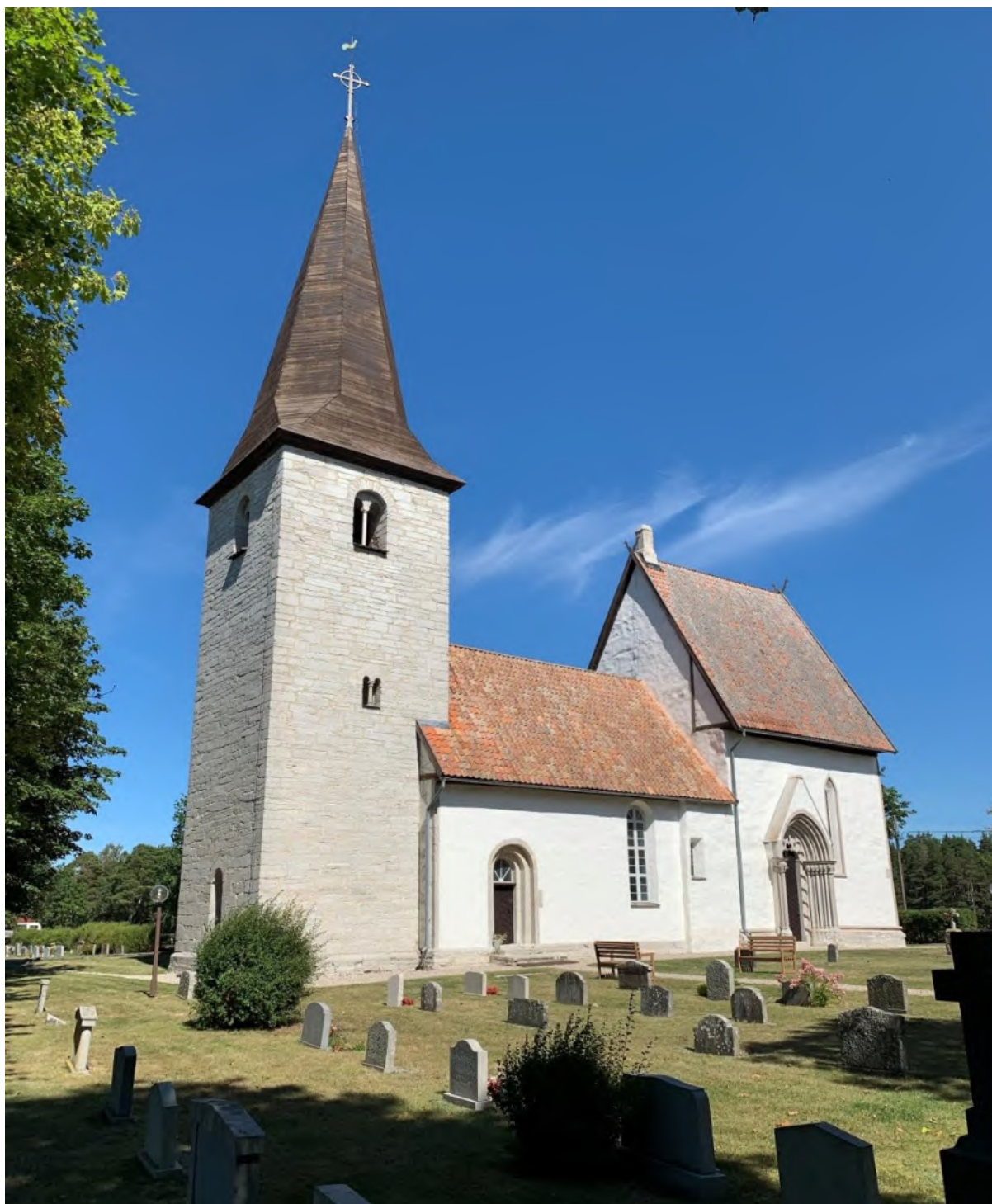
Exteriör från sydväst. Foto JL 2020.
