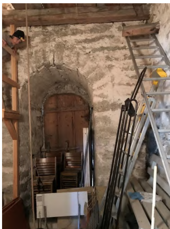
Ringkammaren mot sydöst samt mot väster med innersmygen till tornportalen. Observera urtaget längst till höger på bjälken. Foto JL 2020.
