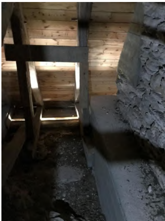
Korvindens sydvästra hörn. Triumfbågsmurens murverk grövre än mot långhusvinden. Gaveln förstärkt med betong 1965. T.h. rest av avbränt ställningsvirke i triumfbågsmuren mot korvinden. Foto JL 2020.
