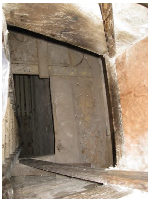
Uppgång till tornets andra övervåning. Foto JL 2020. T.h. sedd ovanifrån med en äldre sammanhängande steg nedifrån ringkammaren, vilket talar för att trägolvet till första våningen kan vara yngre än valvöppningen. Foto Rebecka Svensson 2008, Visby stift.
