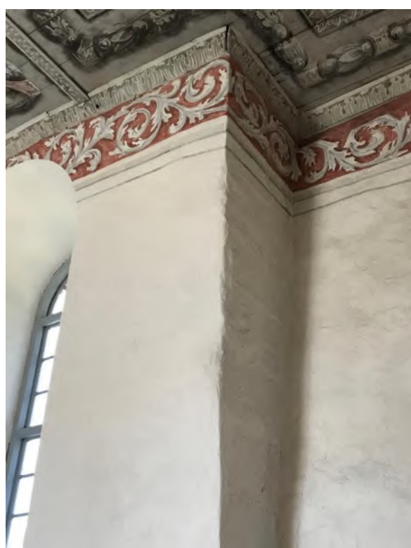
Detaljer från långhusförlängningens norra murar. Murklacken mot långhusets västra del utgör långhusets tidigare östra mur med bevarad sockel och ett fint murverk under den tunna putsen. Foto JL 2020.
