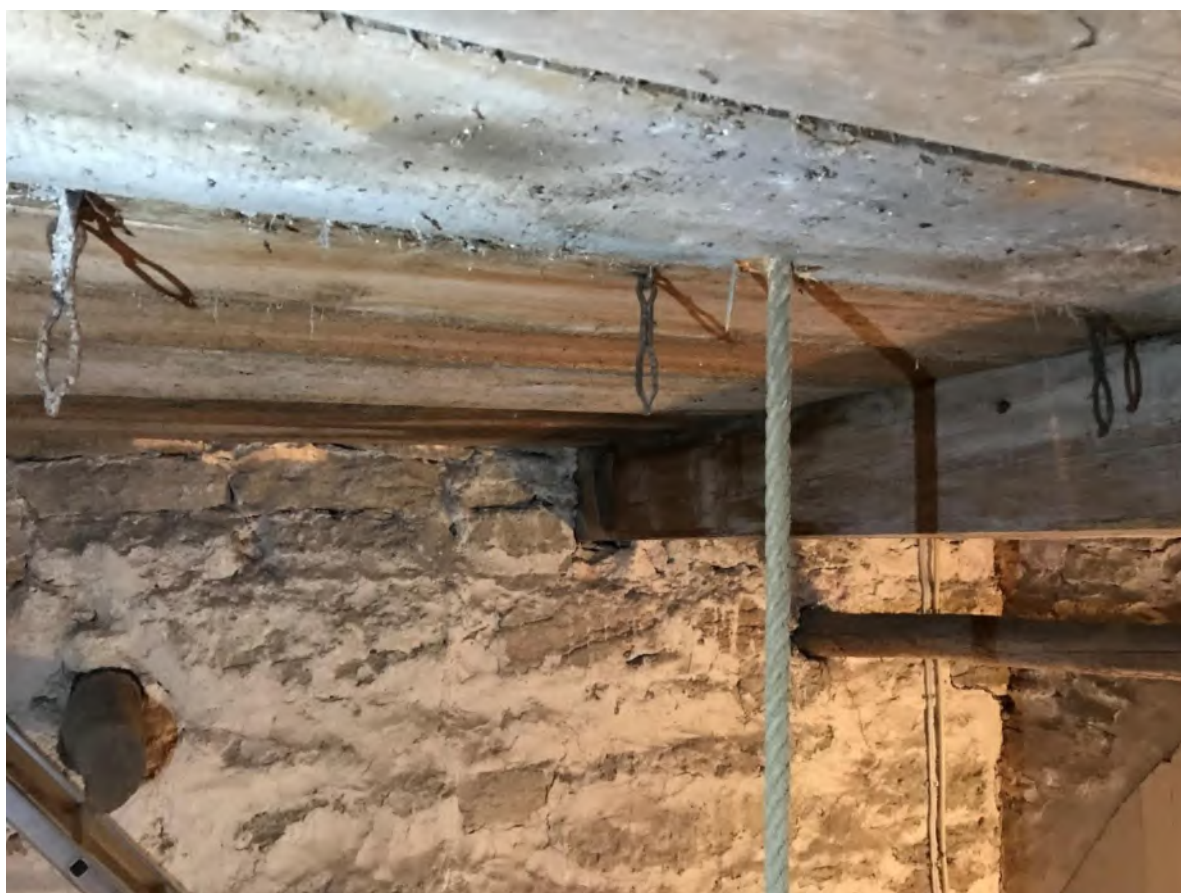
Bjälklag mellan ringkammaren och den första övervåningen, sett mot norr. Bjälkarna har möjligen byggts som stöd vid valvslagningen snarare än som golvbjälklag. Foto JL 2020.
