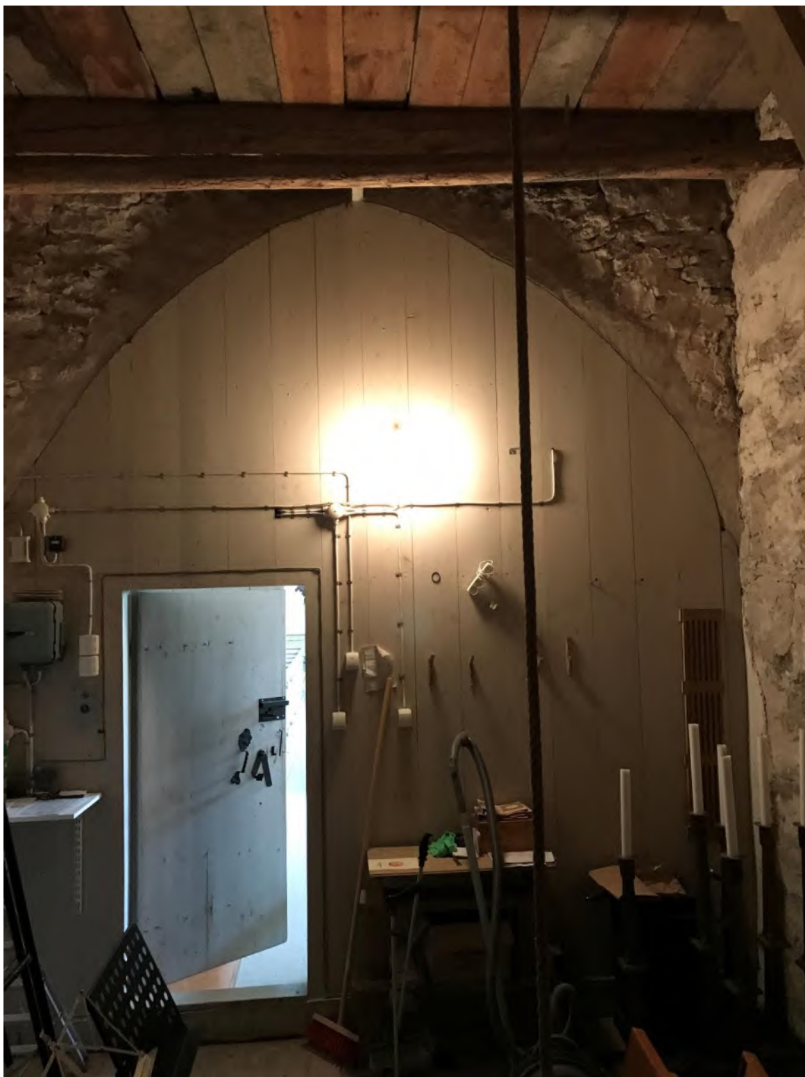
Ringkammaren mot öster med träväggen i tornbågen. Foto JL 2020.
