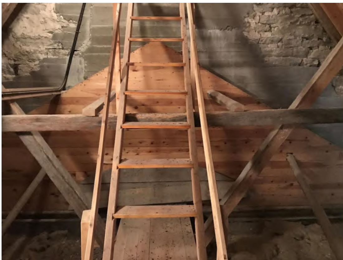
Långhusvindens östra del med panel framför övre delen av triumfbågen. Foto JL 2020.
