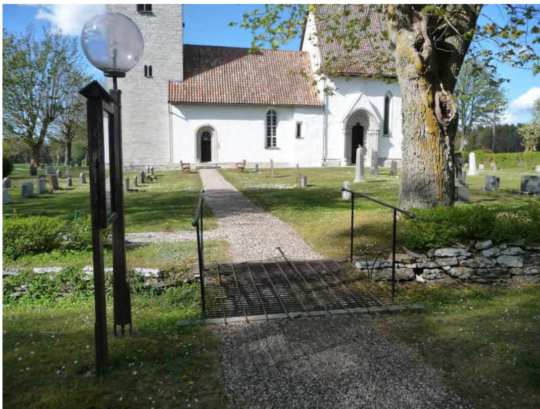
Den södra ingången med en färist (järngaller) och räcken i järn. Foto ES 2020.
