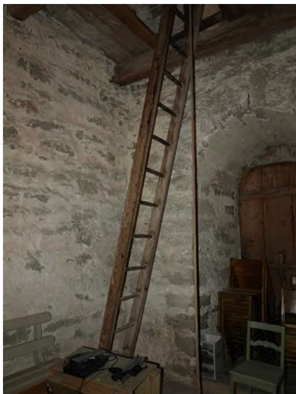
Ringkammaren mot sydväst med västportalens innersmyg. Bilden tagen innan den upp till valvet, förbi första våningen obrutna stegen ca 2010 ersattes av nuvarande trätrappor. Möjligen var stegen densamma som före 1860-talet användes till vindsluckan i långhuset. Foto Pär Malmros 2009, Gotlands Museum (PA153947).
