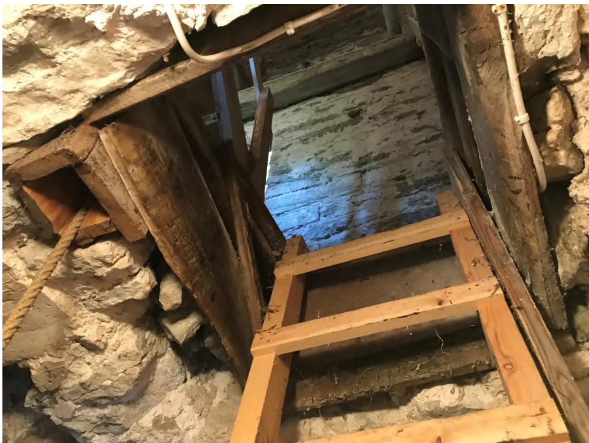
Uppgång genom valvet till tornets andra övervåning. Upptagen på 1860-talet istället för tidigare öppning i långhusets innertak. Foto JL 2020
