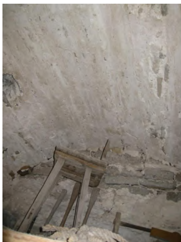
Tornets första övervåning. Kvarvarande skälbräder i valvanfangets sydvästra hörn. Foto JL 2020. T.h. tunnvalvet sett underifrån med kvarsittande bruk. Foto Rebecka Svensson 2008, Visby stift.
