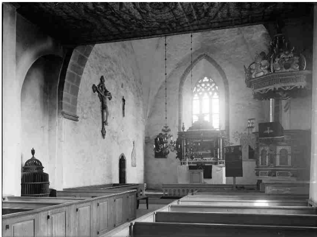
Interiör mot öster. Bågen på muren ovanför kaminen från 1906 innehåller rökröret. Foto Alfred Edle 1928, ATA, RAÄ Kulturmiljöbild.
