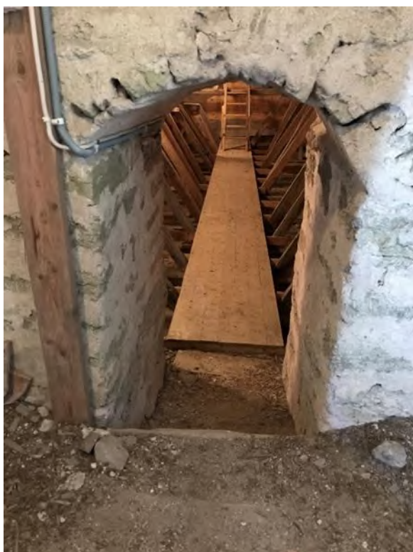
Passage mellan tornets andra övervåning och långhusvinden, sedd från tornet resp. kyrkvinden. Ursprunglig öppning i långhusets västra gavel. Tornvalvet skär över dess nedre del. Foto JL 2020.
