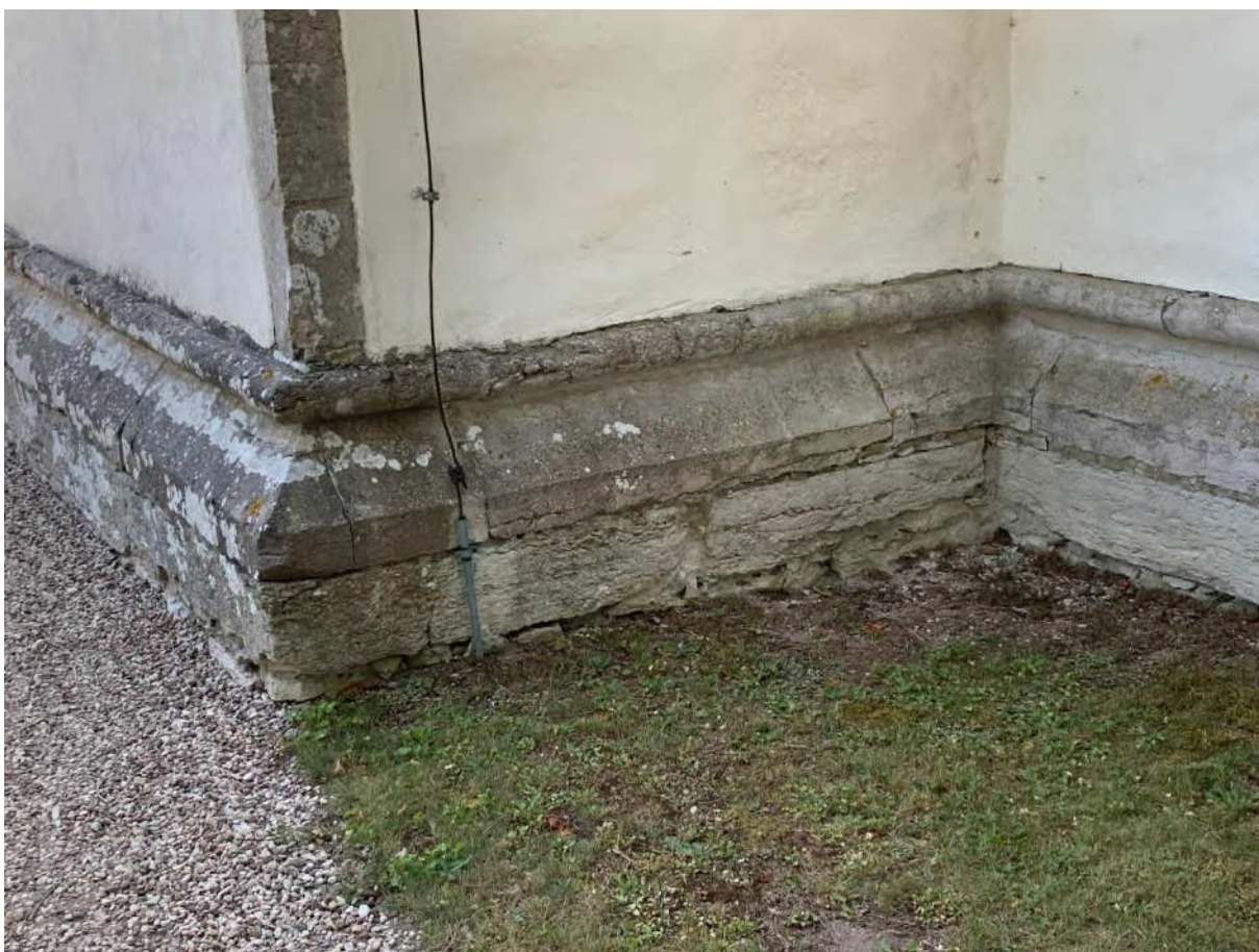
Sockeln i korets nordöstra hörn. Till höger sakristians sockel. Foto JL 2020.
