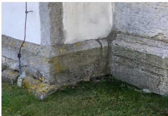
Anslutning mellan tornets och långhusets sockel, t.v. i nordvästra hörnet, t.h. i sydvästra hörnet. Den putsade muren till hör långhuset, den oputsade hör till tornet. Foto JL 2020.
