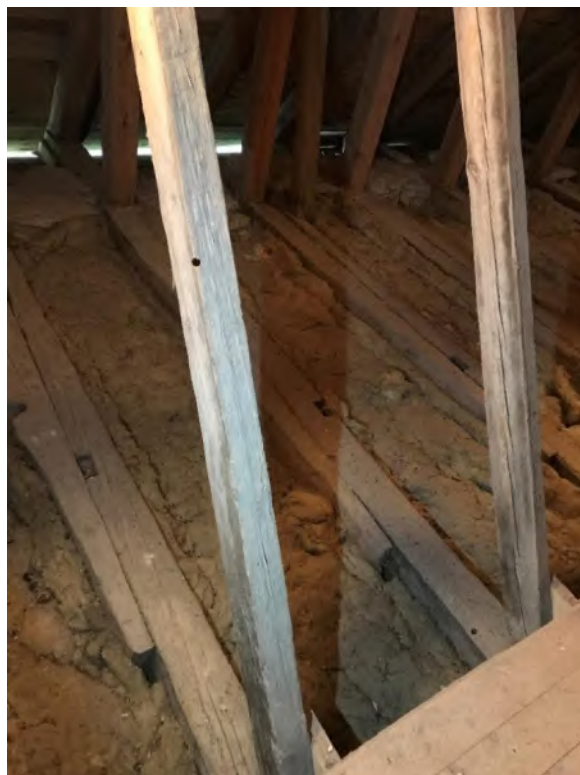
Långhusets takstol, sydvästra hörnet, ovanför den tidigare luckan till vinden. T.h. exempel på de urtag som finns på flera av bindbjälkarna. Två borrhål från dendrokronologisk undersökning synliga. Foto JL 2020.
