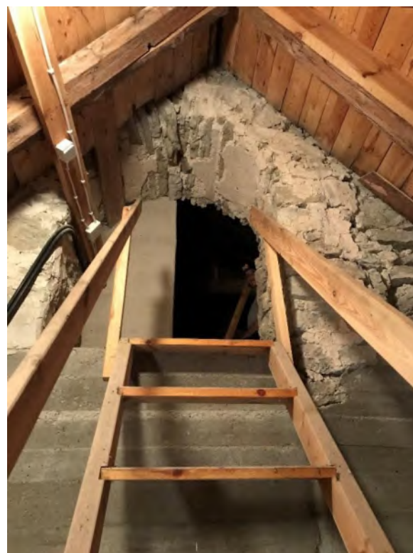
Triumfbågmuren sedd mot öster och sydöst. Gavelröset förstärkt med betong 1965. Foto JL 2020.
