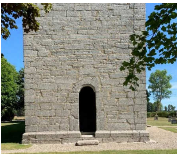
Tornets nedre del från väster samt trampstenar i tornportalen, den närmast troligen altarsten, därovanför del av rundad sockel från en absid, vilken visar att kyrkan hade sådan. Foto JL 2020.
