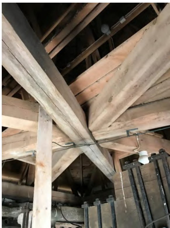
Tornhuvens bärverk samt ett av de fasade takfallen i hörnen. Foto JL 2020.
