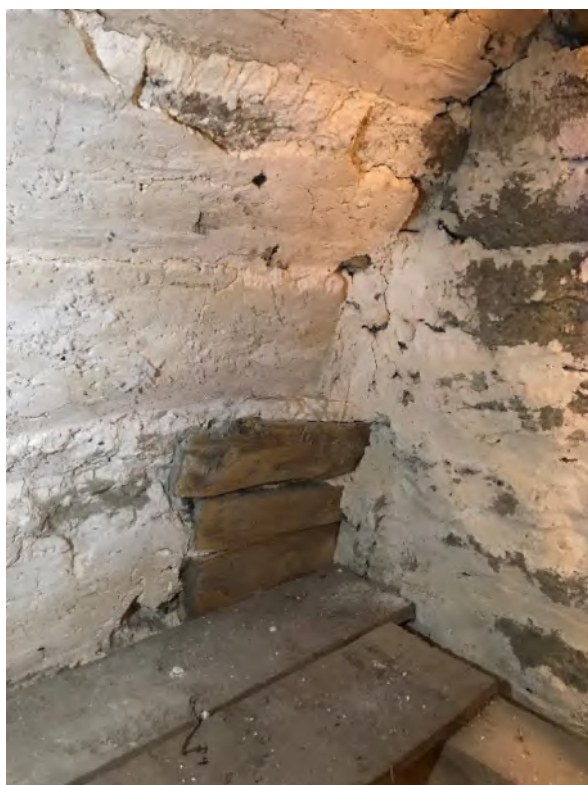
Tornets första övervåning. Kvarvarande skälbräder i valvanfangets sydvästra hörn. Foto JL 2020. T.h. tunnvalvet sett underifrån med kvarsittande bruk. Foto Rebecka Svensson 2008, Visby stift.
