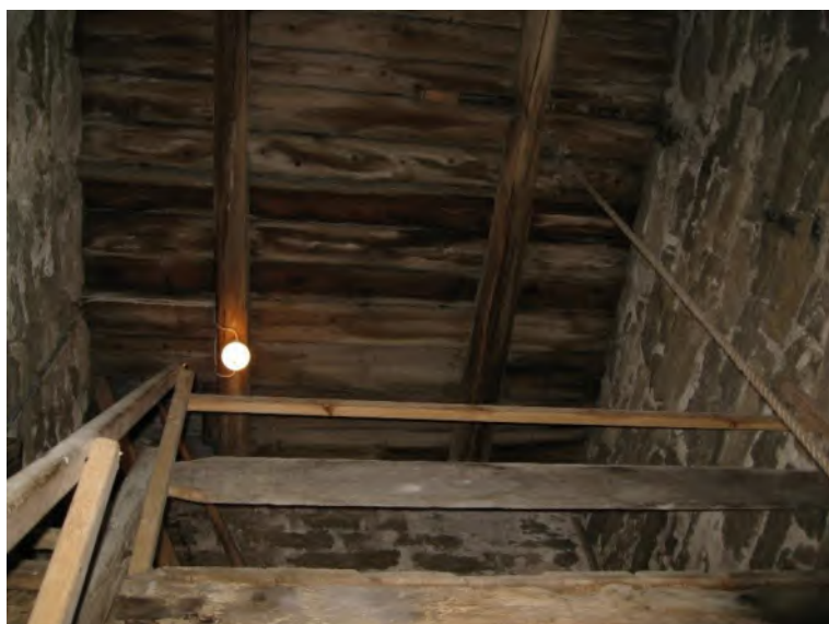
Tornets tredje övervåning, mot söder, sett nedifrån samt nära sydöstra hörnet. Under trappan syns ett kvarvarande sannolikt ursprungligt ställningsvirke. Foto Rebecka Svensson 2008, Visby stift, resp. JL 2020.
