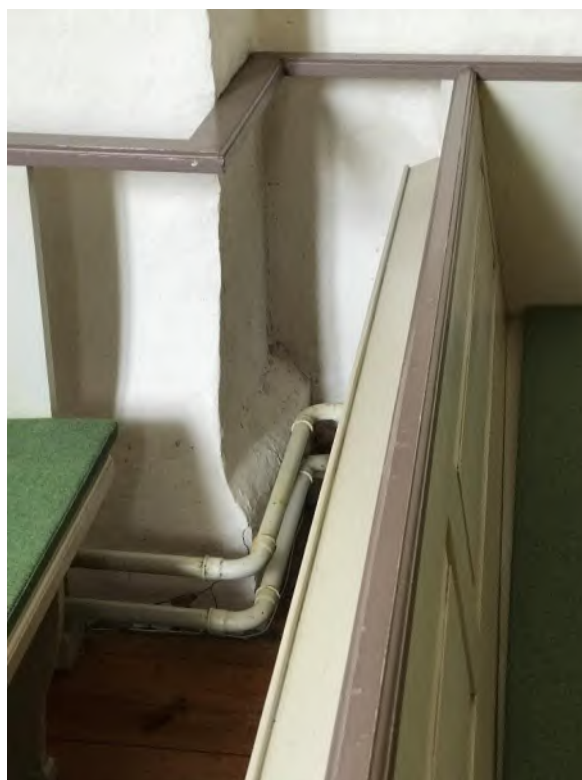
Detaljer från långhusförlängningens norra murar. Murklacken mot långhusets västra del utgör långhusets tidigare östra mur med bevarad sockel och ett fint murverk under den tunna putsen. Foto JL 2020.
