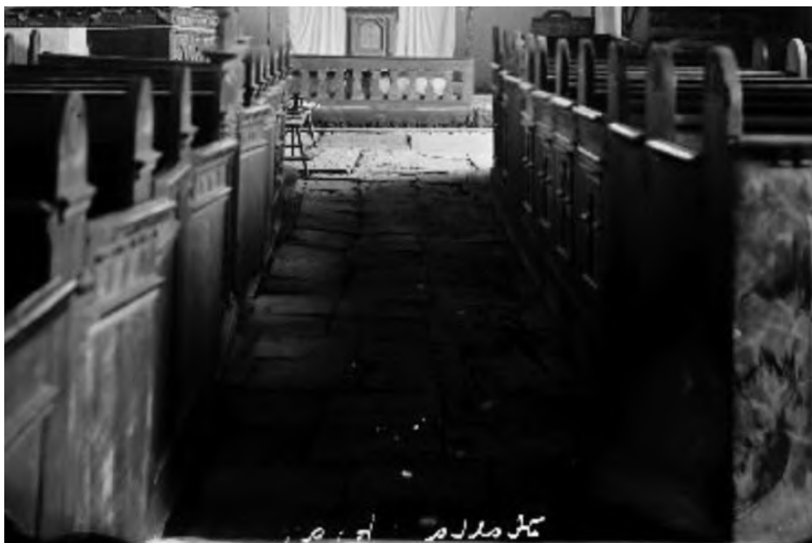
Bänkinredning från 1600-talet, riven 1876. Bänkarna har förhöjda gavlar, några av dörrarna speglar med bågkrönta fält. Sättningar i golvet förefaller ha gjort att en del dörrar inte gick att stänga. Foto C. F. Lindberg 1875 (detalj), ATA, RAÄ Kulturmiljöbild.
