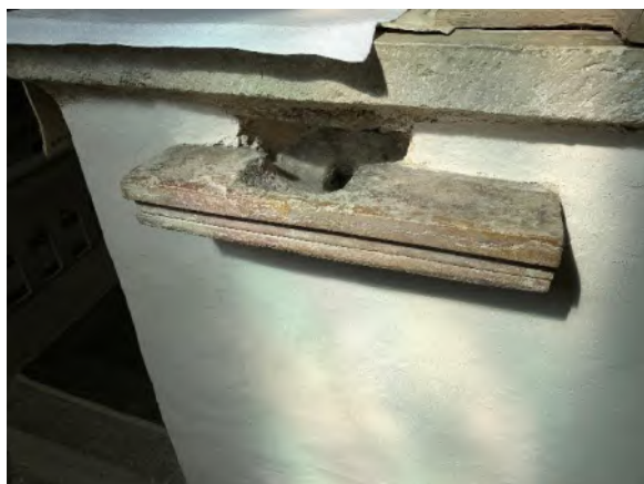
Piscina på altarets södra sida, tillverkad av listverk i röd kalksten. Foto JL 2020.
