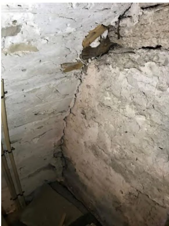
Tornets första övervåning, nordöstra hörnet. Långhusets äldre västgavel med ursprunglig puts samt kvarsittande trästycke, sannolikt ställningsvirke. T.h. avtryck av skälbrädernas träådring och form. En utskjutande fals visar hur en av bräderna var skadad. Falsen delvis borthuggen för elledningens framdragnings. Foto JL 2020.
