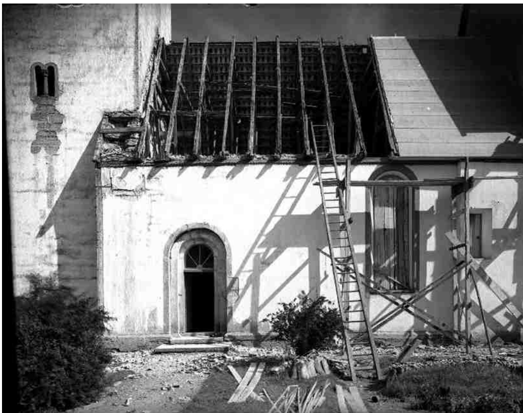
Exteriör av långhuset från söder under pågående takarbeten. Foto Alfred Edle 1931, ATA, RAÄ Kulturmiljöbild.
