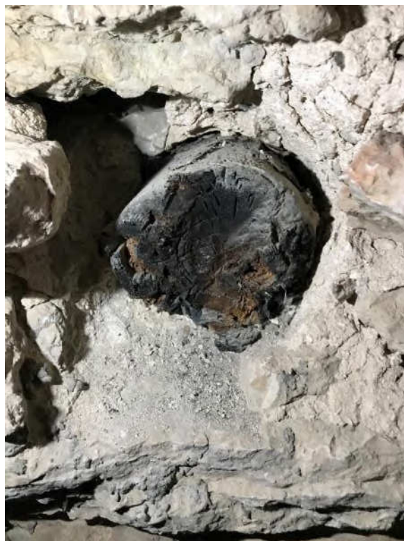
Korvindens sydvästra hörn. Triumfbågsmurens murverk grövre än mot långhusvinden. Gaveln förstärkt med betong 1965. T.h. rest av avbränt ställningsvirke i triumfbågsmuren mot korvinden. Foto JL 2020.
