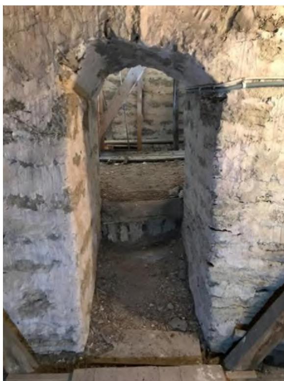
Passage mellan tornets andra övervåning och långhusvinden, sedd från tornet resp. kyrkvinden. Ursprunglig öppning i långhusets västra gavel. Tornvalvet skär över dess nedre del. Foto JL 2020.
