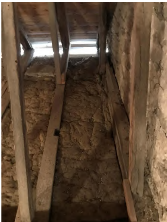
Långhusets takstol, sydvästra hörnet, ovanför den tidigare luckan till vinden. T.h. exempel på de urtag som finns på flera av bindbjälkarna. Två borrhål från dendrokronologisk undersökning synliga. Foto JL 2020.
