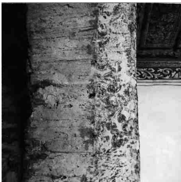
Tornbågens norra sida under restaureringen 1965. Träväggen för bågen, troligen från 1876, har tagits ned och blottlagt dekor från 1600-1700-talet fram till gränsen för en tidigare trävägg. Spåren målades sedan över när den nya träväggen byggdes 1965. T.h. smygen till långhusets medeltida fönster delvis frilagd 1965. Foto ATA, RAÄ Kulturmiljöbild.
