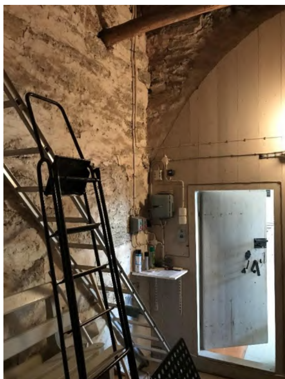
Ringkammaren mot nordöst, t.h. uppifrån. Foto JL 2020.
