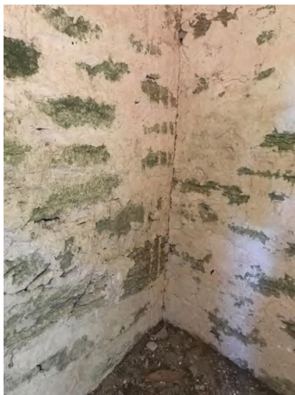
Tornets andra övervåning, hörnen i nordöst och sydöst där tornmurarna stöter stumt emot långhusets västgavel, vars puts går in bakom muren och således är ursprunglig. Foto JL 2020.
