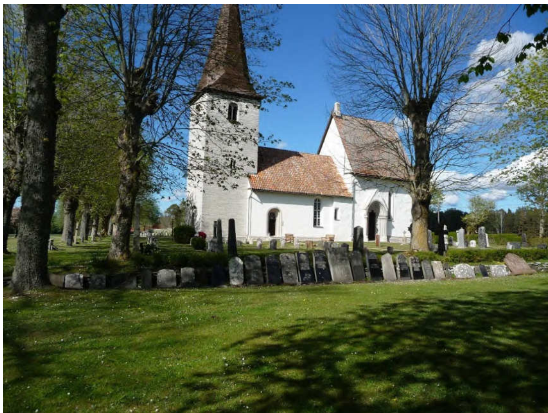
Vid den södra kyrkogårdsmuren står ett antal gravvårdar uppställda. Foto ES 2020.
