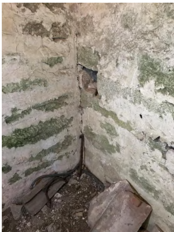
Tornets andra övervåning, hörnen i nordöst och sydöst där tornmurarna stöter stumt emot långhusets västgavel, vars puts går in bakom muren och således är ursprunglig. Foto JL 2020.
