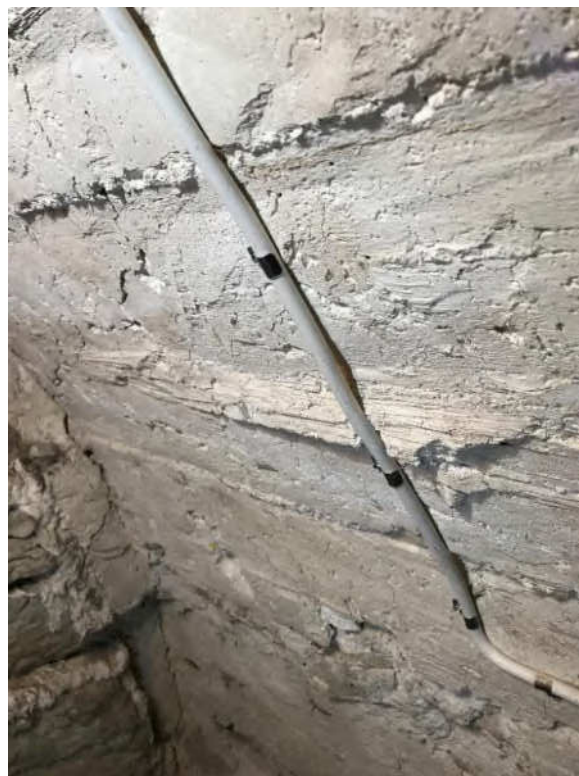
Tornets första övervåning, nordöstra hörnet. Långhusets äldre västgavel med ursprunglig puts samt kvarsittande trästycke, sannolikt ställningsvirke. T.h. avtryck av skälbrädernas träådring och form. En utskjutande fals visar hur en av bräderna var skadad. Falsen delvis borthuggen för elledningens framdragnings. Foto JL 2020.
