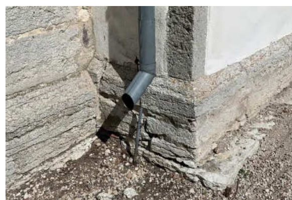
Anslutning mellan tornets och långhusets sockel, t.v. i nordvästra hörnet, t.h. i sydvästra hörnet. Den putsade muren till hör långhuset, den oputsade hör till tornet. Foto JL 2020.
