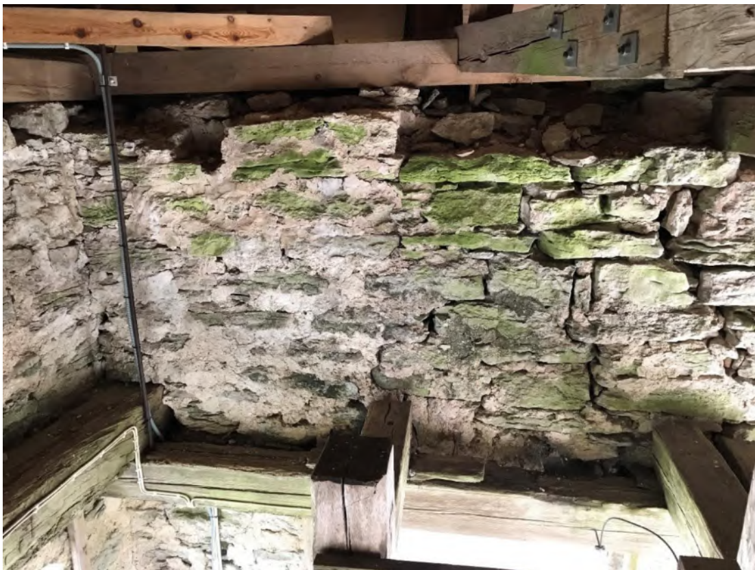
Del av tornets murkrön. Foto JL 2020.
