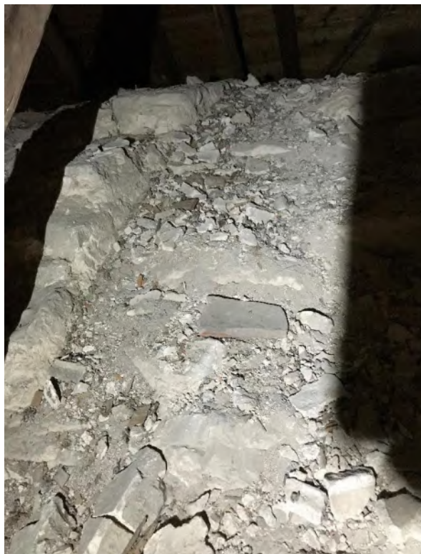
Skarven mellan den äldre, till höger, och yngre, till vänster, delen av korets tunnvalv. Foto JL 2020.
