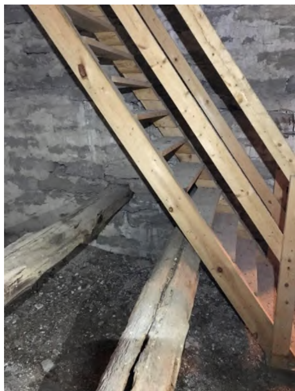
Tornets första övervåning. Parställda bjälkar och deras infästning i södra muren, sedd mot sydväst, och norra muren, sedd mot nordväst. Foto JL 2020.
