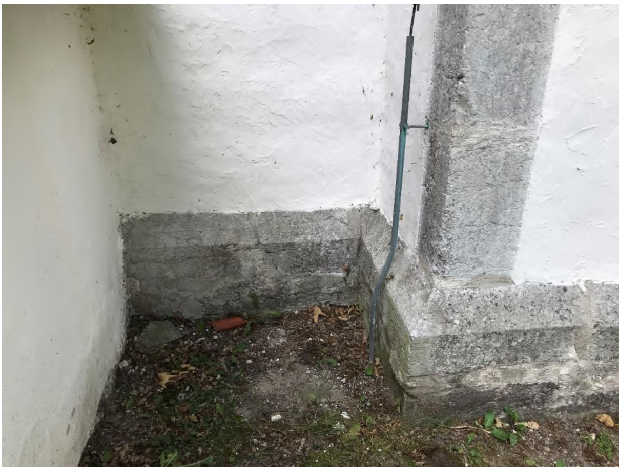
Sockeln mellan långhuset och koret på norra sidan. Korets och sakristians sockel är samordnade och sannolikt samtida. Foto JL 2020.
