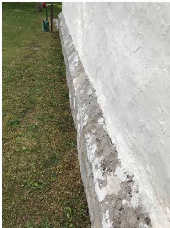
Till vänster: Detalj av sydfasaden, väster om långhusets portal med skiftningar i sockeln i höjd med tornets östra hörn och långhuset. Till höger: Detalj av sockeln i korets förlängning. Märk de rundade stenarna från den absid som tidigare fanns i öster. Foto JL 2020.
