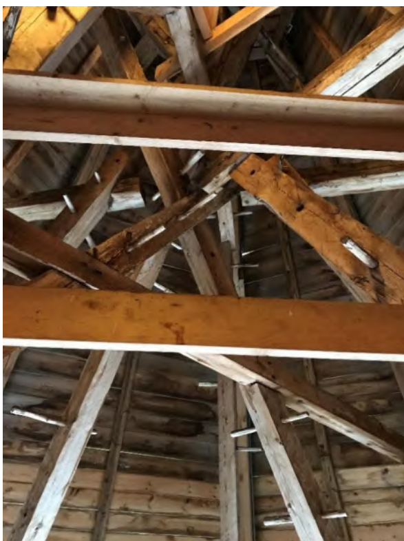
Detaljer av tornhuvens inre konstruktion. Foto JL 2020.
