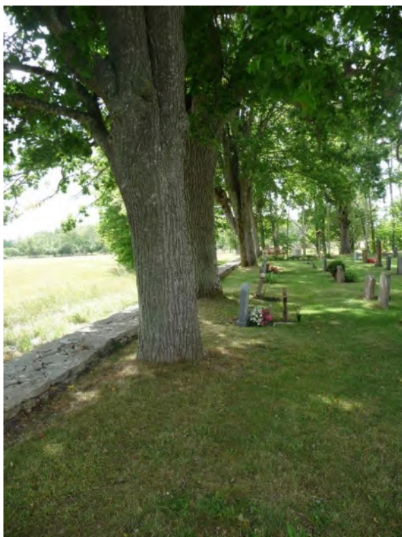
Den östra terrassmuren. Foto ES 2020.
