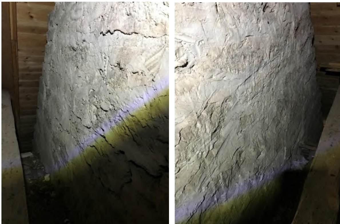
Triumfbågsmurens sida mot långhusvinden, sedd mot nordöst resp. sydöst, visande murverkets utstrukna fogar. Foto JL 2020.
