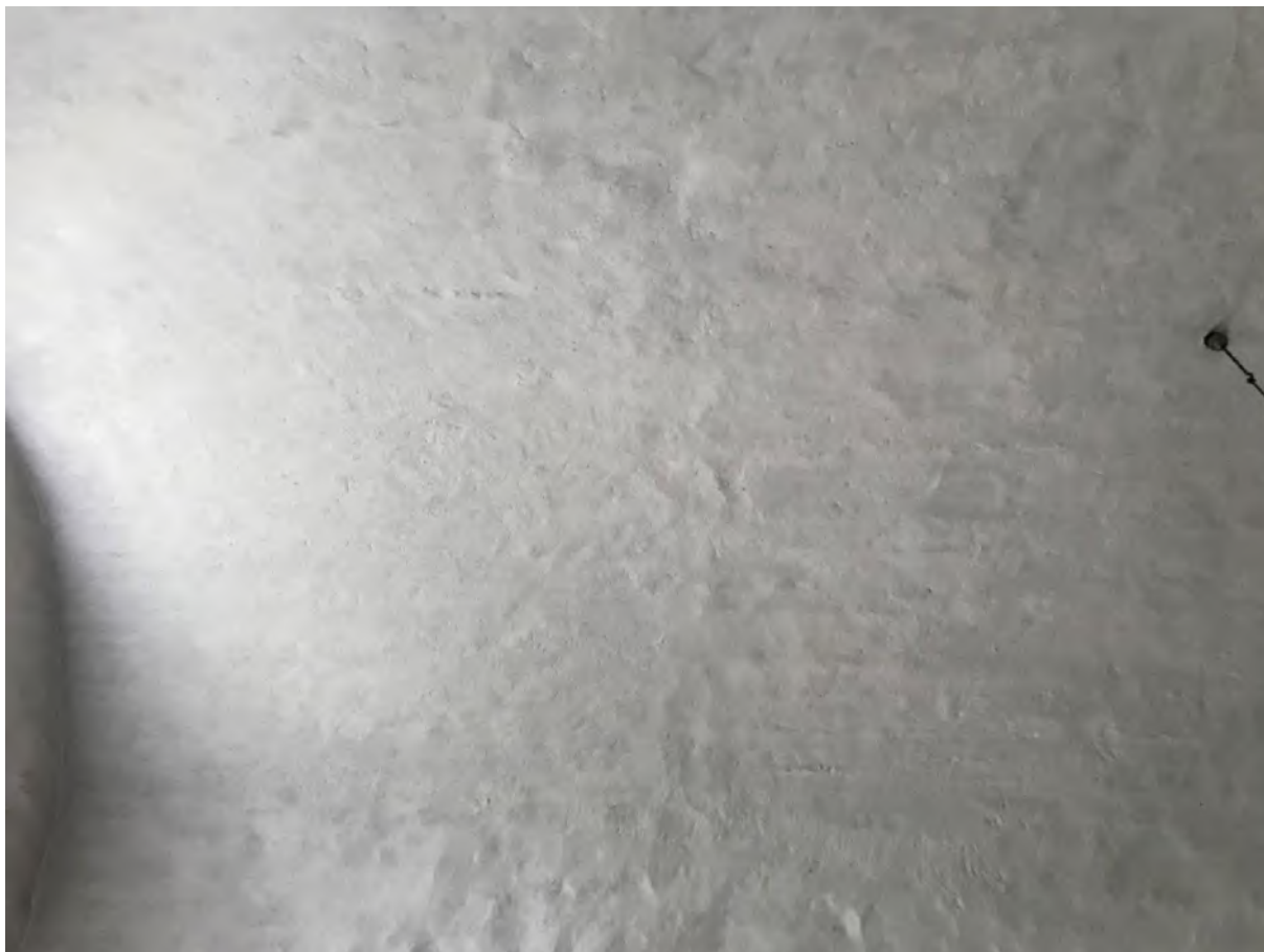
Korets tunnvalv. Till höger den ursprungliga delen, till vänster förlängningen åt öster. Foto JL 2020.
