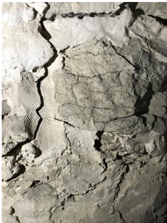
Avtryck av tyg i murbruket på korvinden, sannolikt från byggnadstiden, till vänster söder om och till höger norr om passagen till långhusvinden. Foto JL 2020.
