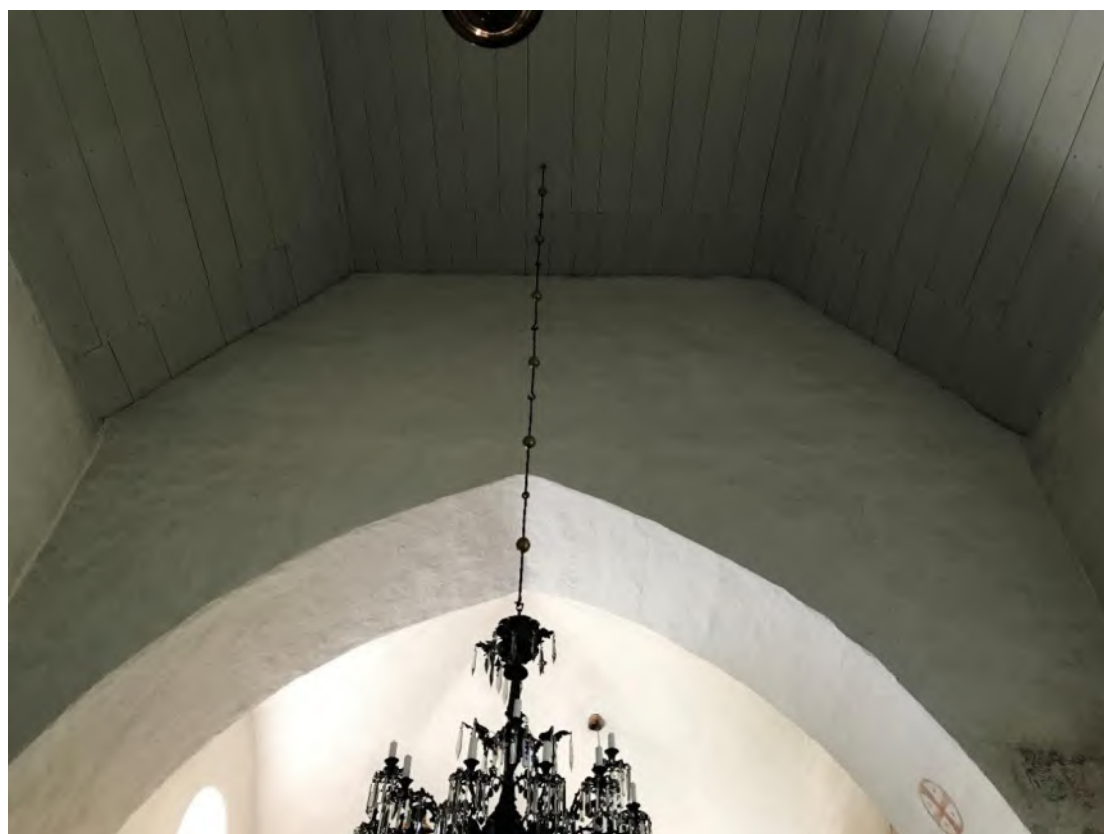
Muren ovanför tornbågen, sedd mot väster med motsvarande avtryck. Foto JL 2020.
