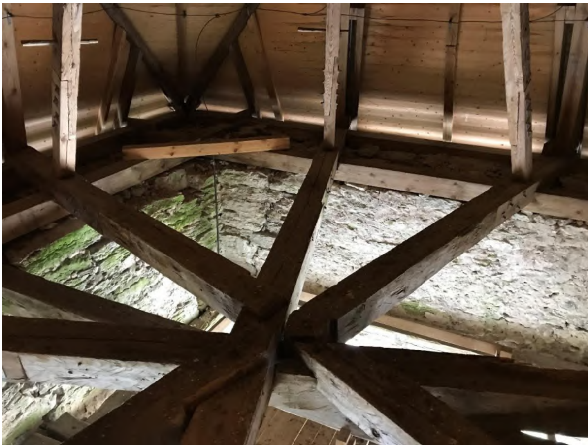
Del av tornets murkrön. Foto JL 2020.
