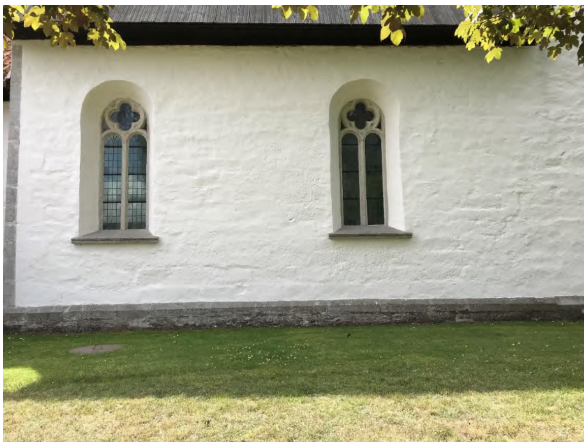
Långhusets nordfasad. Foto JL 2020.
