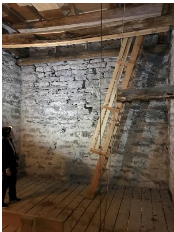
Tornets andra övervåning mot nordväst. Trästycket som skjuter ut snett ur norra muren till höger utgörs av en urskårad stock, sannolikt en tidigare spygatt från klockdäcket. Foto JL 2020.
