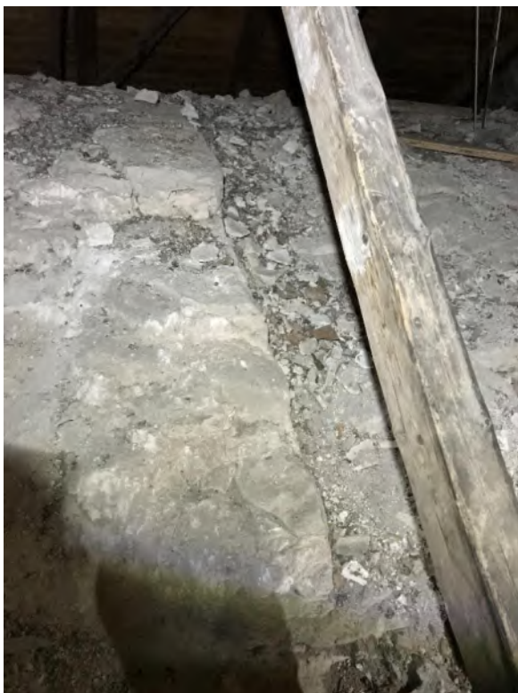
Skarven mellan den äldre, till höger, och yngre, till vänster, delen av korets tunnvalv. Foto JL 2020.
