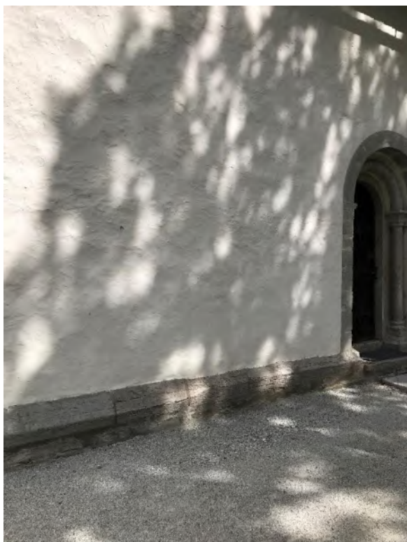
Till vänster: Detalj av sydfasaden, väster om långhusets portal med skiftningar i sockeln i höjd med tornets östra hörn och långhuset. Till höger: Detalj av sockeln i korets förlängning. Märk de rundade stenarna från den absid som tidigare fanns i öster. Foto JL 2020.
