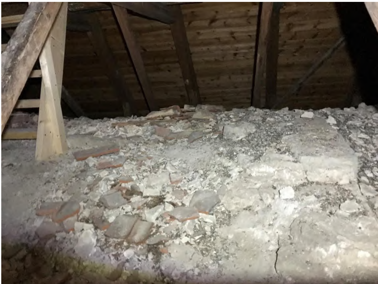
Korets tunnvalv sett mot söder. Foto JL 2020.
