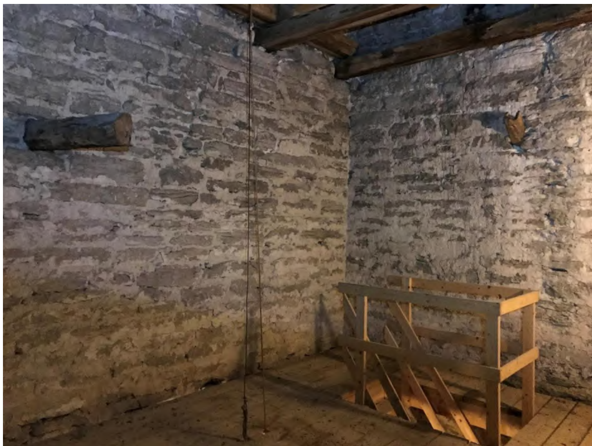
Tornets andra övervåning mot nordväst. Trästycket som skjuter ut snett ur norra muren till höger utgörs av en urskårad stock, sannolikt en tidigare spygatt från klockdäcket. Foto JL 2020.
