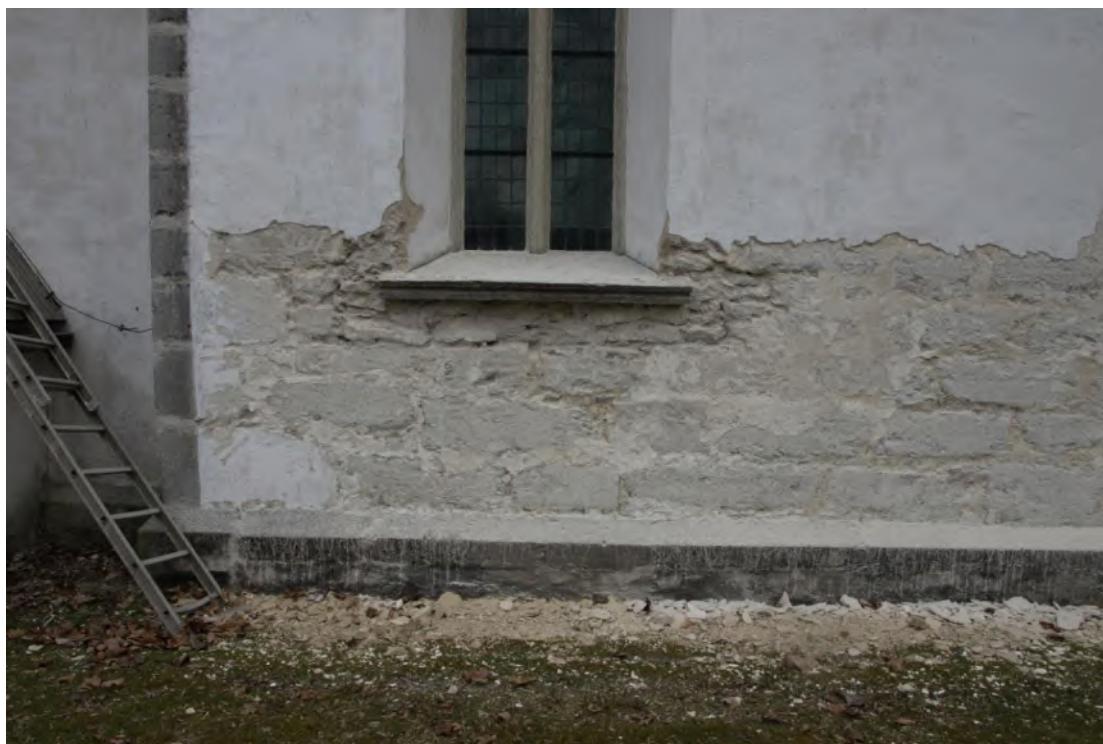
Långhusets nordöstra hörn under omputsning vid restaureringen 2012 med det ursprungliga slåthuggna murverket frilagt. Foto Pär Malmros 2012. Gotlands Museum (P4128488).
