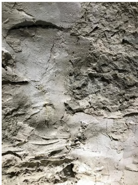
Avtryck av tyg i murbruket på korvinden, sannolikt från byggnadstiden, till vänster söder om och till höger norr om passagen till långhusvinden. Foto JL 2020.
