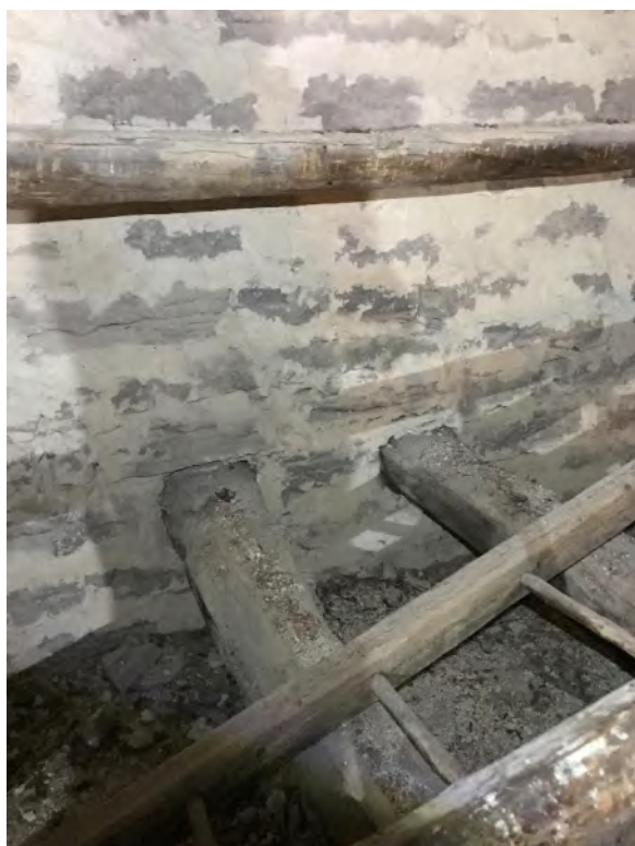
Tornets första övervåning. Parställda bjälkar och deras infästning i södra muren, sedd mot sydväst, och norra muren, sedd mot nordväst. Foto JL 2020.
