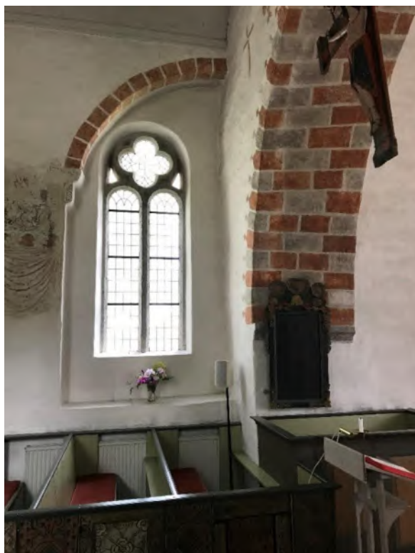
Höga nischer, formade genom förtunning av muren, sannolikt i efterhand. Den norra större än den södra. Förmodligen utförda efter triumfbågens vidgning för att ge rum åt sidoaltaren på var sida om bågen. Foto JL 2020.
