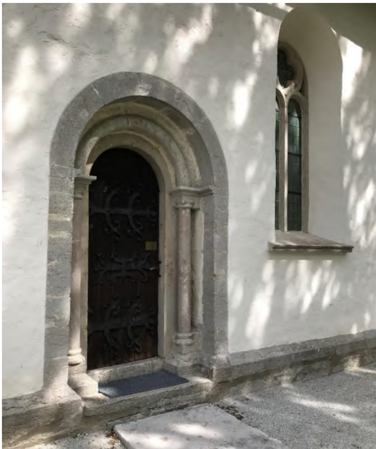
Långhusportalen och långhusets södra fönster sedda från sydväst. Foto JL 2020.
