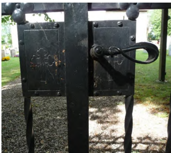
Grinden går att låsa. Ett nyckelhål syns under handtaget. Foto ES 2020.
