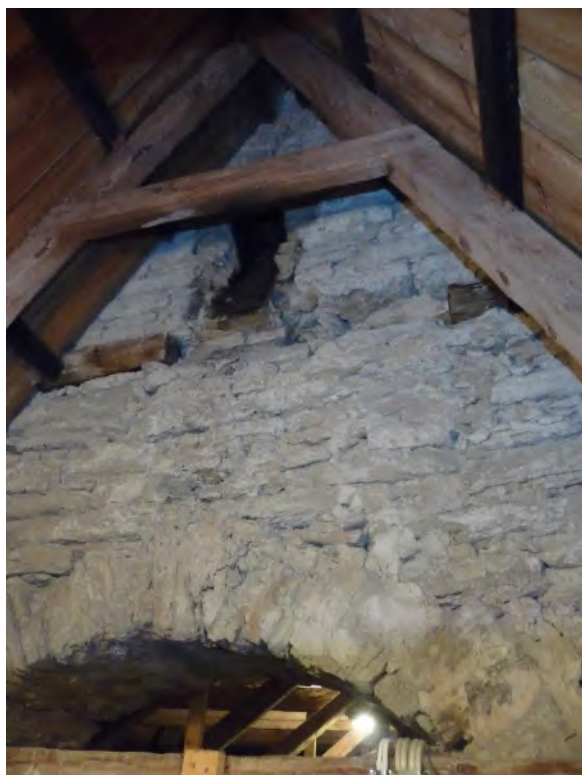
Triumfbågsurens gavelröste sett från långhusvinden med spår av riven skorsten från ca 1915–20. Till höger södra sidan av långhusets takstol med delvis återanvänt virke, samt ovansidan av långhusvalven. Foto JL 2020.
