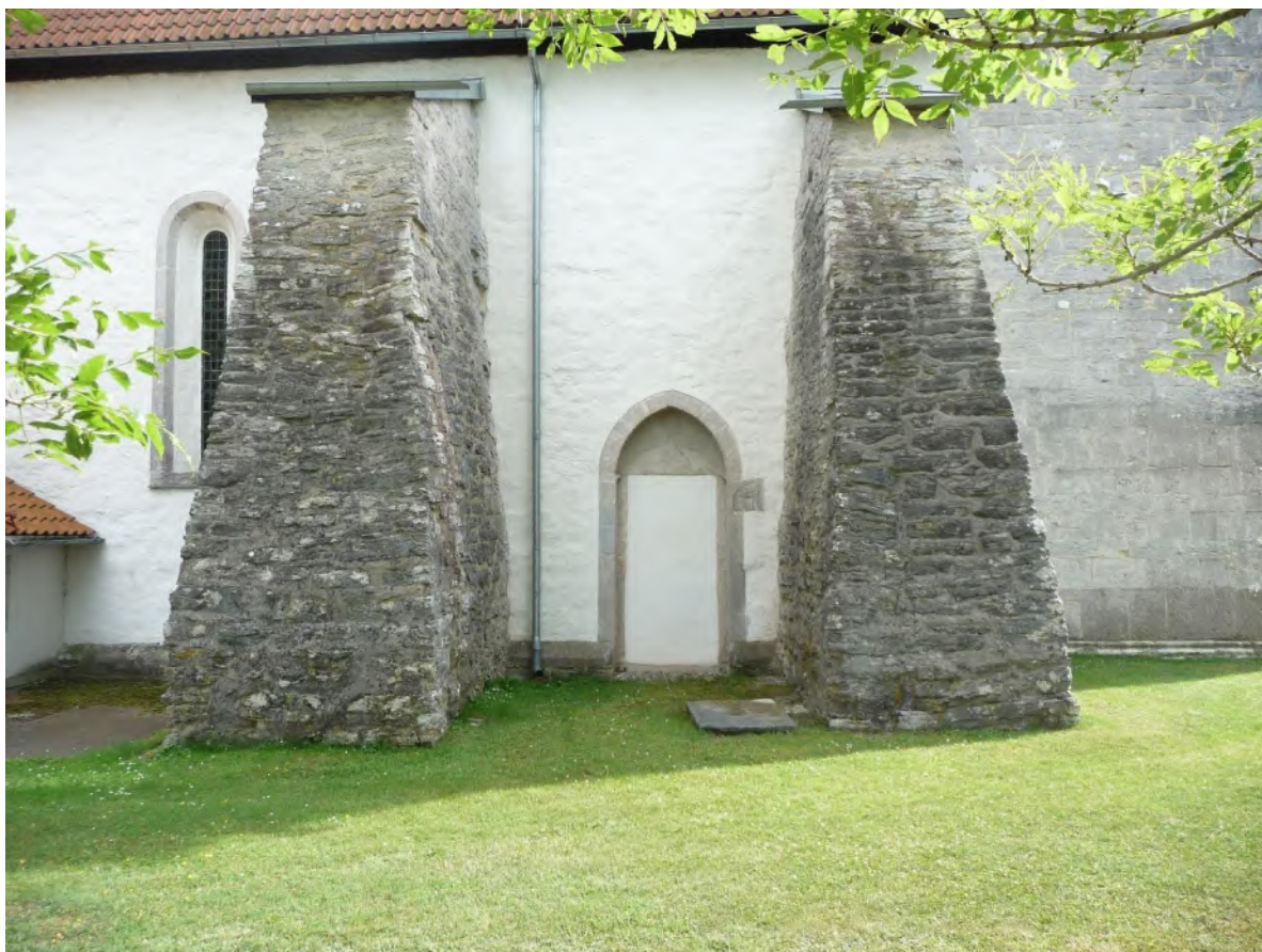
Långhusets nordfasad. Foto JL 2020.
