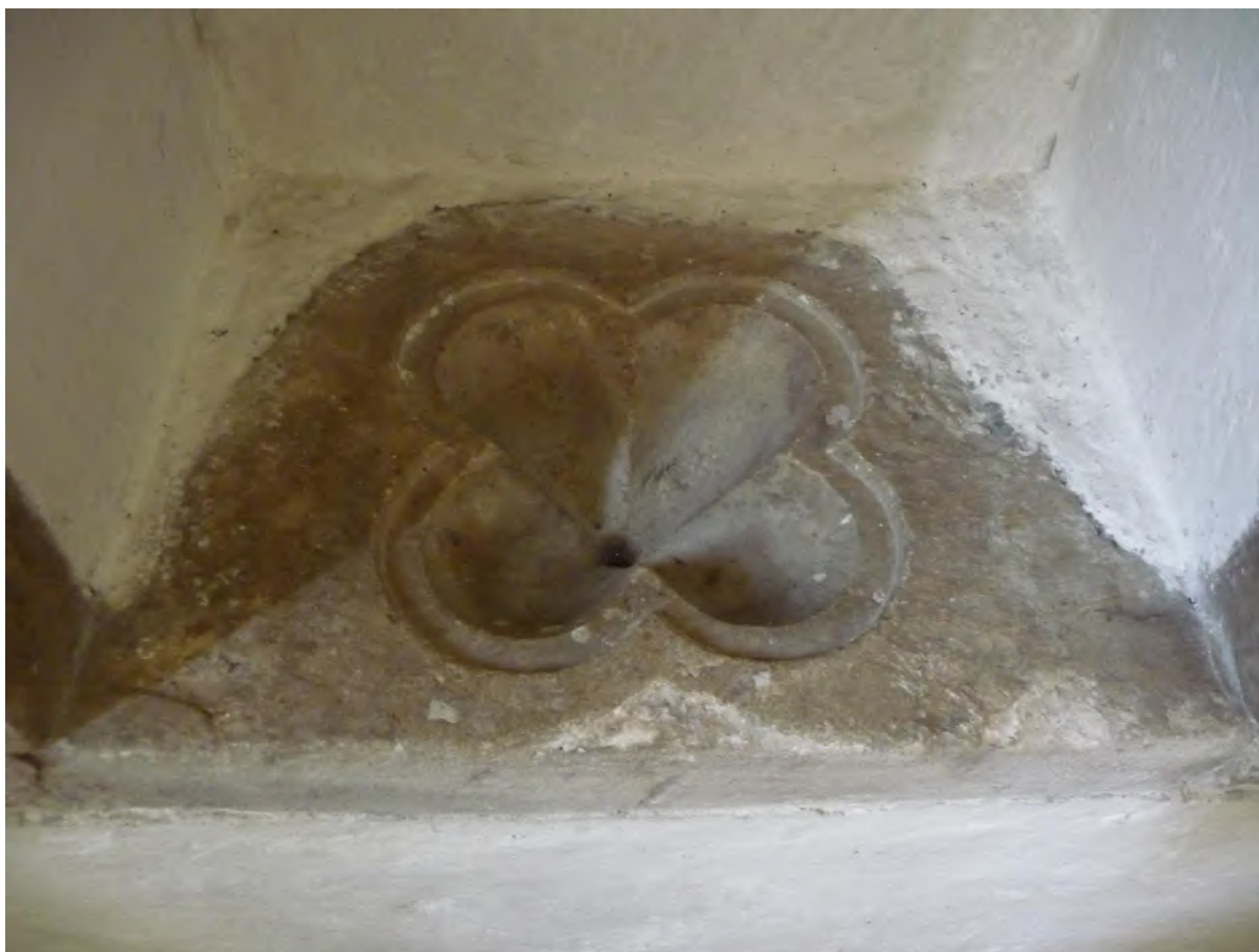
Piscina i nischen i korets södra mur. Foto JL 2020.
