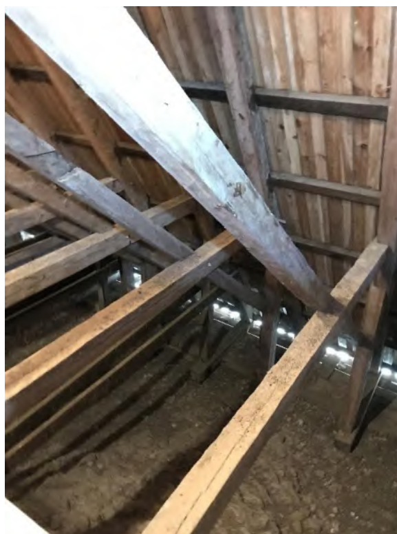
Triumfbågsurens gavelröste sett från långhusvinden med spår av riven skorsten från ca 1915–20. Till höger södra sidan av långhusets takstol med delvis återanvänt virke, samt ovansidan av långhusvalven. Foto JL 2020.
