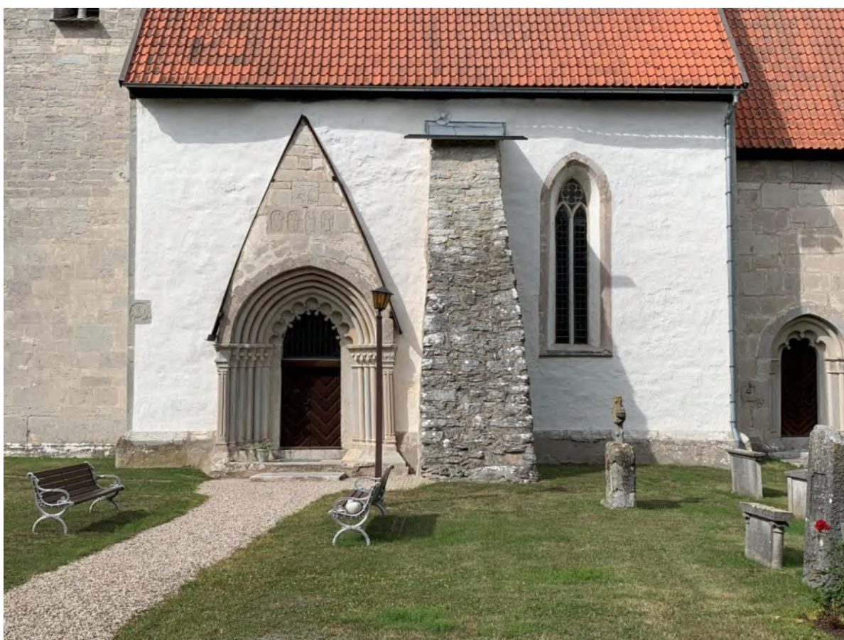
Långhusetets sydfasad med strävpelare och fönster. Foto JL 2020.
