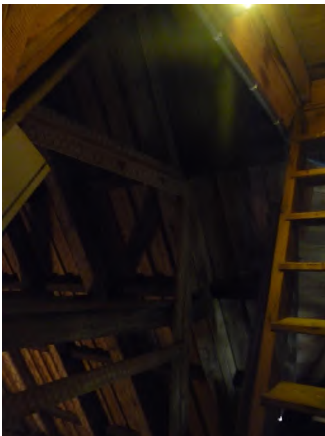
Tornhuvens nedre del med murkrönet, sedda mot sydväst, samt öppning mellan långhusvindensnock och tornhuvens nedre del, sedd mot sydöst. Foto JL 2020.
