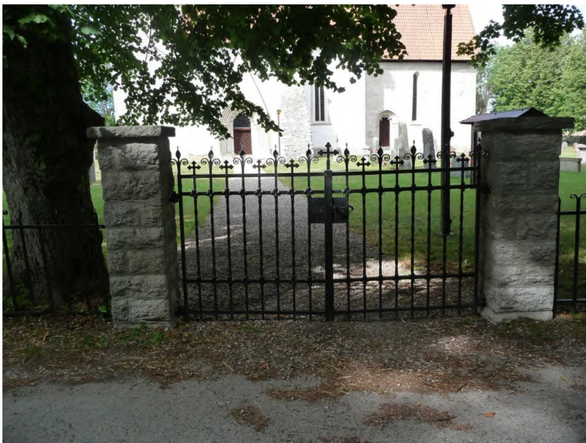
Huvudingången från söder med, en grind i smidesjärn och murade kalkstensstolpar. Foto ES 2020.
