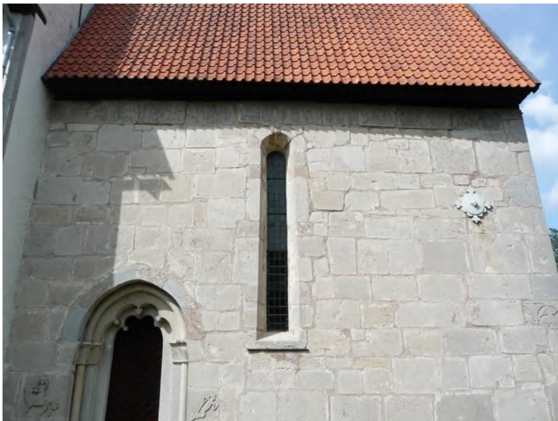
Korets sydfasad med återanvänd fasadsten från en äldre kyrka. Foto JL 2020.
