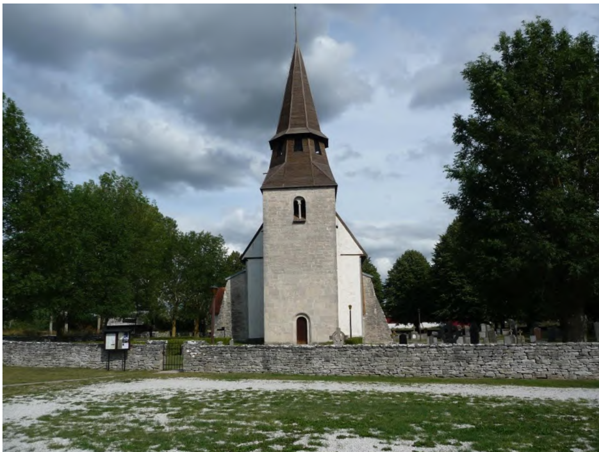
I väster finns en kallmurad kalkstensmur från äldre tider. Foto ES 2020.
