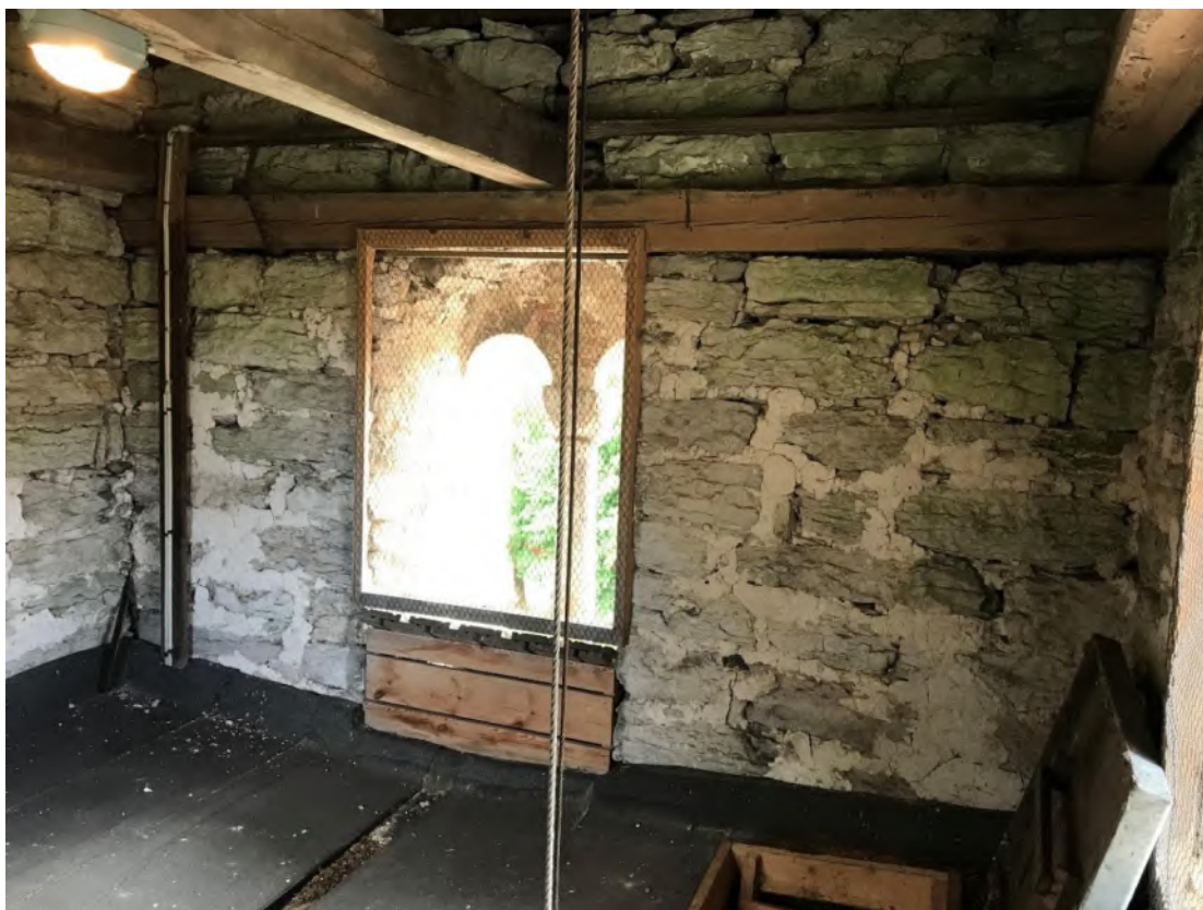
Den tidigare klockvåningen, mot söder. Foto JL 2020.
