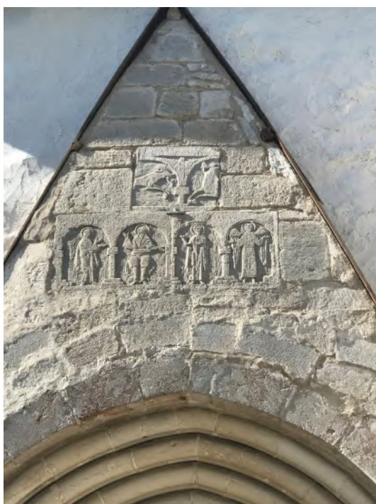
Långhuset södra portal samt detalj av vimpergen med reliefer från den tidigare kyrkans fasad. Foto JL 2020 respektive 2018.
