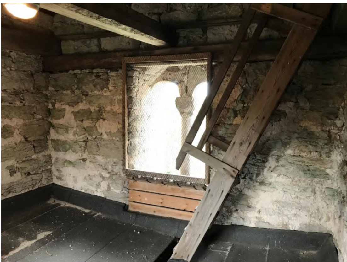
Den tidigare klockvåningen, mot norr. Foto JL 2020.
