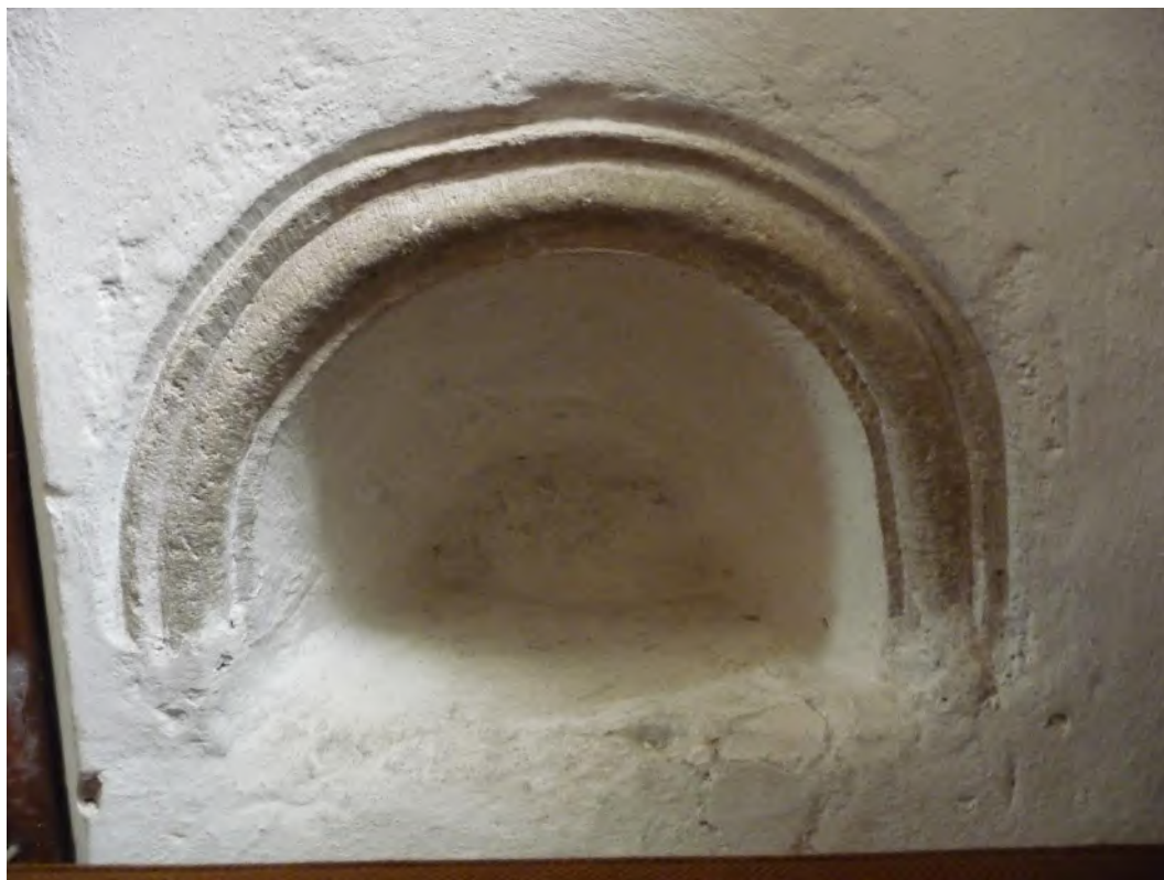
Nisch i predikstolens fundament som tidigare utgjorde sidoaltare. Omfattningen formad av en fönsteromfattning från den äldsta kyrkan. Foto JL 2020.
