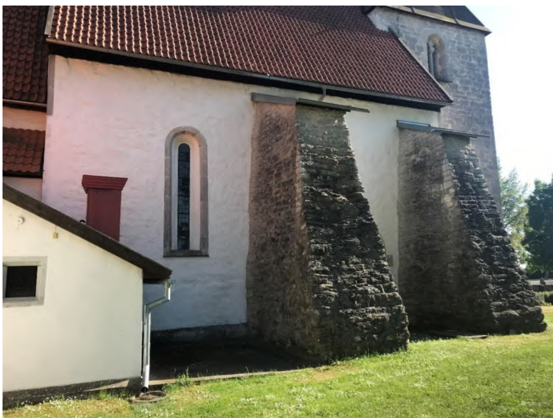
Strävpelare på långhusets norra sida. Foto JL 2018.
