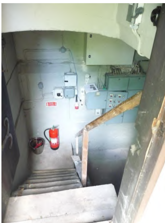
Värmekammarens inre mot öster och söder. Foto JL 2020.
