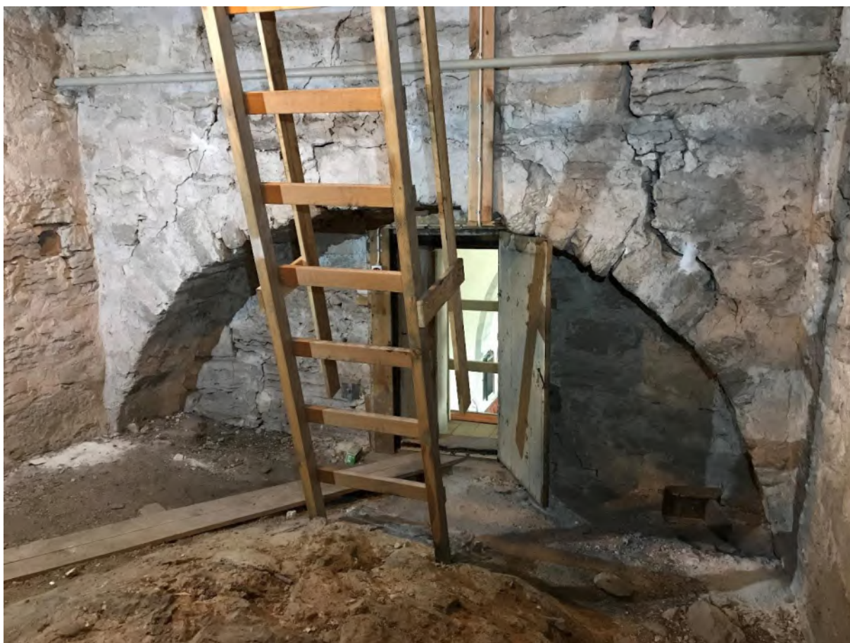
Tornets första övervåning mot öster. Foto JL 2020.
