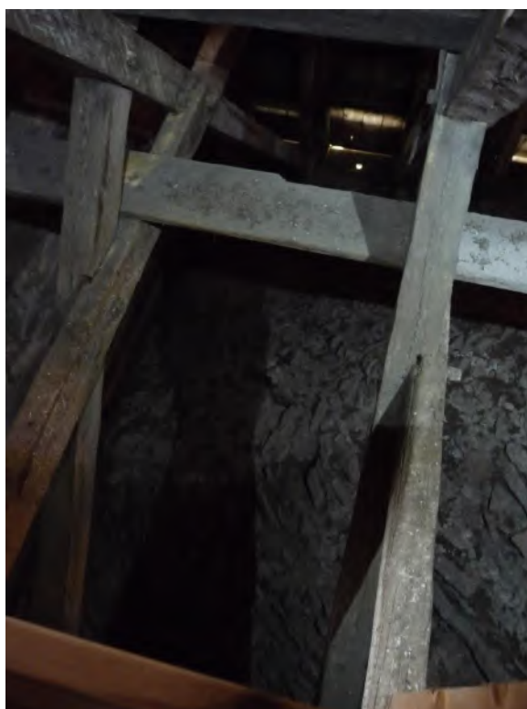
Bomhål på insidan till triumfbågsurens öppning mellan långhus- och korvinden. Till höger korvinden, valvens ovansida sedd mot söder. Foto JL 2020.
