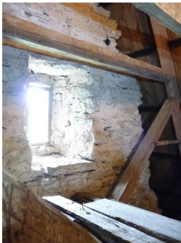
Korets gavelröste sett inifrån mot sydöst. Bomålet i högra bildens övre del innehåller en bränd stock. Foto JL 2020.
