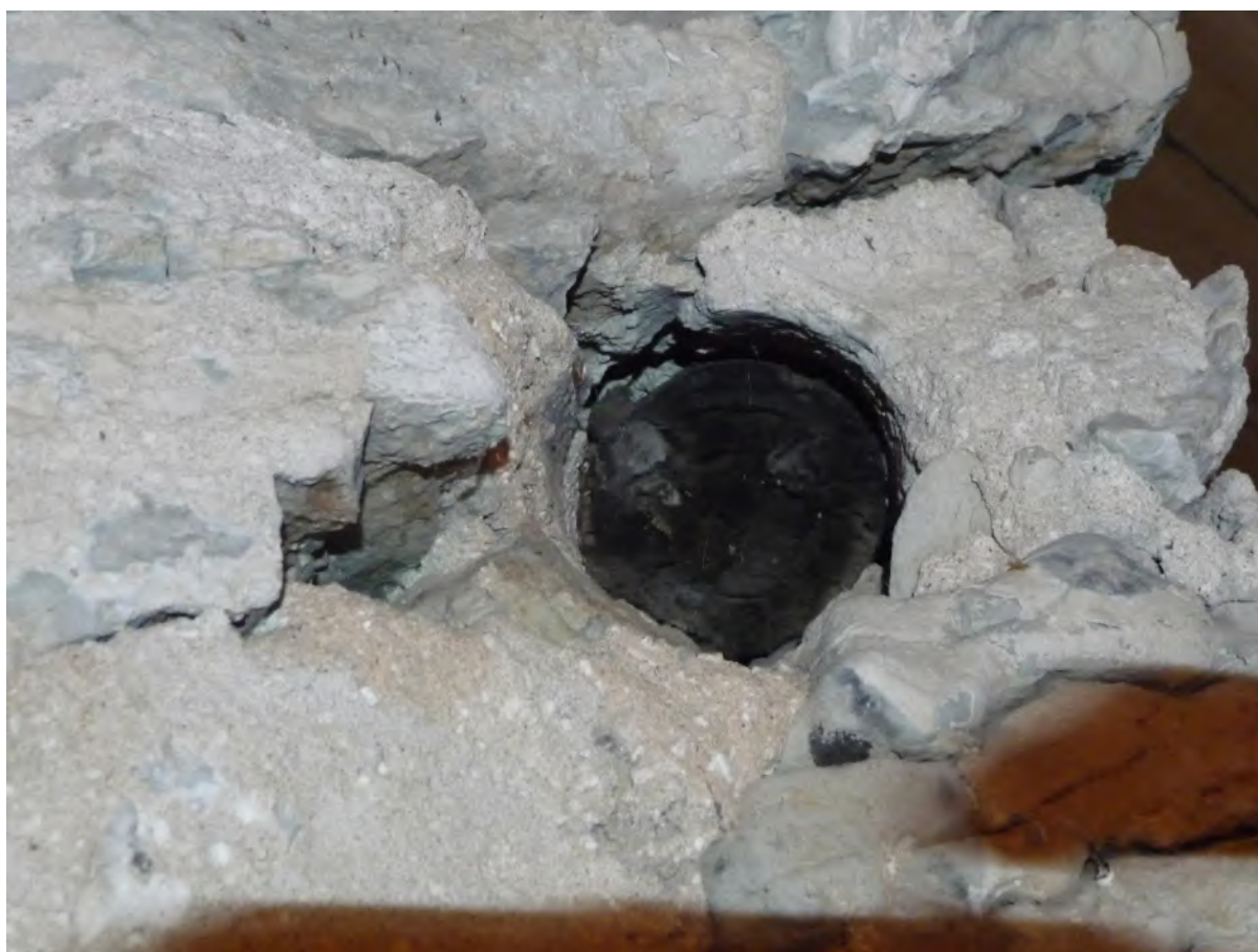
Bomhå i korets östra gavelröste, på övre delens södra sida, med avbränd stock, vilket visar att kyrkans taklag vid okänt tillfälle brunnit, kanske redan på medeltiden. Foto ES 2020.
