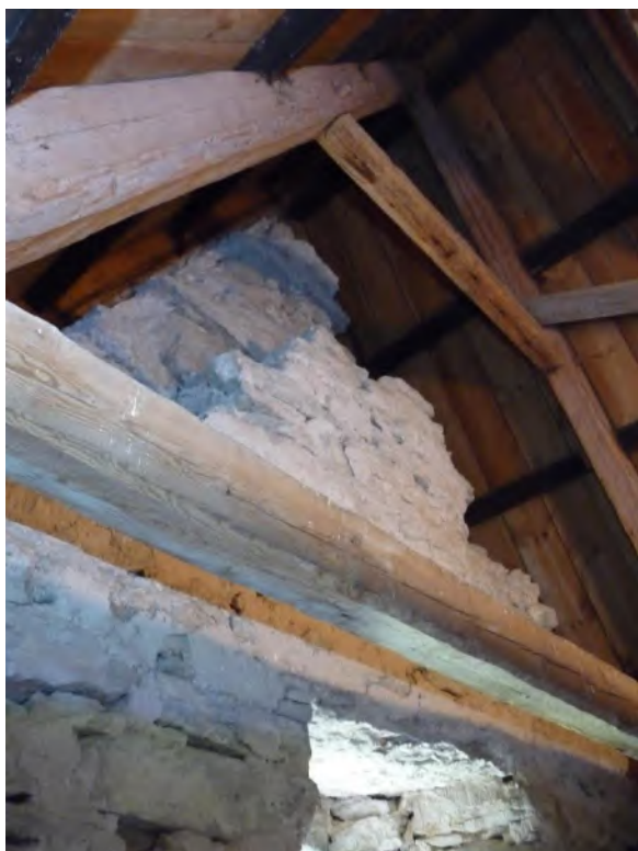
Korets gavelröste sett inifrån mot sydöst. Bomålet i högra bildens övre del innehåller en bränd stock. Foto JL 2020.
