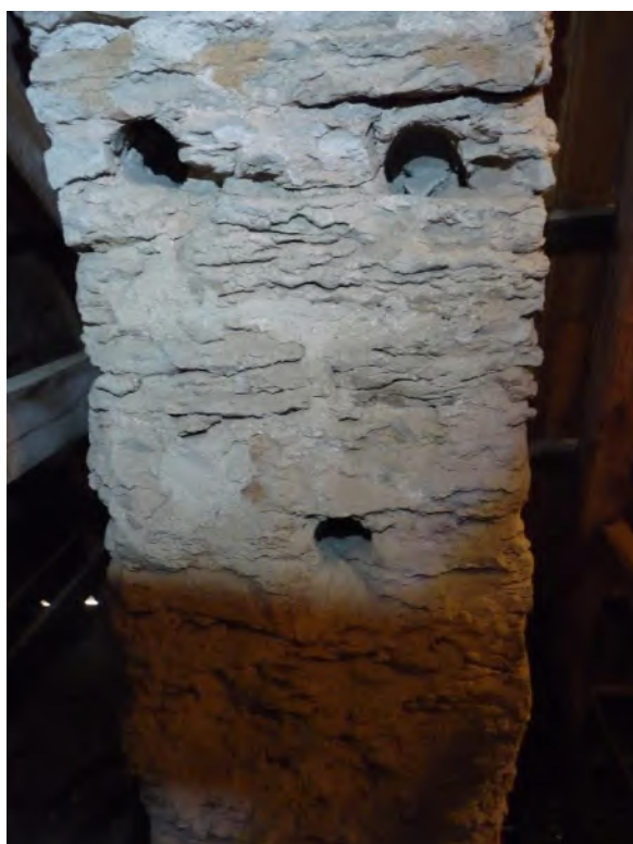
Bomhål på insidan till triumfbågsurens öppning mellan långhus- och korvinden. Till höger korvinden, valvens ovansida sedd mot söder. Foto JL 2020.
