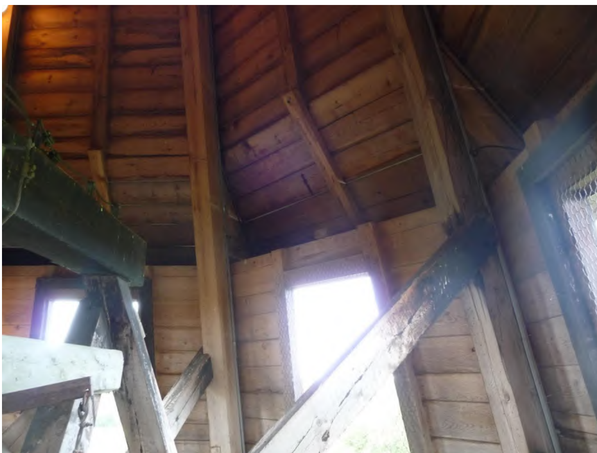
Klockvåningen i tornhuven sedd mot sydväst. Foto JL 2020.
