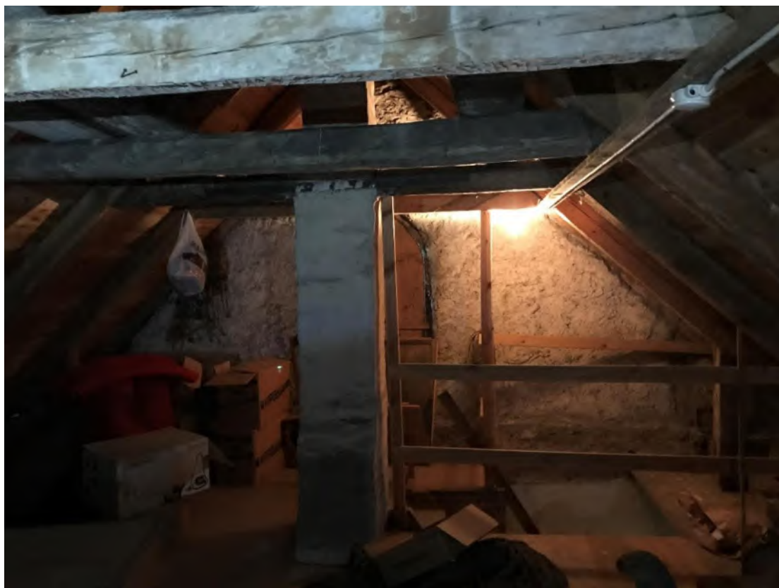
Sakristievinden sedd mot norr. Foto JL 2020.
