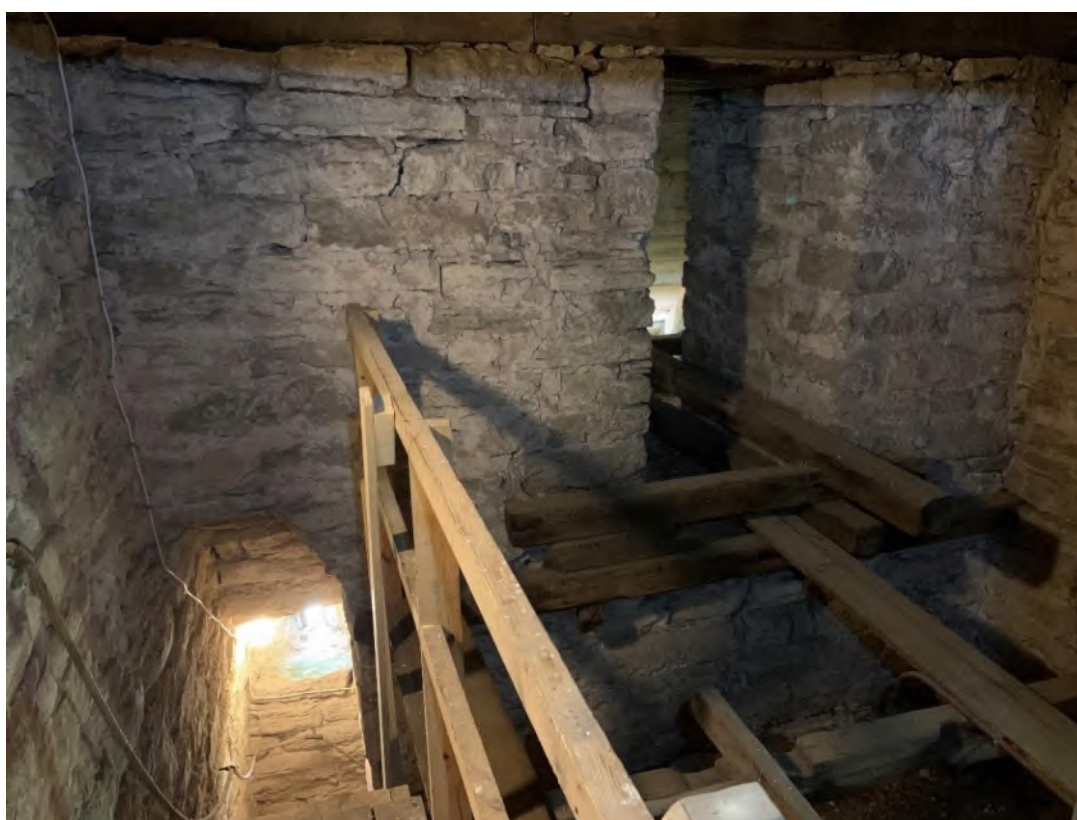
Våningen ovanför ringkammarens valv, sedd mot söder. Till vänster trappans mynning vid sydfasadens ljusglugg. Till höger utgång till det ej färdigställda södra galleriet. Foto JL 2020.
