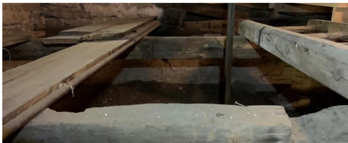
Detalj av bjälklaget av äldre takstolsvirke, sannolikt från tidigare stenkyrkan. Foto JL 2020.
