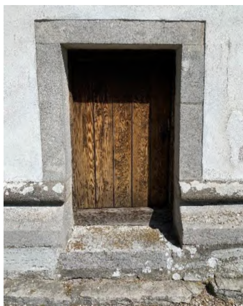
Ingång till kammaren i södra muren. Foto JL 2020.
