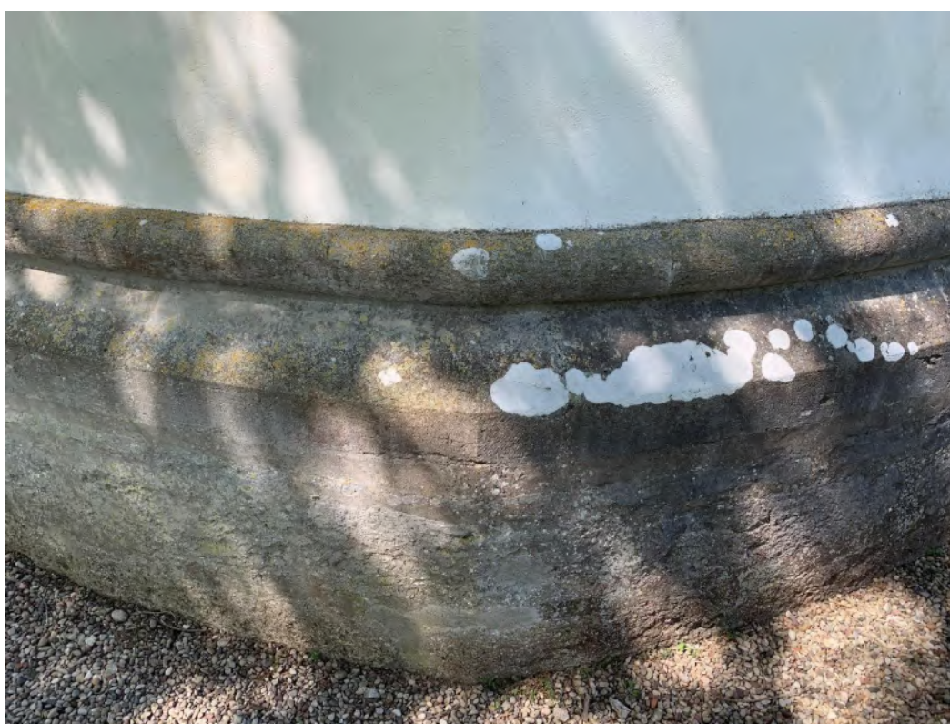
Absidens sockel med spetsig avslutning. Foto JL 2020.
