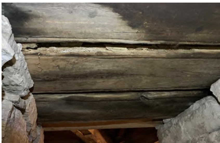
Återanvända takbräder som avtäckning i öppningen ovan, sedda mot norr. Foto JL 2020.
