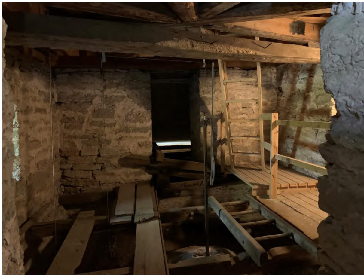
Våningen ovanför ringkammarens valv, sedd mot norr. Bjälklaget består av takstolsvirke, sannolikt från tidigare stenkyrkan. Foto JL 2020.
