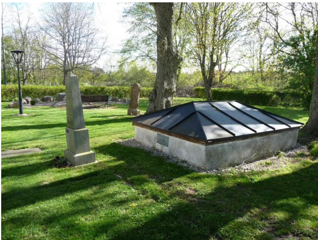
Stor uppmurad gravkammare i kalksten med plåttak för kyrkoherde A. J. Myrdal från 1832. Utpekad som kulturhistoriskt värdefull på grund av sin ålder och utformning i gravvårdsinventeringen. Foto ES 2020.
