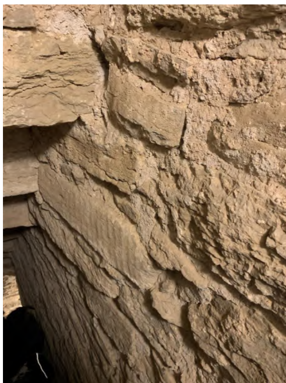
Till vänster: Fasadstenar från den äldre stenkyrkan, inmurade i murtrappan i södra muren. Foto JL 2020. Till höger: Trapploppets övre del vid ljusgluggen i sydfasaden. Foto JL 2020.
