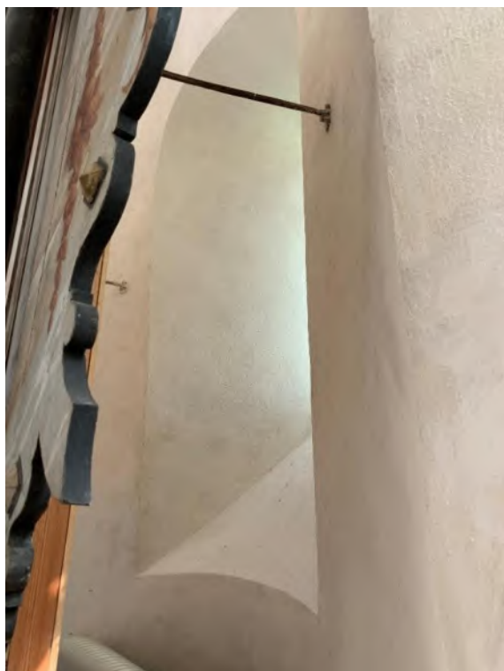
Absidens östra fönster, sett inifrån. Foto JL 2020.
