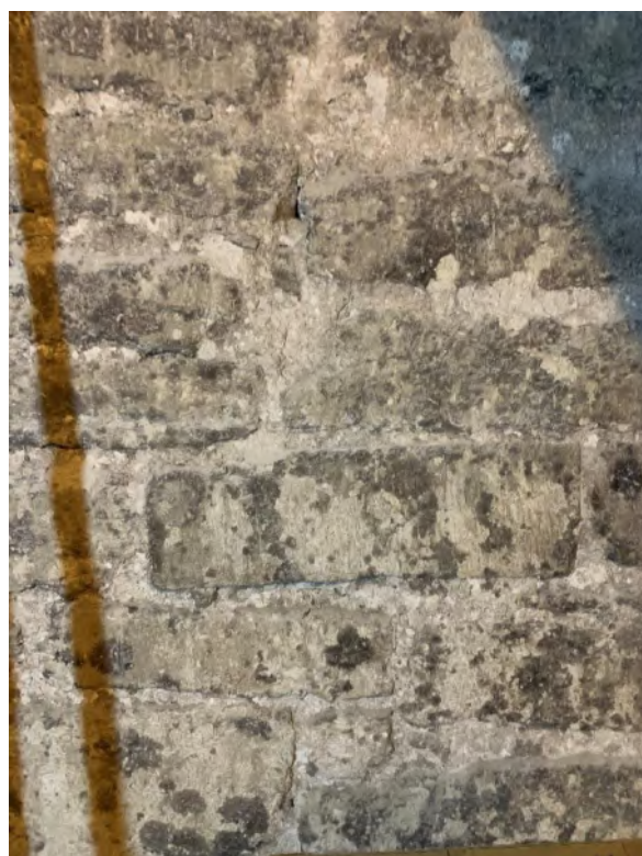
Murverket på korets norra fasad, synligt inifrån sakristiebyggnadens vind, visande återanvänd sten från den äldre stenkyrkan. Den torkade lavpävåxten visar att muren stod utan puts när sakristian började byggas år 1800. Foto JL 2002.
