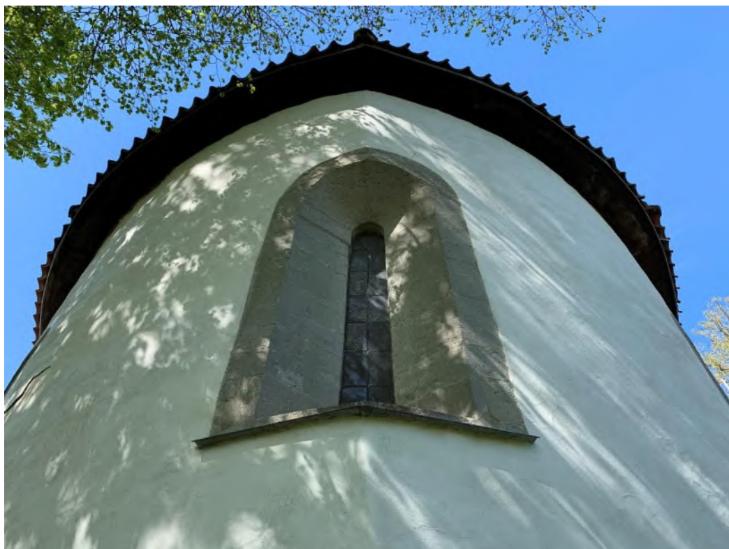
Absidens östra fönster. Omfattningen återger planens spetsbågiga form. Foto JL 2020.
