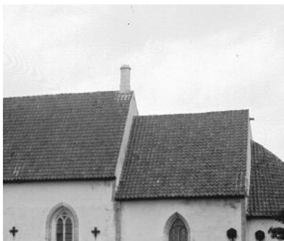
Skorstenen på långhuset. Se bild s. 9. Foto Einar Erics 1914. RAÄ, Kulturmiljöbild.
