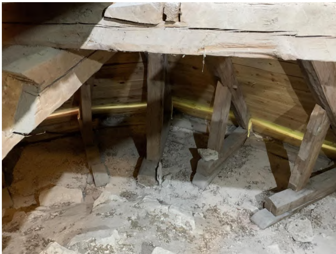
Absidvinden mot öster. Foto JL 2020
