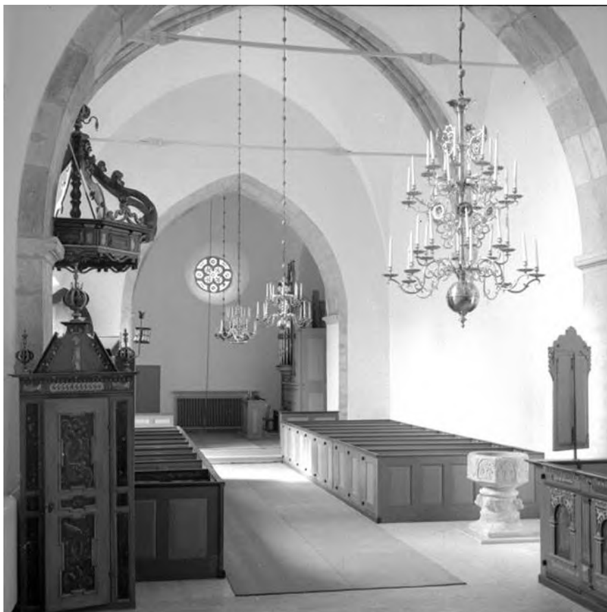
Interiör mot väster efter avslutad restaurering. Foto Gunnar Svahnström 1957. RAÄ, Kulturmiljöbild.
