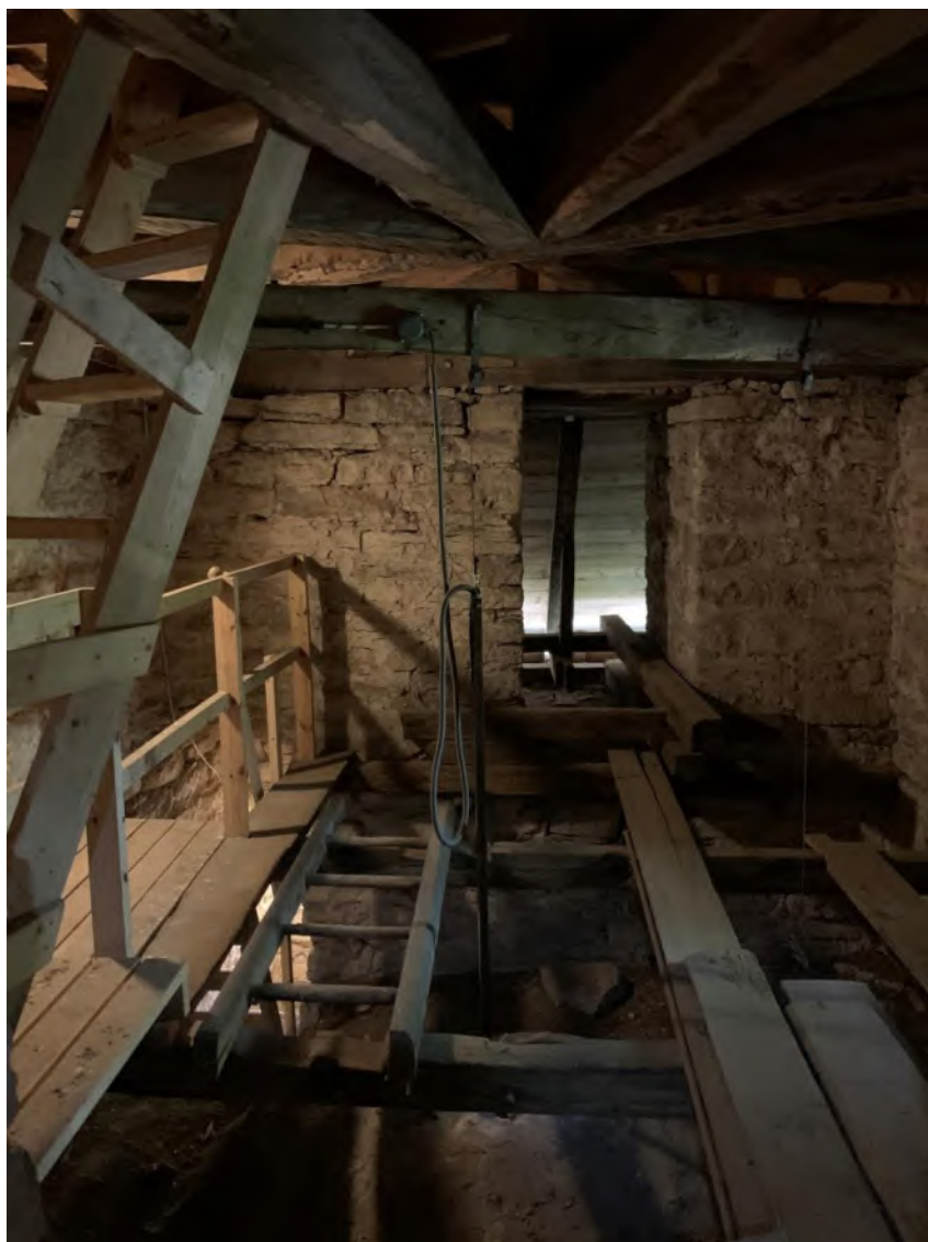
Våningen ovanför ringkammarrens valv, sedd mot söder. Foto JL 2020.
