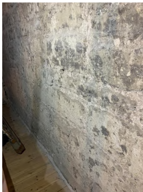
Murverket på korets norra fasad, synligt inifrån sakristiebyggnadens vind, visande återanvänd sten från den äldre stenkyrkan. Den torkade lavpävåxten visar att muren stod utan puts när sakristian började byggas år 1800. Foto JL 2002.
