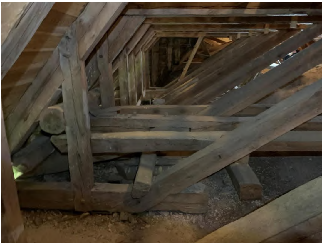
Långhusvindens norra del sedd mot öster. Foto JL 2020.
