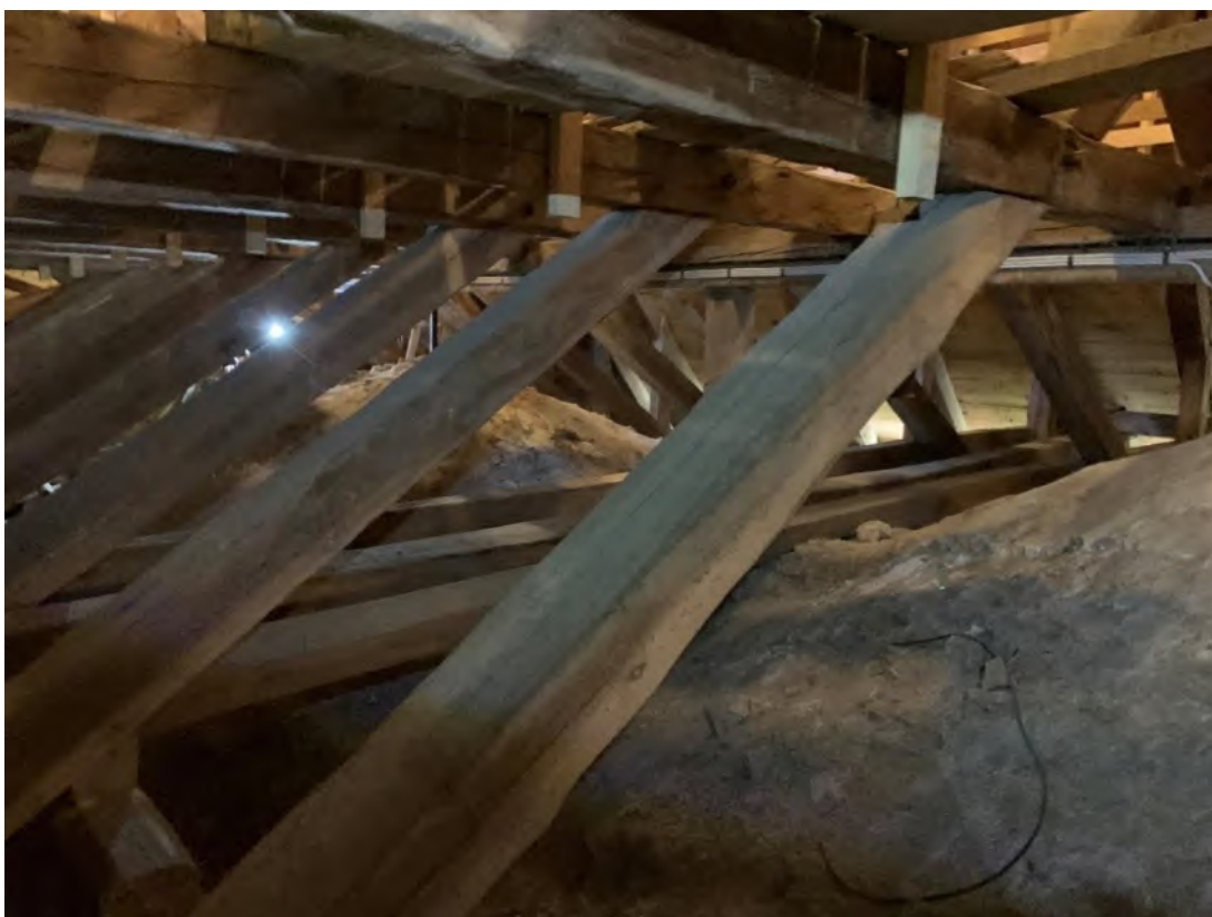
Långhusvinden sedd mot sydöst. Foto JL 2020.
