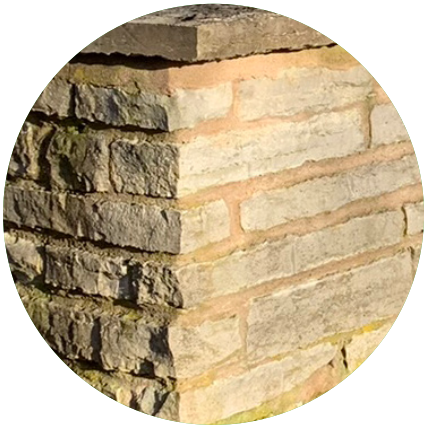
Demonerad kalksten från Kyrkmuren återanvänds i stödmurar
