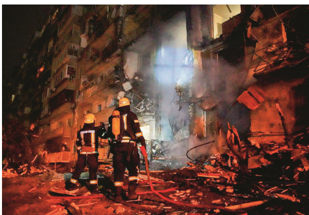
Bild ovan; Brandmän inspekterar skadorna efter att en byggnad träffats av raketer. Kiev, Ukraina, 25 februari 2022.
