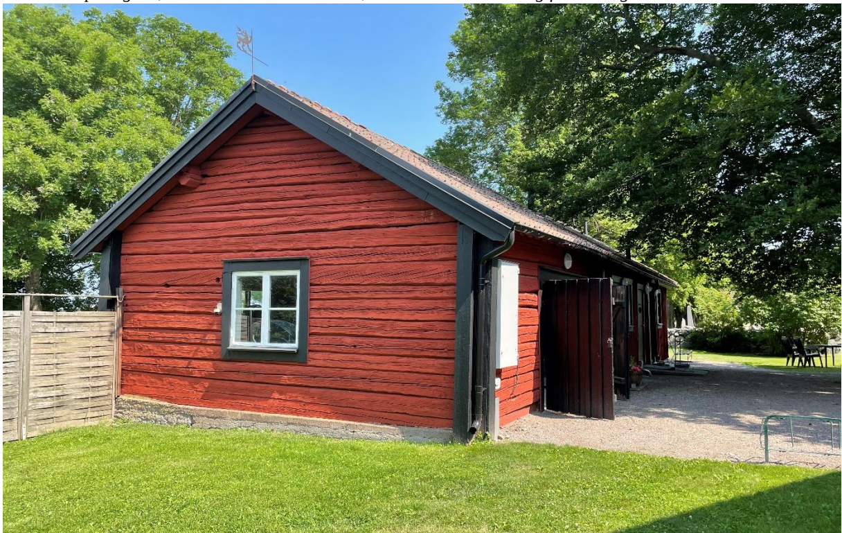
Före detta sockenstuga från 1760-tal. Idag förråd.
