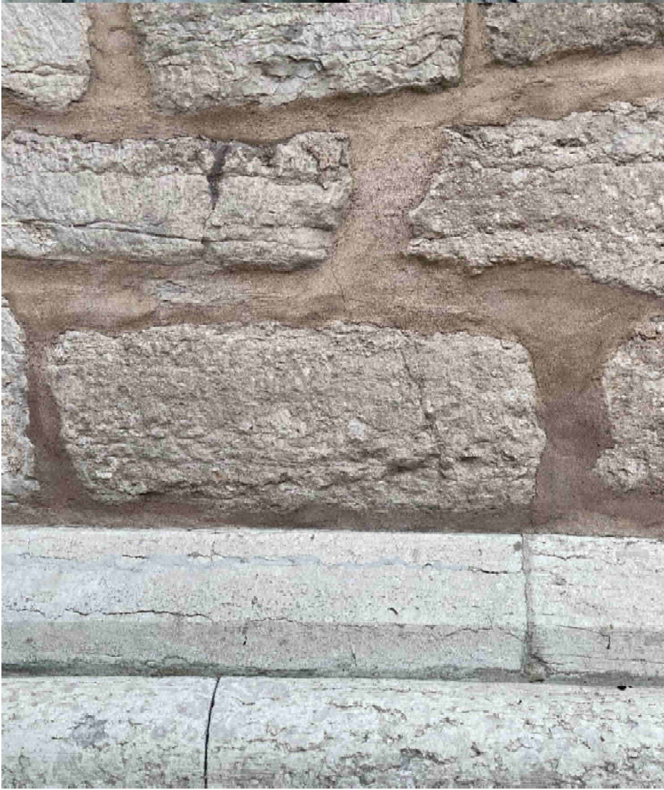
Visby Domkyrka med Webers hydrauliska kalkbruksfog enligt Renovums program 2013–2014.
