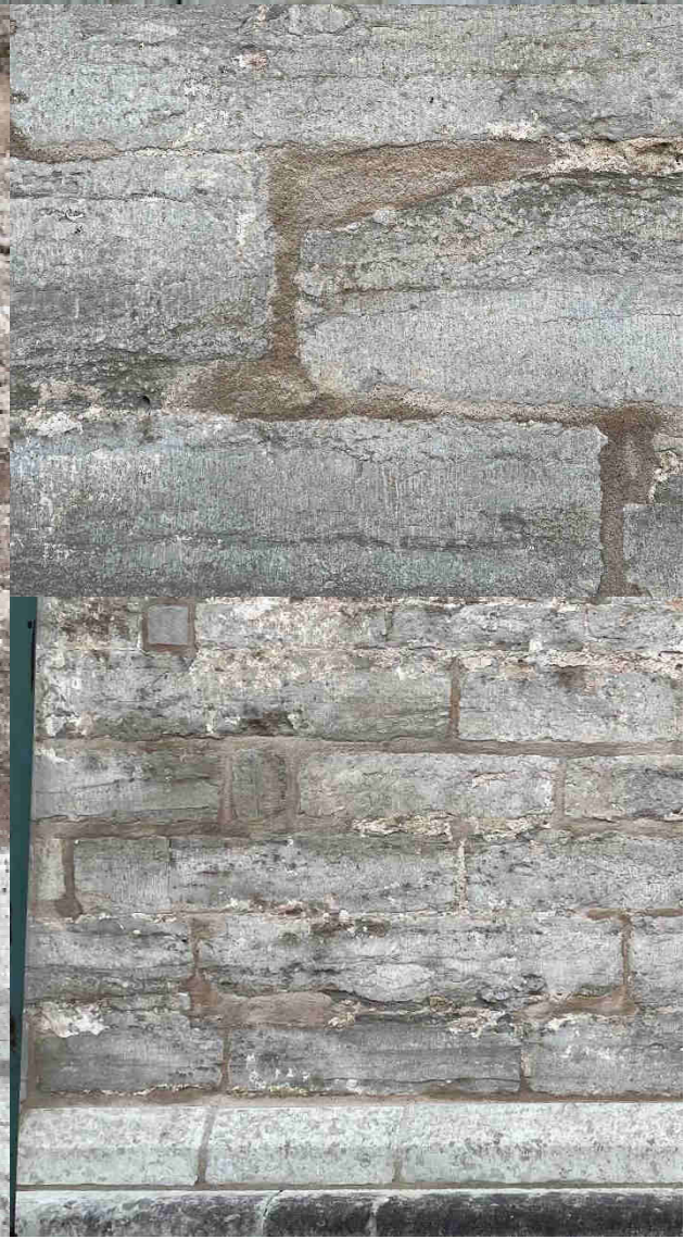
Visby Domkyrka med Webers hydrauliska kalkbruksfog enligt Renovums program 2013–2014.
