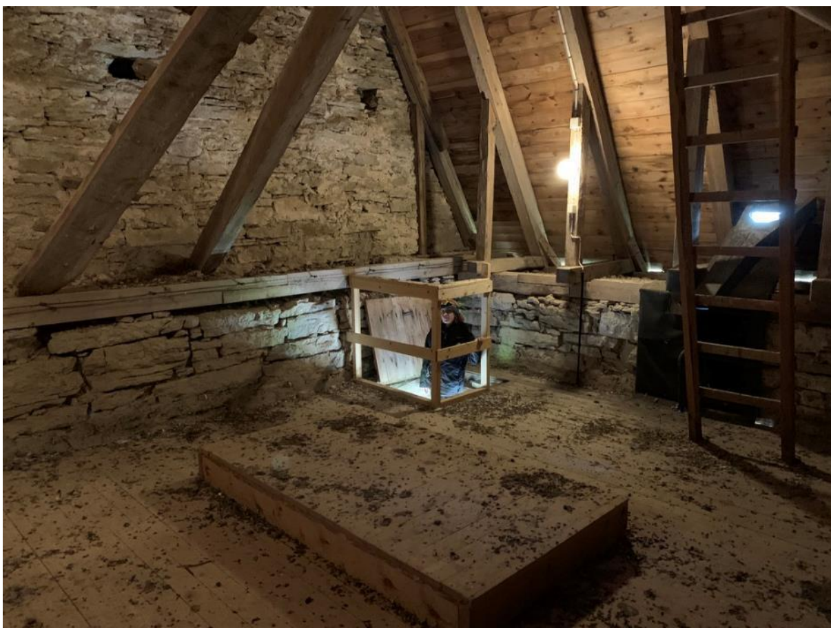
Vindsvåningen innanför sadeltaket på tornet, sedd mot sydöst. Foto JL 2020.
