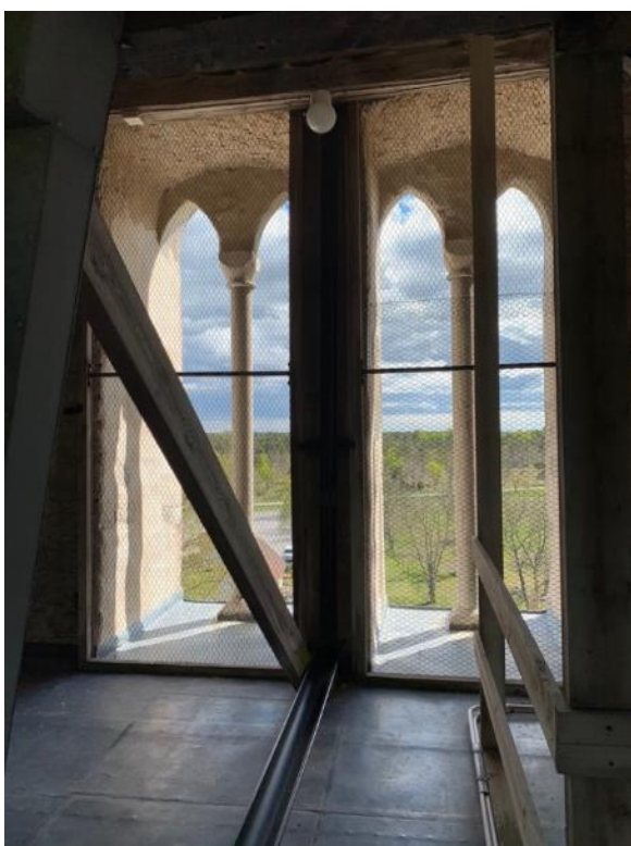
Ljudgluggar mot söder och bränt trä i klockvåningens murar. Foto JL 2020.
