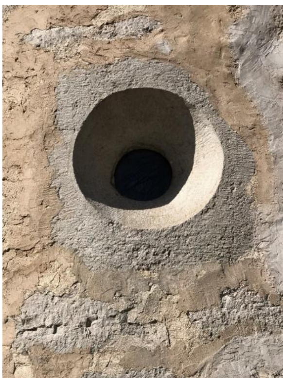
Absidens rundfönster från öster. Till höger absidens sockel. Sockelstenarna har en något snävare radie än absiden. Foto JL 2018.
