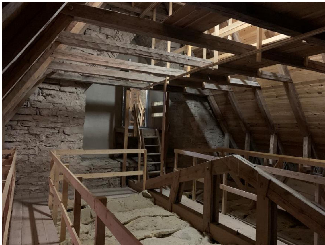
Långhusvinden mot väster. Foto JL 2020.
