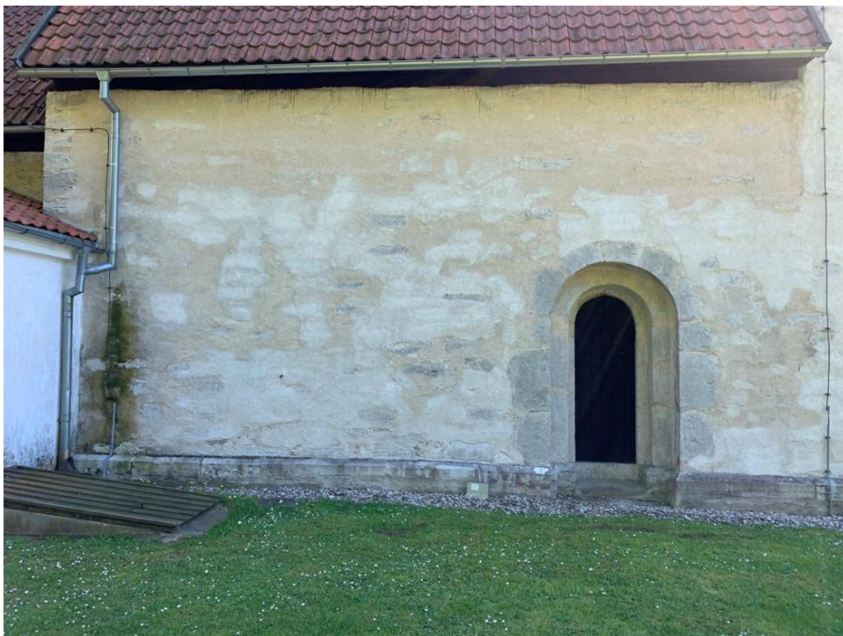
Långhusets norra fasad. Foto JL 2020.
