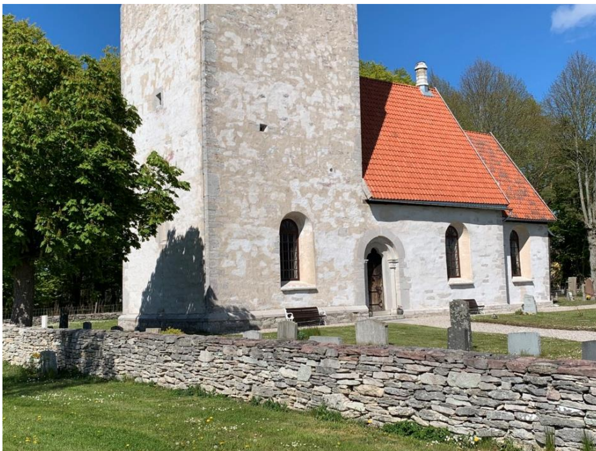
Tornets nedre del från sydväst. Foto JL 2020.
