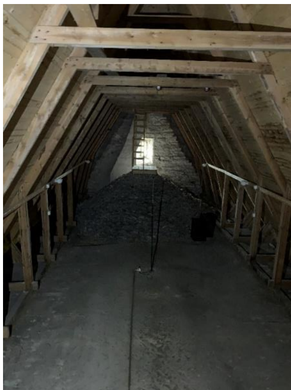
Tornets östra mur mot kyrkvinden. Avtrycket av ett flackt sadeltak sannolikt från skyddstaken efter branden 1938. T.h. kyrkvinden mot öster. Foto JL 2020.
