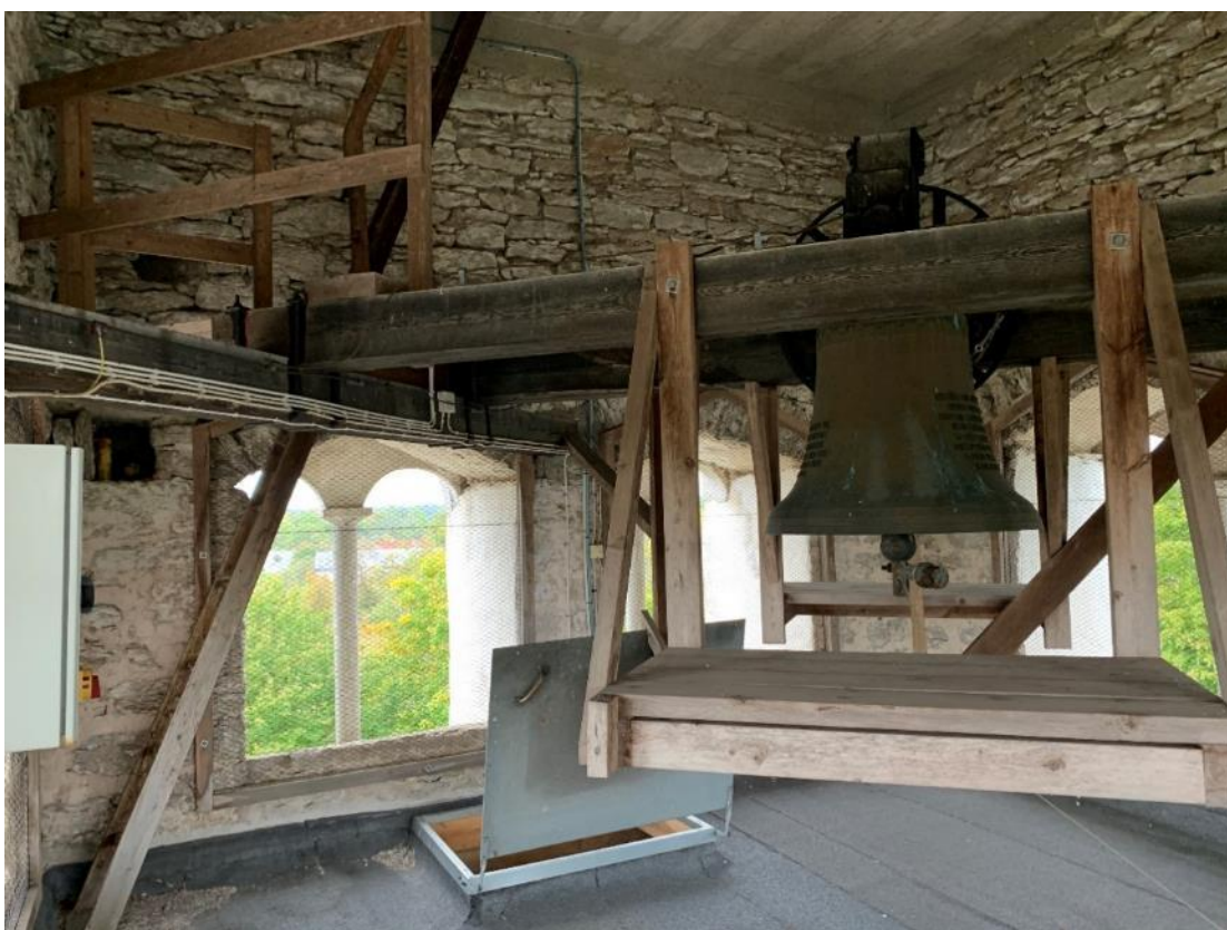
Klockvåningen sedd mot sydväst. Foto JL 2020.
