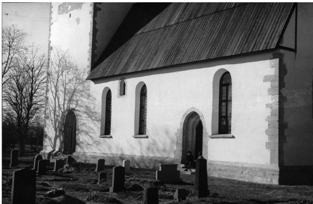
Sydfasaden från efter återuppbyggnaden. Foto Bertil Berthelson 1944, ATA, RAÄ Kulturmiljöbild.
