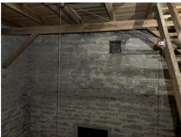
Tornets första övervåning sedd mot öster med nisch i den del av muren som ligger ovanför långhusets södra takfall. T.h. öppning i tornets södra mur med starkt sluttande kanal ner till glugg i tornets sydfasad. Foto JL 2020.
