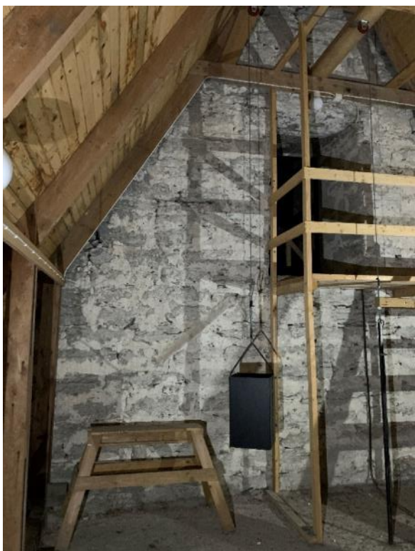
Tornets östra mur mot kyrkvinden. Avtrycket av ett flackt sadeltak sannolikt från skyddstaken efter branden 1938. T.h. kyrkvinden mot öster. Foto JL 2020.
