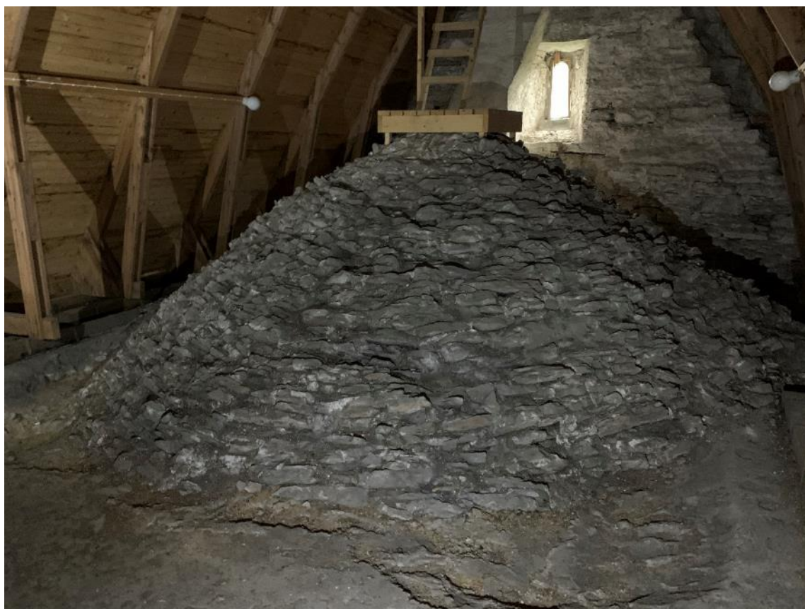
Ovansidan av korets valv, sedd mot nordöst. Foto JL 2020.
