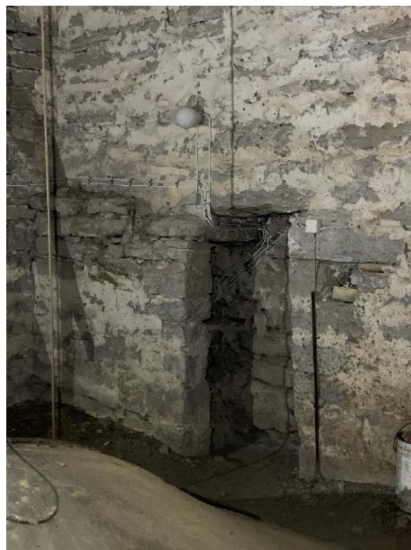
Murtrappan samt ljusglugg i tornets nordvästra hörn. T.h. trappans mynning i tornets första övervåning. Foto JL 2020.
