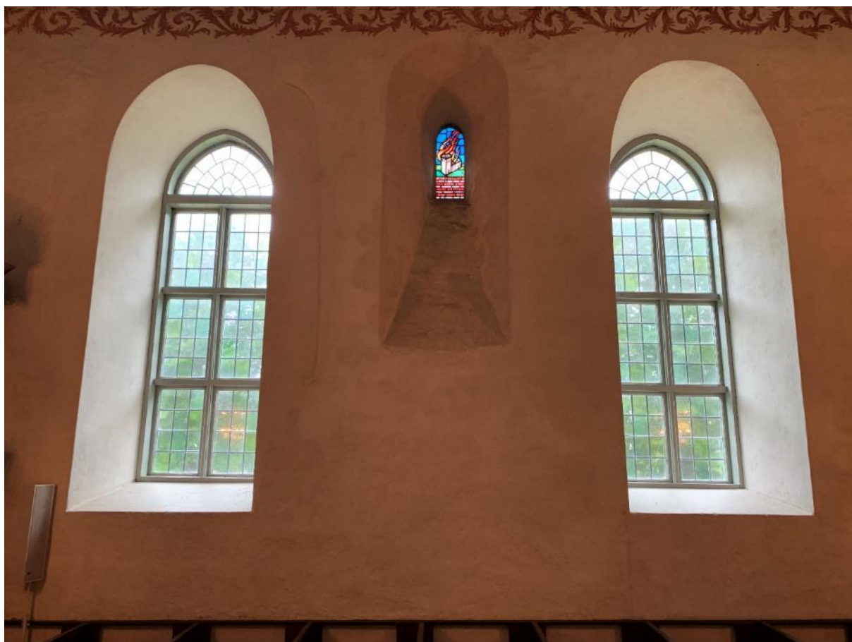
Långhusets södra mur. I mitten ett ursprungligt fönster. Fönstret till höger ersatte ett mindre fönster, vars kontur skymtar på fönstrets vänstra sida. Foto JL 2020.
