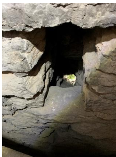
Tornets första övervåning sedd mot öster med nisch i den del av muren som ligger ovanför långhusets södra takfall. T.h. öppning i tornets södra mur med starkt sluttande kanal ner till glugg i tornets sydfasad. Foto JL 2020.
