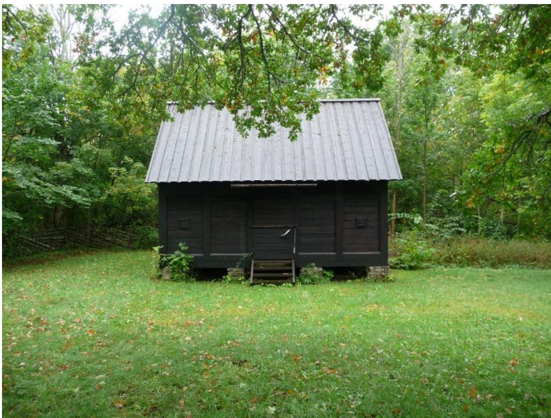
Sockenmagasin från 1866. Stod tidigare vid kyrkogårdens nordöstra hörn. Flyttat till ängat söder om landsvägen 1980. Foto ES 2020.
