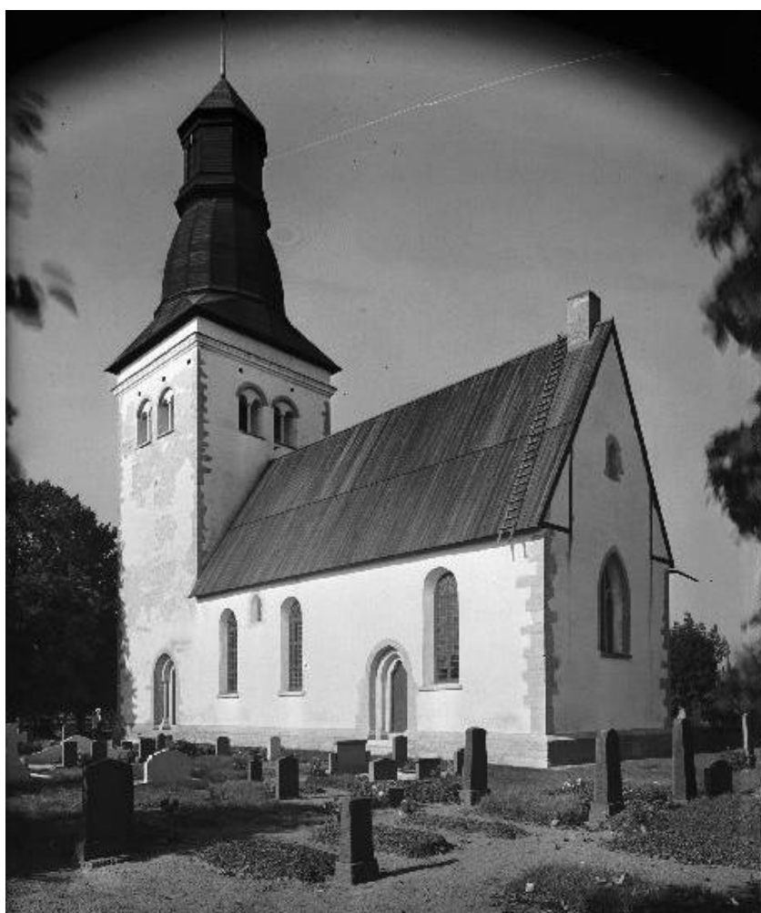
Exteriör från sydöst efter återuppbyggnaden. Foto Nils Lagergren 1958, ATA, RAÄ Kulturmiljöbild. Foton, som detta och det ovan, visar att det återkommande varit problem med putsen på tornets sydfasad.
