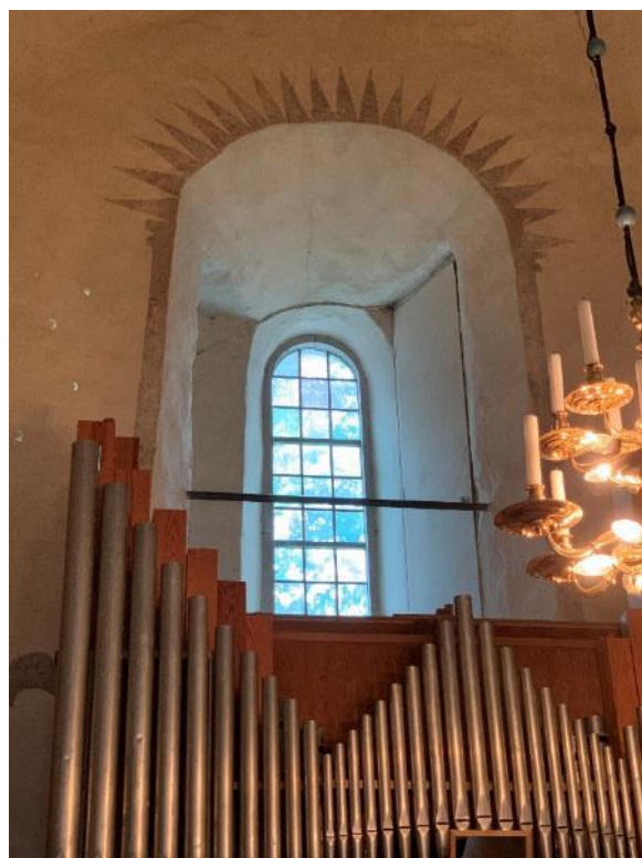
Trapploppet i västra muren sett mot söder från avsatsen i västfönstret. T.h. västfönstrets innersmyg genom vilket murtrappan passerar via ett vilplan, öppet mot kyrkorummet och tidigare använt som läktarutgång. Foto JL 2020.
