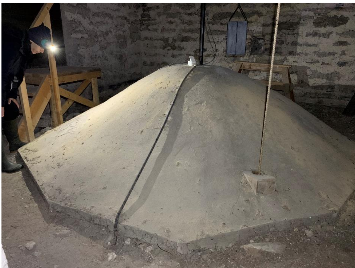
Tornets första övervåning. Ovansidan av ringkammarens valv. Foto JL 2020.
