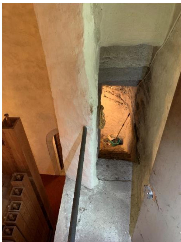
Trapploppet i västra muren sett mot söder från avsatsen i västfönstret. T.h. västfönstrets innersmyg genom vilket murtrappan passerar via ett vilplan, öppet mot kyrkorummet och tidigare använt som läktarutgång. Foto JL 2020.
