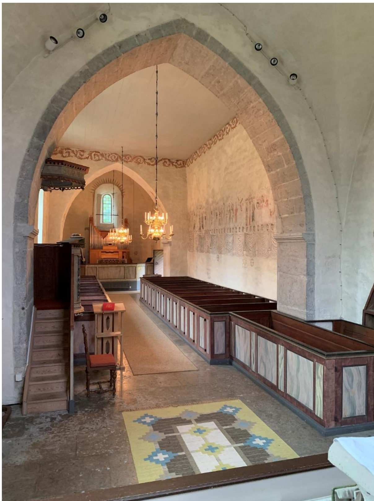
Interiör av koret mot väster. Foto JL 2020.
