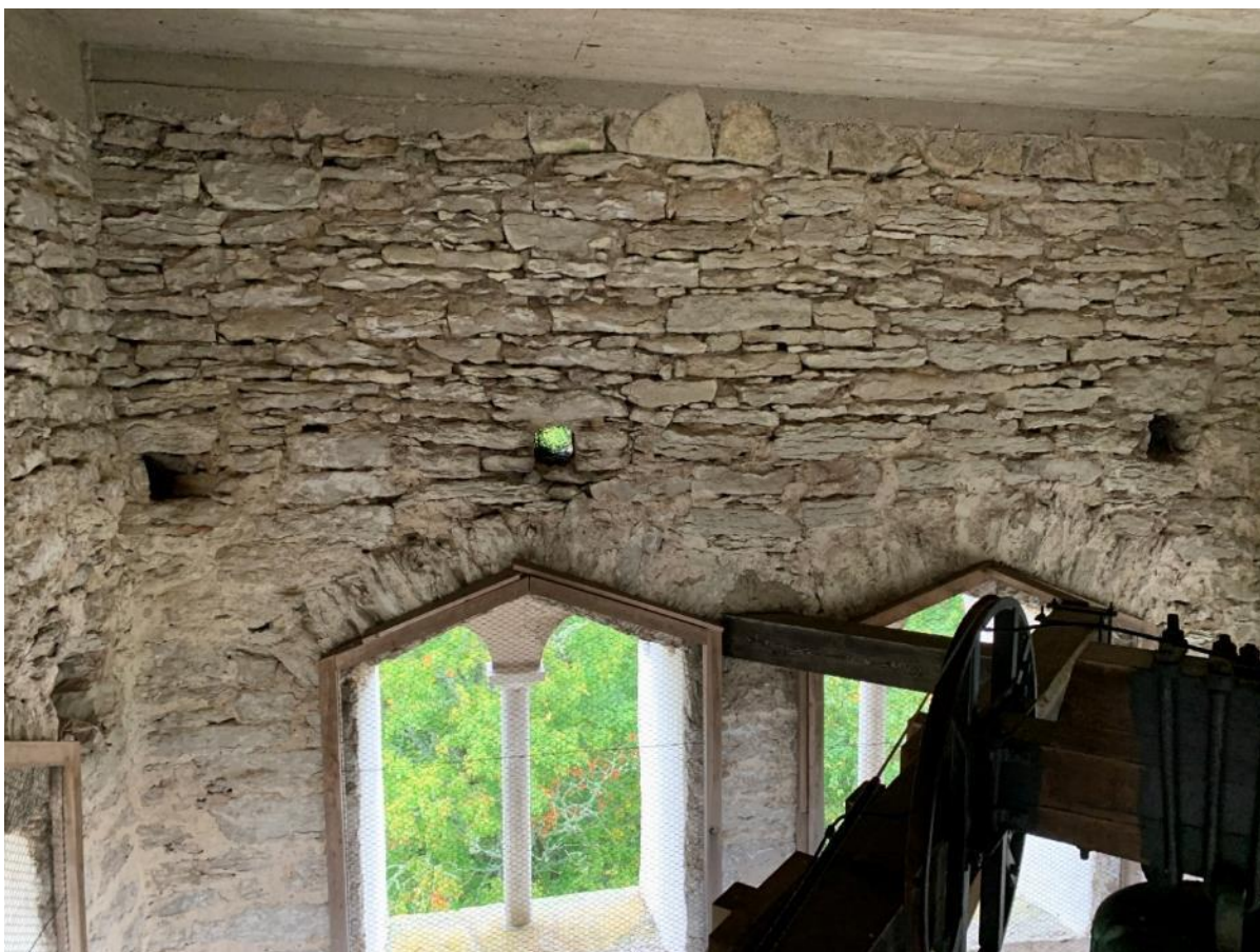
Klockvåningens övre del, sedd mot väster, med radiellt utskjutande bjälkhål. Foto JL 2020.
