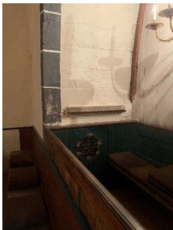
Tornbågens södra och norra båganfang. Observera sockelstenen på bilden till höger. En motsvarande sockel skymms under bänken på södra sidan. Foto JL 2020.
