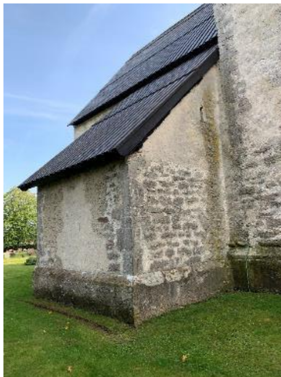
Sakristian från nordöst och nordväst. Gavlarna tillkomna vid en ombyggnad från sadeltak i nord-sydlig riktning till pulpettak. Foto JL 2020.
