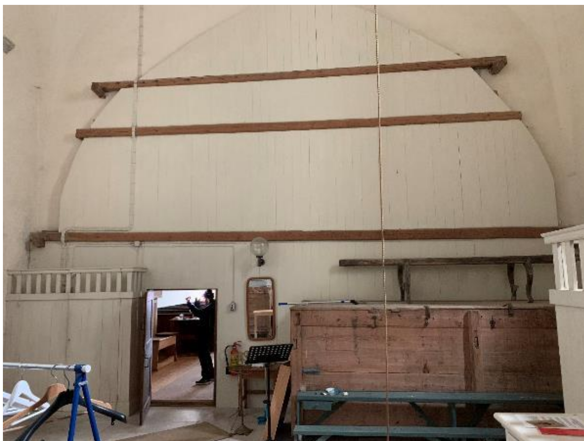
Träväggen i tornbågen sedd från väster.
