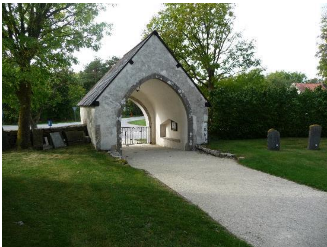
Huvudingången i väster med en stiglucka. Gången som leder fram till kyrkan är belagd med finkornigt kalkstensgrus. Foto ES 2020.
