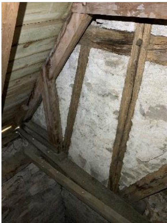
Röset av korsvirke över det gotiska långhusets västgavel, dess norra och södra nedre del, sett mot nordöst och sydöst. Korsvirkesgaveln har en betydligt slätare och putsad yta mot väster. Avtryck av ett tidigare, lägre placerat yttertak över det romanska långhuset visar att korsvirkesröset, som sannolikt byggdes vid takombyggnaden 1700, var fasadyta före takhöjningen över västpartiet. Foto JL 2020.
