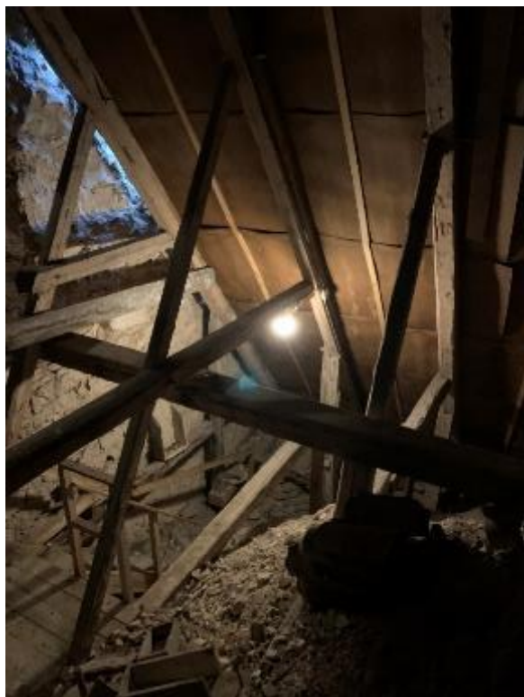
Korvinden sedd mot nordväst med trappans mynning. T.h. brandskador på triumfbågmurens nedre del i korets nordvästra hörn. Foto JL 2020.
