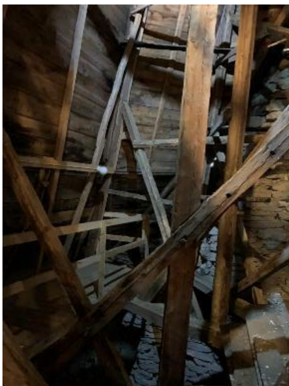
Tornvinden mot sydväst och nordväst. Det stjärnformade bjälklaget under huvens (takryttarens) konstruktion synligt. Foto JL 2020.
