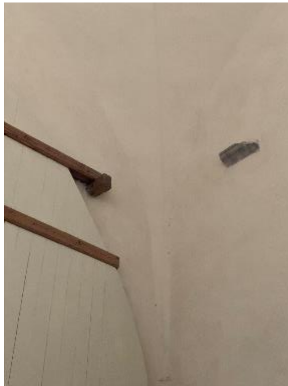
Ringkammaren uppåt mot nordöst och sydöst med brädväggens förankring samt konsoler efter tidigare valv. Foto JL 2020.
