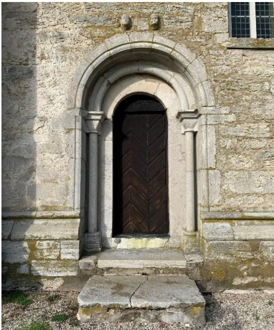
Korportalen, tidigare sydportal i det äldre långhuset, nuvarande tornet. Foto JL 2020.
