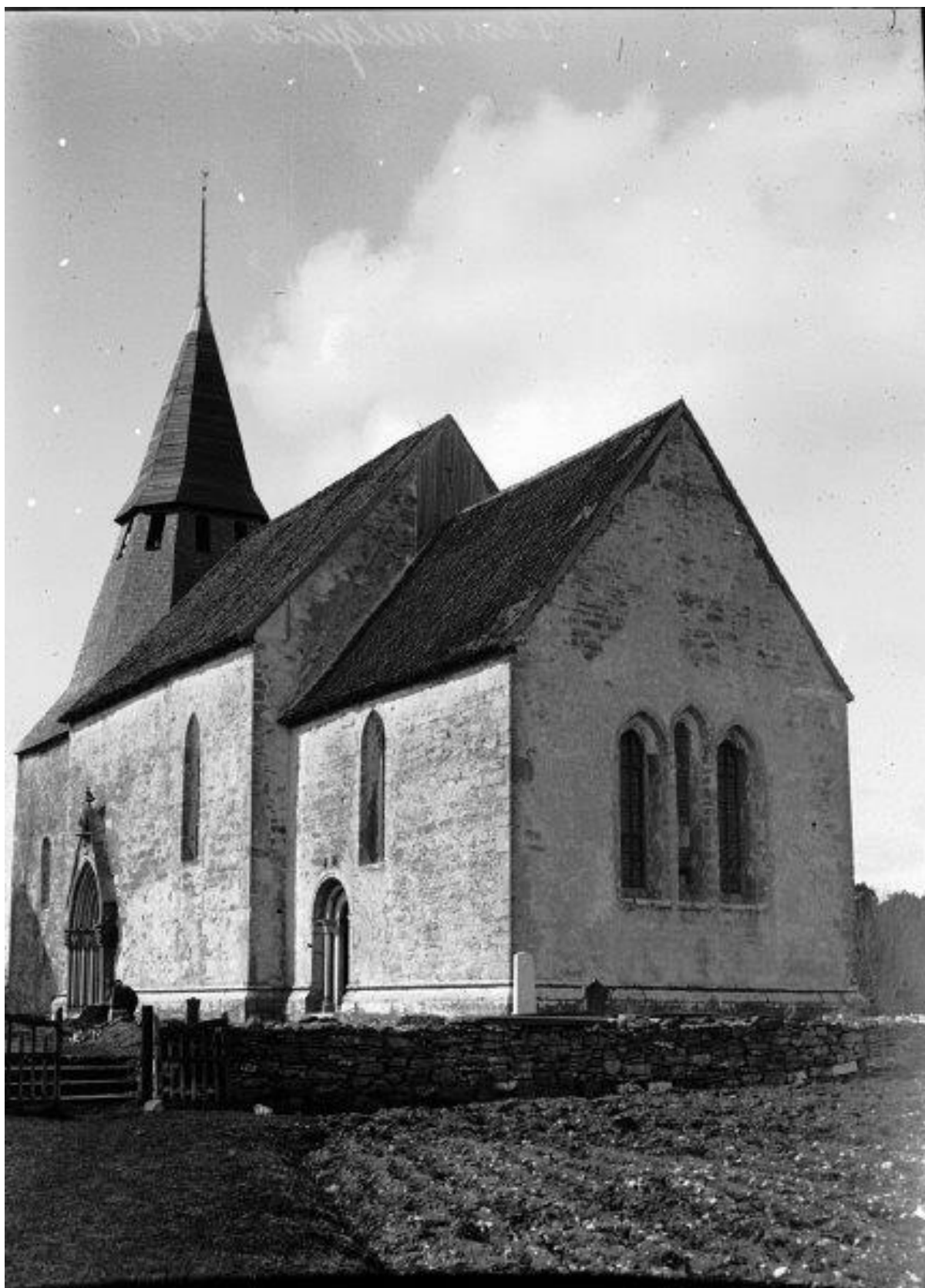
Exteriör från sydöst före restaureringen 1956–58. I långhusets östra gavel är avtrycket tydligt från korets högre takfall och gavelns övre del i trä är ännu inte putsad. Puts kvarsitter på korets östra gavel och trefönstergruppen saknar ännu masverk. Foto Einar Erics 1916, ATA, RAÄ Kulturmiljöbild.
