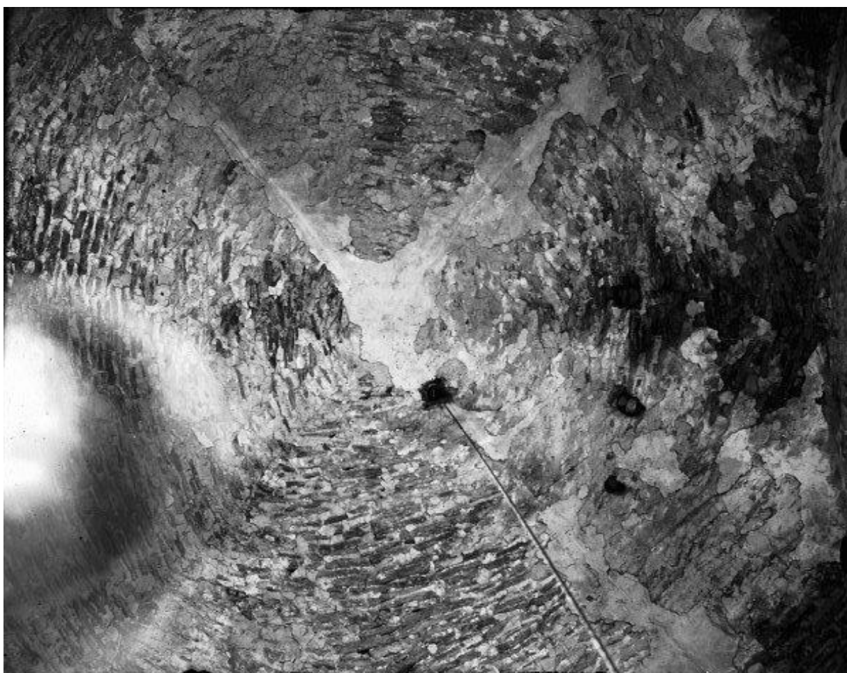
Ringkammarrens (\"ödekyrkans\", magasinets) valv sett underifrån. Foto Johnny Roosval 1915, ATA, RAÄ Kulturmiljöbild.
