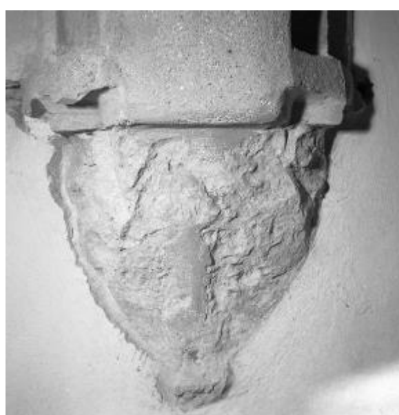
Långhusets västra och östra valvkonsoler med tydliga brandskador, frilagda från puts under restaureringen 1956–58. Foto Gunnar Svahnström 1957-58, ATA, RAÄ Kulturmiljöbild.
