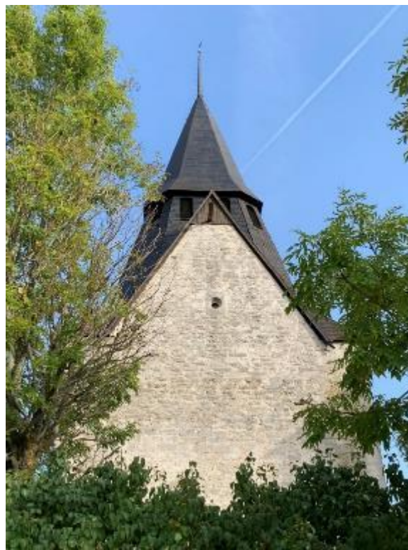
Tornhuven byggd som takryttare på det romanska långhusets västra del, sedd från söder. Till höger tornhuven (takryttaren) samt det romanska långhusets gavelröste från väster. Foto JL 2020.
