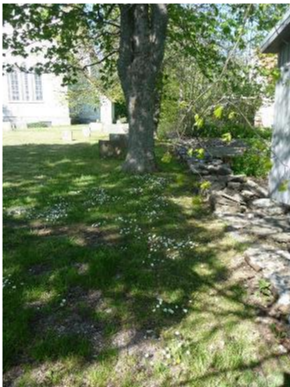
Mursträckningen i öster. Nivåskillnaden på in- och utsidan är stor genom jordpåfyllnad på kyrkogården. Foto ES 2020.
