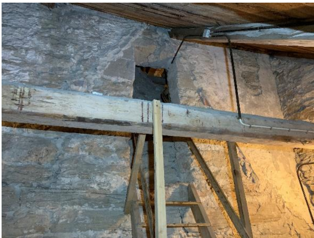
Sakristievinden uppåt mot söder med avtryck av tidigare sadeltak över sakristian. Foto JL 2020.
