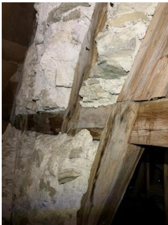
Långhusets västra gavelröste mot sydväst. Röset mellan långhuset och tornet är murat i korsvirke. Foto JL 2020.
