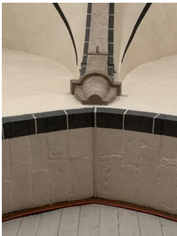
Långhusets västra valvkonsol, liksom den östra (se föregående bild) formad i betong vid restaureringen 1956–58 som ersättning för de brandskadade ursprungliga. Foto JL 2020. Den lilla öglan av järn har troligen fäst en trissa för locket till dopfunten som alltså varit placerad här nedanför tidigare.
