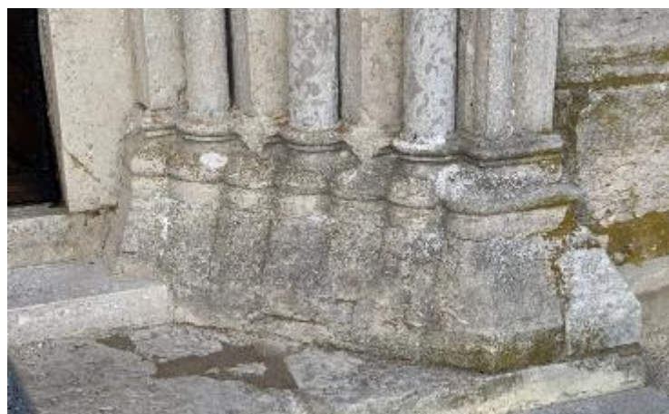
Långhusportalens tympanon samt västra och östra basband. Foto JL 2020.
