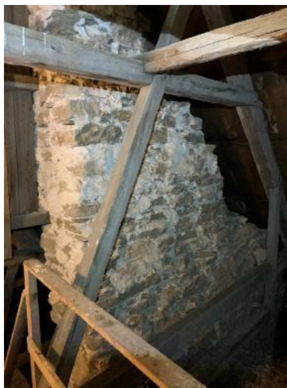
Långhusvinden sedd mot nordöst med triumfbågmurens norra, påmurade del. Foto JL 2020.
