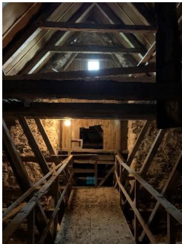
Triumfbågsurens gavelröste, den tunnare påbyggda delen mot norr. T.h. långhusvinden mot öster med gavelröset och öppningen mot korvinden. Foto JL 2020.
