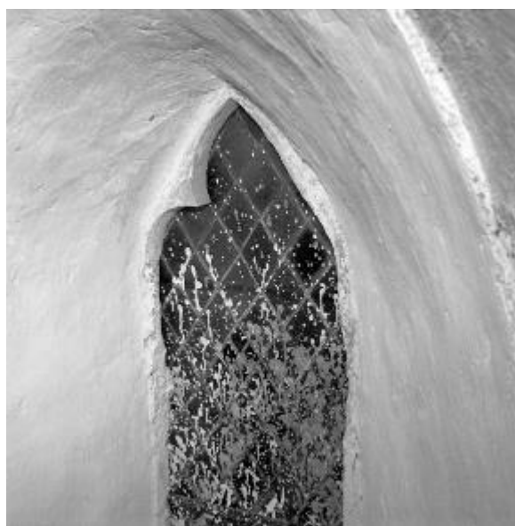
Det norra och mellersta av korets tre östfönster före restaureringen 1956–58, då masverken i korets fönster rekonstruerades utifrån spår i omfattningen och bevarade stenfragment. Foto Gunnar Svahnström 1957–58, ATA, RAÄ Kulturmiljöbild.
