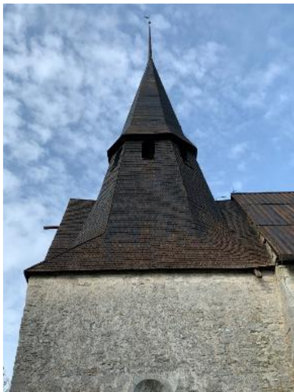
Tornhuven byggd som takryttare på det romanska långhusets västra del, sedd från söder. Till höger tornhuven (takryttaren) samt det romanska långhusets gavelröste från väster. Foto JL 2020.
