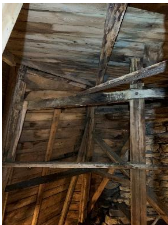
Tornvindens övre södra del mot väster strax under klockdäcket. T.h. skadad knut i huvkonstruktionen. Foto JL 2020.
