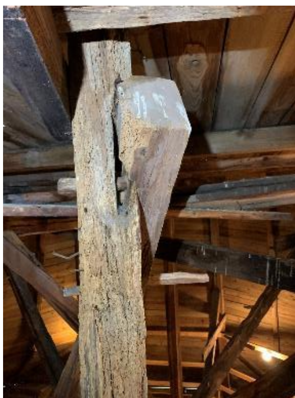
Tornvindens övre södra del mot väster strax under klockdäcket. T.h. skadad knut i huvkonstruktionen. Foto JL 2020.
