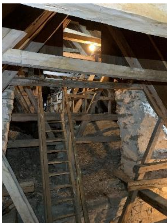
Korvinden mot väster och öster. T.v. öppningen mot långhusvinden. Triumfbågsmuren upp till öppningens nederkant äldre med brandskadat, sannolikt medeltida murverk. Den tunna gavelmuren däröver med brett utstruket fogbruk yngre, kanske från 1700-talets takomläggningar. T.h. östgavelns insida. En av hanbjälkarna har årtalet 1752 med rödkrita. Foto JL 2020.
