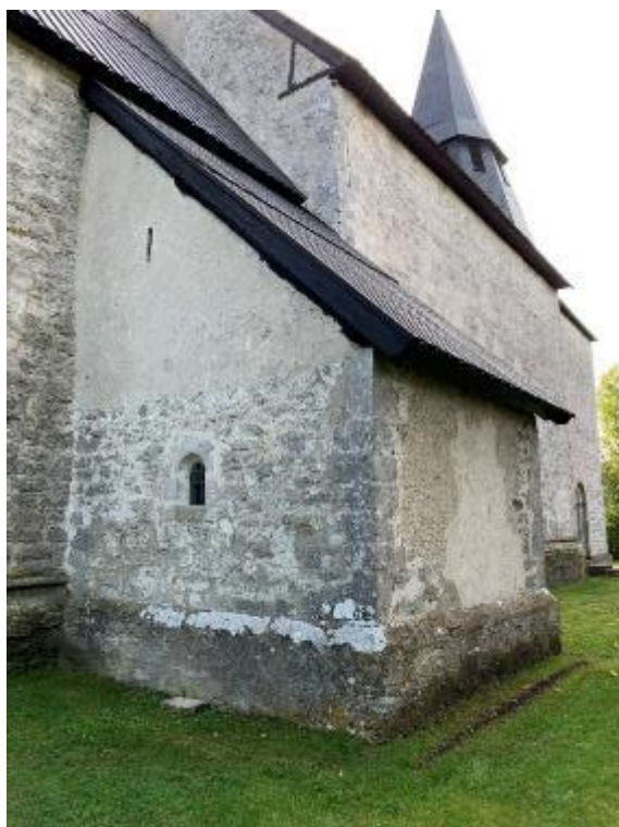
Sakristian från nordöst och nordväst. Gavlarna tillkomna vid en ombyggnad från sadeltak i nord-sydlig riktning till pulpettak. Foto JL 2020.
