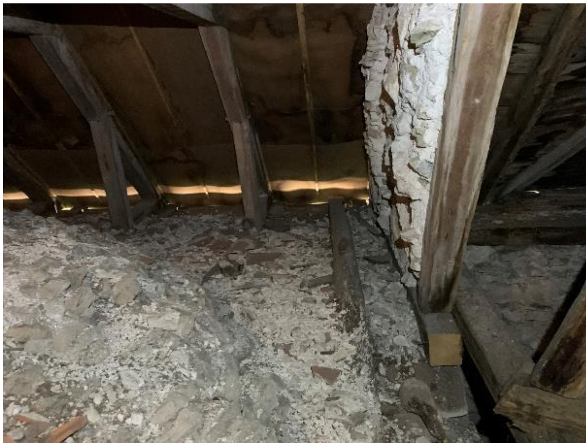
Långhusvinden sydvästra hörn. Foto JL 2020.
