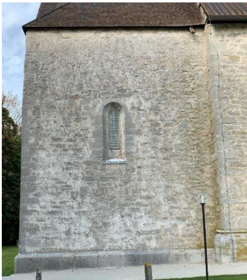
Tornets eller det romanska långhusets sydfasad, förhöjd 1755. Under fönstret var tidigare platsen för sydportalen, nu i koret. Foto JL 2020.
