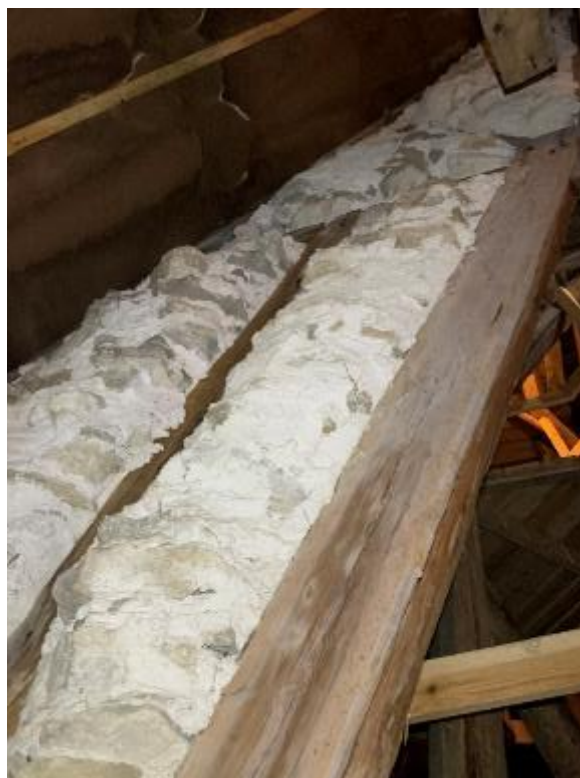
Långhusets västra gavelröste mot sydväst. Röset mellan långhuset och tornet är murat i korsvirke. Foto JL 2020.
