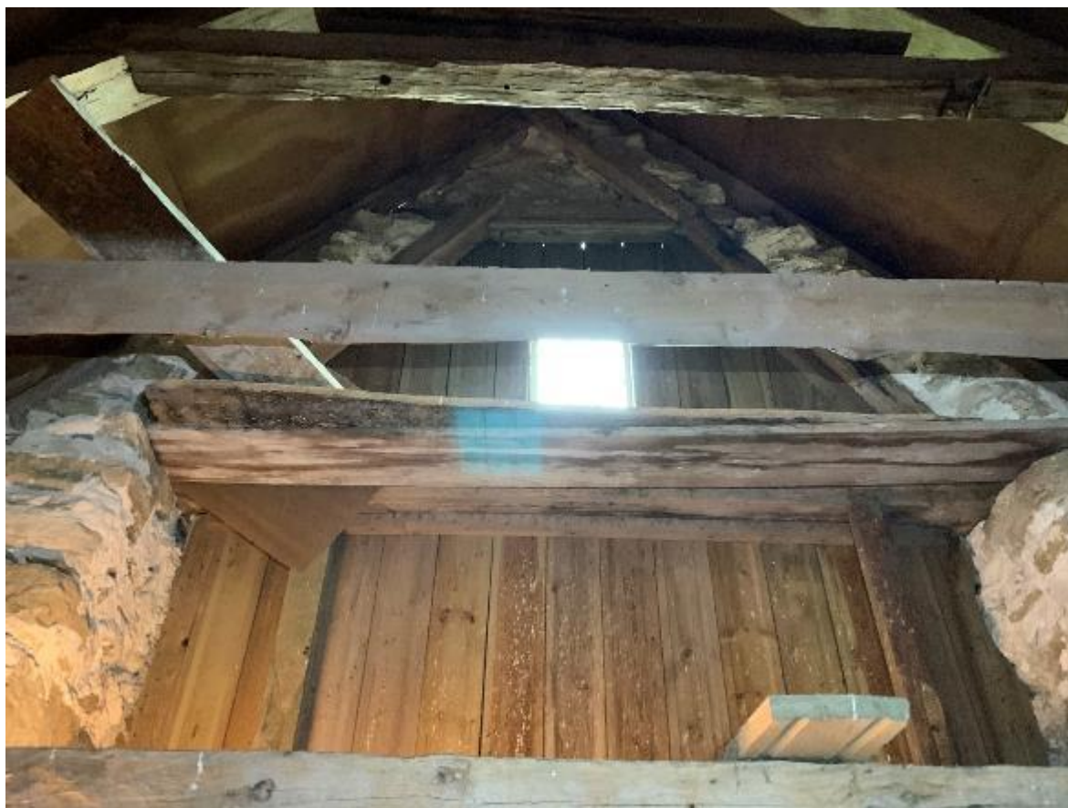
Triumfbågmurens gavelröste, sett från långhusvinden mot öster. Träpanelen putsad utvändigt. Foto JL 2020.
