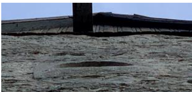
Nordportalen. Foto Einar Erici 1916, ATA, RAÄ Kulturmiljöbild. T.h. rundfönster i västra gavelröset, nedtill sett underifrån. Den välhuggna omfattningen har möjligen en svagt rundad framsida, vilket i så fall talar för att det suttit i en absid och vid dess rivning flyttats hit. Övriga absidstenar har inte påträffats i murarna, men utgrävningen 1956–58 berörde inte platsen för absiden. Foto JL 2020.
