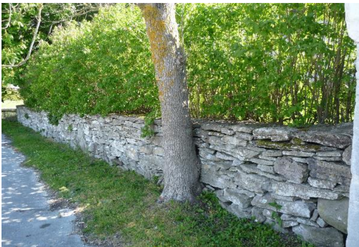
Den nordvästra mursträckningen med en syrenplantering innanför muren. Foto ES 2020.
