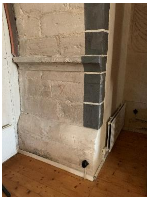
Tornbågens södra och norra båganfang. Observera sockelstenen på bilden till höger. En motsvarande sockel skymms under bänken på södra sidan. Foto JL 2020.
