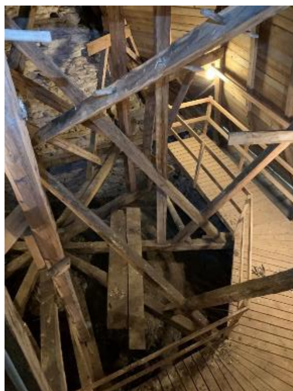
Tornvinden mot sydväst och nordväst. Det stjärnformade bjälklaget under huvens (takryttarens) konstruktion synligt. Foto JL 2020.
