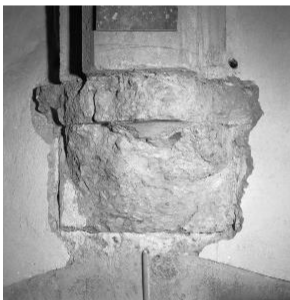
Långhusets västra och östra valvkonsoler med tydliga brandskador, frilagda från puts under restaureringen 1956–58. Foto Gunnar Svahnström 1957-58, ATA, RAÄ Kulturmiljöbild.
