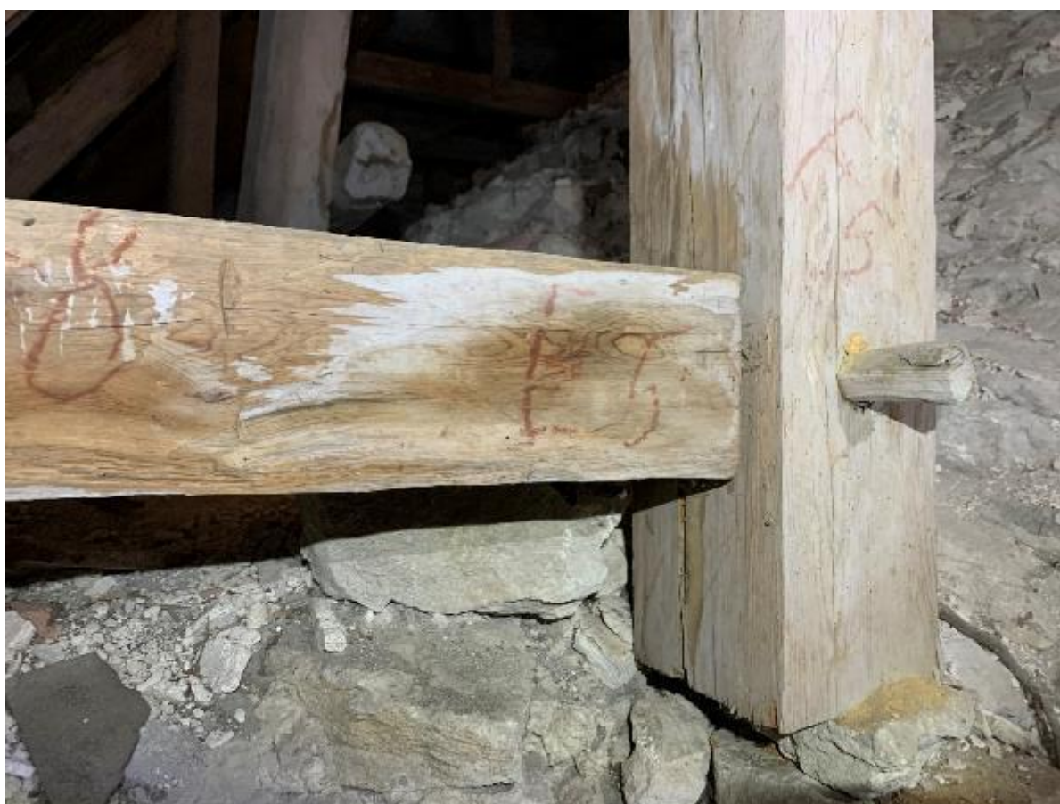
Sammanfogningsmärken på takstolen på korvindens norra del, sett mot öster. Foto JL 2020.
