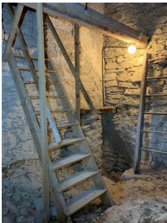
Trappa från sakristians vind till korvinden, t.v. trätrappa och tidigare stege, sedda mot nordväst, t.h. murtrappa med brandskadade stege, sedd mot norr. Foto ES 2020.
