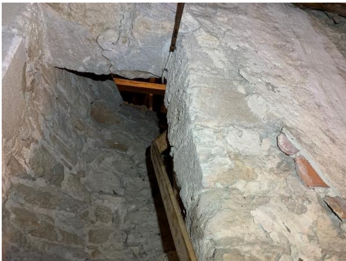
Sakristievinden mot söder med murtrappa till koret samt delar av tegelpannor från sakristians tidigare takfall och kvarsittande delar av korets äldre murputs. Foto JL 2020.
