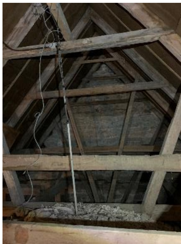
Korvinden mot väster och öster. T.v. öppningen mot långhusvinden. Triumfbågsmuren upp till öppningens nederkant äldre med brandskadat, sannolikt medeltida murverk. Den tunna gavelmuren däröver med brett utstruket fogbruk yngre, kanske från 1700-talets takomläggningar. T.h. östgavelns insida. En av hanbjälkarna har årtalet 1752 med rödkrita. Foto JL 2020.
