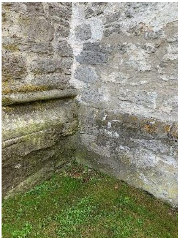
Sakristians sockel vid mötet med korets högre sockel med vulst, sett från nordöst och norr. Sakristians sockel troligen överflyttad från den äldre kyrkan, samt delvis brandskadad. Foto JL 2020.
