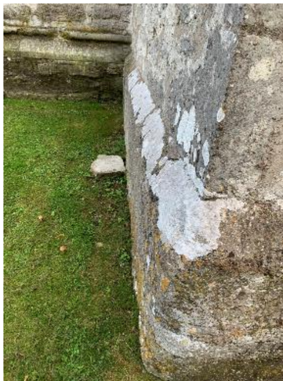
Sakristians sockel vid mötet med korets högre sockel med vulst, sett från nordöst och norr. Sakristians sockel troligen överflyttad från den äldre kyrkan, samt delvis brandskadad. Foto JL 2020.
