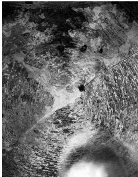
Valvet över ”ödekyrkan” sett underifrån. Öster nedåt. T.h. före restaureringen 1956-58 med flera äldre hål för klocklinor, vilket visar att kyrkan haft takryttare här, sannolikt även på medeltiden av antalet hål att döma, eftersom kyrkorna sedan 1500-talets klockkonfiskationer sällan hade flera klockor. Foto JL 2020 resp. Johnny Roosval 1915, ATA, RAÄ Kulturmiljöbild.
