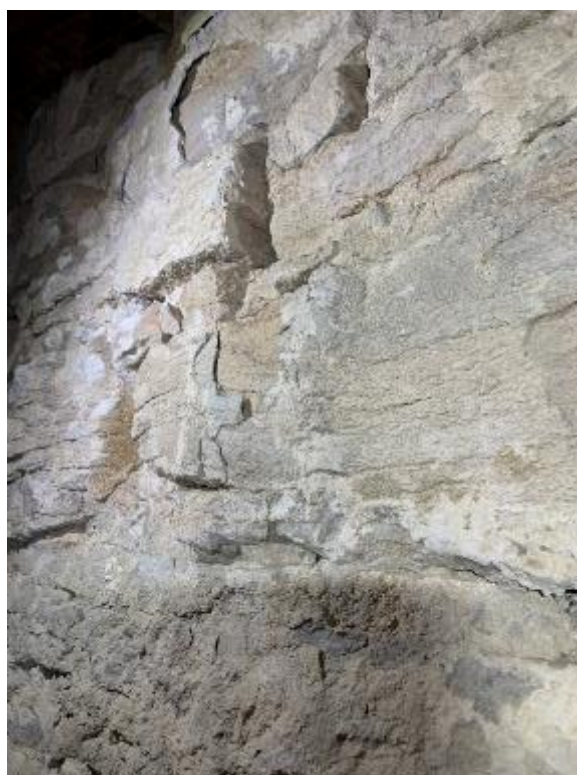
Korvinden sedd mot nordväst med trappans mynning. T.h. brandskador på triumfbågmurens nedre del i korets nordvästra hörn. Foto JL 2020.
