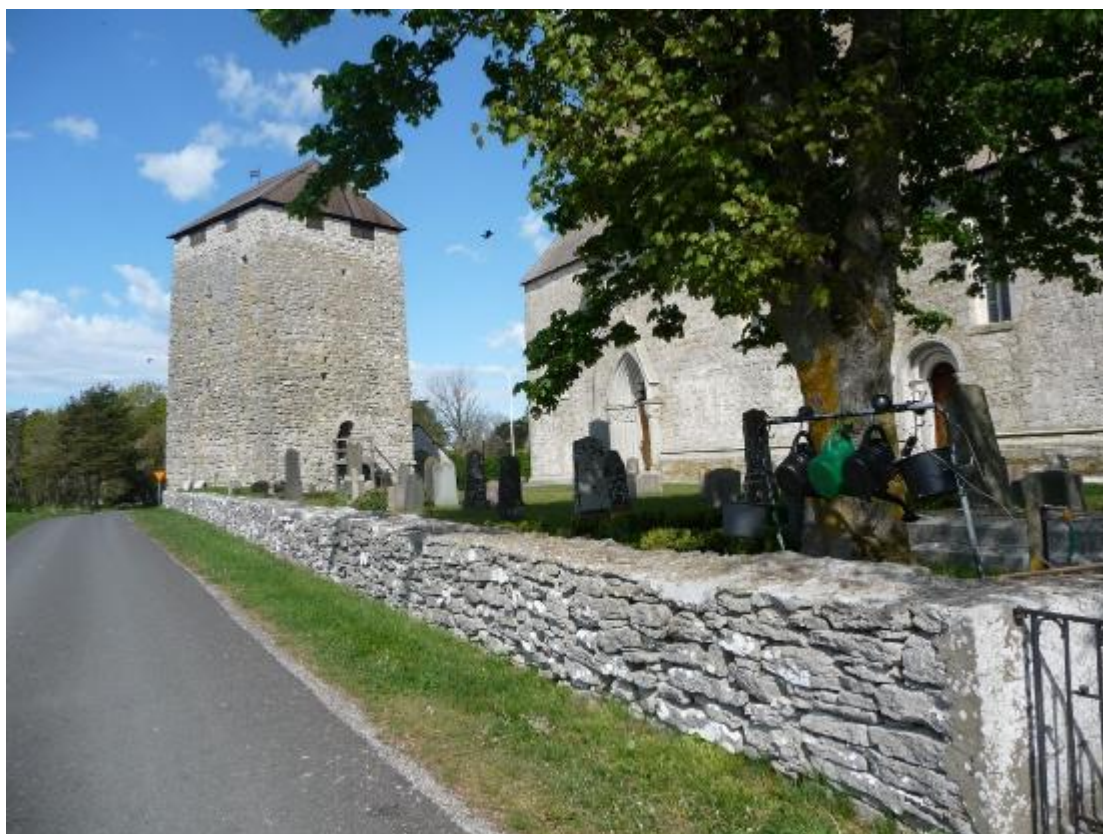
Muren som helhet anlades 1802. Här syns den södra mursträckningen. Foto ES 2020.
