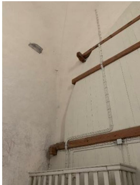
Ringkammaren uppåt mot nordöst och sydöst med brädväggens förankring samt konsoler efter tidigare valv. Foto JL 2020.
