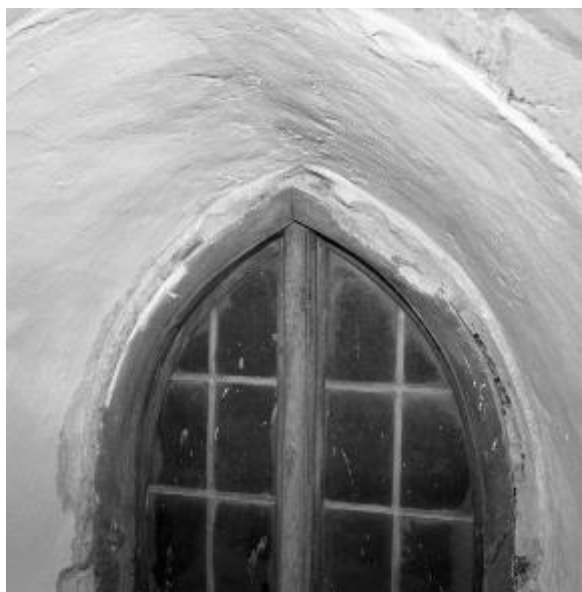
Det norra och mellersta av korets tre östfönster före restaureringen 1956–58, då masverken i korets fönster rekonstruerades utifrån spår i omfattningen och bevarade stenfragment. Foto Gunnar Svahnström 1957–58, ATA, RAÄ Kulturmiljöbild.
