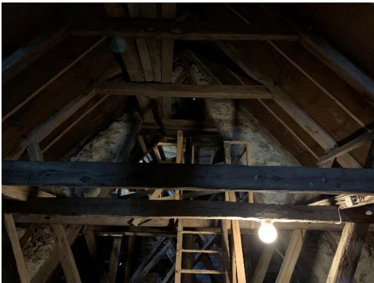
Långhusvinden mot väster. Foto JL 2020.
