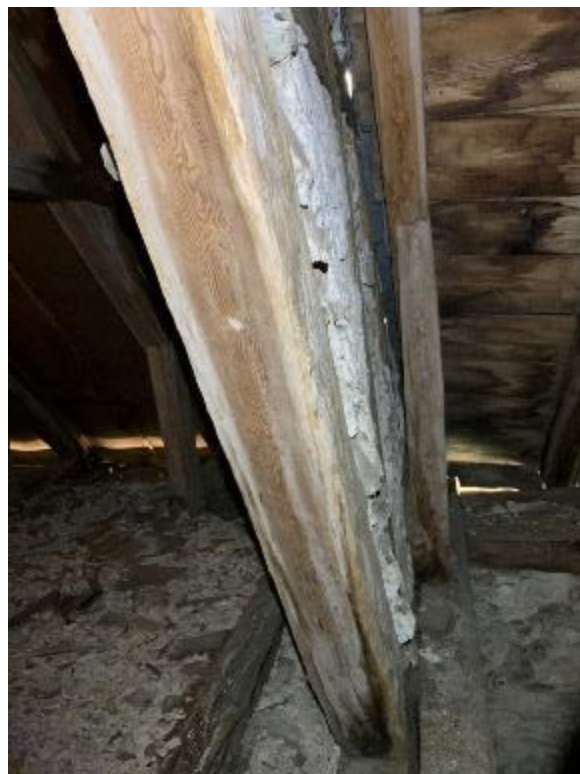
Röset av korsvirke över det gotiska långhusets västgavel, dess norra och södra nedre del, sett mot nordöst och sydöst. Korsvirkesgaveln har en betydligt slätare och putsad yta mot väster. Avtryck av ett tidigare, lägre placerat yttertak över det romanska långhuset visar att korsvirkesröset, som sannolikt byggdes vid takombyggnaden 1700, var fasadyta före takhöjningen över västpartiet. Foto JL 2020.
