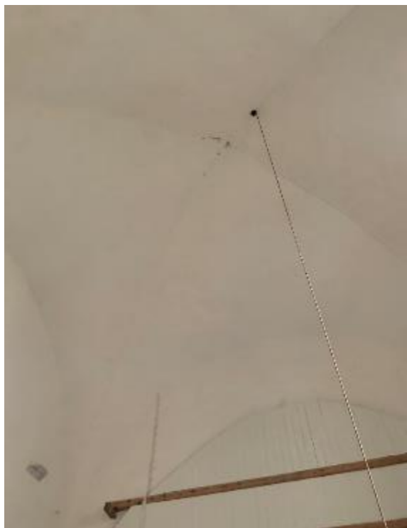
Valvet över ”ödekyrkan” sett underifrån. Öster nedåt. T.h. före restaureringen 1956-58 med flera äldre hål för klocklinor, vilket visar att kyrkan haft takryttare här, sannolikt även på medeltiden av antalet hål att döma, eftersom kyrkorna sedan 1500-talets klockkonfiskationer sällan hade flera klockor. Foto JL 2020 resp. Johnny Roosval 1915, ATA, RAÄ Kulturmiljöbild.
