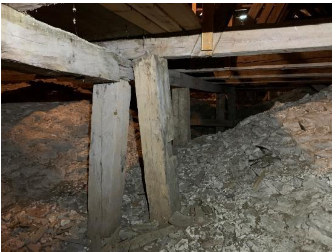
Långhusvinden och valvens ovansida mot öster. Foto JL 2020.
