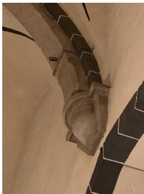
Långhusets västra valvkonsol, liksom den östra (se föregående bild) formad i betong vid restaureringen 1956–58 som ersättning för de brandskadade ursprungliga. Foto JL 2020. Den lilla öglan av järn har troligen fäst en trissa för locket till dopfunten som alltså varit placerad här nedanför tidigare.
