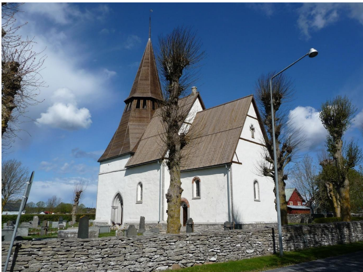
Kyrkogården omges av kallmurad kalksten i söder, öster och norr. Den östra muren. Foto ES 2020.
