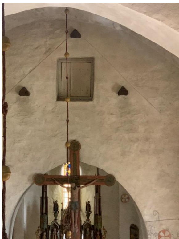
Trästycken i muren ovanför triumfbågen samt avtryck av takfall, sannolikt från tidigare träkyrka. I bilden till höger syns även en vertikal linje norr om triumfbågen efter en yttervägg. Luckan ovanför triumfbågen utgjorde kommunikationsväg mellan den tidigare träkyrkans vind och det nuvarande murade korets vind innan det nuvarande långhuset byggdes. Foto JL 2020 resp. 2019.
