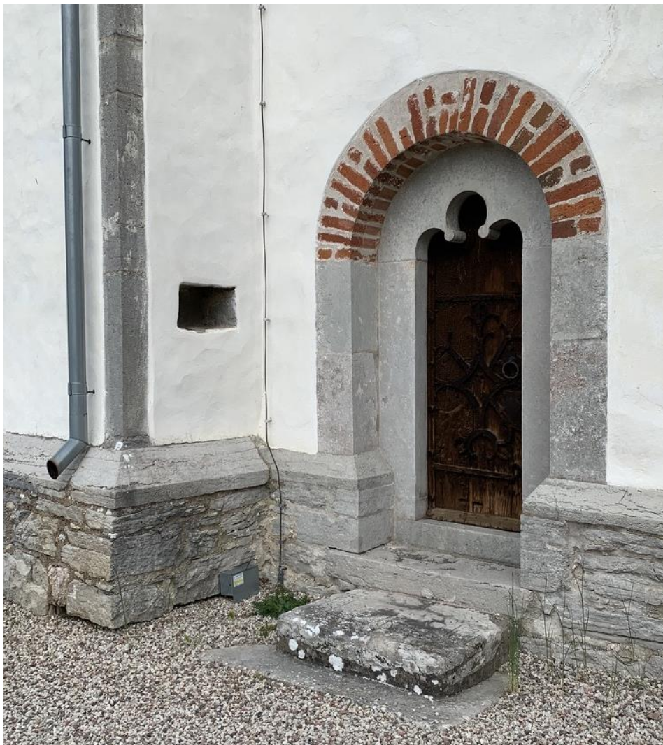
Södra vinkeln mellan långhuset och koret med korportal, socklar på långhus och kor samt nisch i långhusets östra mur. Foto JL 2020.
