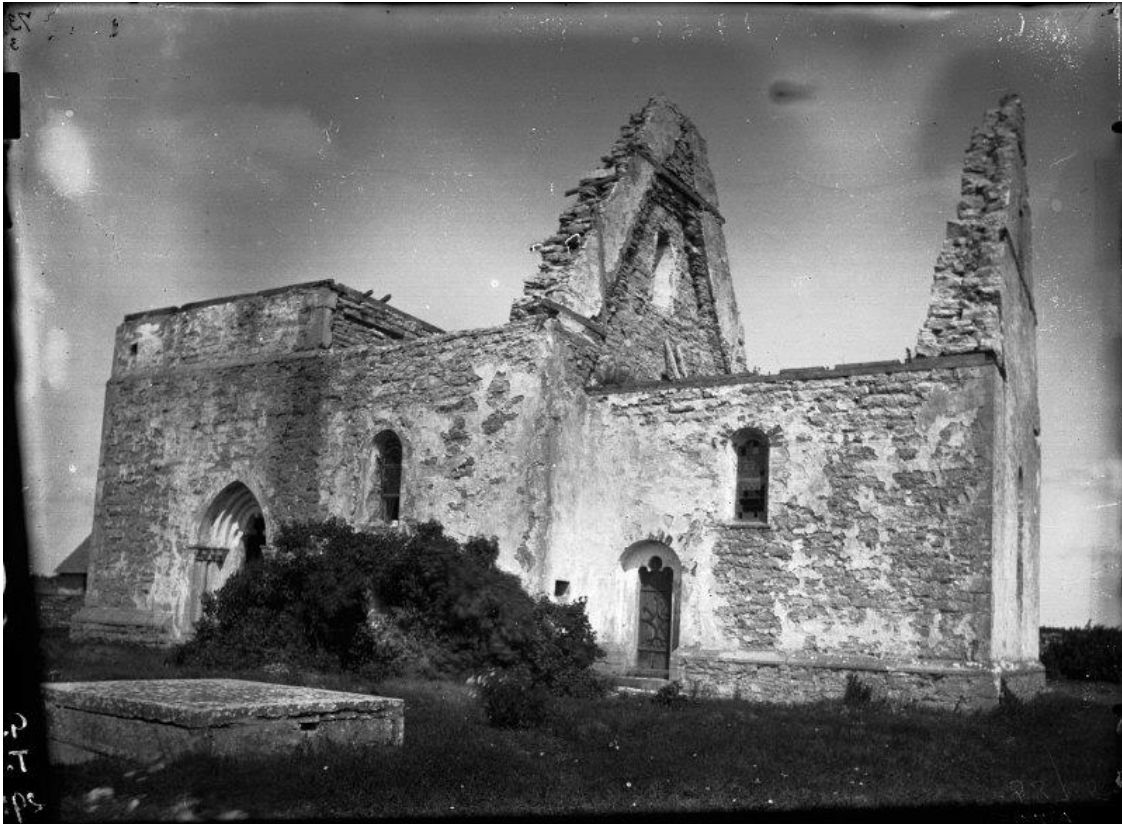
Exteriör från söder under ödekyrkotiden, sannolikt kort tid efter att taken avlägsnats. Foto Olof Sörling, troligen 1891. RAÄ, Kulturmiljöbild.
