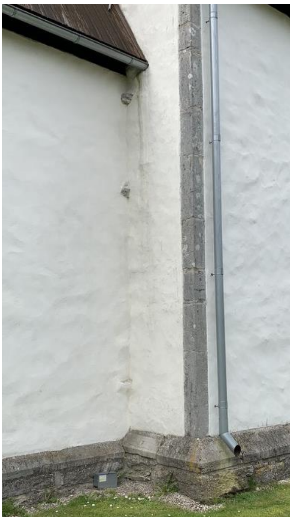
Norra vinkeln mellan kor och långhus, med socklar på olika höjd och förtagningsstenar på korets norra sida. Till höger långhusets södra fönster. Foto JL 2020.
