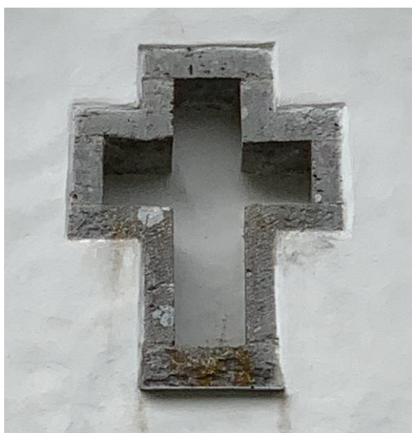
Korsformig tidigare ljuslugg i korets östra gavelröste, igenmurad under 1900-talet och ändrad till blinding. Foto JL 2020.
