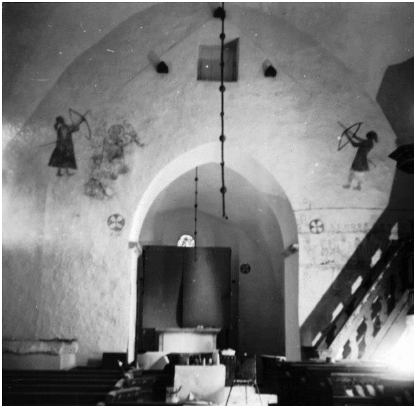
Interiör mot öster, troligen under restaurering 1951 med nykonserverade målningar. Triumfbågsmuren satt i släpljus som framhäver konturerna av träkyrkans väggar och tak. Foto i RAÄ, Kulturmiljöbild.
