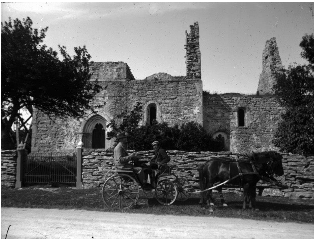
Vid den södra ingången till kyrkogården finns en järngrinnd och stolpar i trä. Muren är i gott skick. Foto Oscar Almgren troligen omkring 1900. RAÄ, Kulturmiljöbild.
