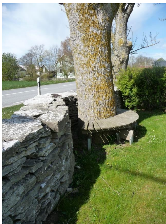
Den södra mursträckningen har buktats ut för att bevara en äldre ask. Foto ES 2020.
