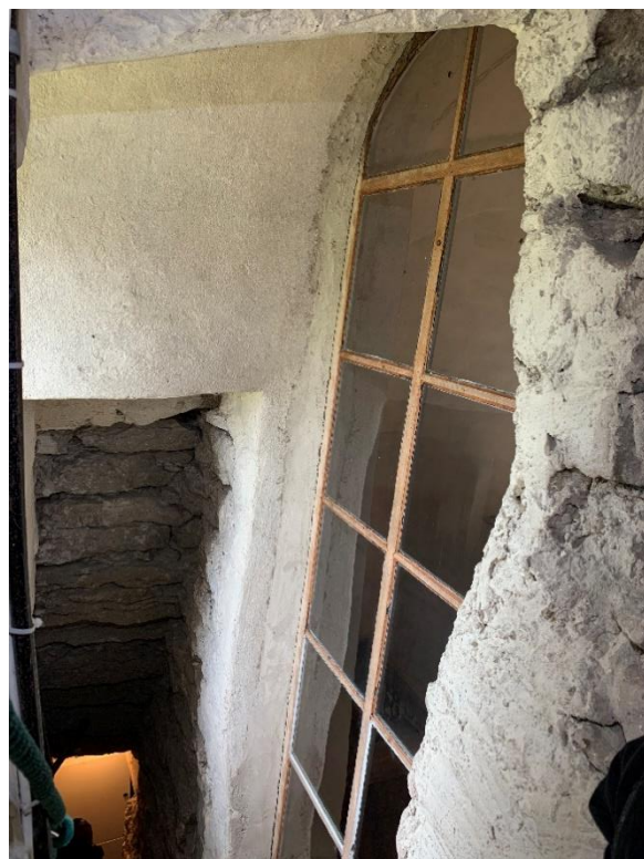
Trappa i tornets västra mur, där denna passerar fönstersmygen, sedd mot norr. Glasfönstret till höger, som leder in mot kyrkorummet, har tidigare sagnats och öppningen varit fri. Kanske har den varit utgång till en mindre läktare eftersom bröstning saknas. Foto JL 2020.
