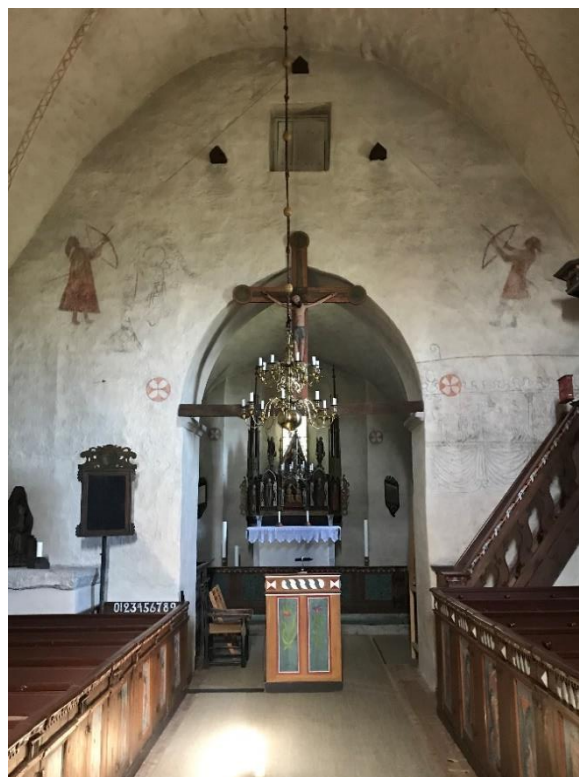
Trästycken i muren ovanför triumfbågen samt avtryck av takfall, sannolikt från tidigare träkyrka. I bilden till höger syns även en vertikal linje norr om triumfbågen efter en yttervägg. Luckan ovanför triumfbågen utgjorde kommunikationsväg mellan den tidigare träkyrkans vind och det nuvarande murade korets vind innan det nuvarande långhuset byggdes. Foto JL 2020 resp. 2019.
