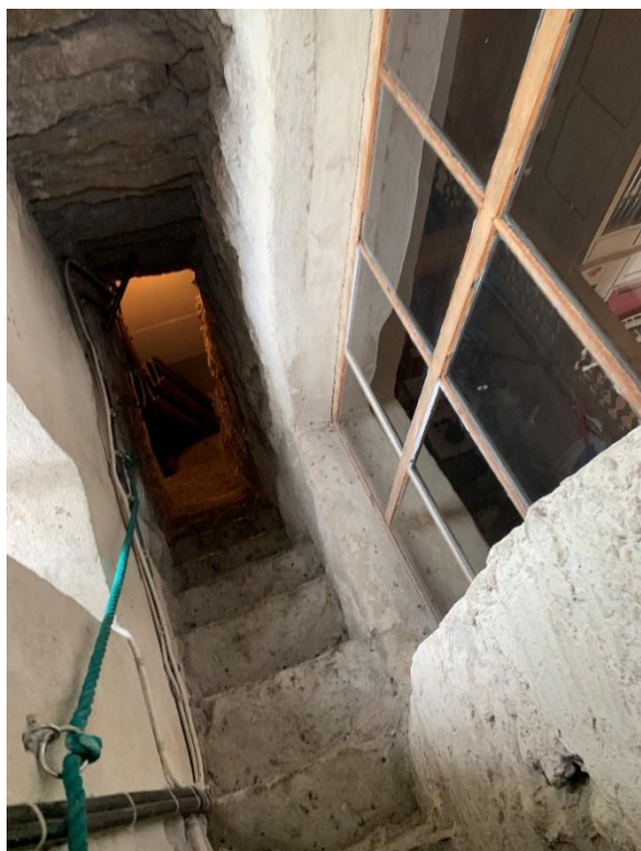
Trappa i tornets västra mur, där denna passerar fönstersmygen, sedd mot norr. Glasfönstret till höger, som leder in mot kyrkorummet, har tidigare sagnats och öppningen varit fri. Kanske har den varit utgång till en mindre läktare eftersom bröstning saknas. Foto JL 2020.
