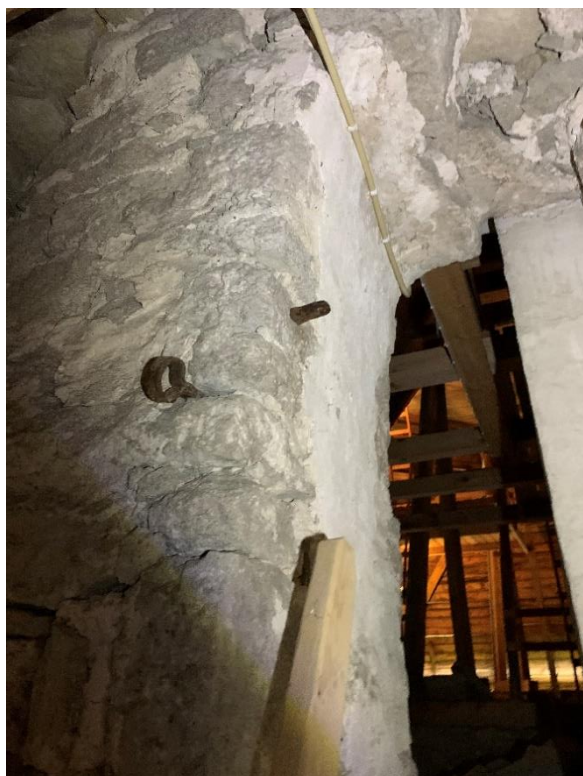
Öppningen i triumfbågmuren med beslag från en tidigare dörr. Att öppningens insidor är putsade talar för att dörren fanns innan långhuset byggdes. Till höger samma mur, visande platsen under stegen för gluggen ner till kyrkorummet. Foto JL 2020.
