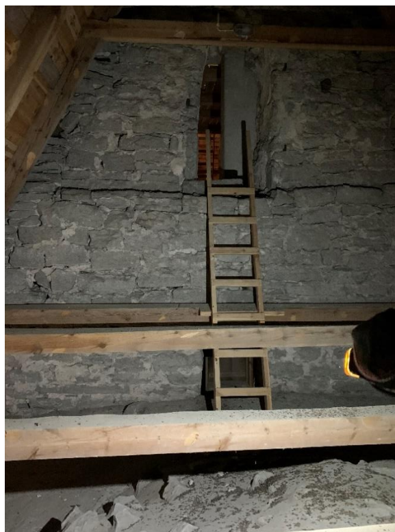
Öppningen i triumfbågmuren med beslag från en tidigare dörr. Att öppningens insidor är putsade talar för att dörren fanns innan långhuset byggdes. Till höger samma mur, visande platsen under stegen för gluggen ner till kyrkorummet. Foto JL 2020.
