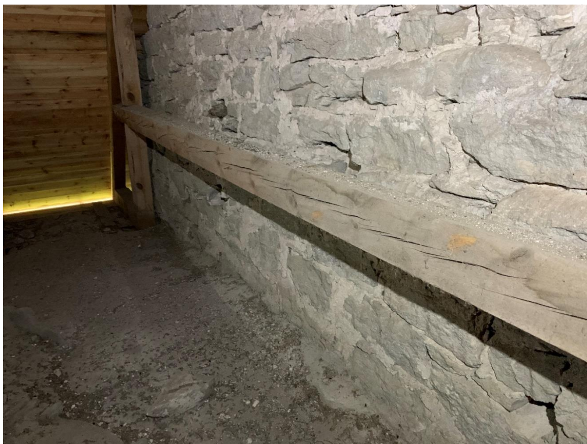
Korets östmur sedd från vinden. Mittlinjen, platsen för korfönstret, ligger ungefär mitt i bilden. Den grunda absiden fortsätter inte ovanför valvet. Muren är dock tunnare ovanför valvet än nedanför. Foto JL 2020.
