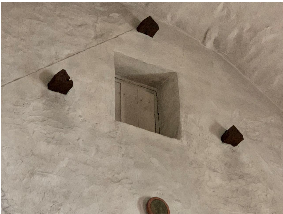
Trästycken ovanför triumfbågen, sannolikt takåsar från en tidigare träkyrka. Foto JL 2020.
