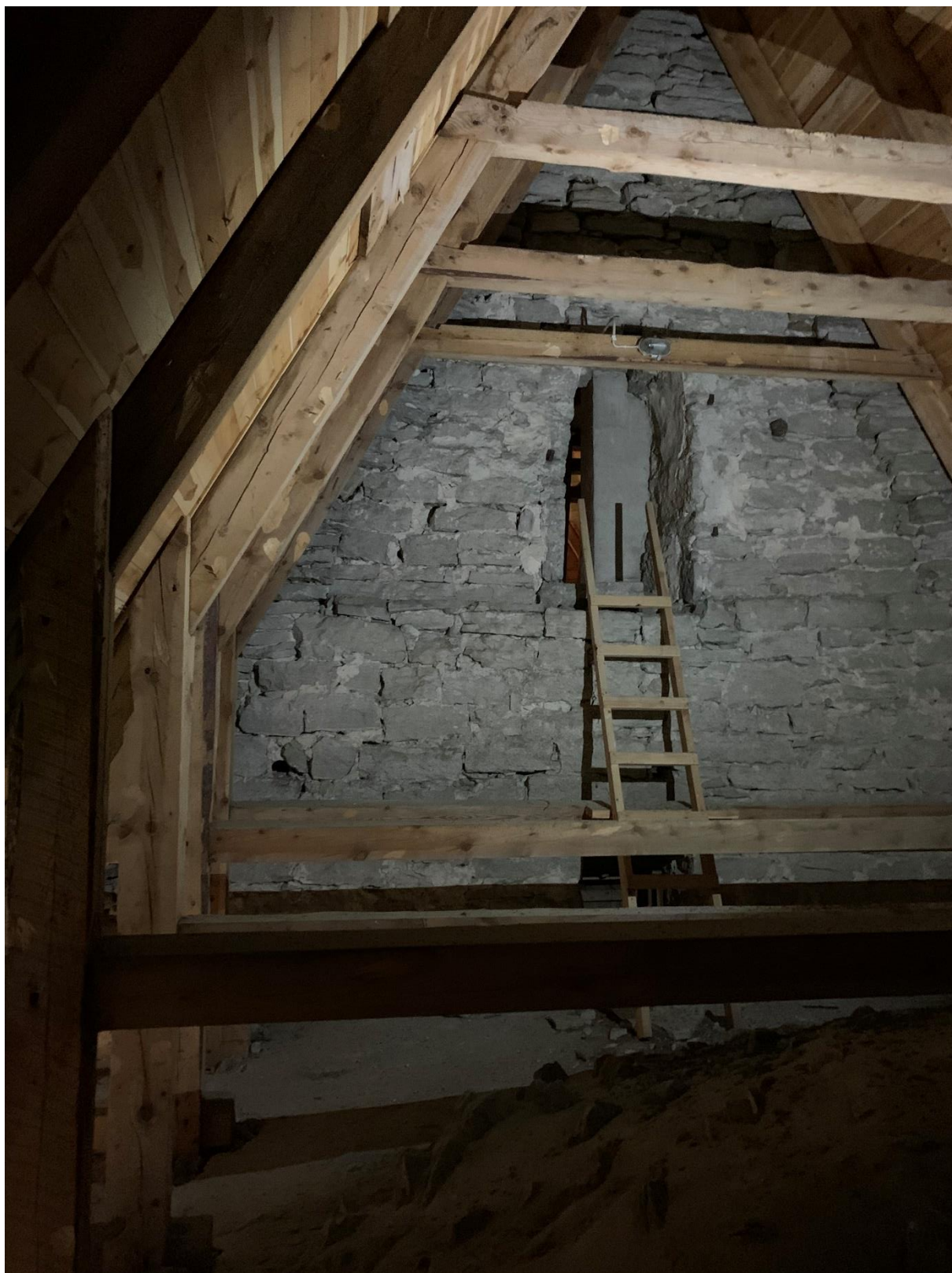
Korvinden sedd mot väster. Öppningen delvis täckt av skorstensstocken från ca 1920. Hållare för gångjärn och låstapp visar att öppningen har kunnat tillslutas med dörr. De utkragande stenarna strax innanför yttertaket visar att det tidigare legat något lägre. Foto JL 2020.
