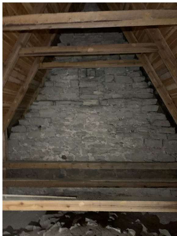
Till vänster öppningen ovanför triumfbågen, sannolikt ursprunglig ingång till korvinden innan det murade långhuset var byggt. Till höger korets östra gavel med den korsformiga gluggens igenmurning. Foto JL 2020.
