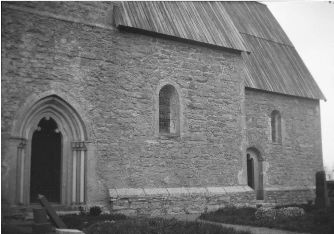
Den södra sidan av kyrkogården. Närmast kyrkan finns några högresta gravvårdar. Foto Berit Wallenberg 1928. RAÄ, Kulturmiljöbild.
