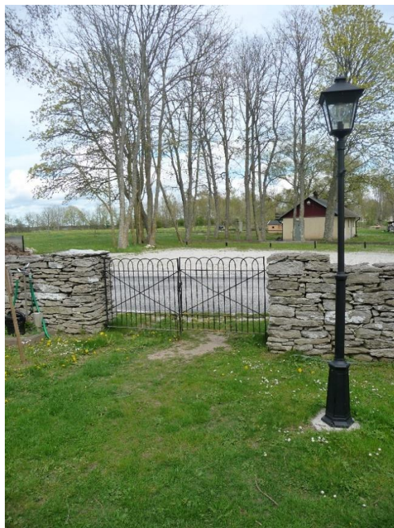
Den östra ingången med en järngrind och stolpar i kallmurad kalksten. Foto ES 2020.
