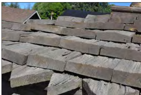
Dala-Floda kyrka. Grindstolpar avtäckta med spån.
