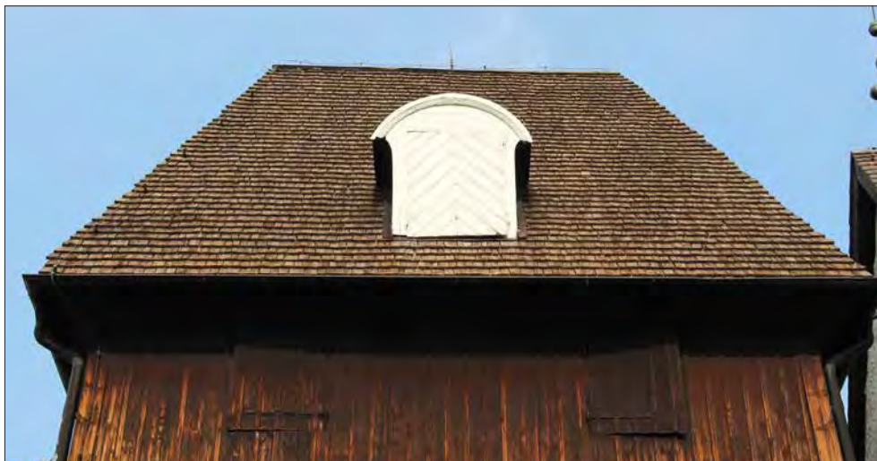
Säby klockstapel. Sågade eksån på klockstapelns södra takfall, de kan vara lagda 1947.
