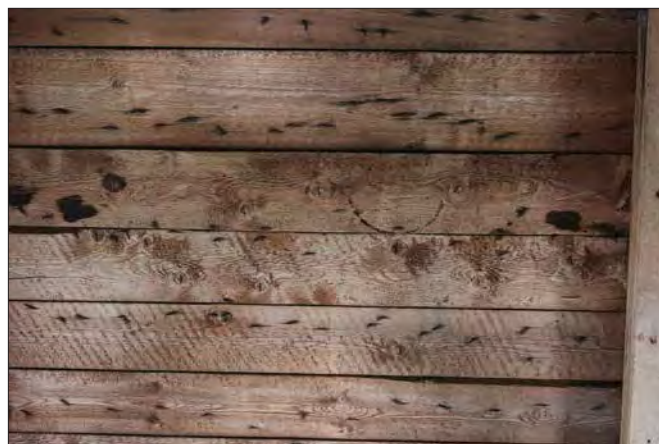
Undertak i klockhuv, två generationer spånpik. Foto: Lisa Skanser.
