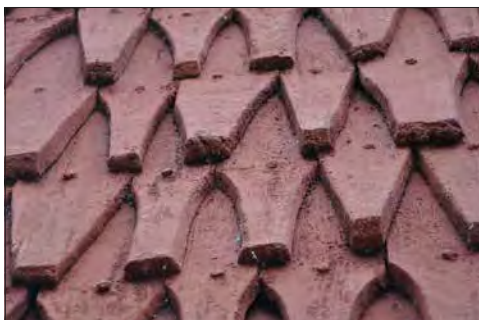
Sundborns klockstapel. Handbearbetade spån på klockstapeln (med ritsar).
