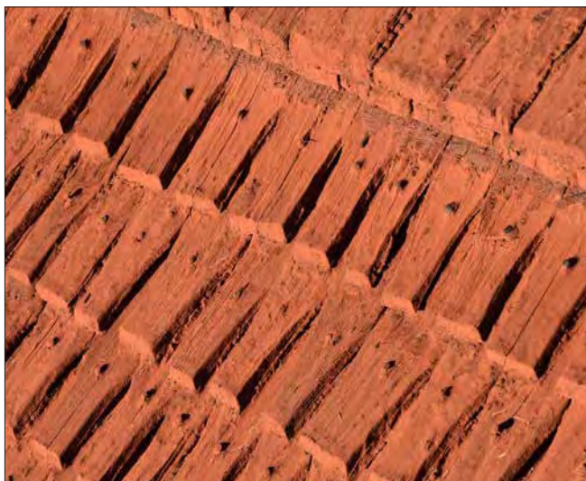
Leksands kyrka. Spån på lökekupolen, sentida khyrda på ovan delen och huggna 1700-talsspån på nedre delen.
