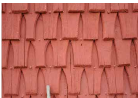
Sundborns kyrka. Spån med buggna bleken på östra korsarmens södra sida tillsammans med enstaka senare, sågade, kompletteringar.
