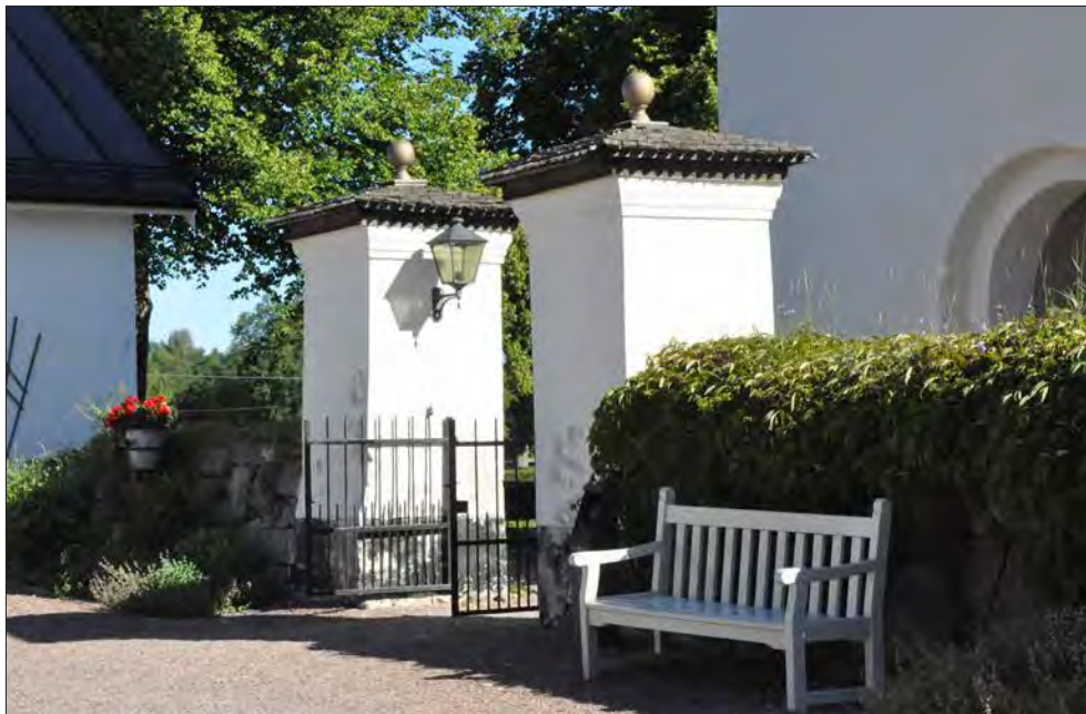
Dala-Floda kyrka. Grindstolpar avtäckta med spån.
