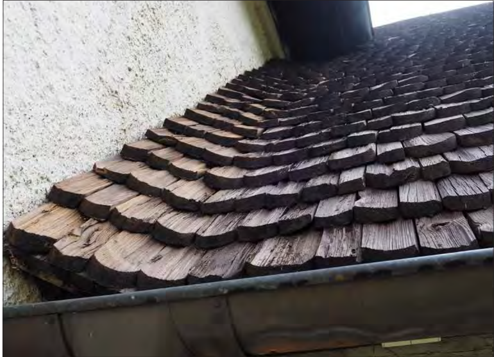
Kärrbo kyrka. Vapenhusets västra takfall.
