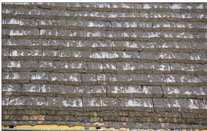
Möklinta kyrka. Detalj av spån ner mot takfoten på vapenbusets östra takfall.
