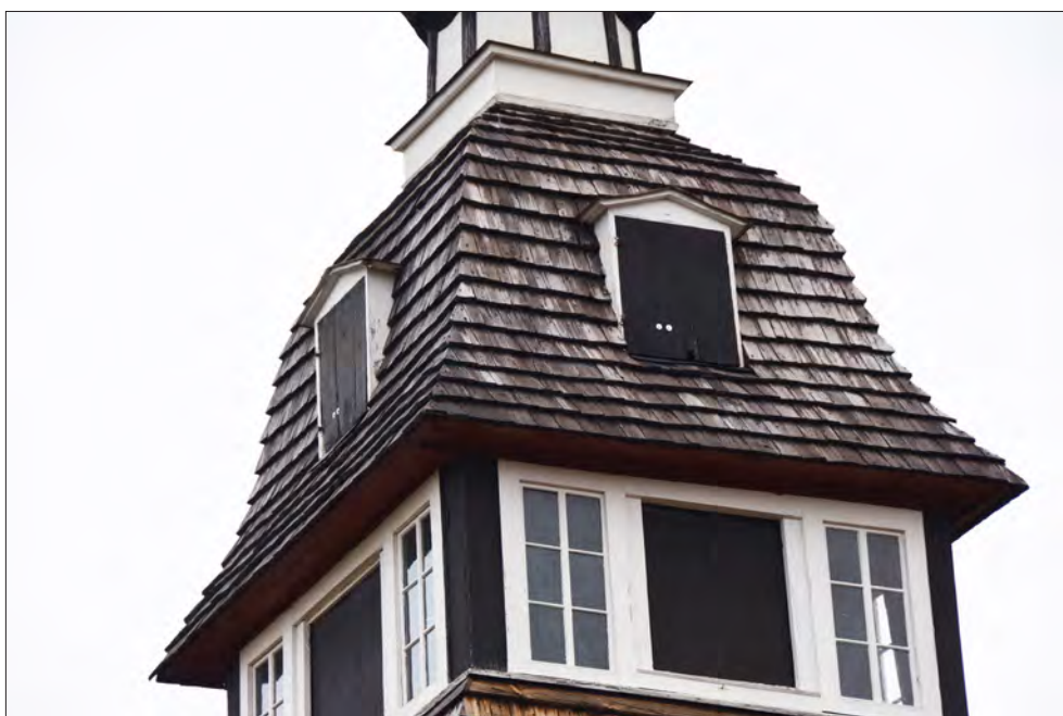
Bingsjö kapell. Tornet med klyvda spån på huven. Dessa spån har silvriga utfällningar i tjäran.
