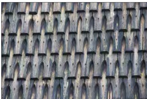
Svedvi klockstapel, sågade spån på östra fasaden.
