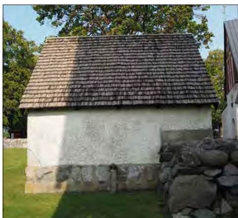
Hubbo kyrka. Bårhusets södra fasad.
