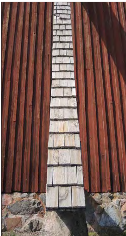
Aspeboda klockstapel. Sågade spån på den norra strävan.
