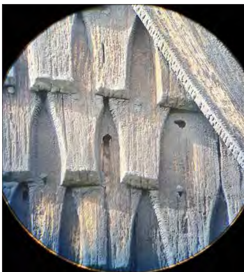
Kung Karls klockstapel. Kikarbild på östra fasadens spån. Hål från tidigare infästning är synliga.
