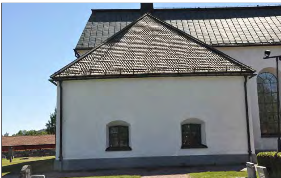
Gagnefs kyrka. Sakristian med rombmönstrad spåntäckning
