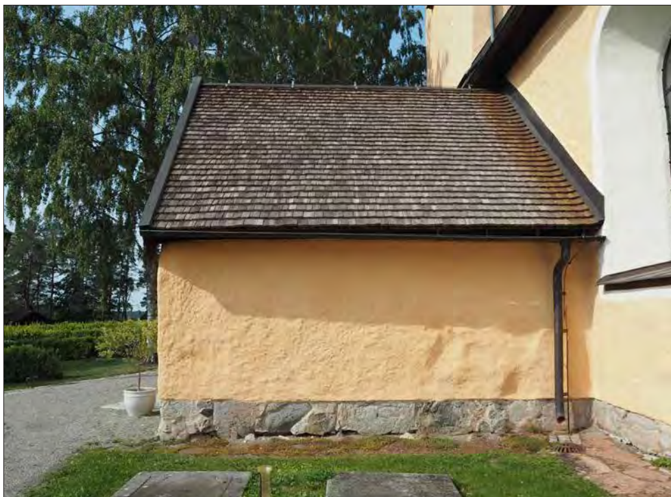
Kumla kyrka. Vapenhusets östra takfall.
