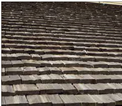
Kumla kyrka. Detalj av vapenhusets östra takfall.
