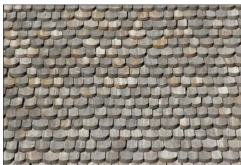
Kungs-Barkarö kyrka. Långhusets norra takfall med spån från 1990.
