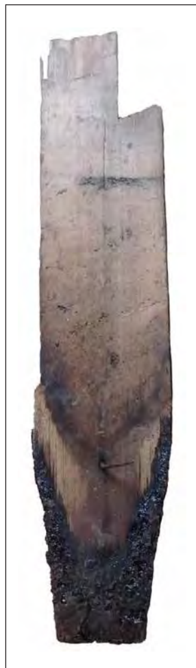
Figur 53. Baksidan/undersidan av ett demonterat spån. Verktögs-spåren visar att sidan är huggen i sin helhet. Foto Lars Jönsses.
