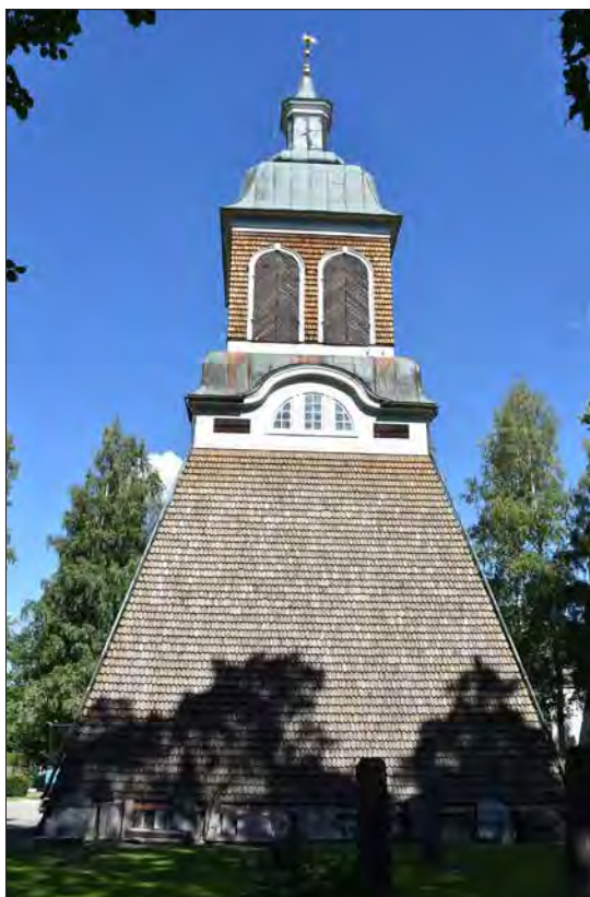
Ludvika Ulrika klockstapel. Detalj av klockstapelns spån som är rundade med fasadkant och i sin helhet sågade.
