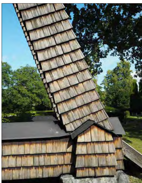
Hovdestalunds klockstapel. Del av klockstapelns syll och stränpelare.
