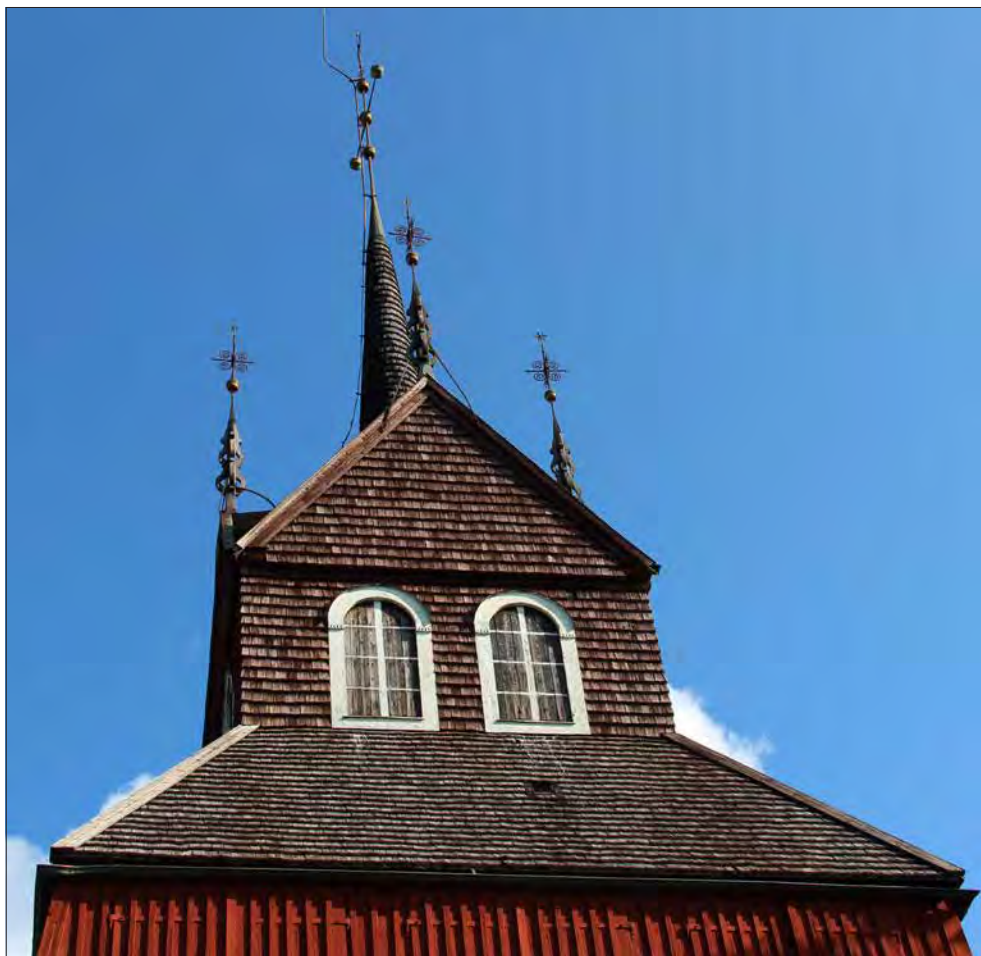
Möklinta klockstapel. Tak och fasad från väster.
