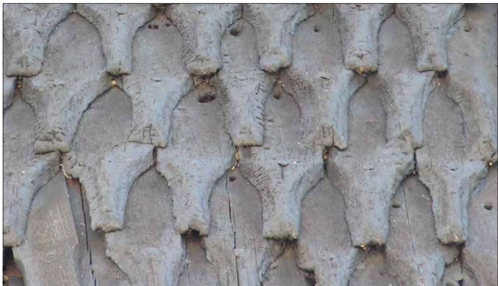
Figur 25. Spån på klockstapelns norra fasad vid Svedvi kyrka, Västerås stift. I höjd med ljudluckorna finns ett parti med spån som bedöms vara av mycket hög ålder. Spånens jämna bredder och symmetrin i läggningen påminner om spåntäckningen i Tångeråsa kyrka, Strängnäs stift, som förmodas vara från 1400-talet. På spånen syns hål från tidigare infästning ovanför befintlig infästning. Hålen är av större dimension än spikhål och i flera fall är de något förskjutna från spånets centrum vilket tillsammans talar för att spånen kan ha varit fästa med träplugg tidigare. Foto Lisa Skanser.
