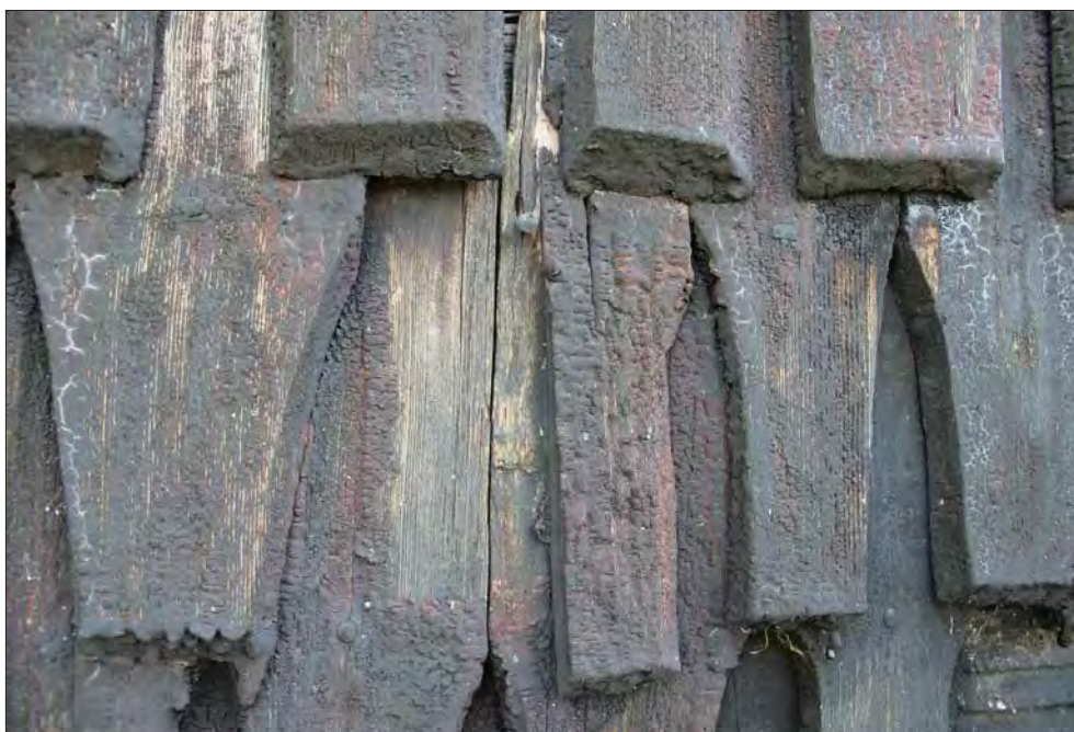
Figur 38. Av Sura gamla kyrka i Västerås stift återstår sakristian som numer utgör kapell och minnesplats. Stanspånerna på västra fasaden uppskattats vara från 1600-talet. Spår efter röda pigment finns i underliggande tjärskikt. Foto Lisa Skanser.
