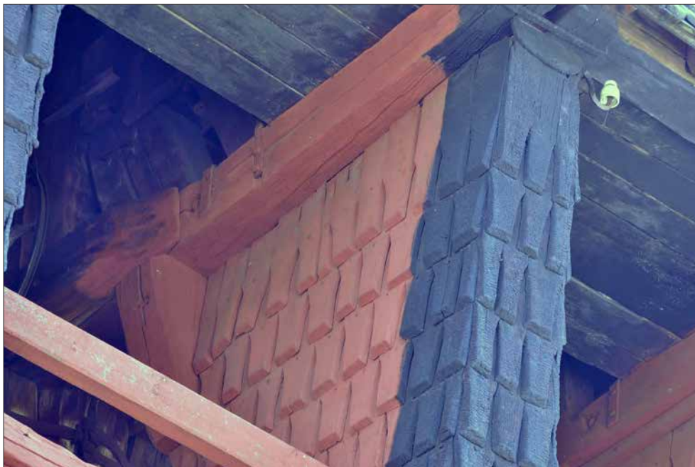
Ljusnarsbergs klockstapel. Spånklädda ljudöppningar i klockhuv.
