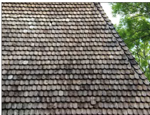
Torpa klockstapel. Södra fasadens spånläggning.
