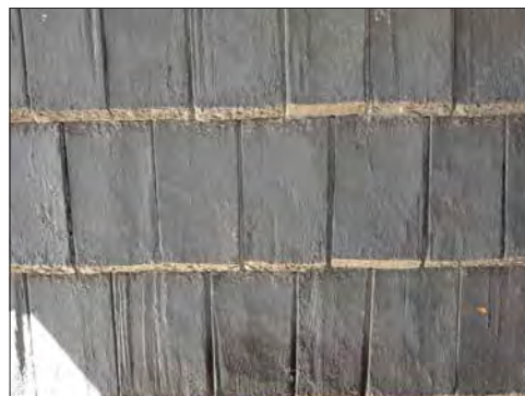
Hosjö kyrka. Detalj av spåntäckningen på den äldre inåtgående kyrkporten. Den är klädd med raka spån med fasad kant och buggen ovansida.
