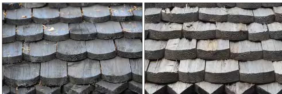
Figur 34 Sågade spån från 1900-talets senare hälft vid Särna kyrka, Västerås stift (t.v.) och kluvna spån från tidigt 2000-tal vid Härads kyrka, Strängnäs stift (t.h.) Foto Sanna Svensson och Karin Myrberg.
