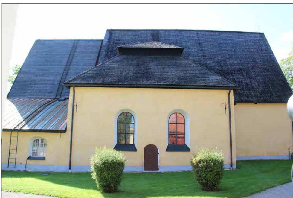
Sala sockenkyrka. Kyrkan sedd från norr. Sex olika spåntyper bedöms förekomma på olika takfall, fyra av dem har registrerats på korsarmens sex olika takfall. Långhusets och korsarmens spåntäckning uppvisar ojämnbeter och rötskador.
