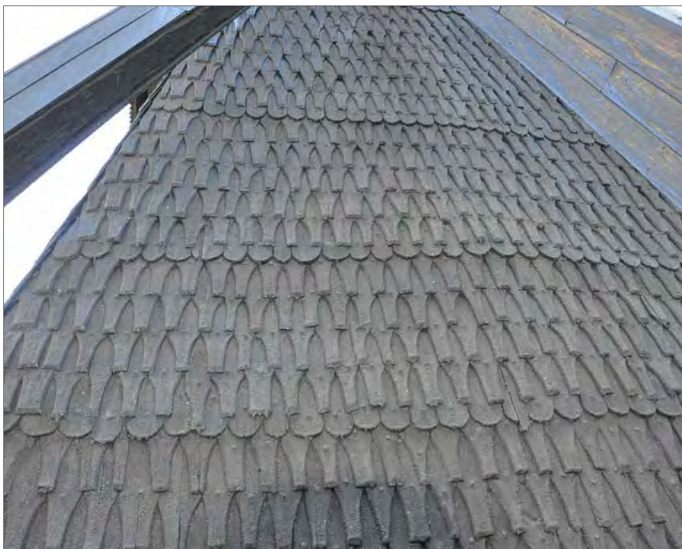
Torsångs klockstapel. Mönsterläggning på västra fasaden.
