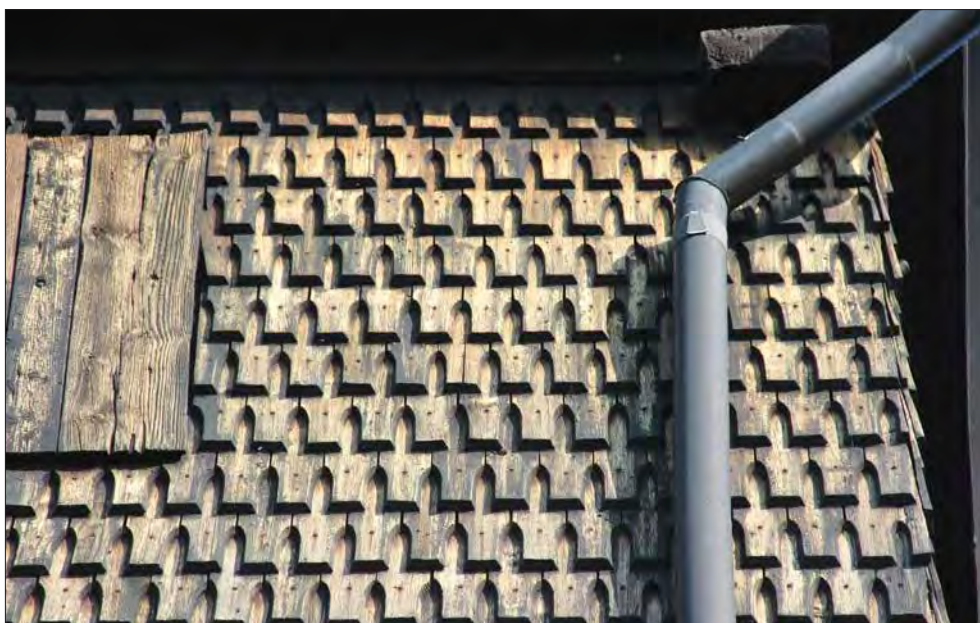
Svedvi klockstapel, sågade spån på södra fasaden.
