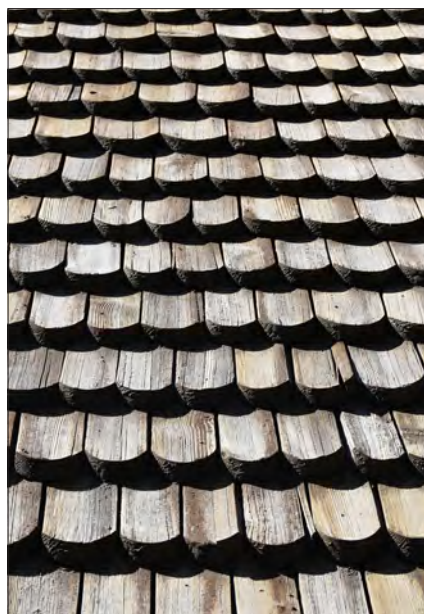
Ludvika Ulrika klockstapel. Detalj av klockstapelns spån som är rundade med fasadkant och i sin helhet sågade.
