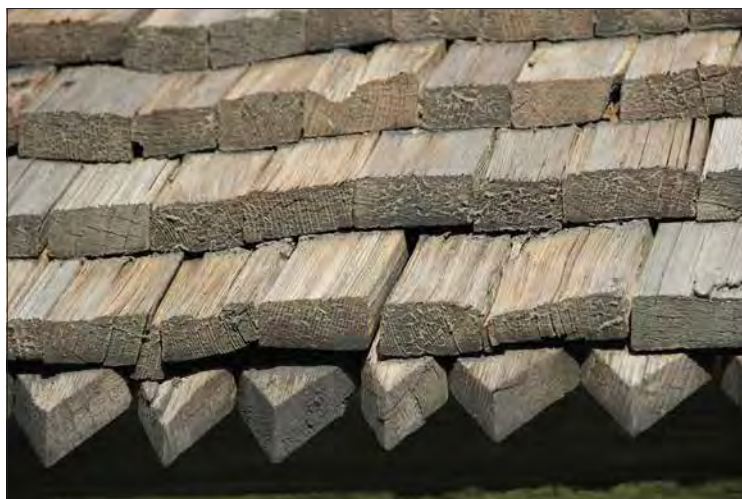
Bergs kyrka, bårhus. Närbild västra takfoten.
