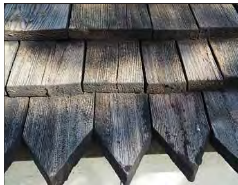
Rytterne bårhus, södra takfallet.
