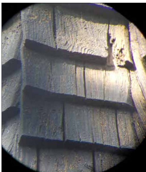
Kvarnsvedens klockstapel. De sågade spånen på tornspiran.
