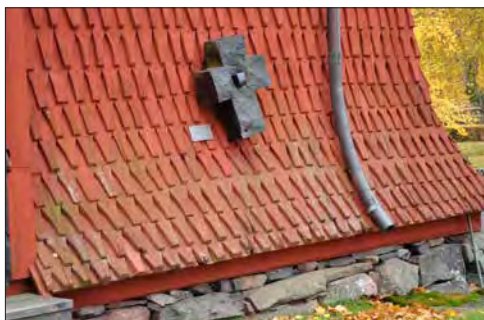
Sundborns klockstapel. Längst ner, på stapelns norra utkragning, förekommer tryckimpregnerade sågade spån, med stor sannolikhet från 1970-talets renovering. Högre upp skymtar äldre, handbearbetade spån.
