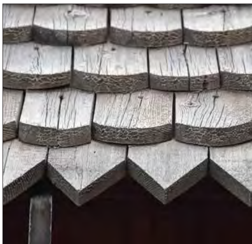
Evertsbergs kapell och klockstapel. Spånen på kapellet och stapelns takfall är genomgående rundformade med lika dimensioner.
