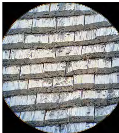
Möklinta kyrka. Kikarbild på långbusets södra takfall. Spånen är lokalt tillverkade 1931 av virke ur prästgårdsskogen.
