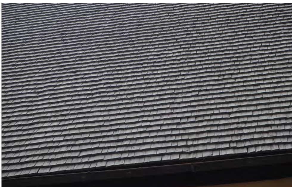
Kumla kyrka. Långhusets norra takfall.
