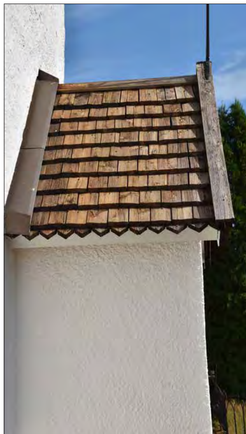
Äppelbo kyrka. Sågade spån på den södra korentrens takfall.
