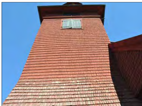
Hosjö kyrka. Tornet sett från söder. Fasadernas övre del har raka spån med hyvlad ovansida medan nedre delen har spån som är sågade runtom och som förmodligen är något yngre.
