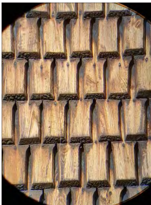
Kungs-Barkarö kyrka. Sågade spån på tornets södra fasad. Mycket liggande årsringar och kvist i bleket.
