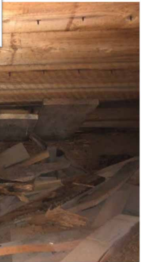
Rötskadad syll på stenfoten, sydöstra sidan. Undertaket har en tidigare lagning.
