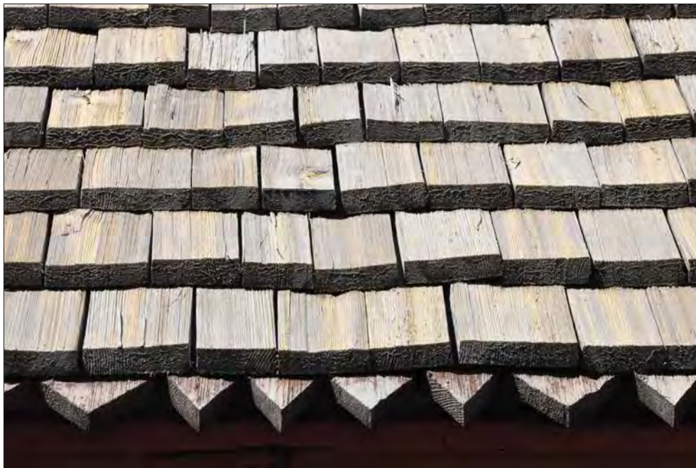
Amsbergs kapell. Klivna spån på vapenhuset
