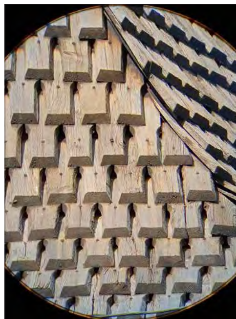
Kungs-Barkarö kyrka. Tornaket takfall åt söder och öster, mycket liggande årsringar.
