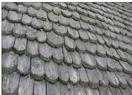
Odensvi kyrka. Trappuppgången är klädd med tjärade furuspån. Alla spån är individuella och skiljer sig åt i mått, form på rundning och tjocklek. Spånen är av hög ålder, eventuellt från 1770-talet eller är äldre än så.
