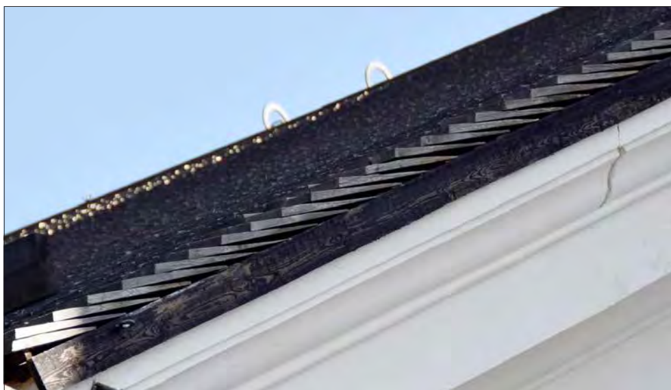
Siljansnäs kyrka. De klyvda spånen på norra långbustakefallet sedda från gaveln.
