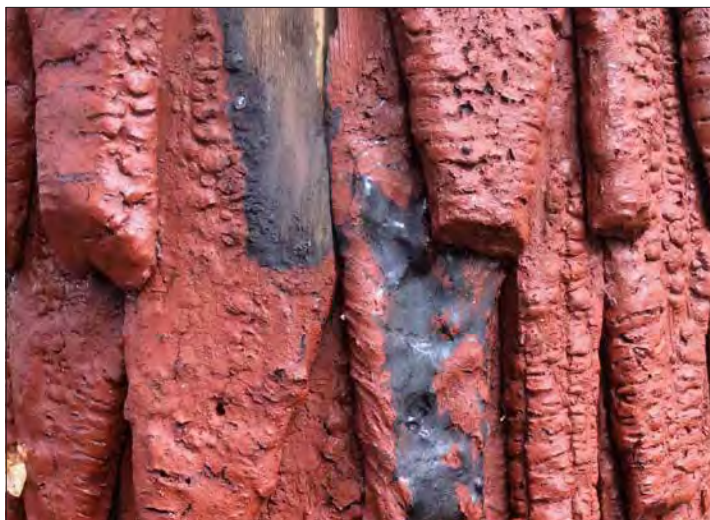
Figur 40. Husby-Oppunda klockstapel, Strängnäs stift. Hjærtstolparnas spån är täckta med tjocka skikt ytbehandling. Foto Karin Myhrberg.
