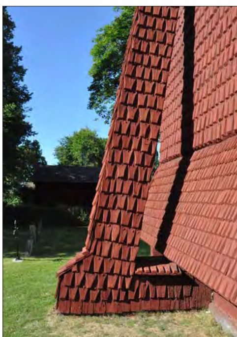
Djura klockstapel. Huggna och sågade spån förekommer över hela fasaden. På strävsans sydsida syns främst huggna spån, men även senare, sågade kompletteringar, finns.
