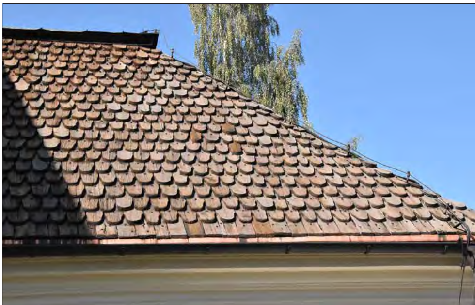
Orsa kyrka. På sakristian förekommer en spåntyp med ovanlig form. På det östra takfallet finns sentida lagningspån som anpassats i formen till de äldre bevarade spånen..
