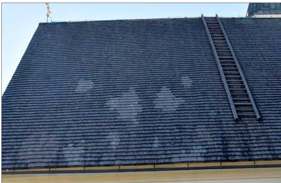
Rättviks kyrka. Klyvda spån förekommer över hela kyrktaket och avtecknar sig som ljusare partier. Här på södra korsarmen.
