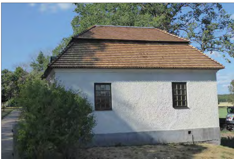
Götunda kyrka. Bårhusets tak har raka spån med en kant av spetsspån.
