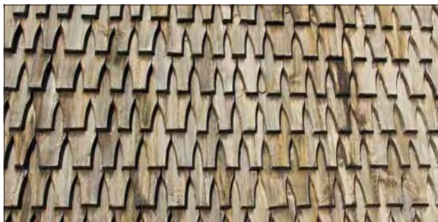
Malma kyrka. Spån på västra fasaden.
