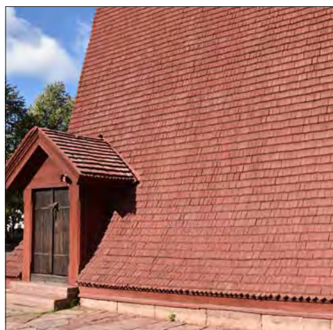
Mora klockstapel. Sydfasaden med spåntäckt entrétak.
