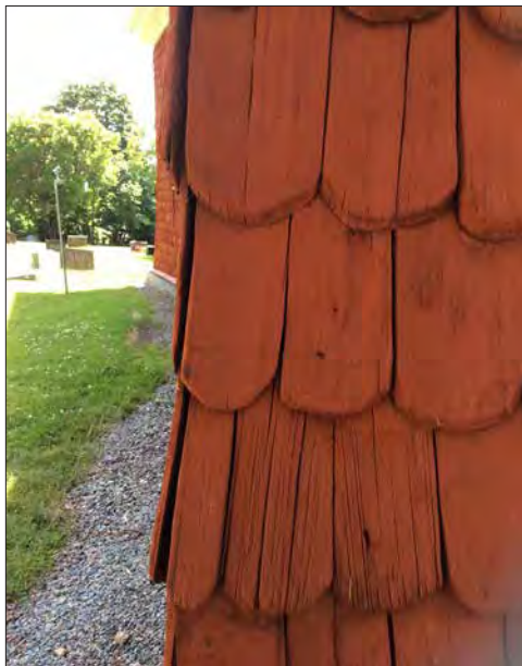
Hjulsjö kyrka. Fasaderna visar prov på stor variation i spånens mått.
