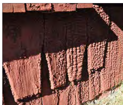
Djura klockstapel. Bild av huggna spån i mycket breda dimensioner. Troligen några av de äldsta kvarvarande spånen på Djura klockstapel. Aterfinns långt ner, mot mötande fasader.
