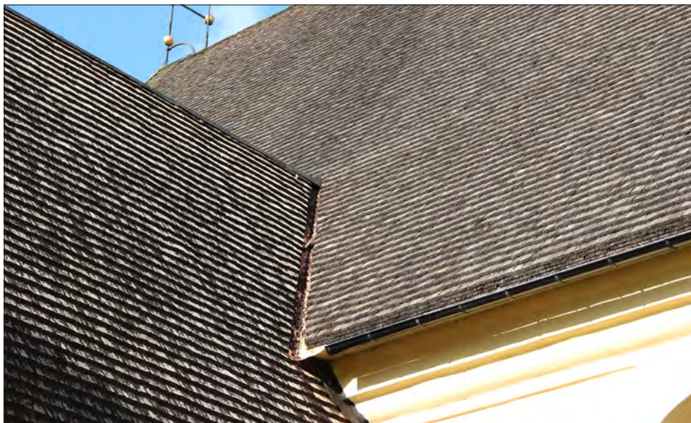
Möklinta kyrka. Rännal med kopparplåt och långbusets södra takfall samt vapenbusets östra takfall.
