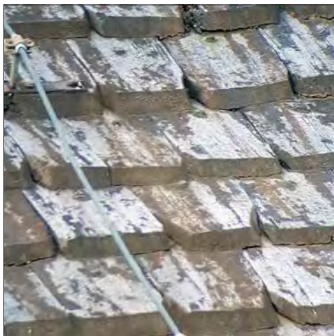
Rättviks kyrka. På kyrkans långhustakfall, nära koret mot norr, finns äldre, handbearbetade spån. Baserna är lätt näbbformade. Lägg märke till spåren av rödtjära. Spånen hör till några av kyrkans äldsta kvarvarande spån och utgör viktigt referensmaterial inför underhållsarbeten på kyrktaket.
