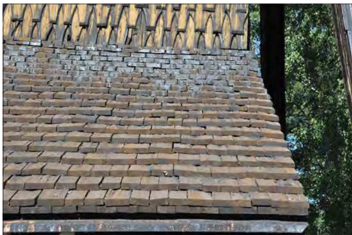
Torsågs klockstapel. Entrétakets spån är senare tillkomna. De är klyvda med sågade kanter och baser.
