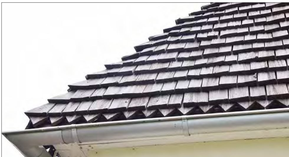
Folkärna bårhus. Spåntäckningen på norra bårhuset utgörs av kluvna raka spån, nedtill kantat med en rad spetspån.
