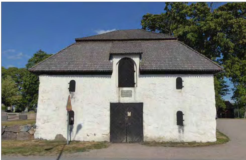
Götunda kyrka. Sockenmagasinet sett från väster.
