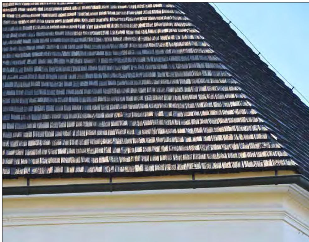
Rättviks kyrka. Äldre, sågade spån från 1900-talets början. Förekommer över hela kyrkan, men återfinns i särskilt stora kvantiteter på koret.
