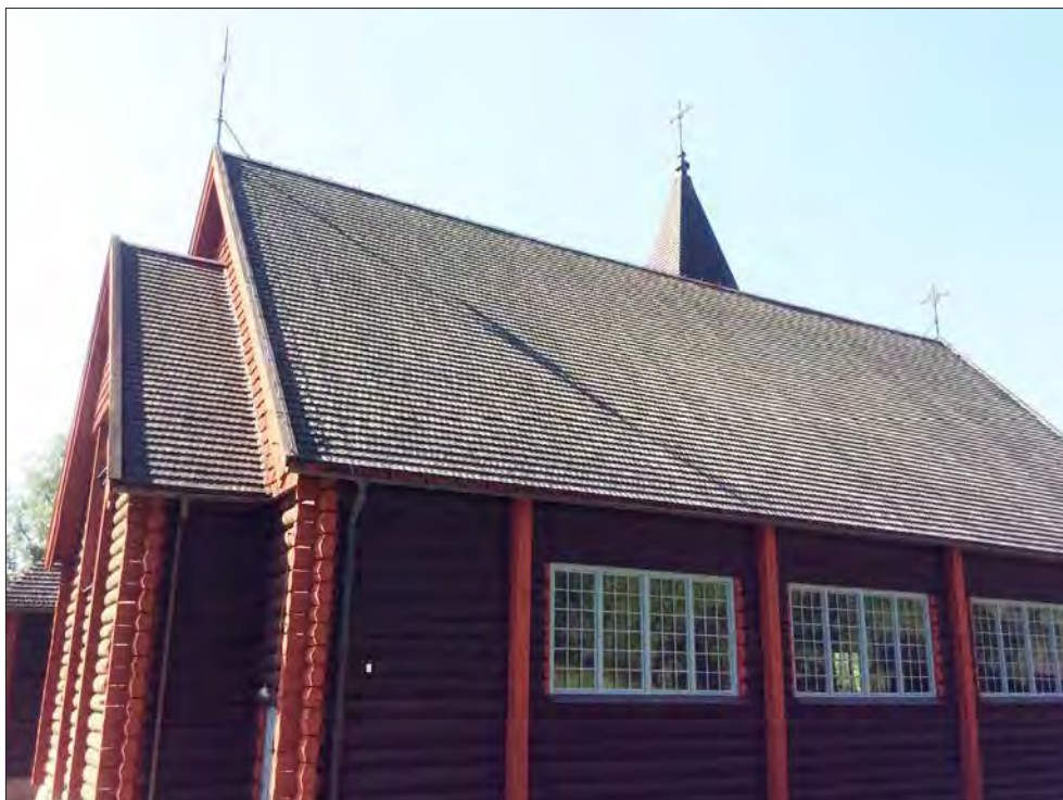
Hörkens kyrka. Kyrkans norra takfall. Spånen är rundade och nedtill finns mönsterläggning med spētsspån och raka spån.
