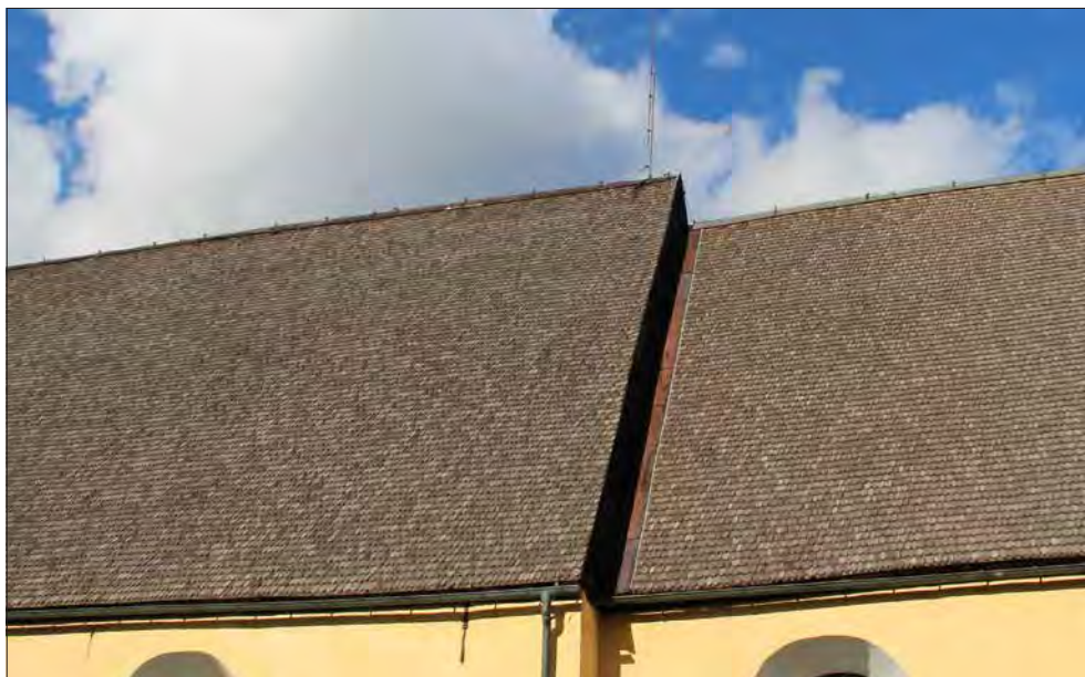
Sala sockenkyrka. På långhusets och korets takfall mot söder ligger kluvna spån uppskattningsvis lagda kring 2000.
