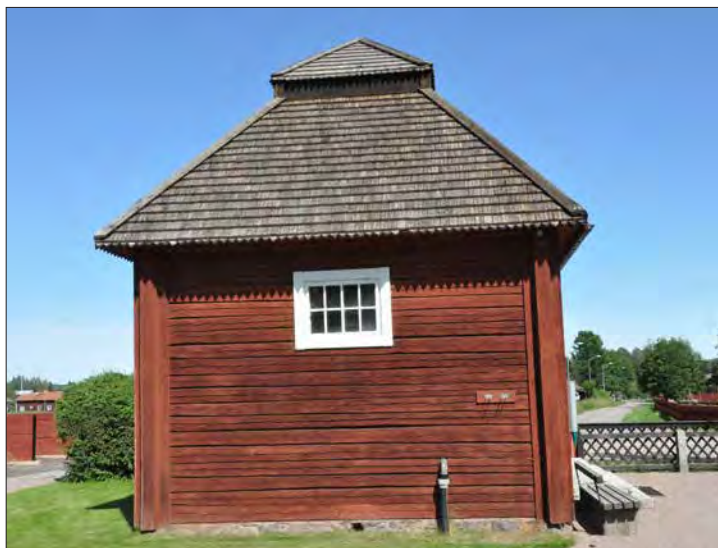
Amsbergs bårhus/ gravkapell med säteritak. Det nedersta spånvarvet är spetsförmigt liksom på samtliga spånklädda takfall i Amsberg
