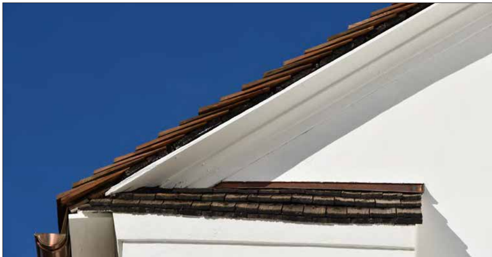
Boda kyrka. Kluvna spån på västra långhustakfallet och äldre spåntäckning på södra gavelgesimsen, foto från södra gaveln.
