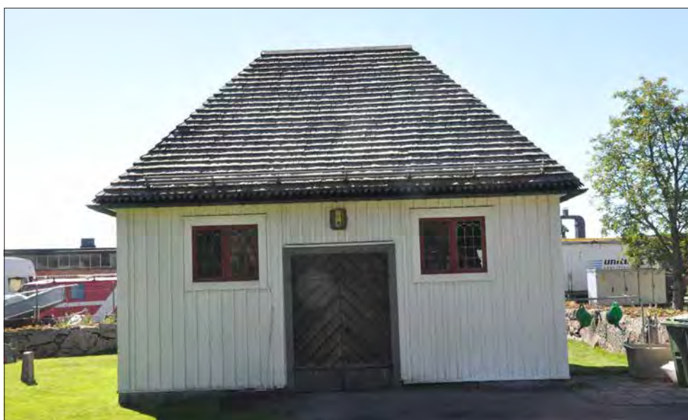
Mockfjärds bårhus har ett valmat spåntäckt sadeltak. Spånen är raka och nedersta varvet spetsformigt.
