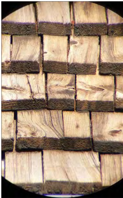
Säby klockstapel. Kikarbild på de sågade ekspån.
