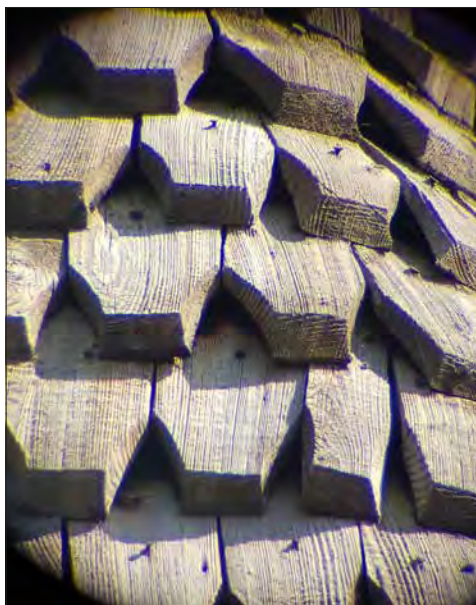
Aspeboda klockstapel. Sågade, näbbformade spån med korta bleken och hög förekomst av liggande årsringar på stapelns tak.
