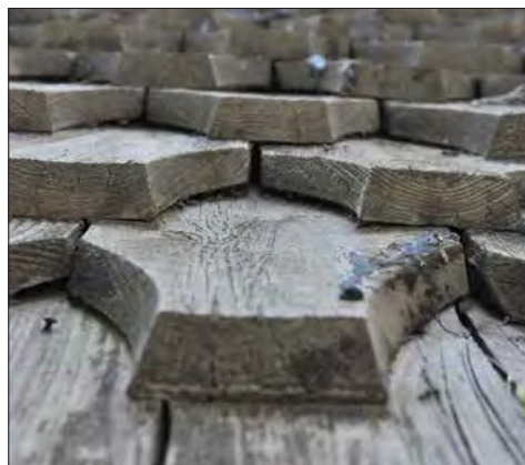
Gagnefs kyrka. Bårhusets sågade, näbbformade spån.
