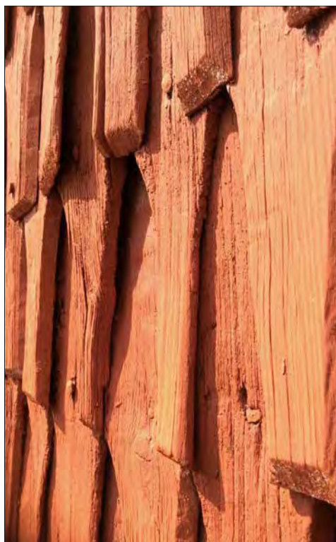
Hällefors kyrka. Vissa spån har eroderat och blivit mycket tunna.
