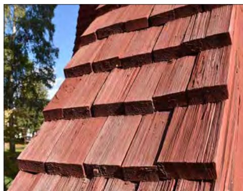
Mora klockstapel. Klockstapelns strävor har raka spån med kluven ovansida, troligen tillkomna på 1990-talet.
