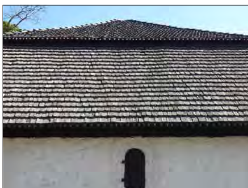
Götunda kyrka. Sockenmagasinet's spåntak från norr.
