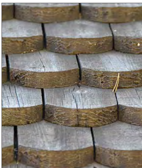
Lumsbedens kapell. Den sågade spåntäckningen på klockstapelns tak. Märk de liggande årsringarna samt kvistförekomsten.
