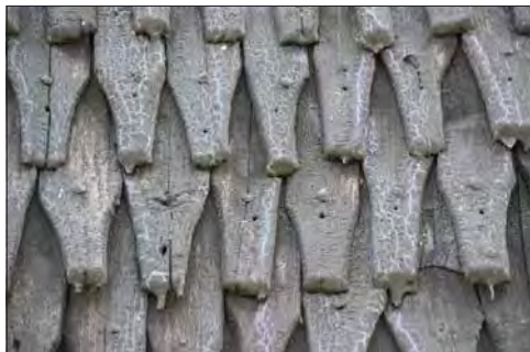
Svedvi klockstapel, närbild på spån på norra fasaden. Mängden spikhål vittnar om att de antingen är återanvända eller att de har demonterats och återmonterats.
