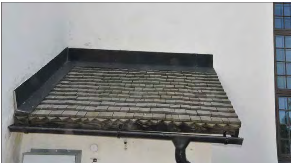
Vika kyrka. Entrétaket med sågade spån.
