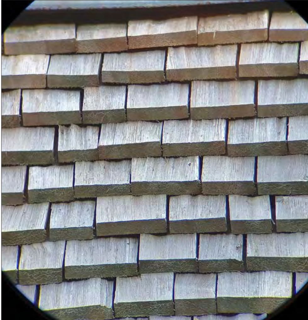
Sala sockenkyrka. Spånen på korets norra takfall lades om i sin helhet 2010. Spånen har klyvd ovalsida och rak bas.
