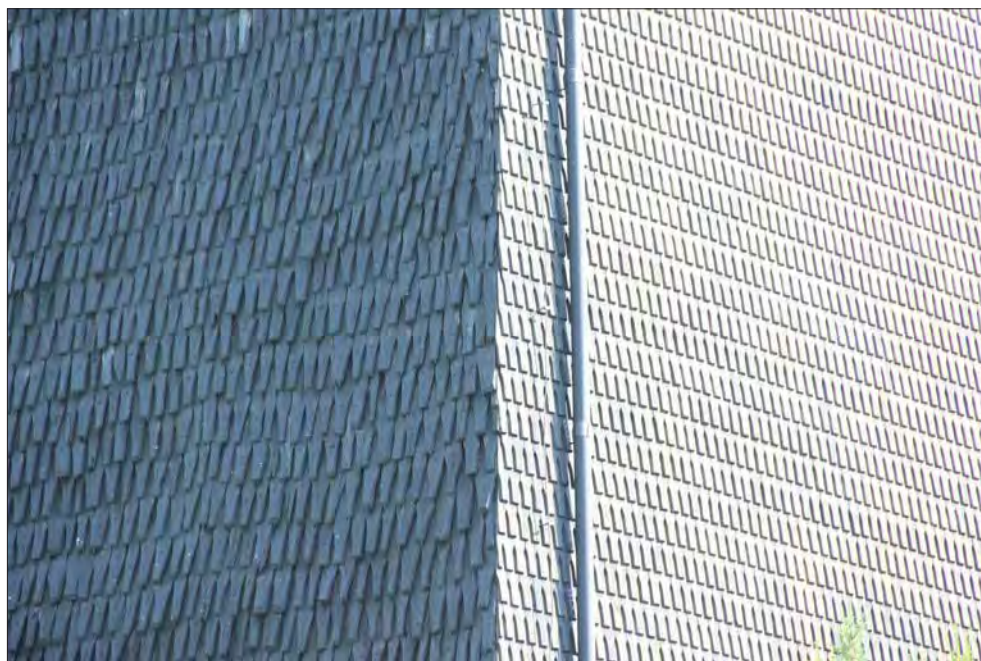
Svedvi klockstapel. Olika spångenerationer förekommer. Ålderdomliga spån finns på norra och västra fasaden medan södra och östra är klädda med sågade spån, eventuellt från sent 1980-tal.
