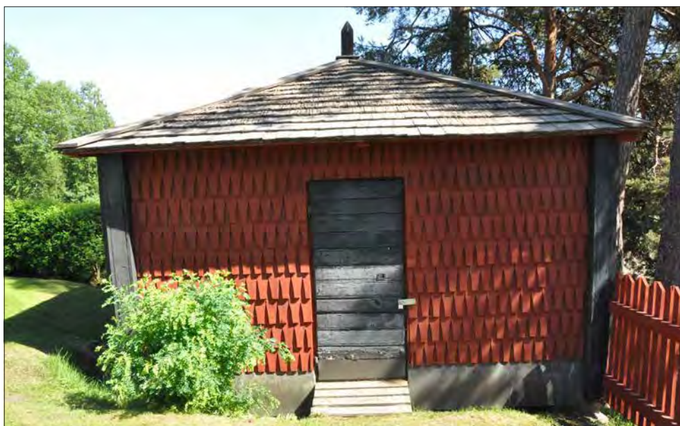
Hosjö kyrka. Redskapsboden har spånklädda fasader och tak. Takspänen har rak kant och hyvlad ovansida, fasadspänen är näbbformade och likadana som på sakristians fasader.
