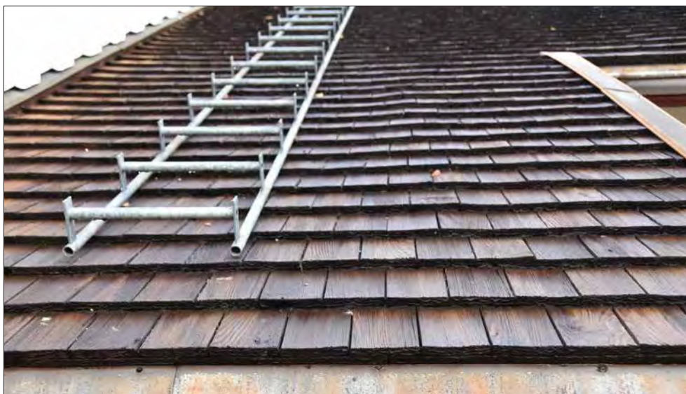
Bingsjö kapell. De sågade spånen på långhus och sakristia är vända "upp-och-ner".
