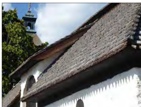
Götunda kyrka. Detalj av spåntak på sockenmagasinet, i bakgrunden skymtar kyrktornet.
