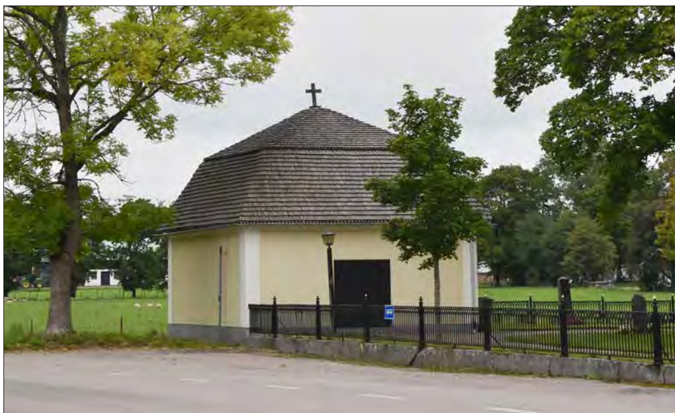
Folkärna kyrka. Två bårhus från 1700-talets slut markerar varsitt hörn på kyrkogården. Taken har en bruten form och själva brytningen i takfallen markeras av spetspån. Bilden visar det norra bårhuset.
