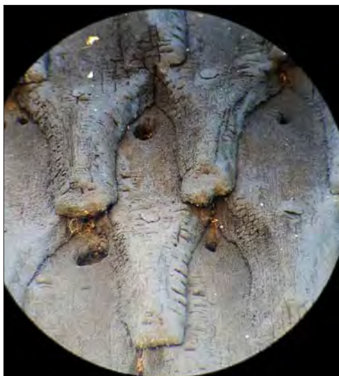
Svedvi klockstapel, sågade spån på östra fasaden.
