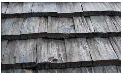
Bingsjö kapell. Klyvda spån på tornfasaden.
