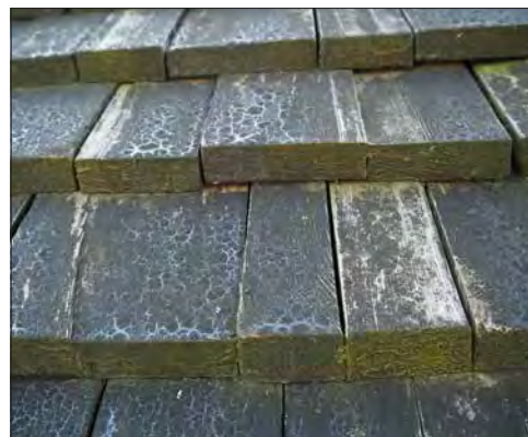
Rytterne bårhus, norra takfallet.
