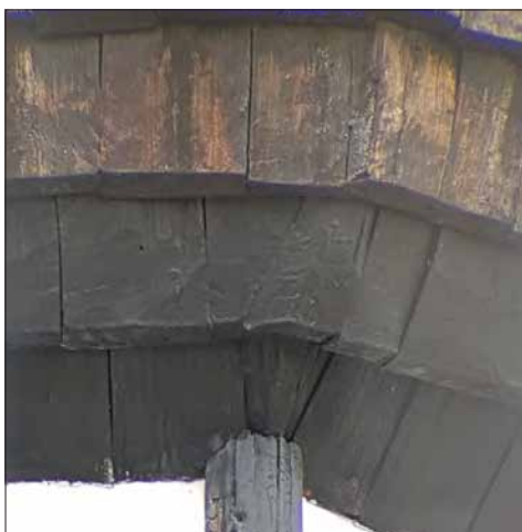
Bingsjö kapell. De sågade spånen på långhus och sakristia är vända "upp-och-ner".
