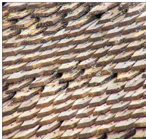
Ore kyrka. På långhuset förekommer framför allt två typer av spån. På denna bild är båda typerna tydligt urskiljbara. En sågad typ, ljusare, troligen tillkommen vid omläggningen 1962. I partier intill ligger en spåntyp med äldre tjärklumpar. Kanske utgör de ursprungliga spån från 1870-talet, eller så har de tillkommit under 1900-talets förra del.
