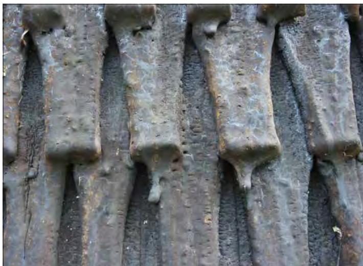
Figur 41. Kungs-Barkarö kyrka, Västerås stift. Spånen på tornets fasader täcks av ett tjockt pansarskikt, eventuellt så kallad rörtjära, eller så förekommer skikt av stenkolsstjära. Foto Lisa Skanser.
