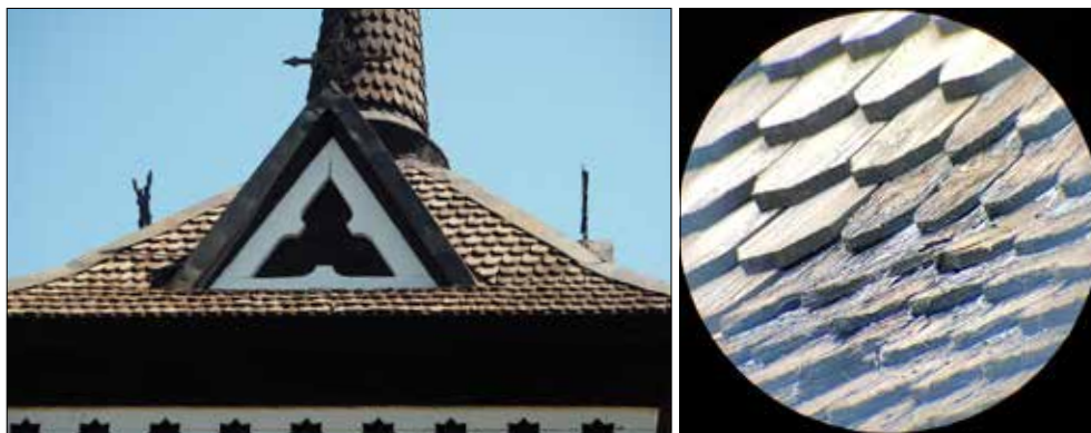
Taxinge klockstapel. Notera skillnaden mellan äldre och yngre spån på buven.
