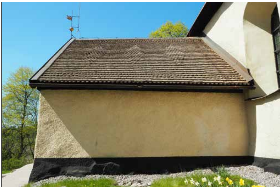
Salems kyrka. Vapenhusets östra takfall.
