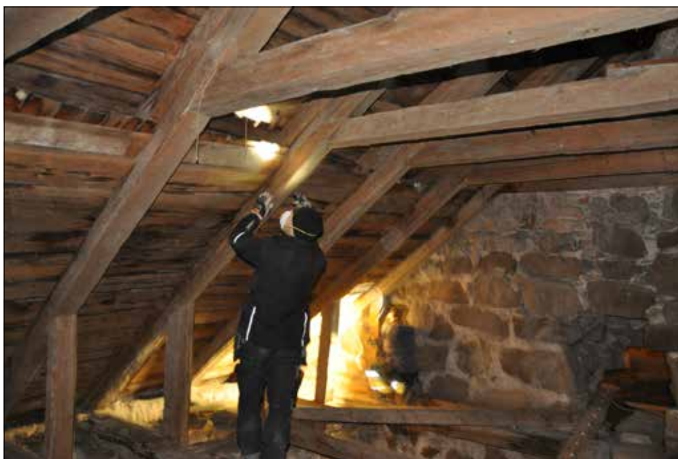
Figur 56. Daniel Eriksson och Lisa Skanser undersöker korets södra sida från vinden i november 2018. Undertaksbrädorna uppvisade två generationer spikhål vid en nära granskning. Foto Lars Jönsses.
