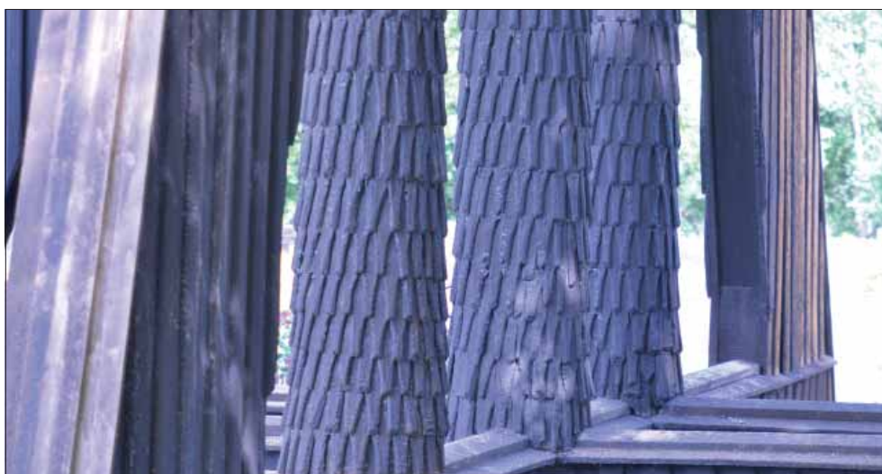
Tångeråsa klockstapel. Klockstapelns hjärtstockar är i sin helhet huggna och täckta med mycket tjocka tjärskikt. Spåntäckningen är mycket gammal och innehåller möjligtvis originalspån.
