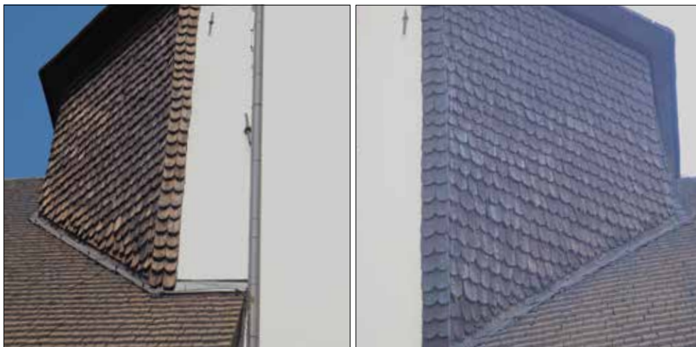
Bälunge kyrka. Tornets spånkädda fasad från nordväst (t.v.) och sydväst (t.h.)
