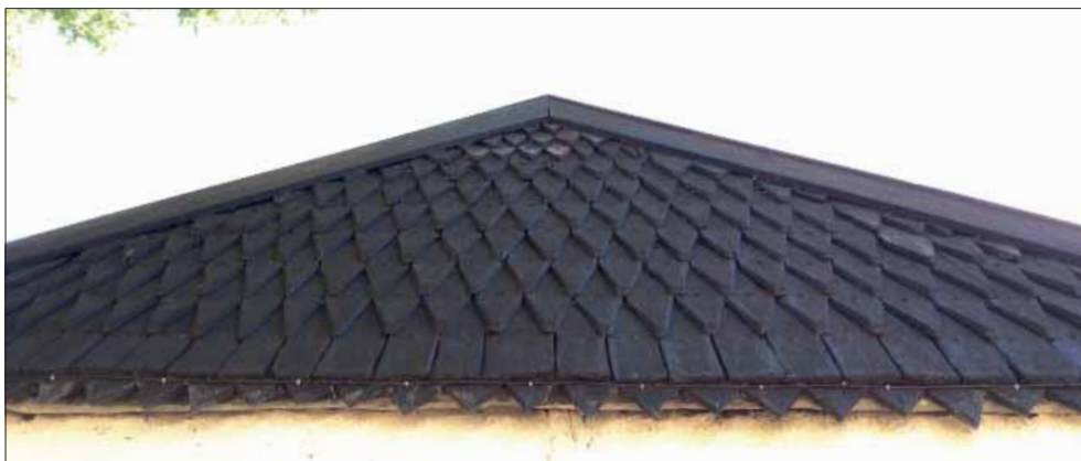
Tångeråsa kyrka. Fasadspånen på sakristians nordsida är mycket gamla och härrör möjligen från medeltiden.
