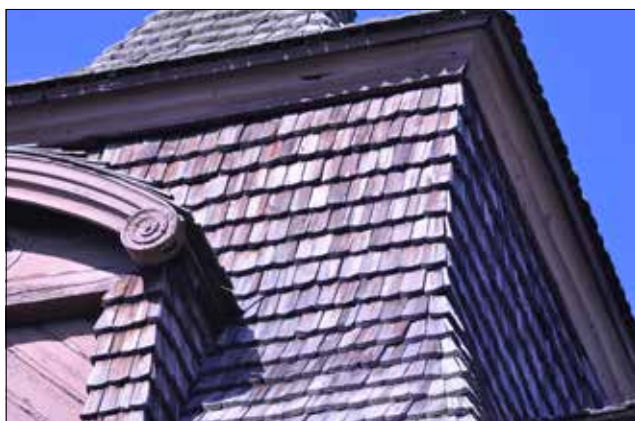
Årdala kyrka. Endast rester av tjära finns på spånytan.
