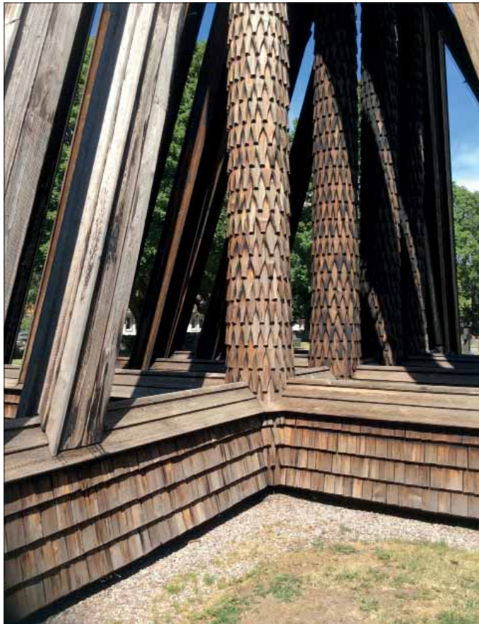
Glanshammars klockstapel. Hjärtstolparna är klädda med näbbspån medan syllen har raka spån.
