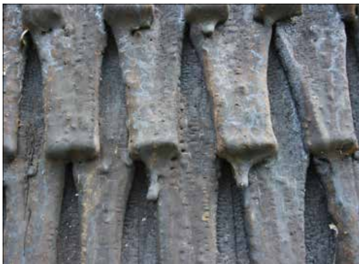
Figur 41. Kungs-Barkarö kyrka, Västerås stift. Spånen på tornets fasader täcks av ett tjockt pansarskikt, eventuellt så kallad rörtjära, eller så förekommer skikt av stenkoltjära. Foto Lisa Skanser.
