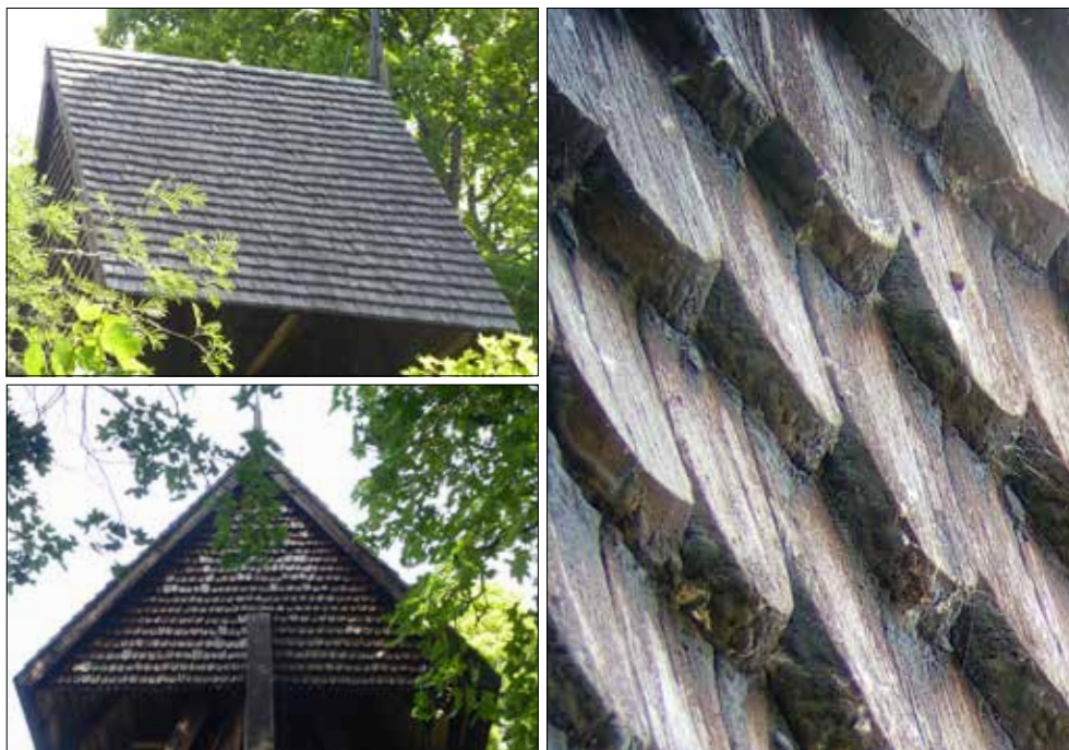
Nykyrka klockstapel. Fasadspån på klockstapelns huv. Vissa spån är utbytta och har synlig infästning.
