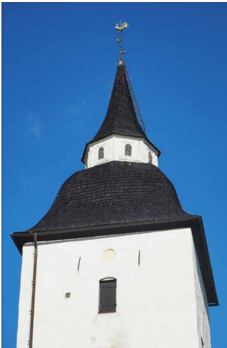
Ytterembörna kyrka. Tornets spåntäckning efter tjärning, septem- ber 2018.
