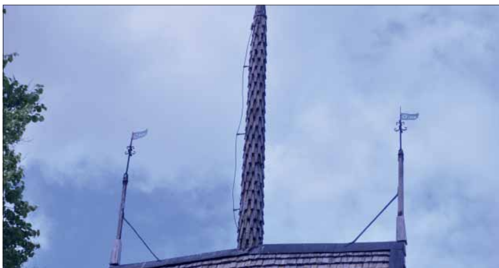
Tångeråsa klockstapel. Klockstapelns spira har näbbformade spån som uppvisar rester av rödtjära.
