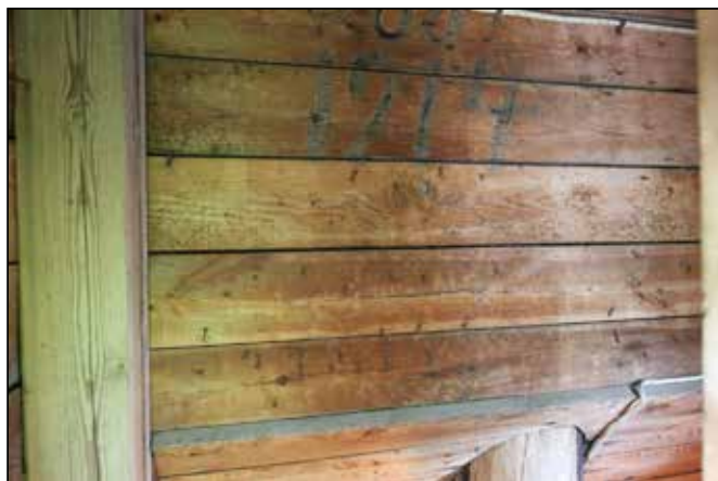
Panel i trappbyggnaden, en generation spånsplik. Foto: Lisa Skanser.
