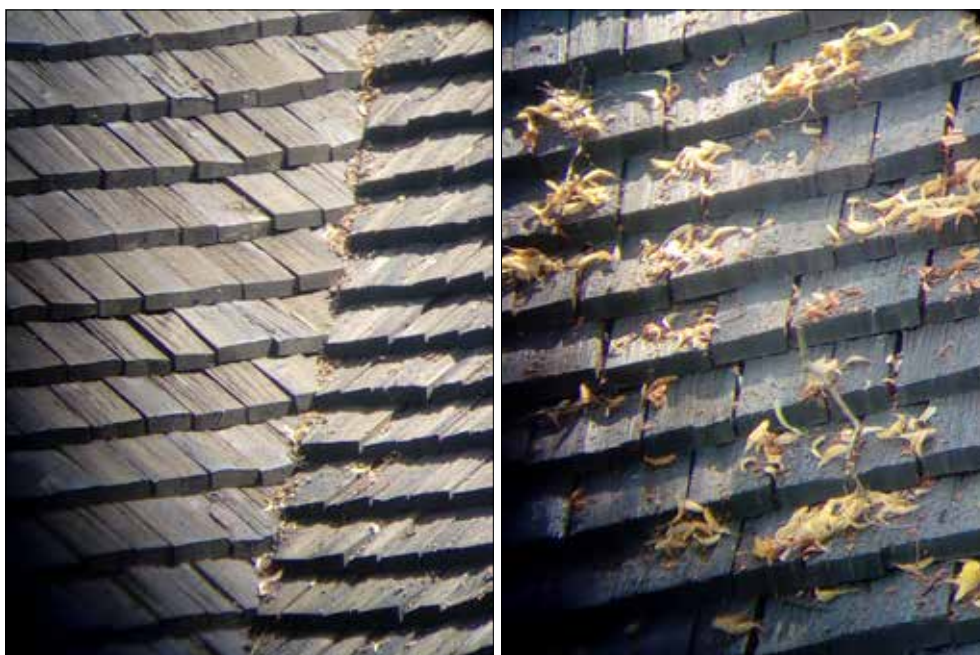
Näshulta kyrka. Rännal mellan sakristia och långhus (t.v.). Raka spån med fasad kant (t.h.).
