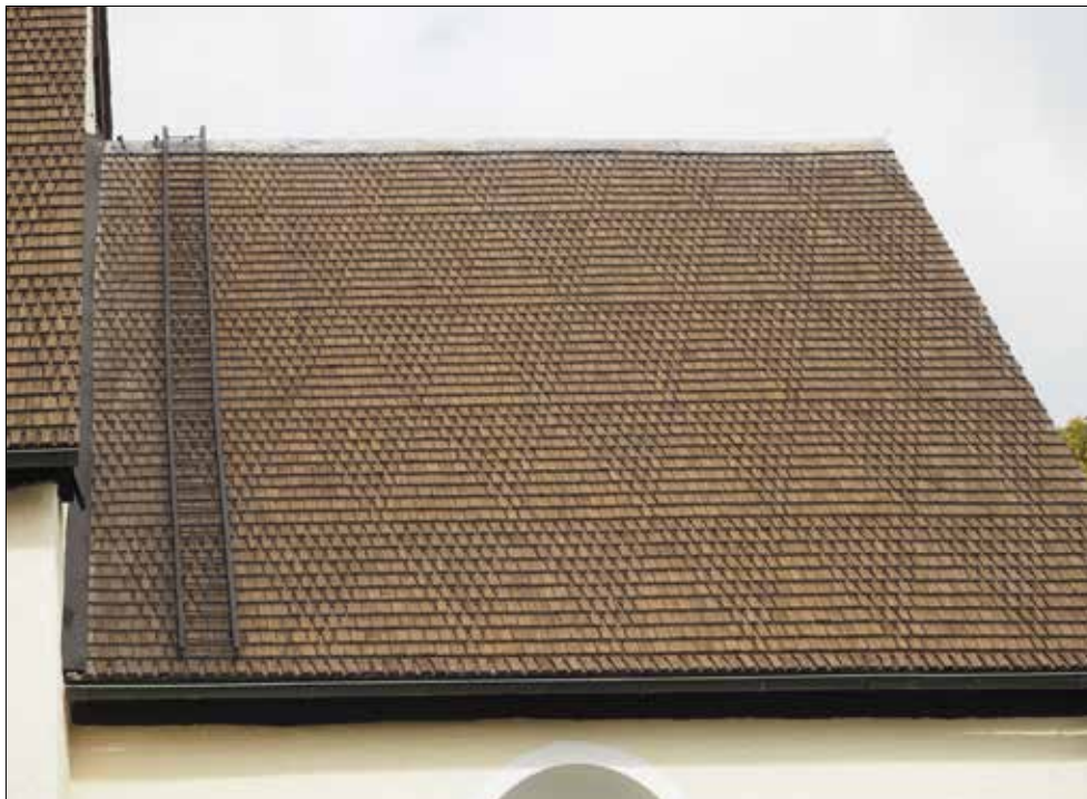
Tuna kyrka. Korets södra takfall.
