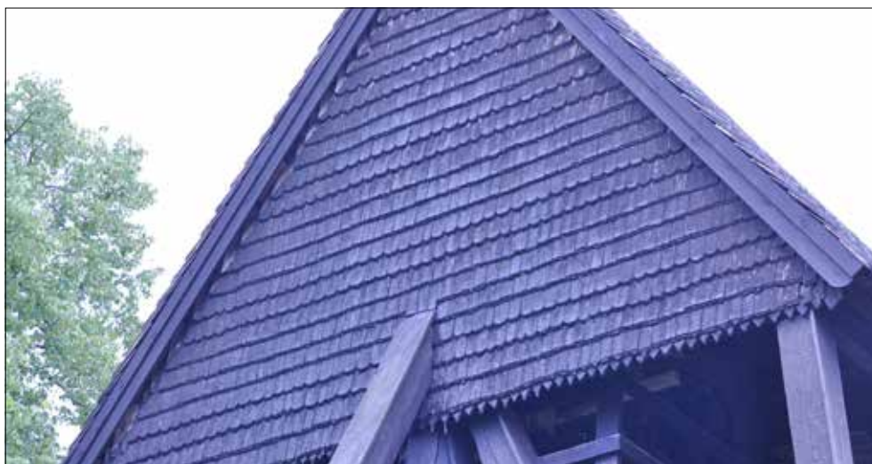
Bärbo klockstapel. Huvens norra fasad med raka och rundade spån.
