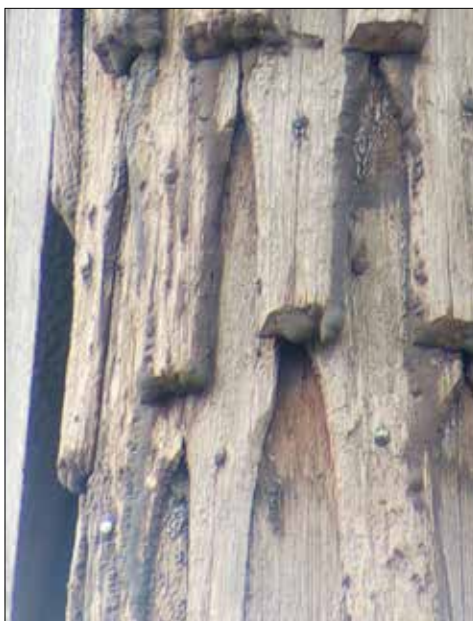
Vadsbro klockstapel. Näbbformade spån på hjärtstolpe.
