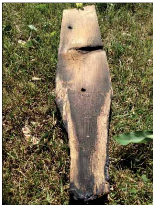
Kräcklinge klockstapel. Hjärtstockarnas spån har synlig infästning och mycket tjocka tjärskikt (t.v.). Ett löst näbbspån med rits på baksidan för näbb, hål för infästning och spår av tjocka tjärager (t.h.).
