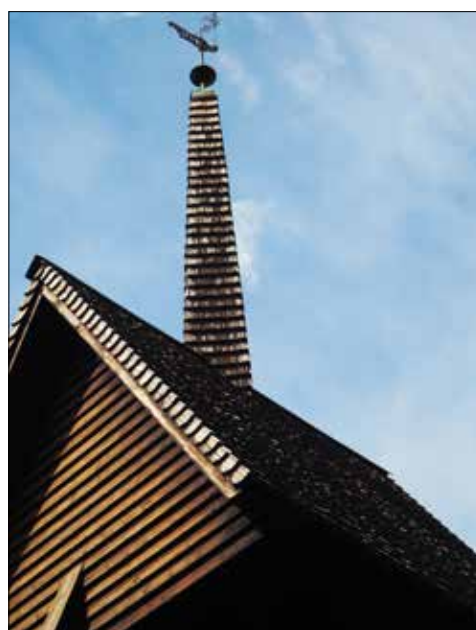
Söby begravningsplats. Vindskivespån på klockstapelns bun. Foto från sydöst.
