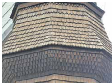
Sköldinge kyrka. Mönsterläggning på gravkorets tak.
