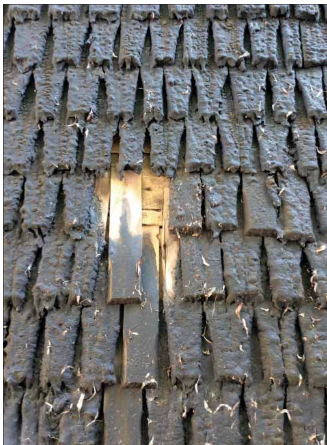
Sköllersta klockstapel. Spåntäckning på klockstapelns västra fasad.
