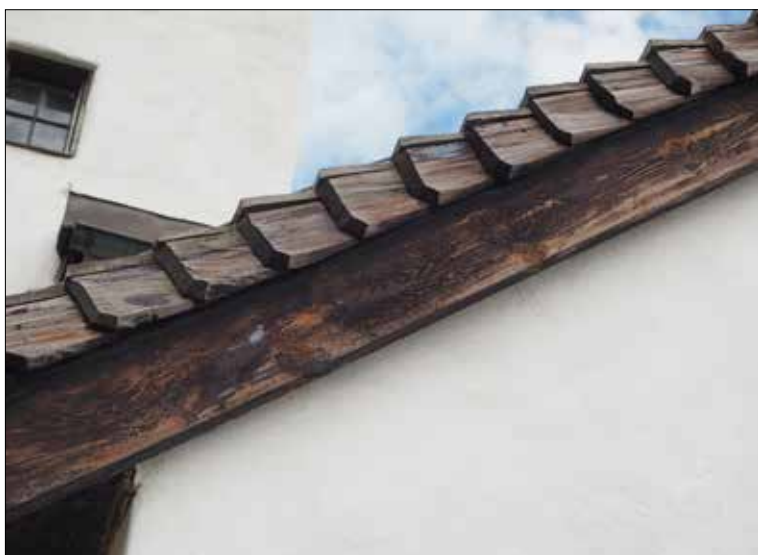
Ytterenhörna kyrka. Vapenhusets vind- skeivespån före tjär- ning. Foto från söder.
