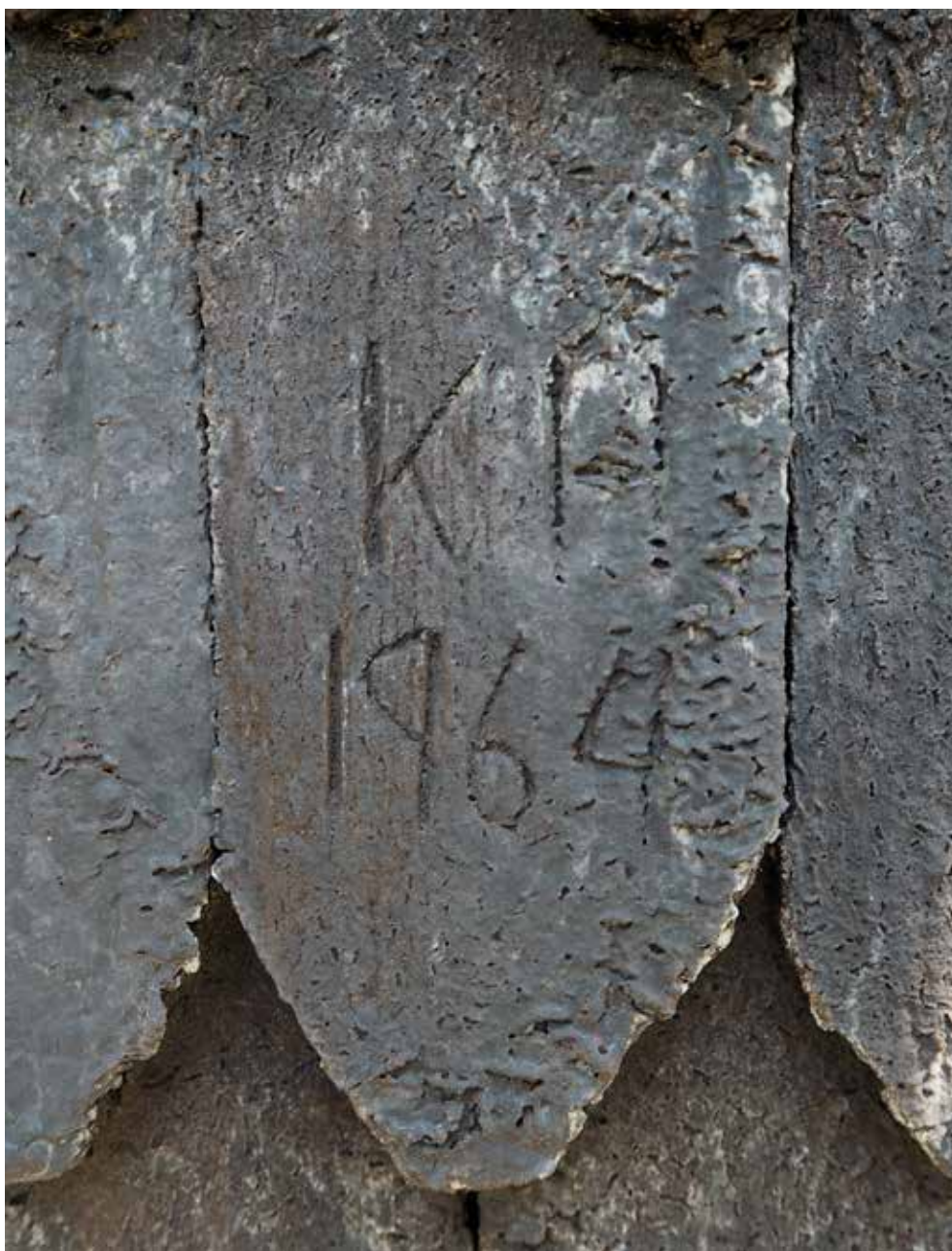
Taxinge klockstapel. "KH 1964" inristat på spån på snedsträva. Årtal för omläggning av spån eller underhåll. Foto från väster.
