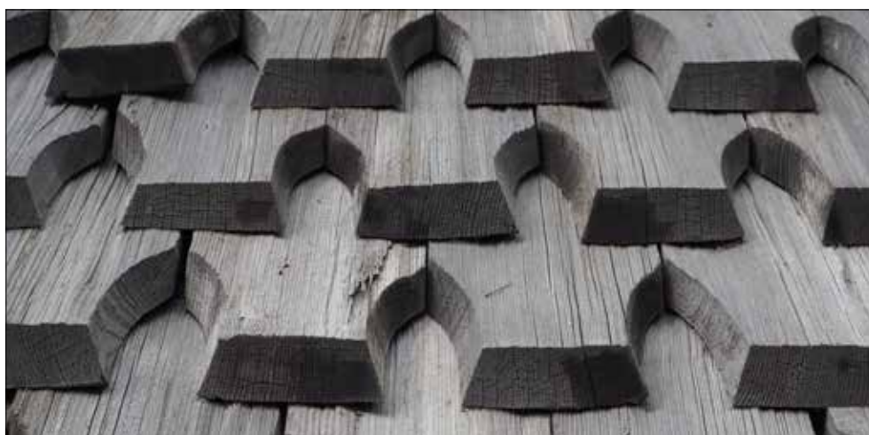
Vansö kyrka. Detalj av spån på strävpelaren.
