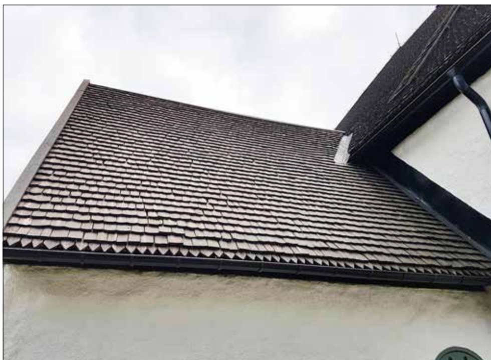
Åkers kyrka. Sakristians västra takfall.
