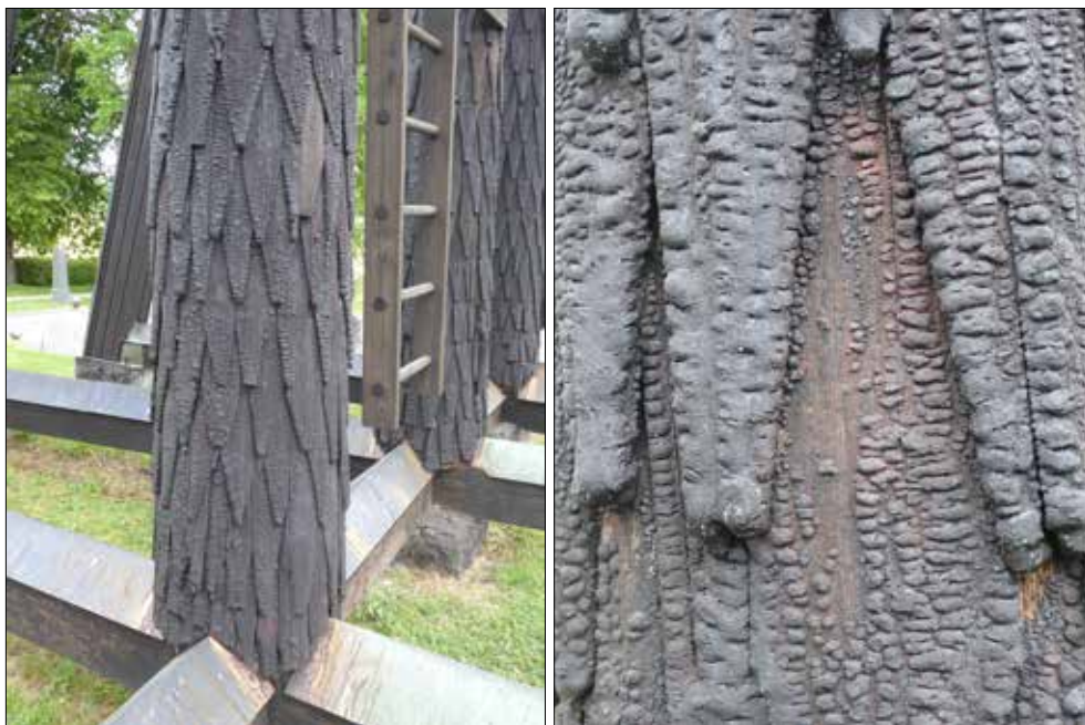
Sköldinge klockstapel. Hjärtstolparnas spantäckning.
