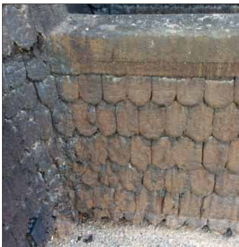
Almby klockstapel. Spånen på syllan har ett mycket tjockt och intakt tjärskikt.
