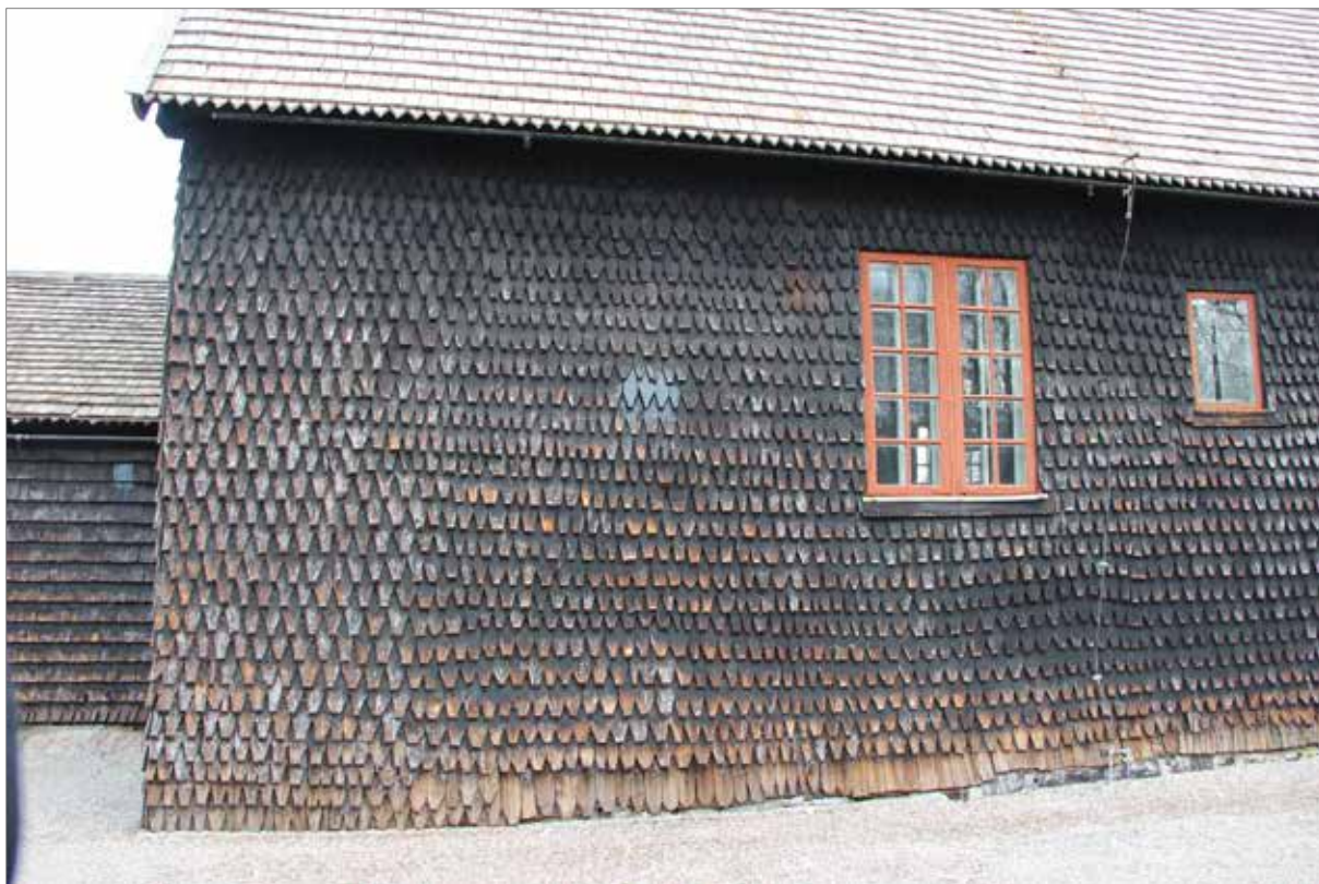
Södra fasaden efter återmontering. De tre nytillverkade spånen kan tillfälligt urskiljas genom den blankare tjäran. Foto: Daniel Eriksson.
