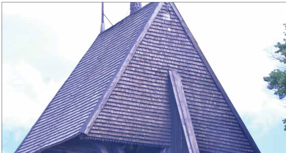
Tångeråsa klockstapel. Klockstapelns huv är i sin helhet spåntäckt. Fasaderna har gamla spån med tjocka tjärskikt med rester av rödtjära medan taket har en yngre spåntäckning.
