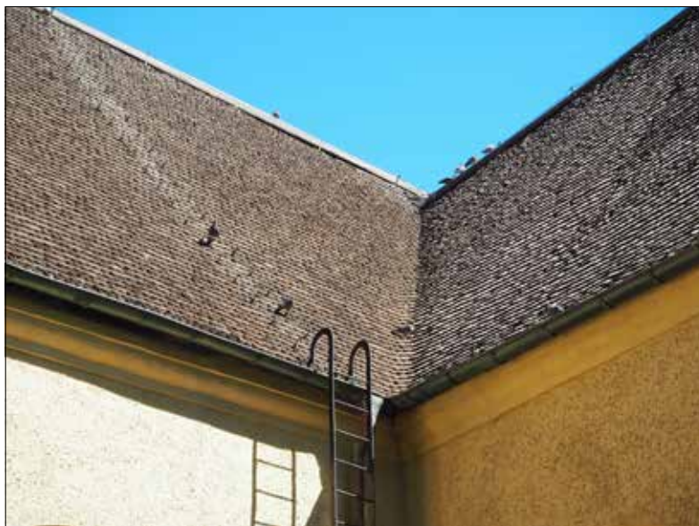
Fors kyrka. Spånklädd rännad mellan långhus och korsarm.
