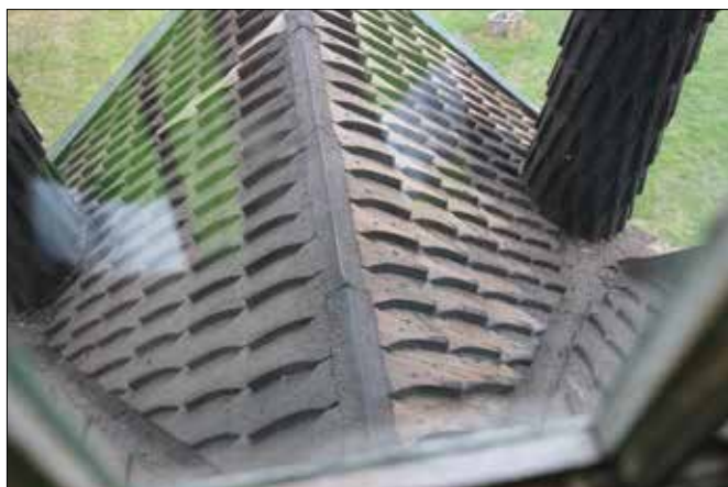
Takfall över stenfoten mot öster. Foto taget genom fönster. Övernock och i rännal ligger plåt. Foto: Lisa Skanser.
