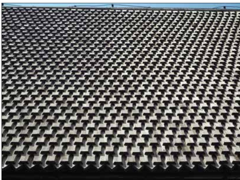
Vansö kyrka. Vapenhusets östra takfall.
