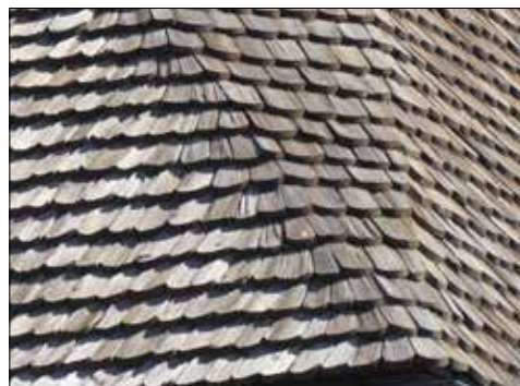
Lista kyrka. Detalj av gravkorets spåntäckning.
