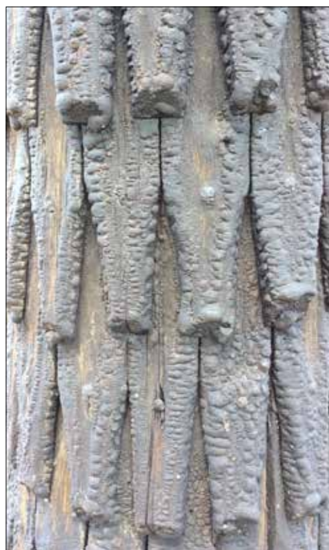
Lista klockstapel. Näbbspån med synlig infästning på en av klockstapelns hjärtstolpar.
