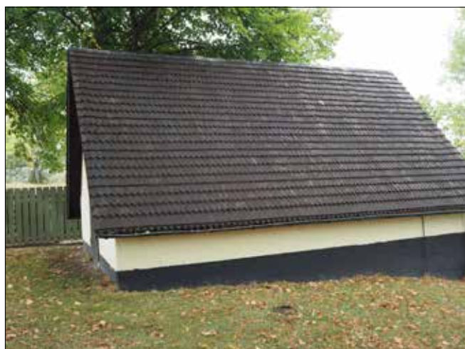
Tuna kyrka. Bårhusets östra takfall.
