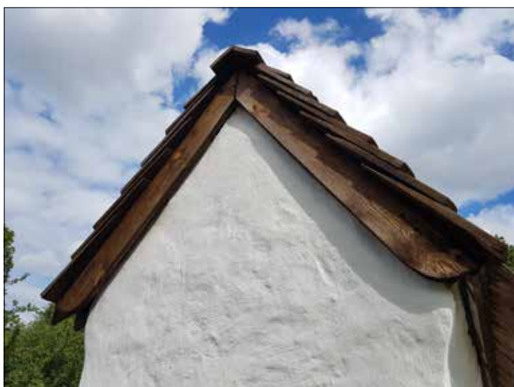
Åkers stigluckor. Spån i trelagstäckning.
