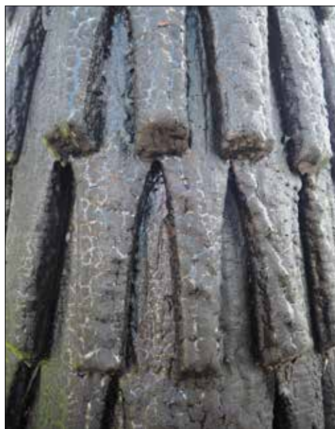
Råby-Rekarne klockstapel. Hjärtstolparna är klädda med näbbformade spån, täckta med ett tjockt tjärlager.
