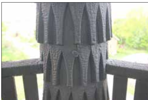
Västermo klockstapel. Näbbformade spån på pelare.
