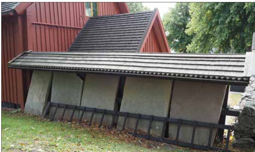
Tunabergs lapidarium. Spåntäckt tak över lapidarium.
