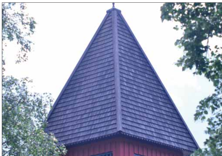
Mullhyttans klockstapel. Klockstapeln uppfördes 1930 och fick ett spånklätt tak. Spåntäckningen utgörs av raka spån och kantas nedtill av spetsspån.
