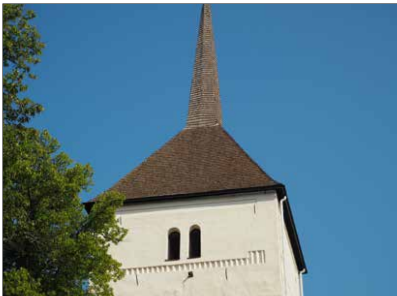
Överselö kyrka. Kyrkans torn med spåntäckt tak.
