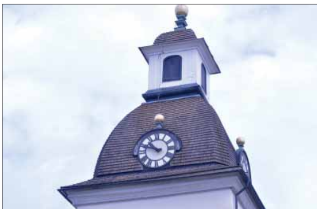
Lerbäcks kyrka. Såväl tornhuv som lanternhuv är spånklädda.
