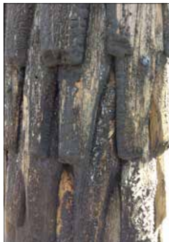
Blacksta klockstapel. Näbbformade spån på en av klockstapelns hjärtstockar. Spår av en grå beläggning syns på bilden, vilket kan vara spår av ett ytbehandlingsmedel som innehåller asbest.
