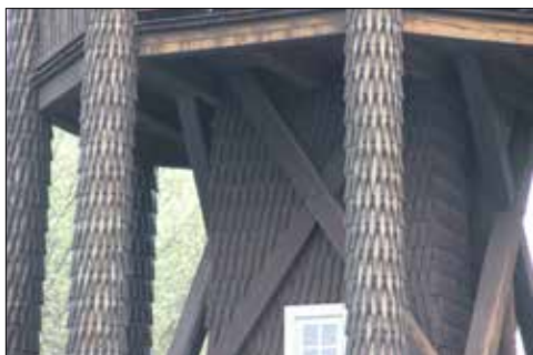
Västermo klockstapel. Spånklädda stolpar och fasad.
