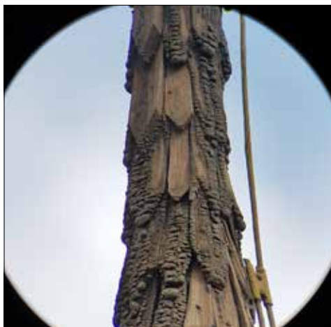
Figur 3. Tunabergs kyrka, Strängnäs stift. Kikarbild visar spån med tjocka tjärklumpar på en av takets spiror. Foto Karin Myhrberg.
