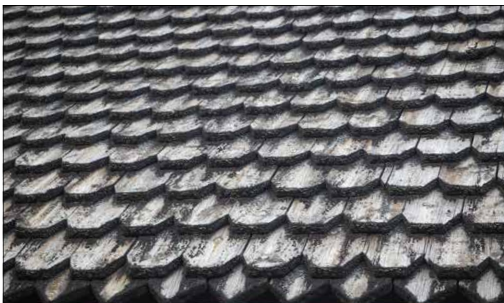
Ösmo kyrka. Långhusets södra takfall.
