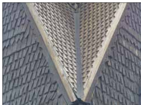
Sköldinge klockstapel. Kontraster mellan huvens fasader med äldre spån och takfallens nyare spån.
