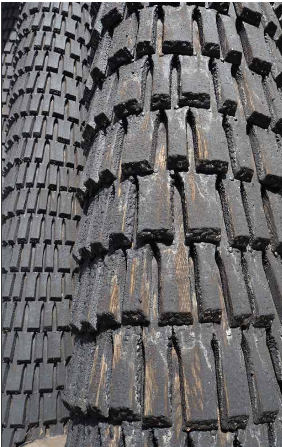
Barva klockstapel. Detalj av spåntäckning på hjärtstolpe.
