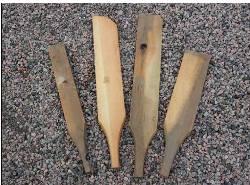
Västermo klockstapel. Oanvända spån som har förvarats inne i klockstapeln.
