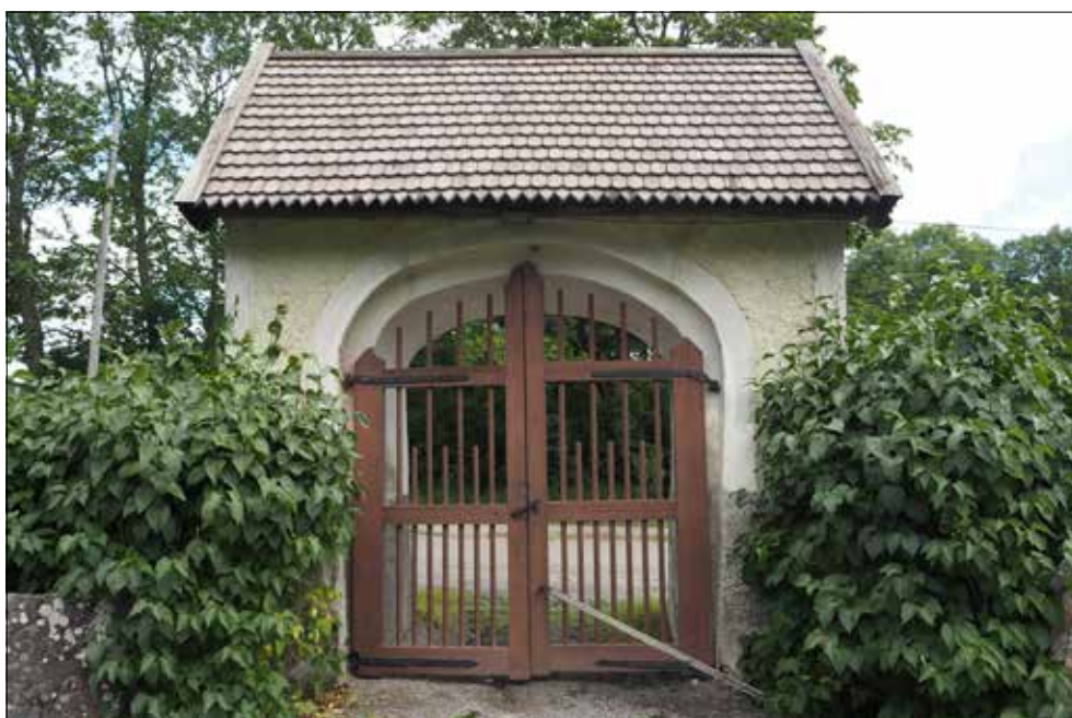
Härads stigluckor. Västra stigluckans södra takefall.
