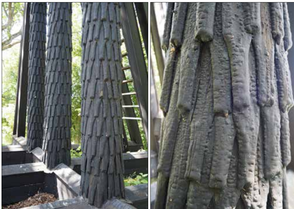
Lästringe klockstapel. Spänklädda hjärtstolpar (t.v.). Detalj av näbbformade spån på en hjärtstolpe. Synlig infästning och ett tjockt tjärskikt (t.h.).
