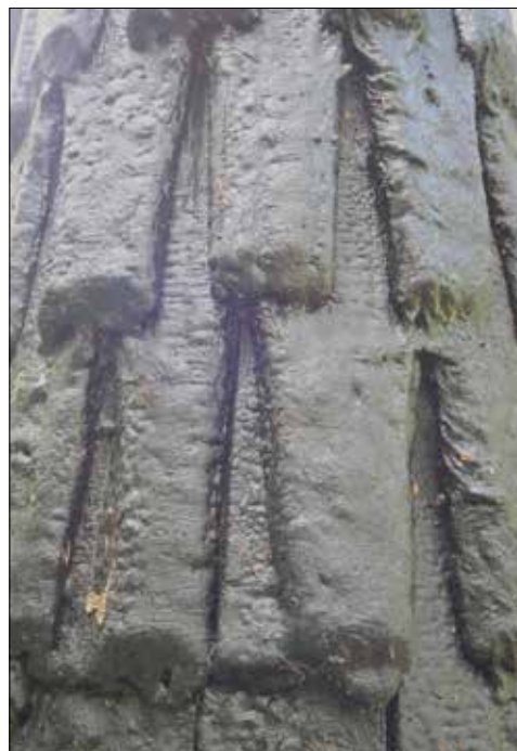
Bälinge klockstapel. Detalj av spån på en av hjärtstolparna. Notera hur spånen mitt i bilden är lagda.
