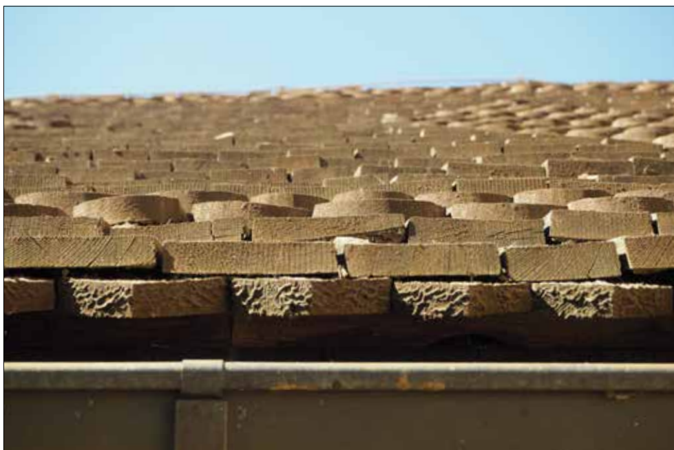
Salems kyrka. Detalj, vapenhusets östra takfall.
