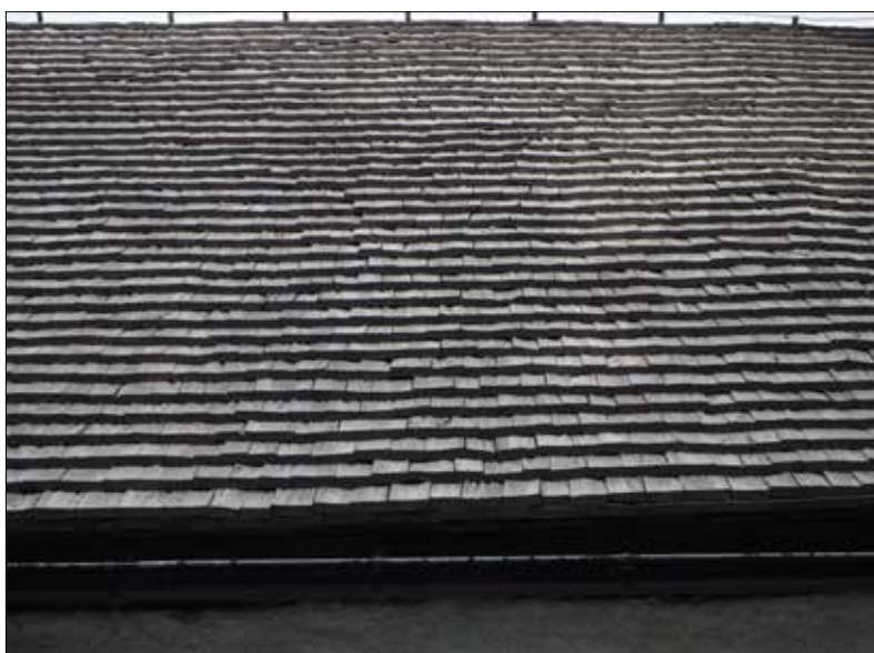
Vansö kyrka. Bisättningshusets västra takfall.
