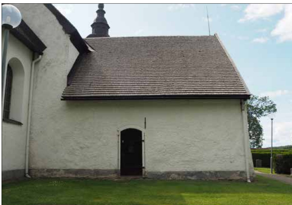
Vansö kyrka. Sakristians östra takfall.
