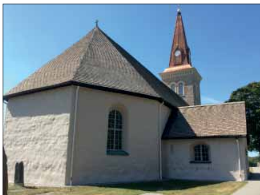
Askers kyrka. Spånen är raka med fasad kant. Nedersta raden har en triangulärt spetsig avslutning.
