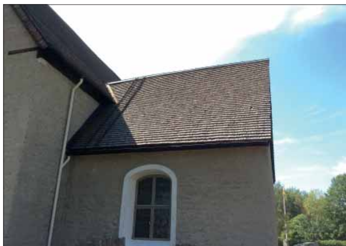
Sköllersta kyrka. Sakristians östra takfall
