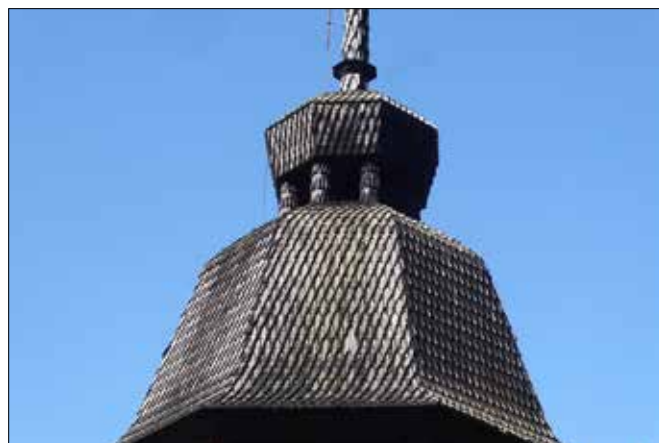
Klockhuv och lanternin. Foto: Bengt Bygdén.
