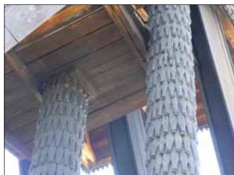
Lista klockstapel. Äldre näbbspån på klockstapelns hjärtstolpar.
