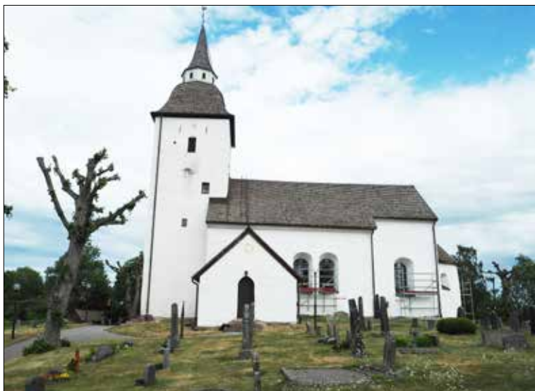
Ytterenhörna kyrka. Kyrkan från söder före tjärning.
