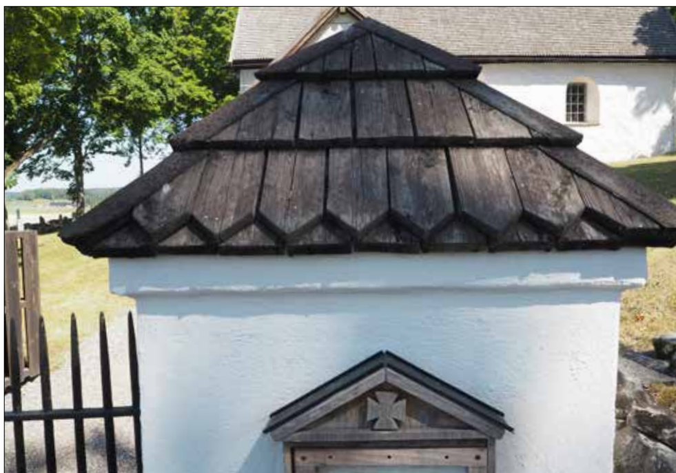
Spelviks grindstolpar. Grindstolpe med spånklädd täckning.
