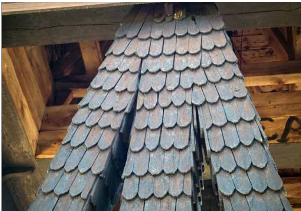
Taxinge klockstapel. Spånbeklädnad, möte snedsträvor och hjärtstock. Foto från väster.
