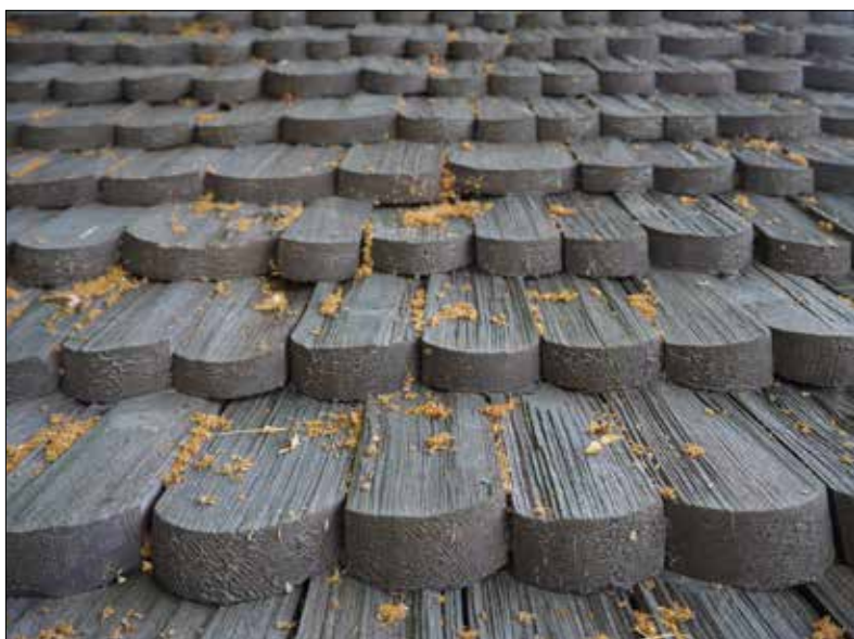
Runtuna stigluckor. Klarna spån på västra stigluckans norra takfall. Spånen lades 2013.
