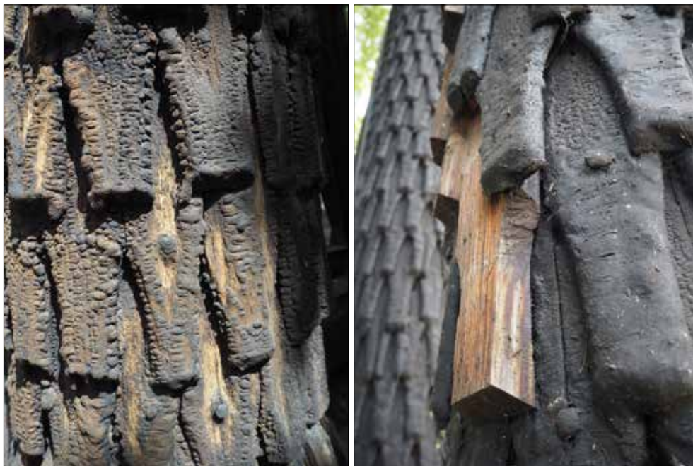
Lids klockstapel. Detaljer från hjärtstolpar. Synlig infästning och på vissa ställen ett tjockt lager tjära (t.v.). Äldre spån och ett fåtal nya spån (t.h.).
