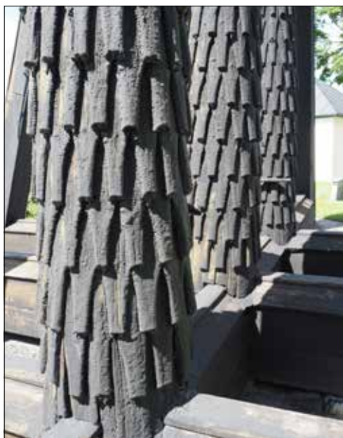
Råby-Rekarne klockstapel. Hjärtstolparna är klädda med näbbformade spån, täckta med ett tjockt tjärlager.
