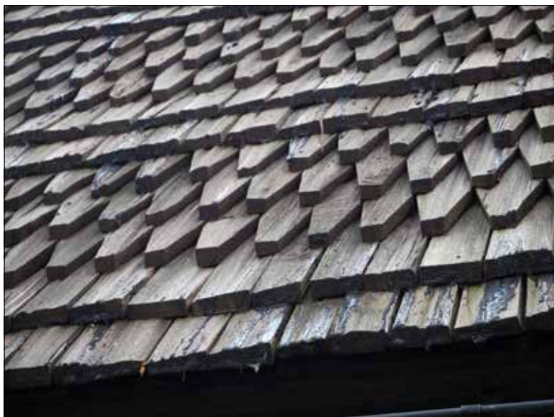
Ytterselö kyrka. Mönsterläggning på sakristians västra takfäll.
