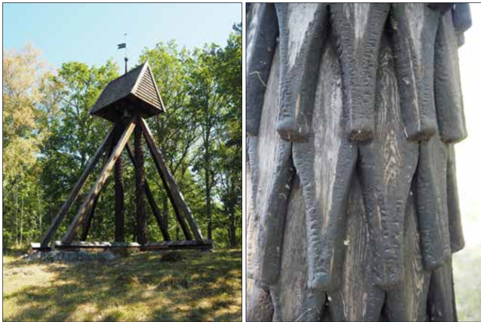
Spelviks klockstapel. Näbbformade spån på en av klockstapelns hjärtstolpar.
