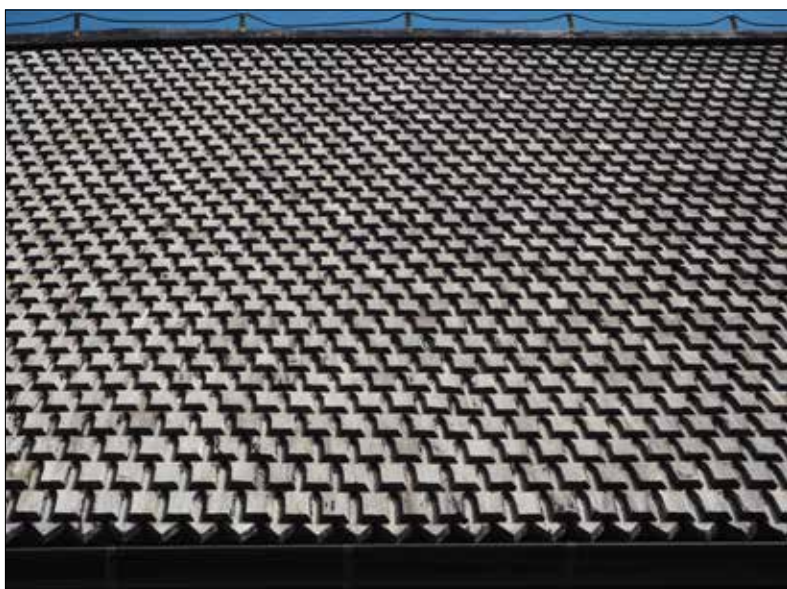
Vallby kyrka. Närbild på vapenhusets västra takfall.
