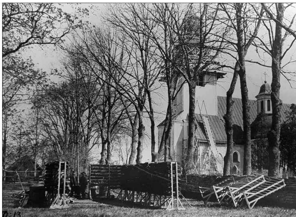
Figur 21. Tjärkokning och torkning av spån vid Vreta klosterkyrka 1915. Foto Erik Fant. Bildkälla ATA.
