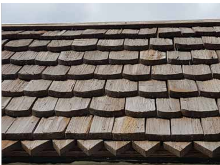
Åkers stigluckor. Spåntäckning på västra stigluckans tak.
