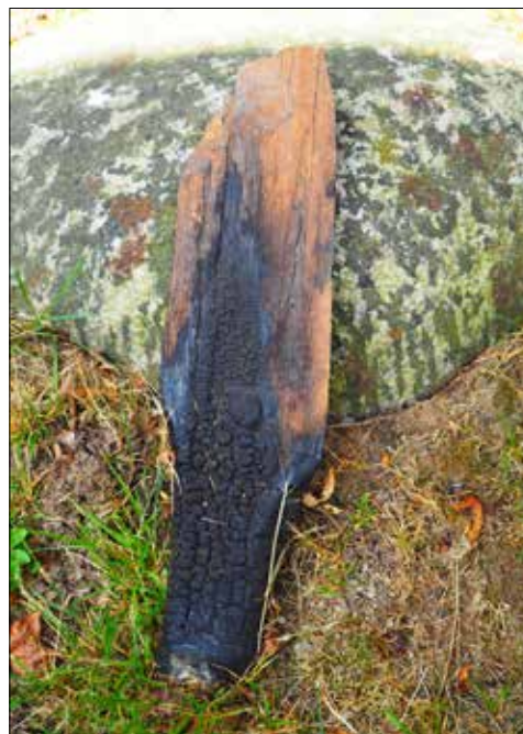
Sättersta klockstapel. Löst spån intill klockstapel. Spånet har synlig infästning och ett ganska tjockt, krackelerat tjärslager.
