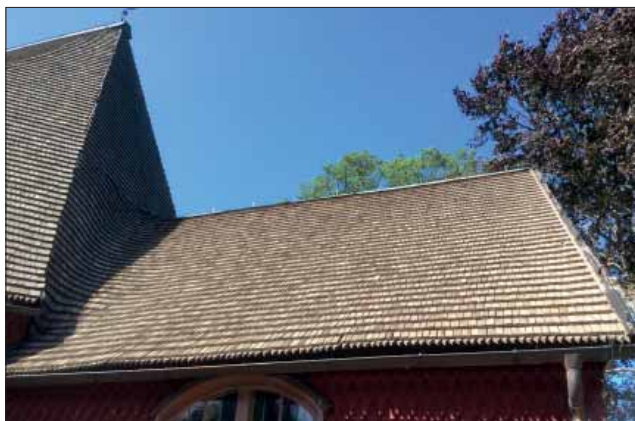
Kvistbro kyrka. Korets södra takfall. Notera uppsvängningen mot långhuset.
