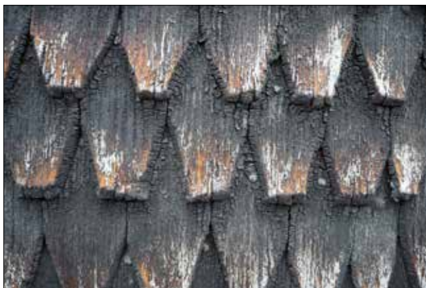
Figur 6. Tångeråsa kyrka, Strängnäs stift. Synliga asbestfibrer på södra långhusväggens spån. Foto Karin Myhrberg.
