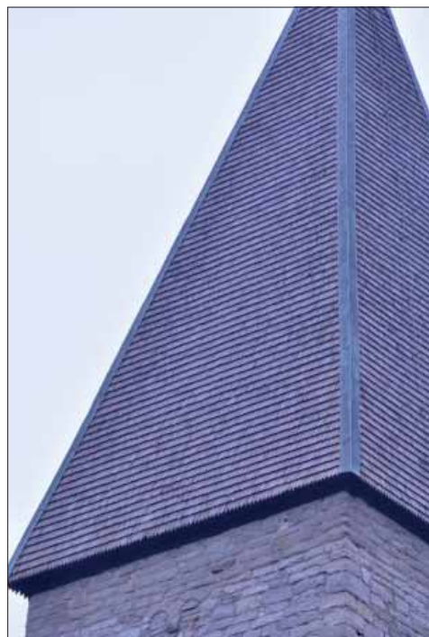
Mosjö kyrka. Torn-taket västra takfall. Tillsammans med östra och södra takfallet saknas den mönsterläggning som återfinns på norra sidan. Möjligen rör det sig om en äldre mönsterläggning som gått förlorad.
