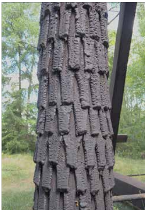
Bälinge klockstapel. Näbbspån med ett tjockt lager tjära på en av klockstapelns hjärtstolpar.
