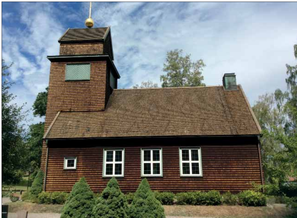
Adventskyrkan i Hjortkvarn. Notera mönsterläggningen på långhustaket. Foto från söder.
