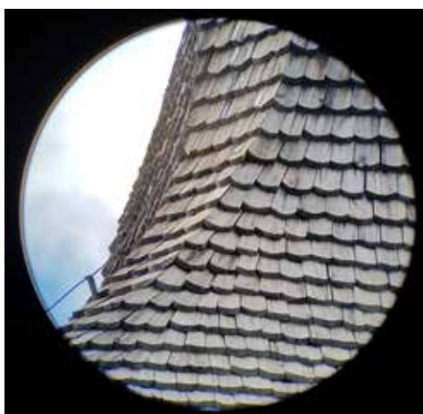
Vårdinge kyrka. Spån på tornets tak. Foto från norr.
