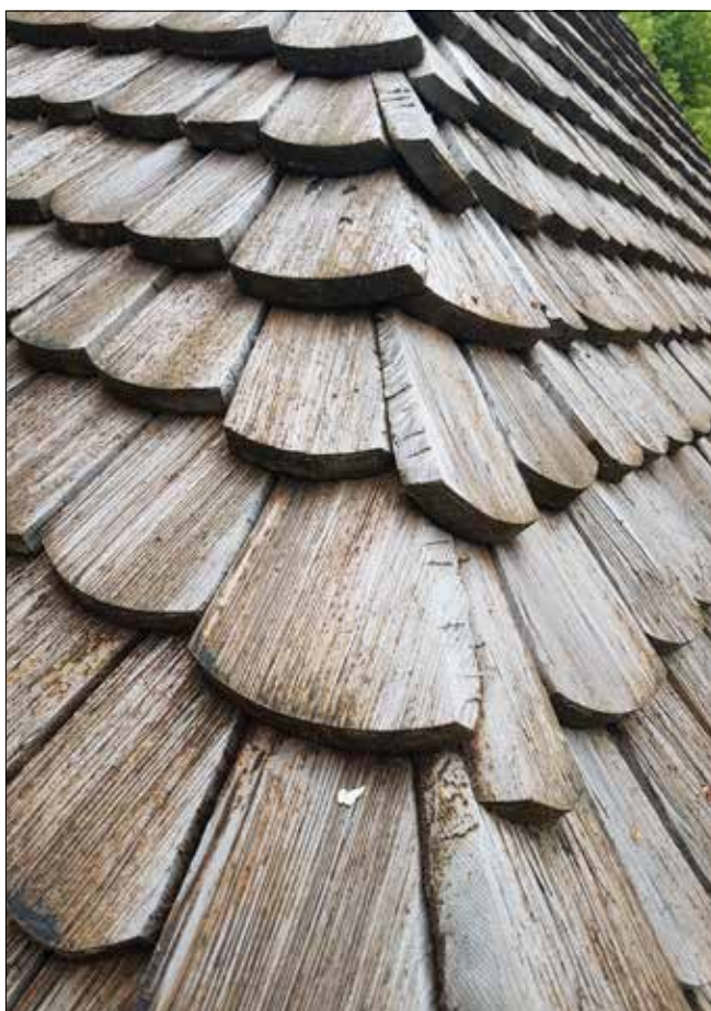
Åkers gravkapell. Spåntäckning på gravkapellet, sydvästra hörnet.
