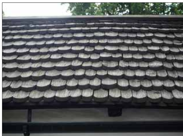
Vallby kyrka. Stigluckans norra takfall.
