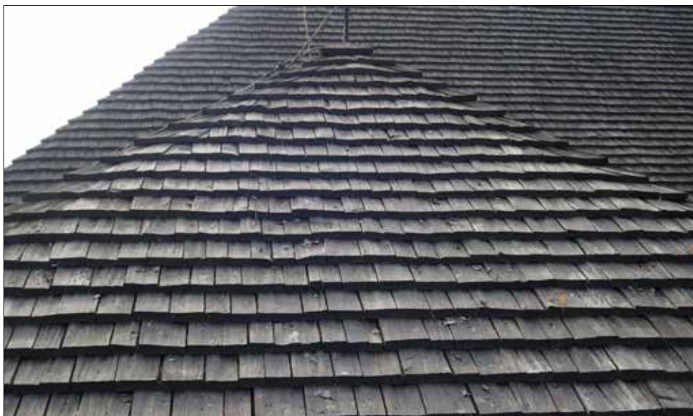
Tunabergs kyrka. Sakristians norra takfall.
