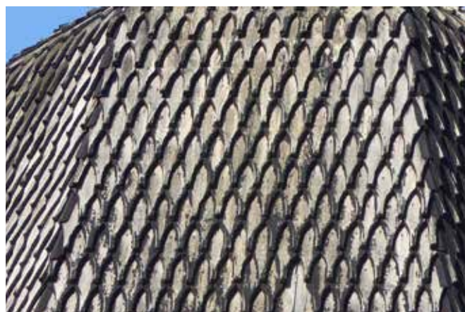
Klockhuv med plåttäckningar i takfallens brytningar. Foto: Lisa Skanser.
