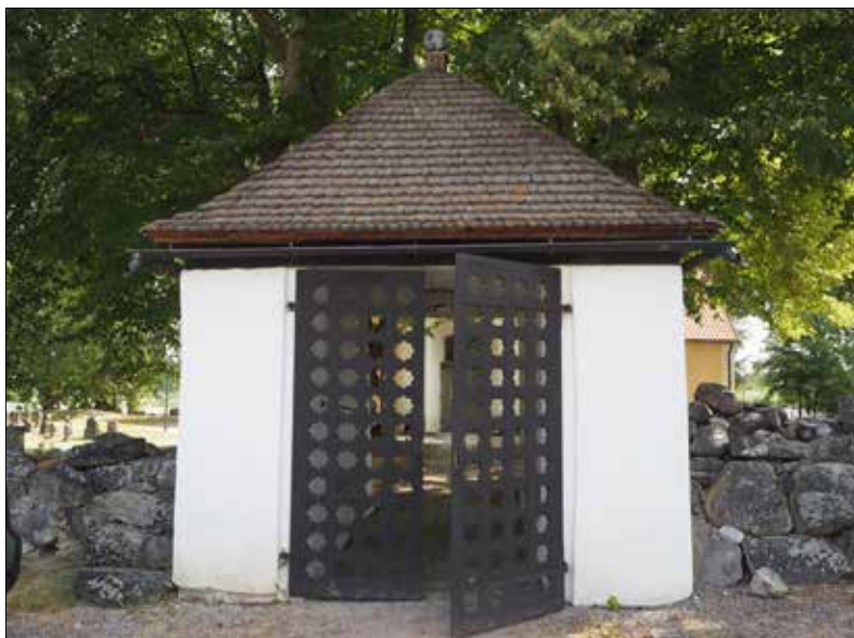
Runtuna stigluckor. Västra stigluckan.
