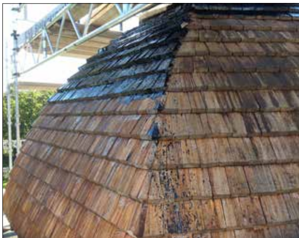
Blacksta klockstapel. Tjärning av huv pågår. Tjärblandningen är gjord utifrån ett recept från 1790-talet.
