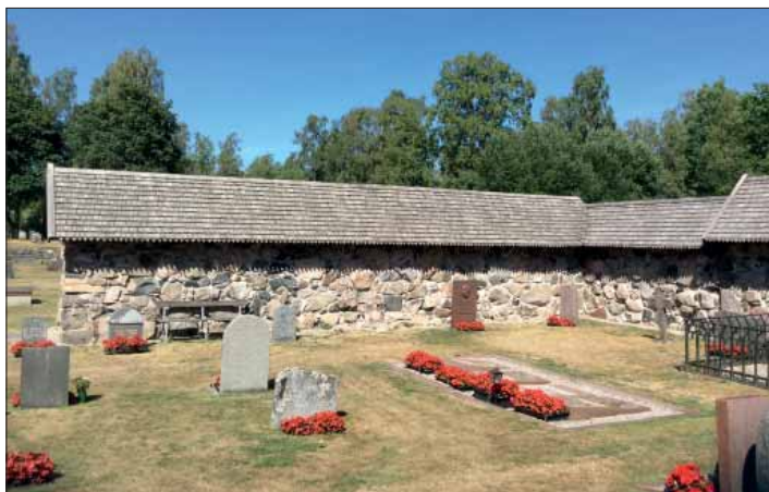
Ramundeboda klosteruin. Ett spåntäckt sadeltak skyddar kyrkogårdsmuren. Spåntäckningen utgörs av raka spån och tillkom omkring år 2013.
