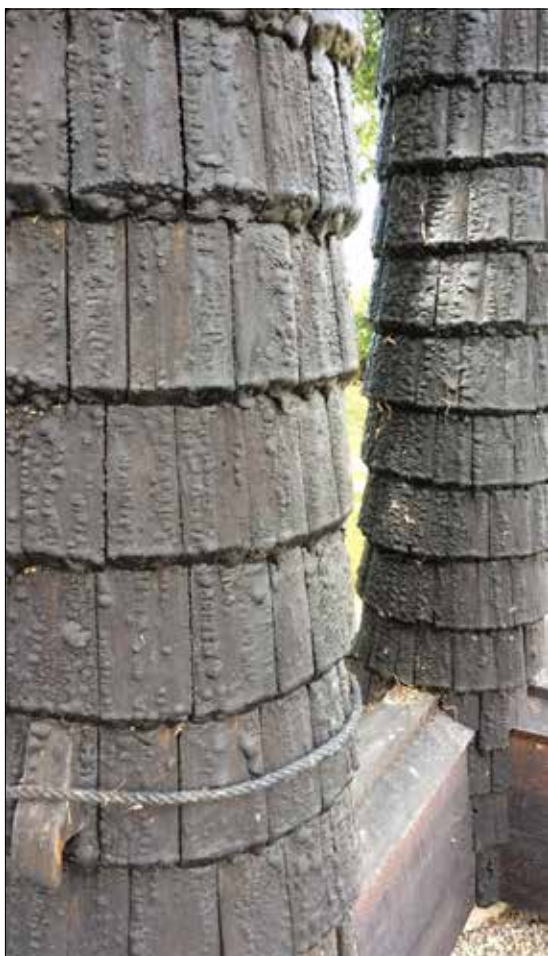
Vrena klockstapel. Hjärtstolparnas spåntäckning.
