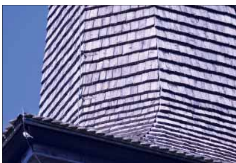
Hovsta kyrka. Torntaket är täckt med raka spån som nedtill kantas av en rad spetsspån.
