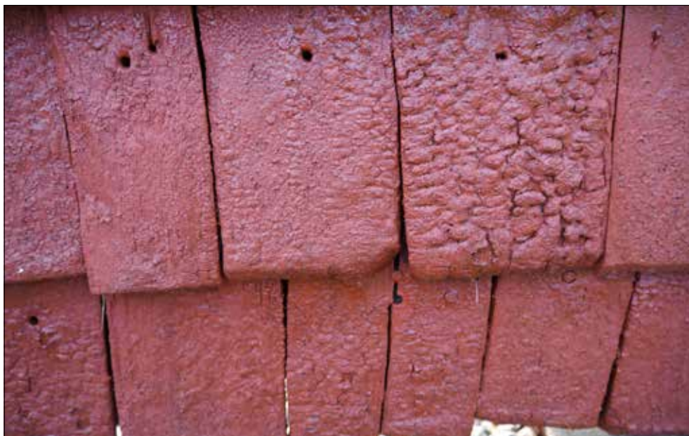
Mörkö klockstapel. Syll med äldre spån som har bål från tidigare infästningar. Notera spånens varierande mått.
