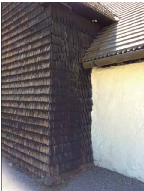
Tångeråsa kyrka. Koret sett från nordöst. Spånen är raka med ett tjockt tjärskikt som delvis är borta.
