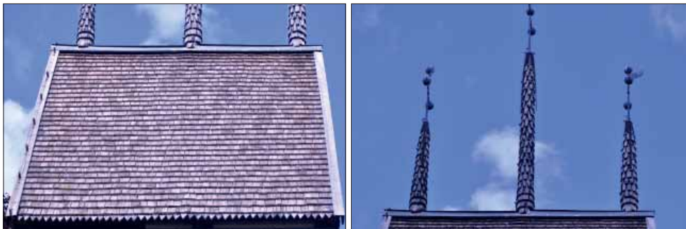
Kvistbro klockstapel. Klockstapelns södra takfall (t.v.). Klockstapelns kröns av tre smala spiror, upptill klädda med näbbspån och nedtill med tre rader raka spån (t.h.).
