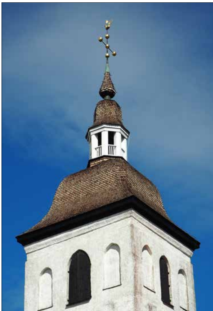
Vårdinge kyrka. Tornet med spånklädd huv från sydöst.
