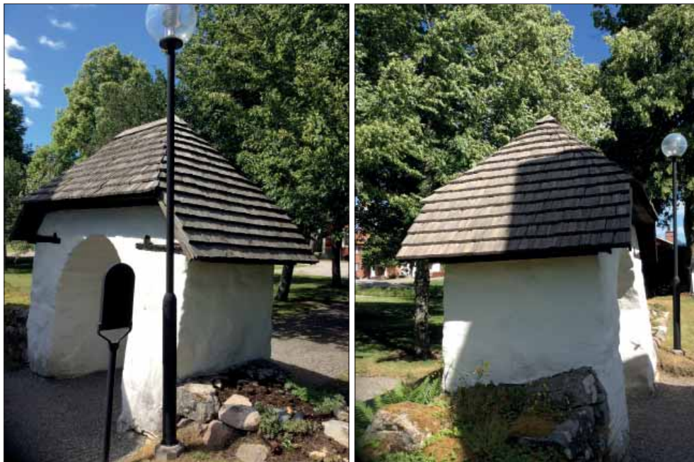
Täby stiglucka. Stigluckan uppfördes på 1760-talet med valmat spåntäckt sadeltak. Spånen är raka med kluven ovansida.
