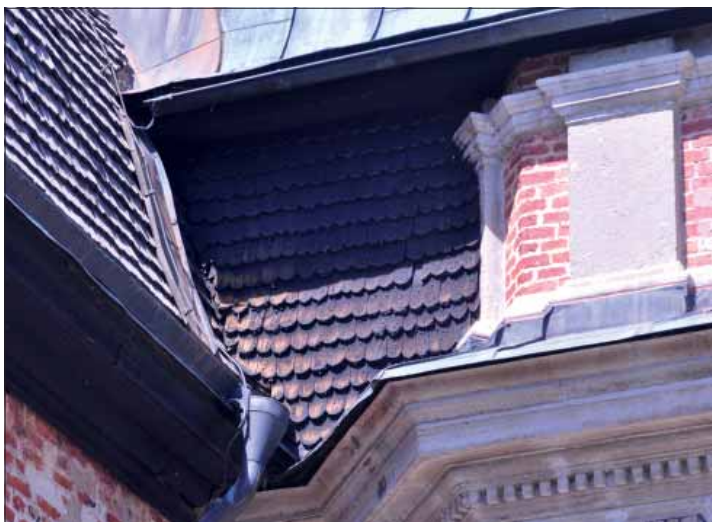
Askersunds landskyrka. Detalj av koret från söder. På koret finns de få beva- rade äldre spånen.
