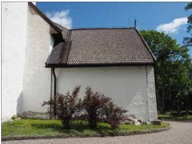
Vallby kyrka. Vapenhusets västra takfall med näbbformade spån.
