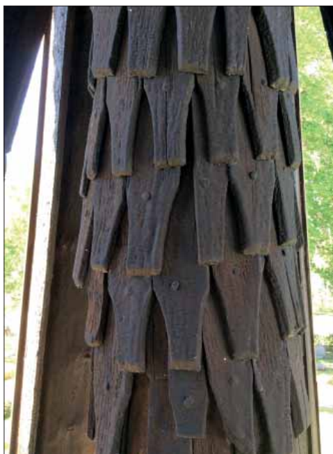
Kräcklinge klockstapel. Hjärtstockarnas spån har synlig infästning och mycket tjocka tjärskikt (t.v.). Ett löst näbbspån med rits på baksidan för näbb, hål för infästning och spår av tjocka tjärager (t.h.).
