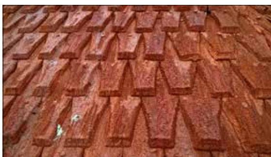
Figur 51. Närbild på den spåntyp som ligger på takfall åt nordöst. Foto Lars Jönnes.
