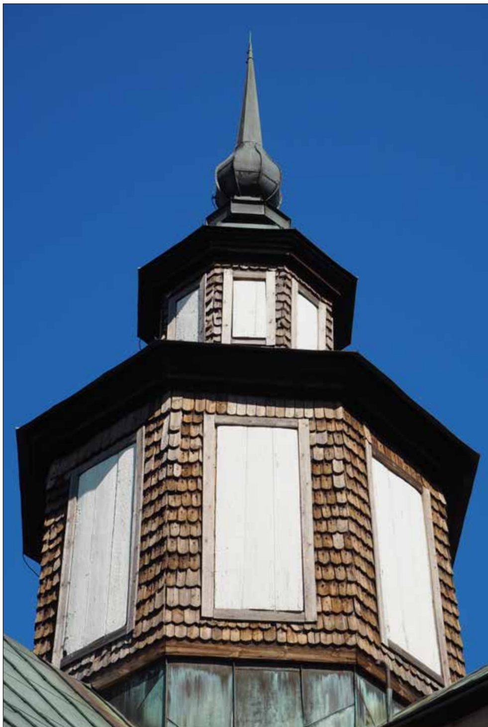
Ludgo kyrka. Tornets spånklädda fasad från sydöst. Två olika generationer av spån finns, de äldre med synlig spikning och de yngre med dold infästning.
