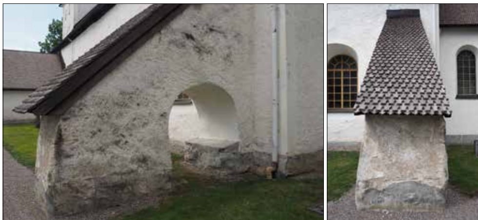
Vansö kyrka. En av de spåntäckta strävpelarna.
