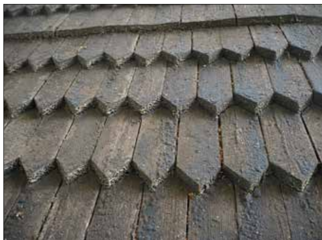
Tuna kyrka. Spån på bårhusets västra takfall.
