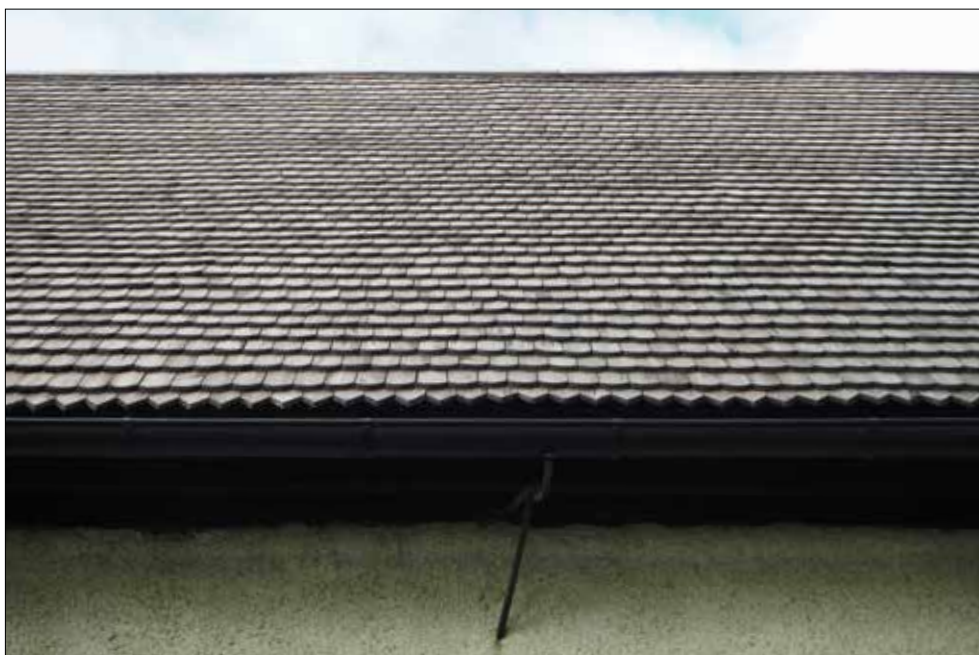
Häradskyrka. Späntäckning på vapenhusets östra takfall.
