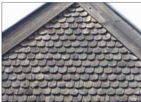
Halla klockstapel. Fasadspån på huv.
