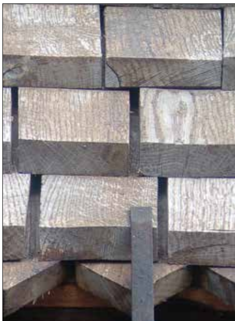
Ripsa kyrka. Spån på långhusets södra takfall.
