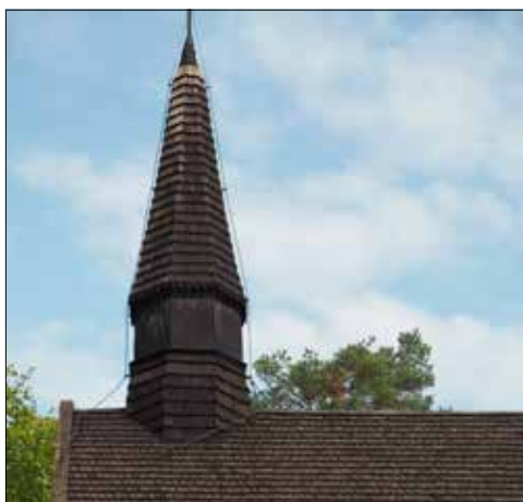
Tunabergs kyrka. Den spånklädda större takryttaren på kyrkans långhus.
