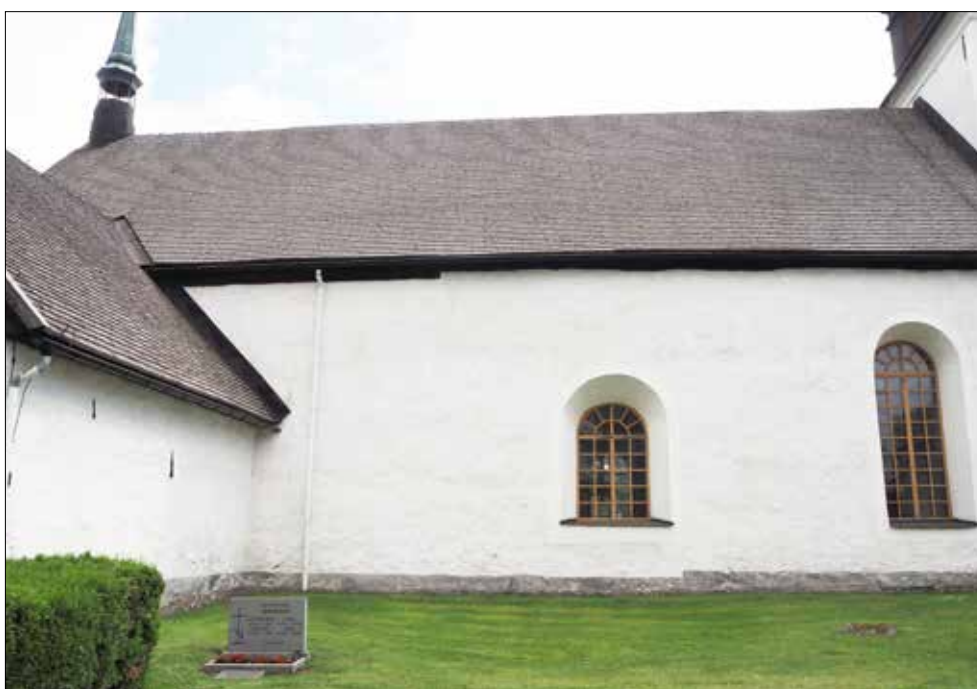
Vansö kyrka. Långhusets norra takfall.
