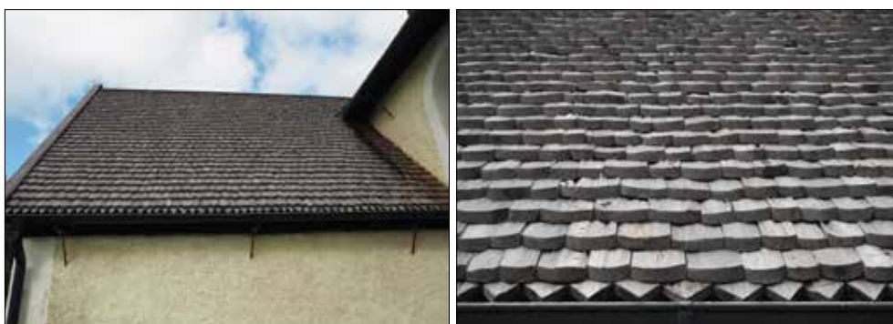
Häradskyrka. Kyrkan med späntäckta tak sedd från nordväst (t.v.). Norra korsarmens östra takfall (t.h.).
