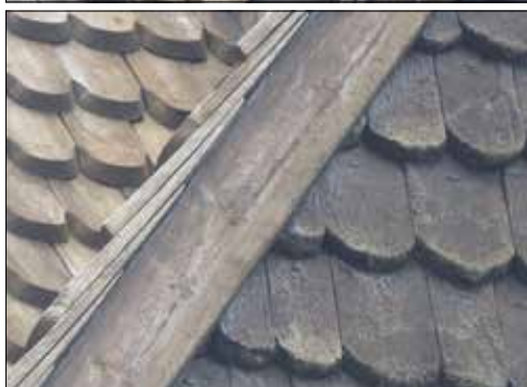
Lilla Malma klockstapel. Klockstapelns tak och spira. Detaljer som visar äldre spån på klockstapelns gavel och yngre takspån. Notera den synliga infästningen och lagret med tjära på fasadspånen.
