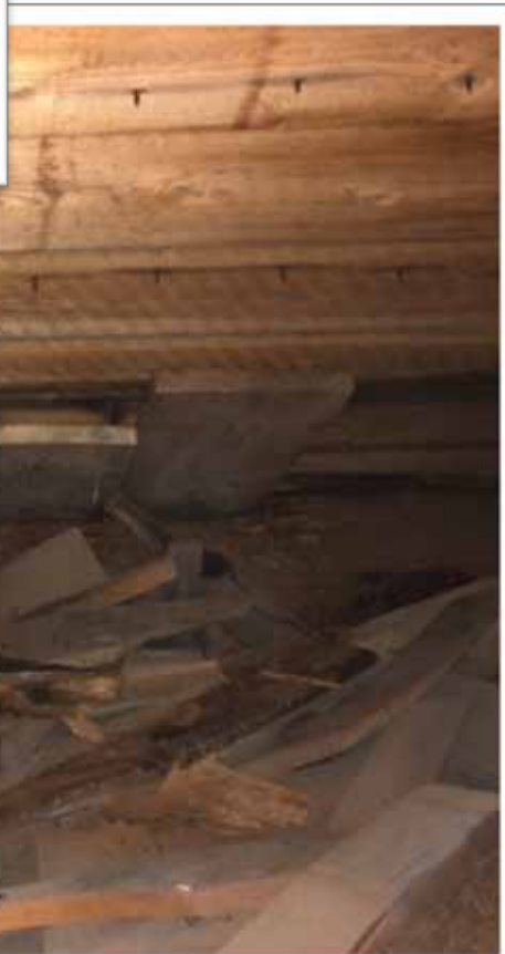
Rötskadad syll på stenfoten, sydöstra sidan. Undertaket har en tidigare lagning.
