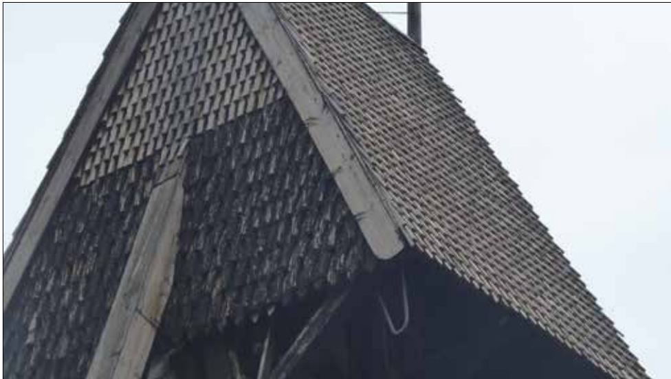
Helgesta klockstapel. På den ena gaveln finns äldre spån nedtill och nyare upptill.
