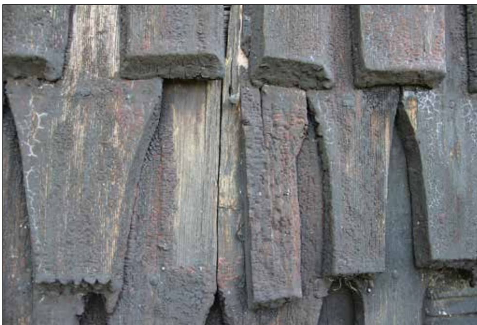
Figur 38. Av Sura gamla kyrka i Västerås stift återstår sakristian som numer utgör kapell och minnesplats. Stavsåpanen på västra fasaden uppskattats vara från 1600-talet. Spår efter röda pigment finns i underliggande tjärskikt. Foto Lisa Skanser.
