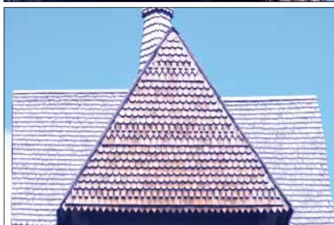
Kräcklinge klockstapel. Takspånen har raka spån med en rad spetspån som avslutning nedtill. Huvens fasader har mönsterlagda spåntäckningar i våder med spån som är rundade, näbbformade, spetsiga och raka.
