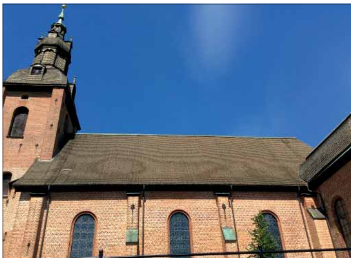
Askersunds landskyrka. Långhusets södra takfall.
