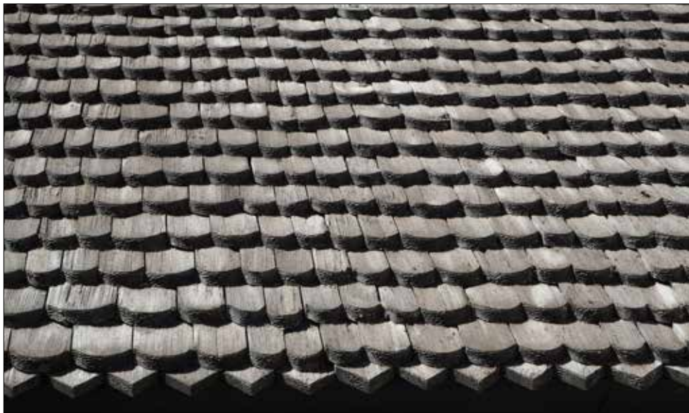
Grödinge kyrka. Vapenhusets östra takfall.
