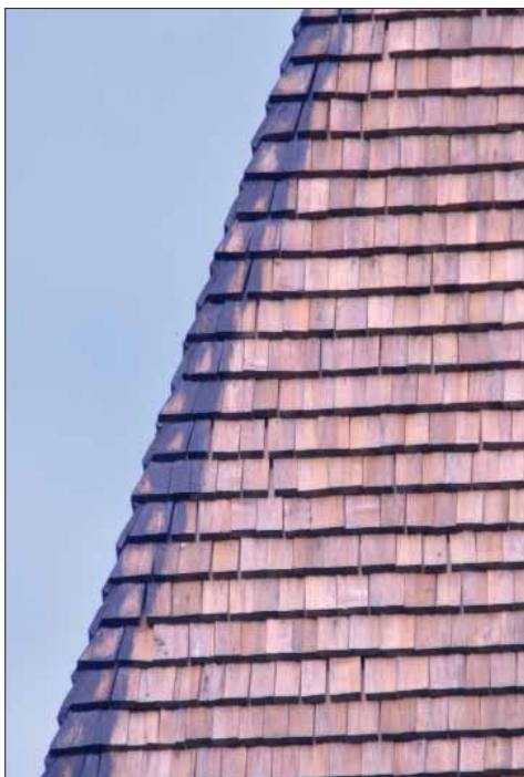
Hardemo kyrka. Vid inventeringstillfället i juni 2018 återfanns tjärrester endast vid takfallens brytningar, trots att spånen var nylagda och nytjärade.
