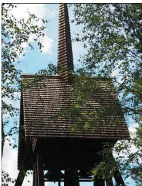
Söby begravningsplats. Spåntäckning på klockstapelns ena takfall.
