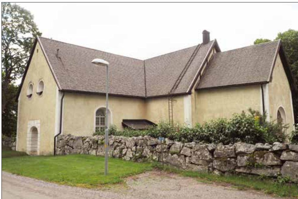
Häradskyrka. Vapenhusets östra takfall.
