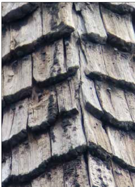
Ripsa kyrka. Spån på tornryttaren, åt söder.
