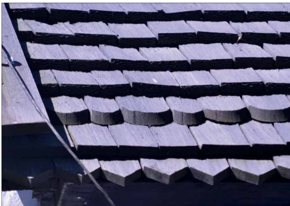
Hidinge gamla kyrka. Detalj av långhusets spåntak sedd från söder. Spånen har rak kant med mönsterläggning nedtill med spetsiga respektive runda spån på rad ett och tre.
