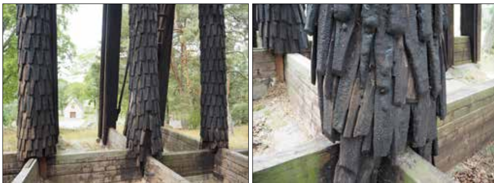
Björnlunda klockstapel. De tre hjärtstockarna täckta med näbbspån (t.v). Notera virrvarret av spån nertill på en av hjärtstockarna (t.b.).
