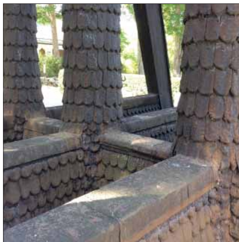
Almby klockstapel. Stora partier med spån av hög ålder täcker syllan.
