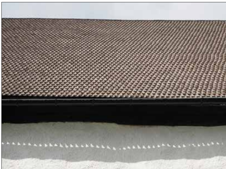
Vansö kyrka. Långhusets södra takfall.
