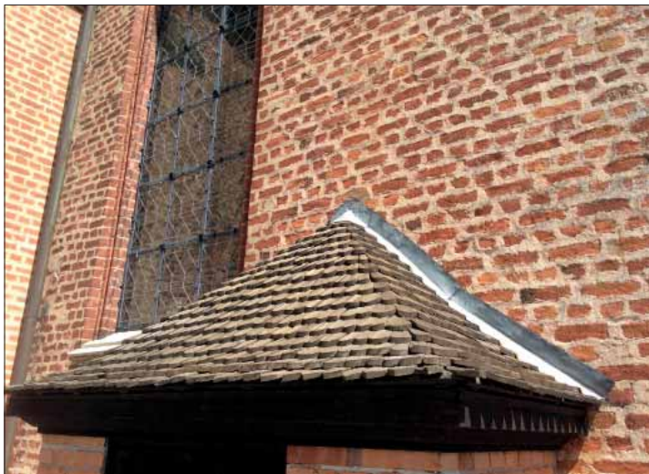
Askersunds landskyrka. Tak över källarnedgången i södra korsarmen.
