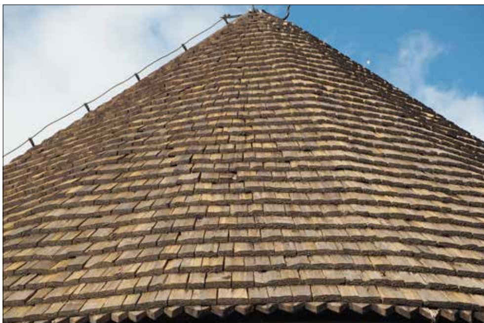
Dillnäs kyrka. Spåntak över absiden.
