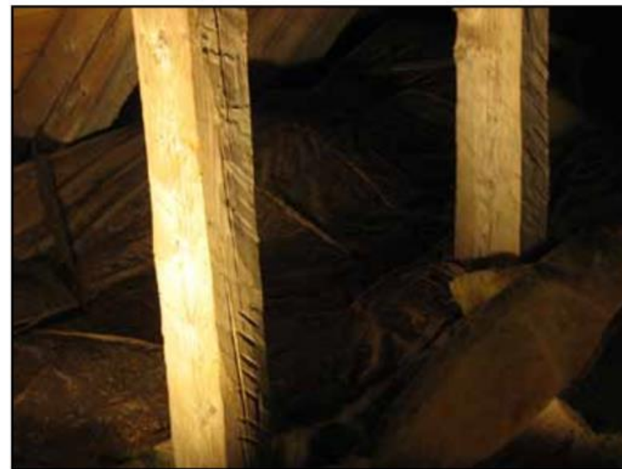
Timmermärkning, till vänster i form av hack på en av sparrarna, till höger i form av streck på två av stödbenen i norr.
