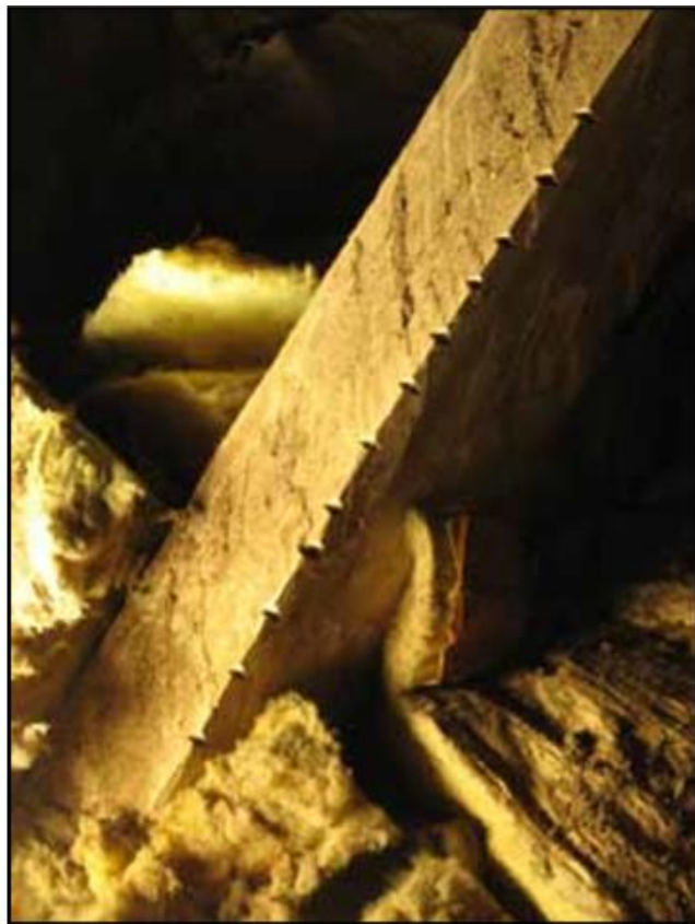
Timmermärkning, till vänster i form av hack på en av sparrarna, till höger i form av streck på två av stödbenen i norr.
