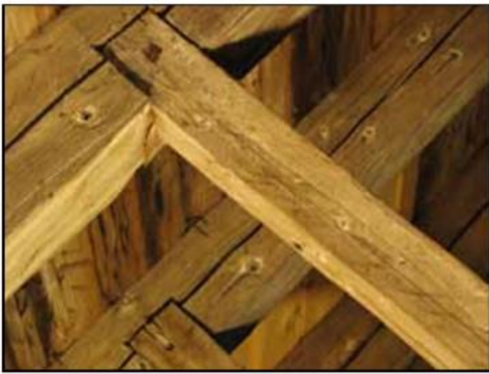
Hopfogningar med bladning och spik, ovan mellan högben och sparrar, till höger mellan de korsande sparrarna.
