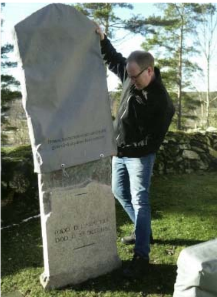
Exempel på plåtavtäckningar formade efter stenarnas ovankant
