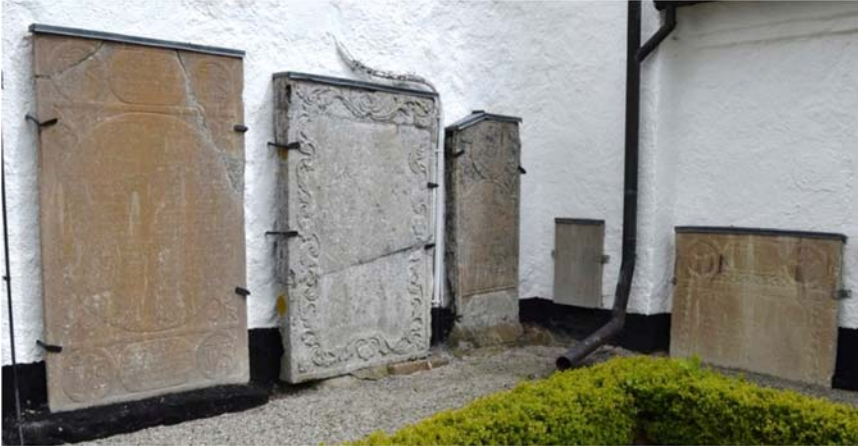
Exempel på kalkstenshällar med lagade sprickor, samt uppsatta i mindre regnutsatt läge vid kyrkvägg och försedda med avtäckning av plåt.
