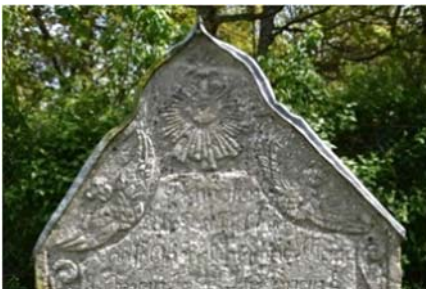
Exempel på plåtavtäckningar formade efter stenarnas ovankant
