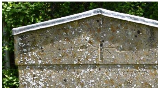
Exempel på plåtavtäckningar formade efter stenarnas ovankant
