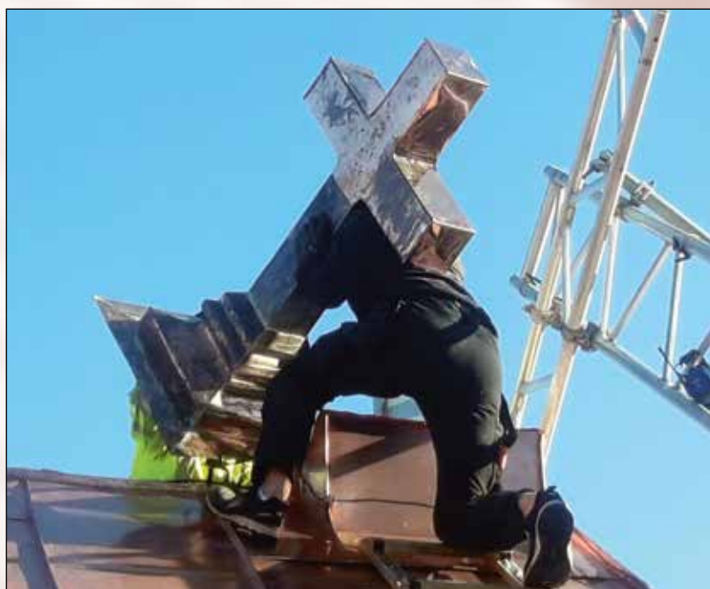
Nytt kors på kyrktaket ovan koret monteras.
