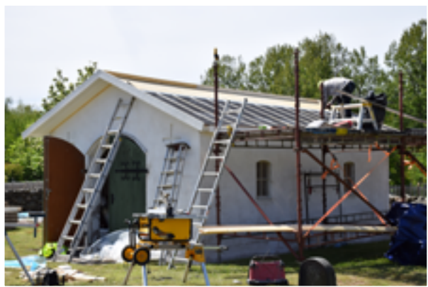
Här är man i full gång med att byta det gamla trätaket som sedan ska prydas med nya tegelpannor.
