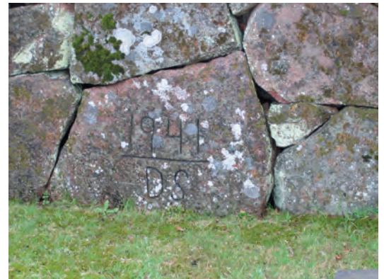
Märkningen 1941 DS anger byggnadsår för denna norra del av muren samt stenvärdens initialer. Foto J. Haas.
