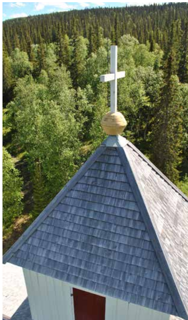
Fatmomakke/Faepmie kyrka sedd från skyliften vid inspektion.
