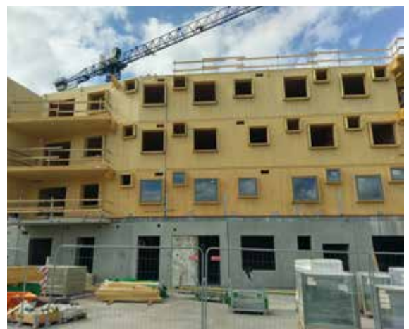
Ökat byggande i trä. Här ett flervåningshus i Växjö. Byggt i block av korslimmade massiva träelement, CLT.
