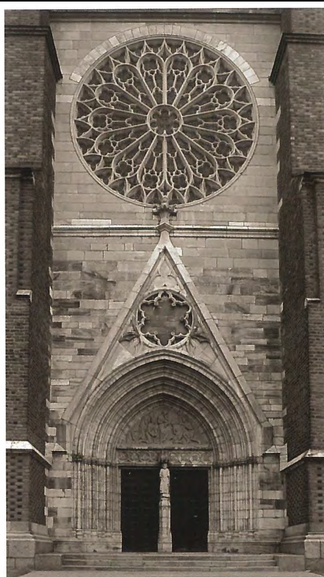
Uppsala domkyrkas nordportal med höggotiskt rosett-fönster besläktat med Notre Dame i Paris, infogat i ett fasadparti av kalksten.
