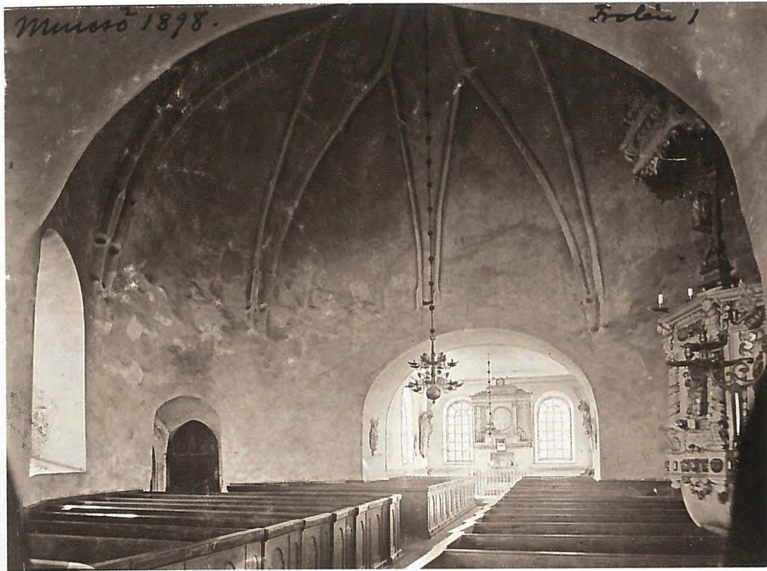
Det stora runda rummet i Munsö kyrka med en låg, rundad absid. Det ståtliga stjärnvalvet slogs på 1470-talet samtidigt som rektangulära utbyggnader för sakristia och vapenhus byggdes till. Tornet rymde ursprungligen flera våningar med olika funktioner. Fotografi 1898 av H. Frölin.
