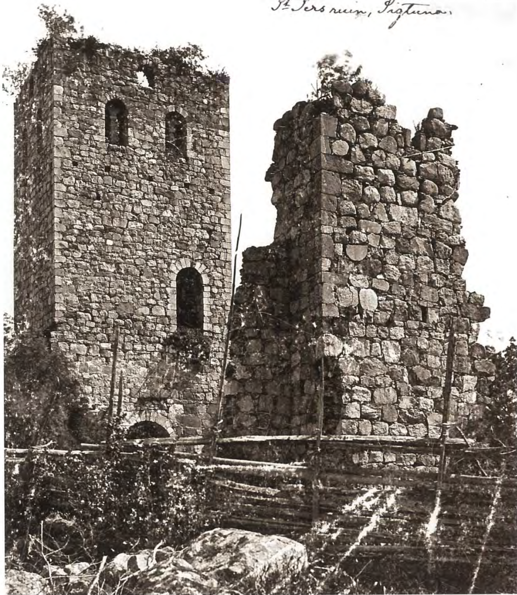
Ruinen av Sankt Per i Sigtuna, uppförd vid början av 1100-talet under Inge den äldres tid. I förgrunden det senare uppförda västtornet med kungsläktare in mot långhuset. Fotografi omkring 1890 före iståndsättandet 1895.
