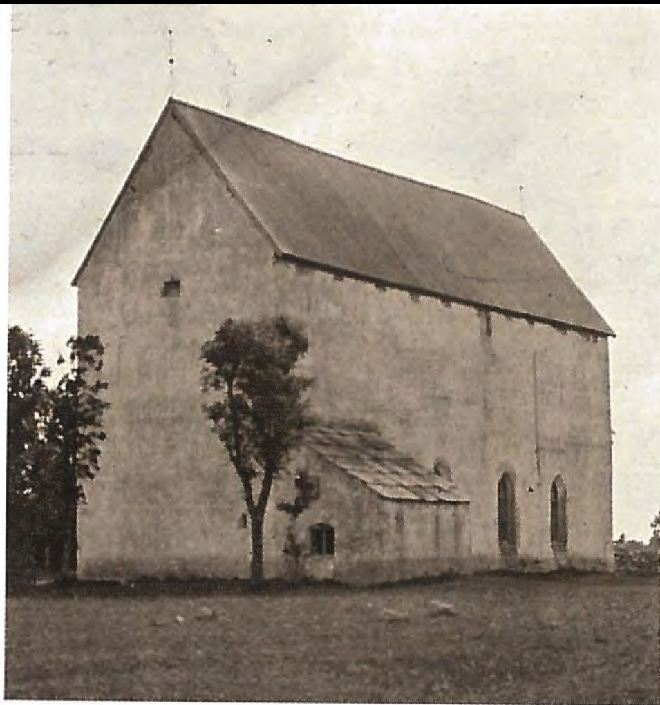
Den romanska försvarskyrkan Källa på Ölands norra udde, uppförd omkring 1200 med västtorn, vars övre delar är rivna. Kyrkan rymde två våningar ovanför långhusvalven, härbärke och skytteloft. Fotografi omkring 1900.
