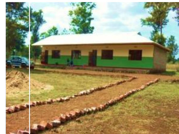
Neema Montessori Primary School Första byggnaden 2015, Moshi Tanzania
