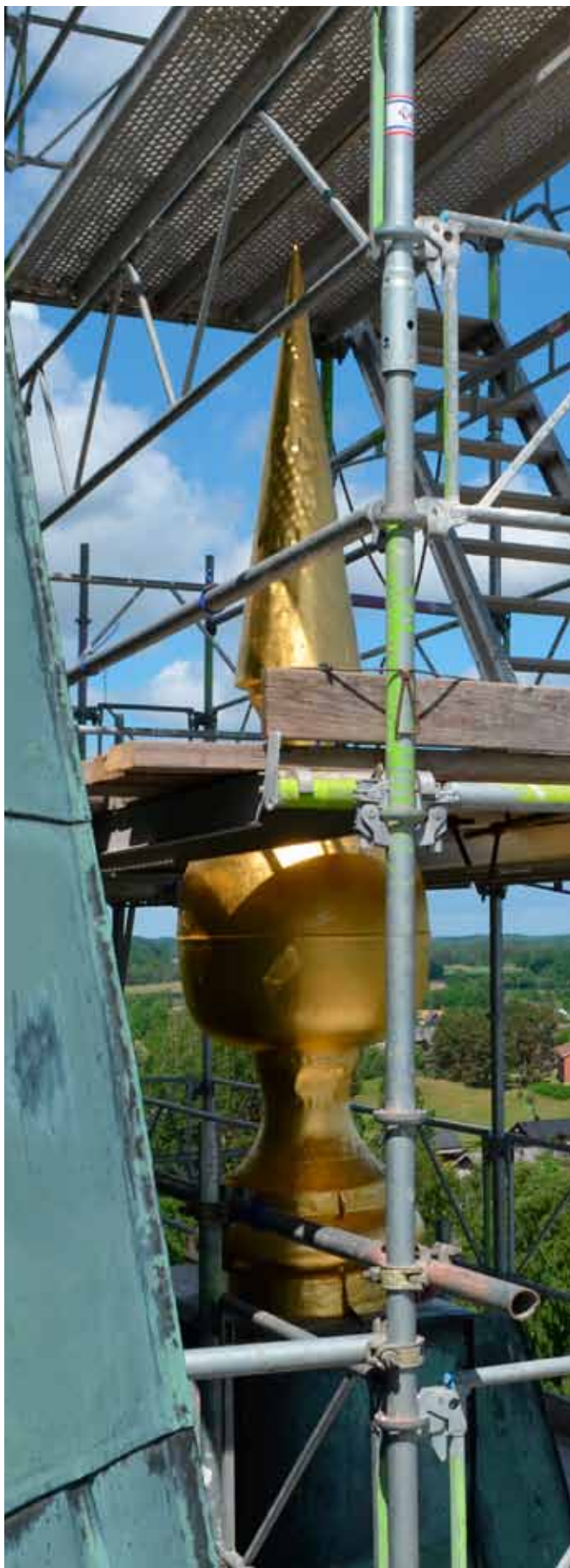
Renoveringen av Näsums kyrka beräknas pågå fram till oktober månad
