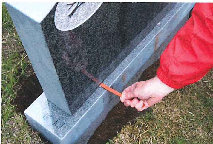
Figur 8. Kontroll av antalet dubbar med bågfilmsblad
