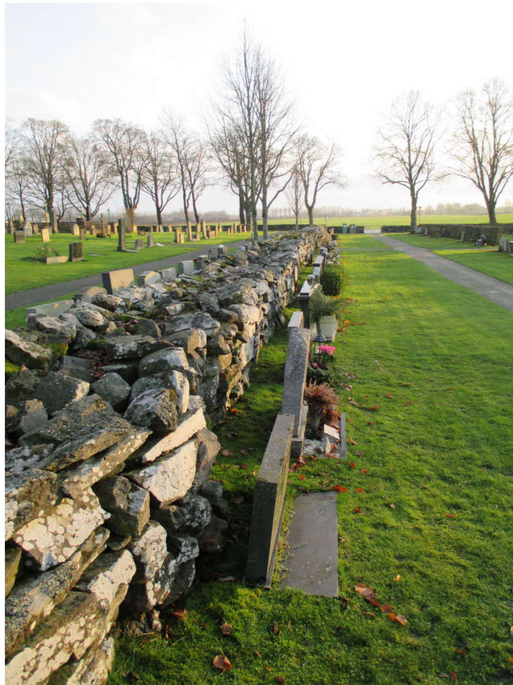
Ovan: Felaktig fyllning i en nyligen renoverad mur. Runda sten och jord får inte förkomma som fyllnad i en kallmurad stenmur. Höger: En gammal mur kan med tiden ta skada av de jord- och gravarbeten som utförts i samband med att kyrkogården utvidgats.
