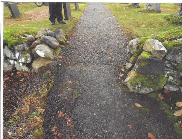
5. Muröppning i norr.
