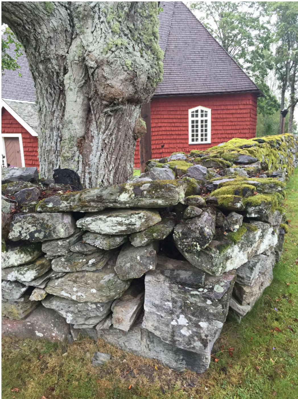
Vänster: Ett gammalt träd placerat innanför murhörnet medför att stenar glider ur läge. Ovan: Ett dike som inte rensas gör att vattnet blir stående och muren rör på sig vid tillfrysning och avtining.
