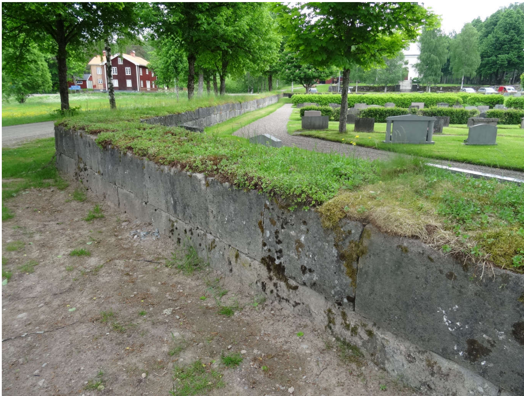
Renoverad mursträcka. Det övre stenlagret kalvade tidigare utår. Renoveringsarbetet utfört under 2016. Holmedals kyrkogård i Nordmarkens
