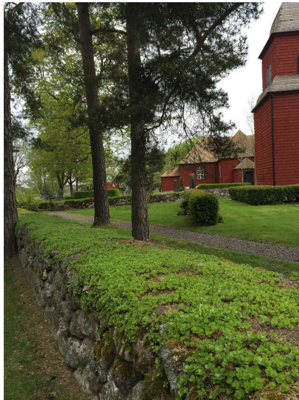
Sedumväxter fungerar bra som "avtäckare". De kan hindra att muren med tiden fylls på med jord, nedfallande löv och grenar.
