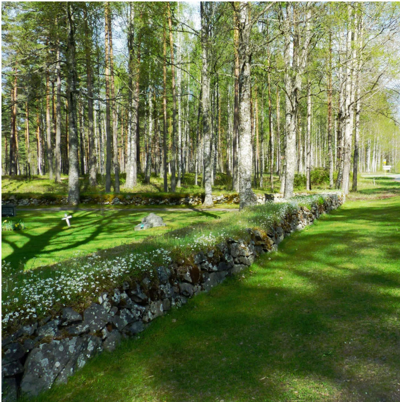
Muren i Nordmark står i vårpraktsblom, ett och ett halvt år efter att projektmedarbetarna var där och renoverade muren som en del av utbildningen.
