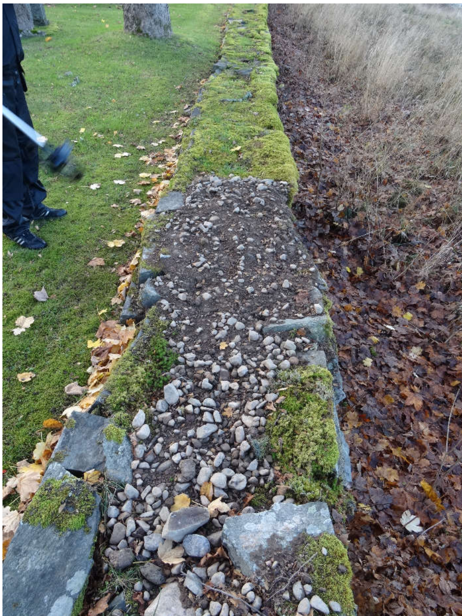
Ovan: Felaktig fyllning i en nyligen renoverad mur. Runda sten och jord får inte förkomma som fyllnad i en kallmurad stenmur. Höger: En gammal mur kan med tiden ta skada av de jord- och gravarbeten som utförts i samband med att kyrkogården utvidgats.
