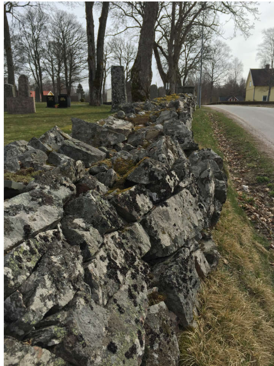
Vänster: Ett gammalt träd placerat innanför murhörnet medför att stenar glider ur läge. Ovan: Ett dike som inte rensas gör att vattnet blir stående och muren rör på sig vid tillfrysning och avtining.
