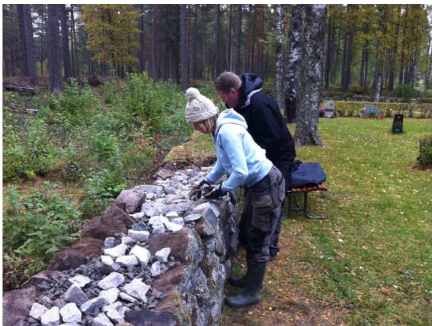
Överst: Projektet studerar en mur som saknar fyllnadssten, Kroppa kyrka i Filipstads församling. Nederst: Påfyllning med fyllnadssten i muren vid Nordmarks kyrka, Filipstads församling.
