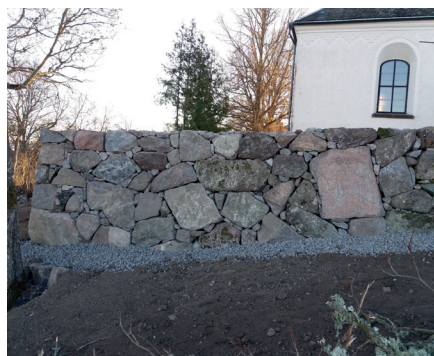
Bild på muren efter restaurering. Foto: Ulf Jansson
