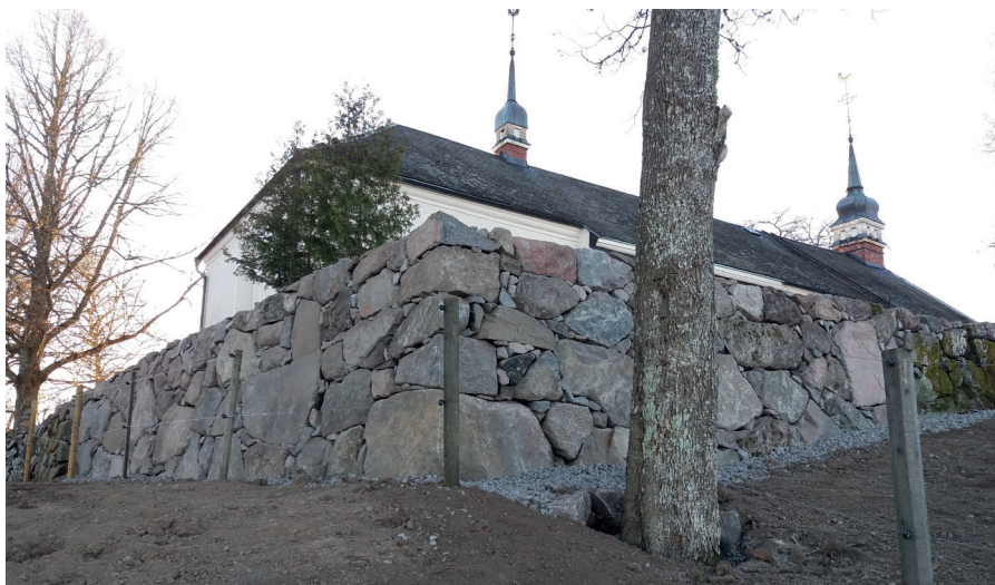
Bild på muren efter restaurering. Foto: Ulf Jansson
