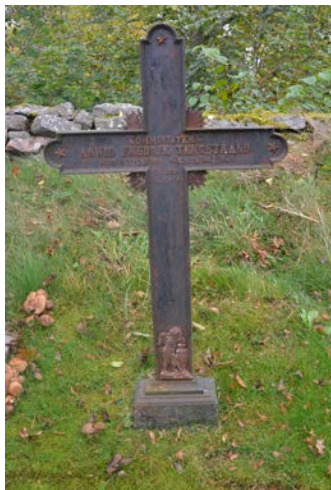
Ovan: I 8 är rostangripen. T b: INR 8 har ett rosthål längst ned på korsstammen.
