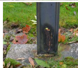
Ovan: I 8 är rostangripen. T b: INR 8 har ett rosthål längst ned på korsstammen.
