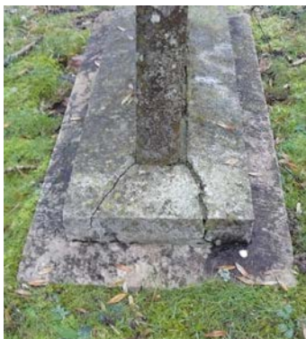
G 5 ovan och t v har sprickor i sockeln. Sprickor förekommer också på tre av gravvårdarna i Dicanderska gravanläggningen, bilder nedan.
