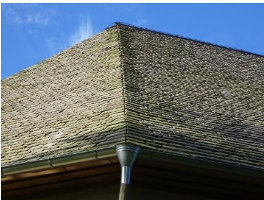
Ihophuggen skiffersnednock på By kyrka. Vid renovering kompletterades taket med takavvattningssystem i galvat utförande med runda vattkupor skarpa krökar enligt traditionellt utförande. Om några år ska systemet målas in i bakomliggande kulör.
