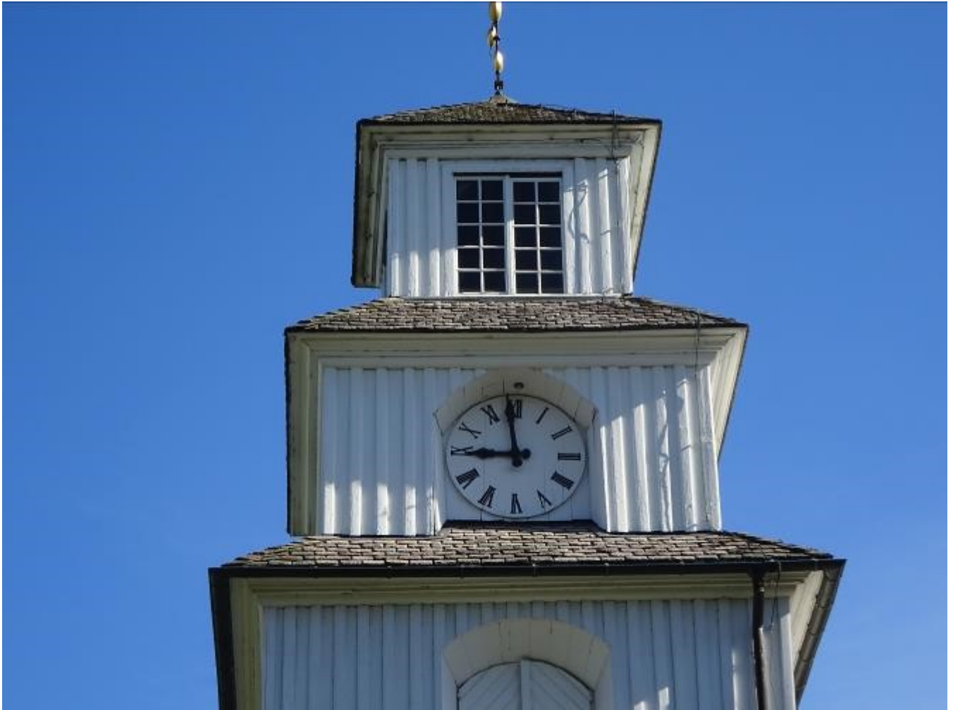
Ovan. Töcksmarks kyrka. Tornet har en avtrappning i tre språng där varje takkrans är täckt med rakhuggen glavaskiffer. Nedan. Ånimskogs kyrka med diagonallagt glavaskiffer.
