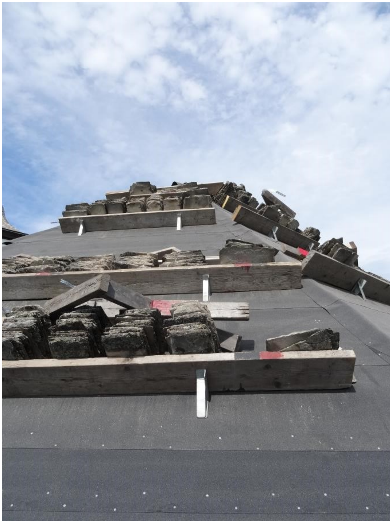
Vid en skiffertaksrenovering bygger skifferläggarna plattformar av trä för förvaring av skiffern. Plattformarna monteras efter hand som skiffern plockas ned och underlagspappen monterats.
