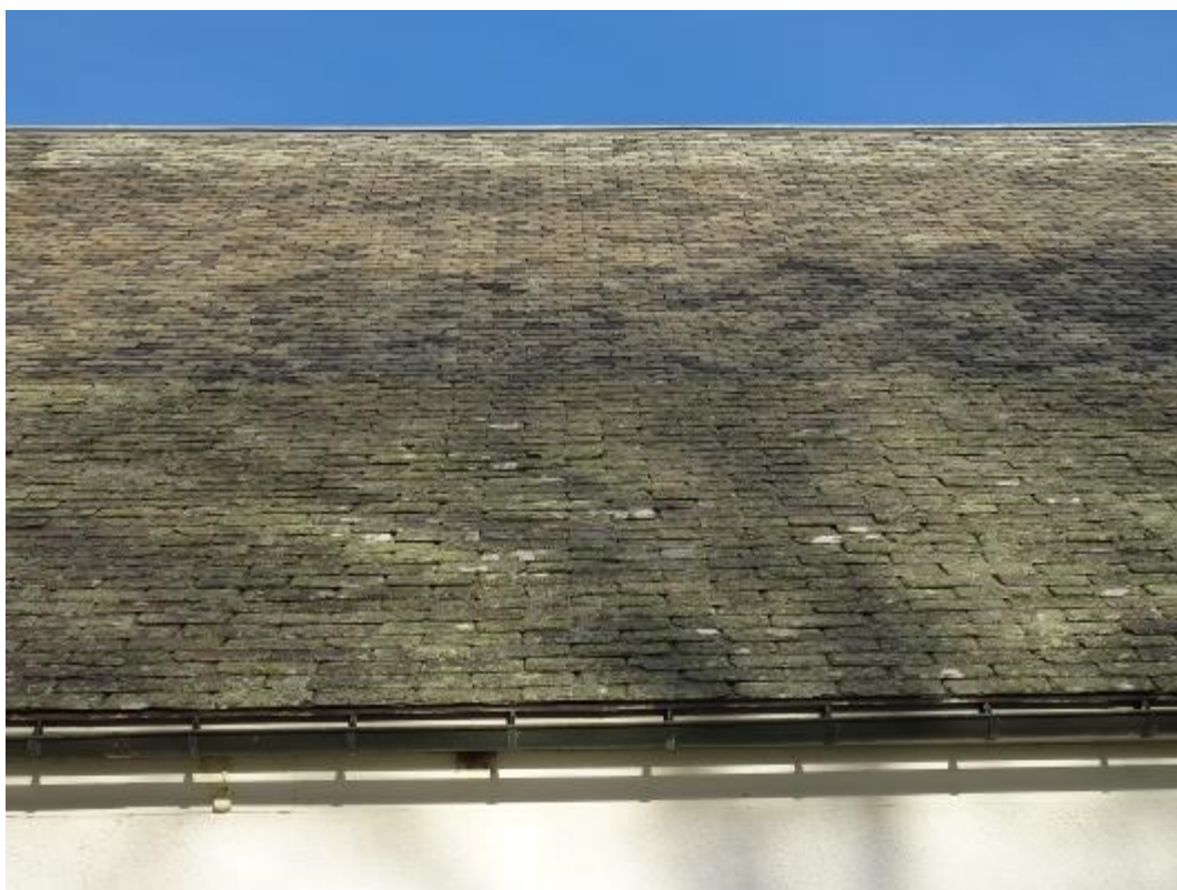
Ett takfall med blandning av såväl stensort som storlek. Från takfoten och uppåt ligger sten från Glava i storlek 13x16 tum, sedan kommer ett parti med sten från Dalsland i storlek 13x8 och överst sten från Grythyttan i storlek 13x8. Det är inga problem med tätheten eftersom man bytt till halvstora plattor, men lösningen påverkar i högsta grad utseendet.
