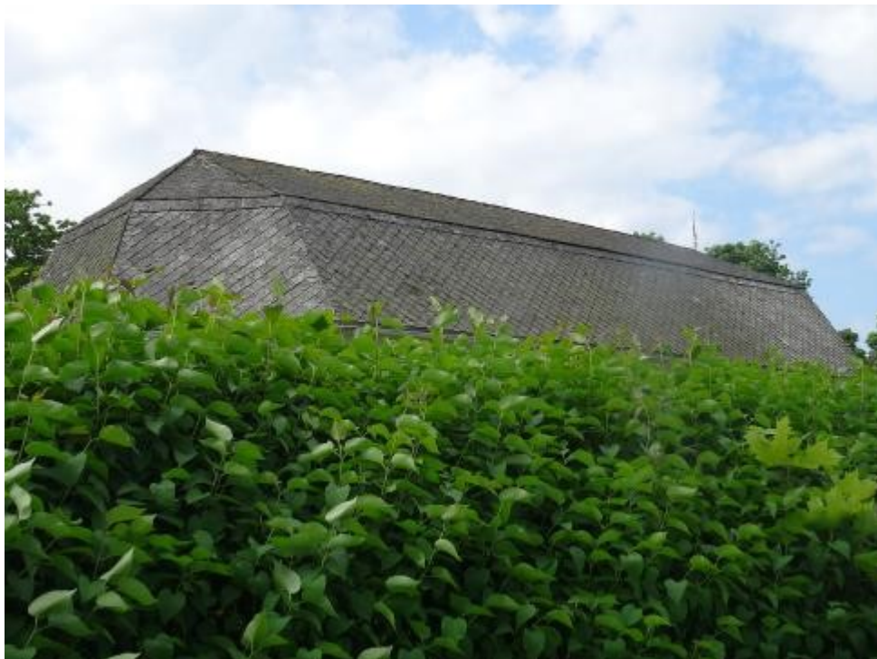
Ovan. Töcksmarks kyrka. Tornet har en avtrappning i tre språng där varje takkrans är täckt med rakhuggen glavaskiffer. Nedan. Ånimskogs kyrka med diagonallagt glavaskiffer.
