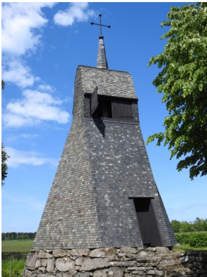
Ovan vänster. Den skifferklädda klockstapeln vid Järns kyrka. Överst höger. Skifferklädda vindskivor på bårhuset vid Järbo kyrka. Skiffer av spansk typ. Ovan höger. Vackert plåtarbete på vattkupa vid överskjutande skiffersnednock på Järns kyrka. Nedan. Skifferklädda grindstolpar vid Gunnarsnäs kyrka.
