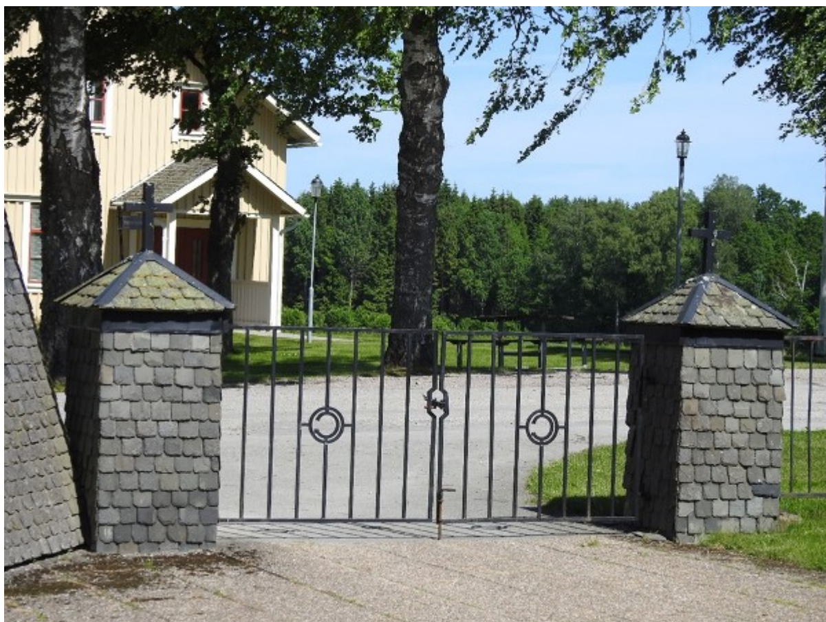
Ovan vänster. Den skifferklädda klockstapeln vid Järns kyrka. Överst höger. Skifferklädda vindskivor på bårhuset vid Järbo kyrka. Skiffer av spansk typ. Ovan höger. Vackert plåtarbete på vattkupa vid överskjutande skiffersnednock på Järns kyrka. Nedan. Skifferklädda grindstolpar vid Gunnarsnäs kyrka.
