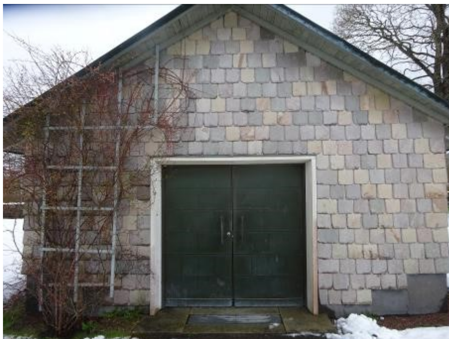
Överst. Ånimsnäs kyrkomiljö. Kyrkan har i huvudsak skiffer i diagonalläggning. Även grindstolpar och klockstapeln har skiffertaktäckning. Miljön i sin helhet bildar en värdefull skiffertaksmiljö. Nederst. Bårhuset i Storfors. Fasaderna är täckta med skiffer från Glava.
