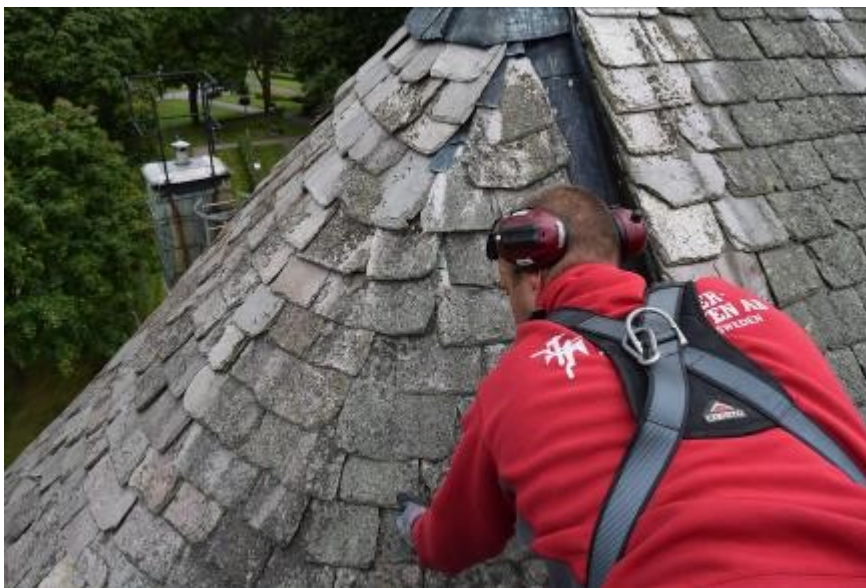
Skifferhantverkare Emil Gustafsson undersöker täck, skifferstorlek och skifferplattornas montage på Gunnarskogs kyrka.
