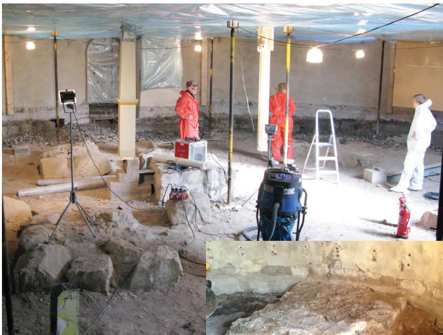
Rivningen av golvet med högaltaret i koret
