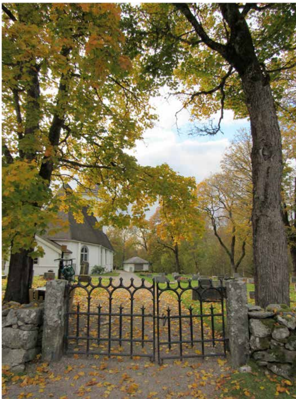
En av kyrkogårdens entréer med gjutjärnsgrind och huggna grindstolpar av granit.
