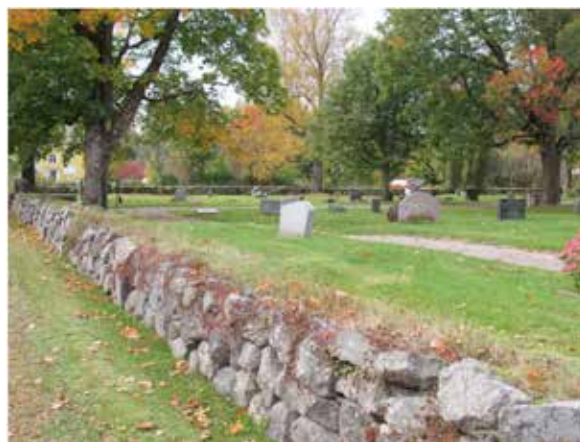
Kyrkogårdsmuren är kallmurad av fältsten. Bitvis fungerar den som stödmur vilket syns i den högra bilden.
