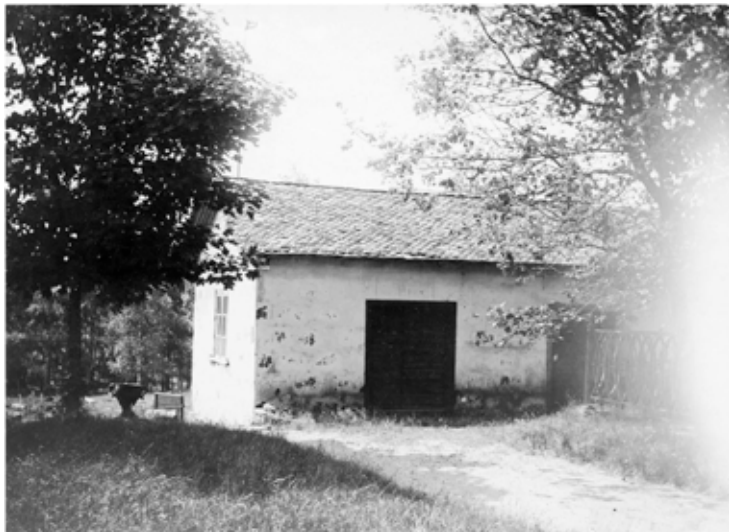
Ekonomibyggnaden år 1912 innan ombyggnad. Uppe på taket bland löven skimtar väderflöjeln från år 1649 som satt på den gamla kyrkogårdsporten. Till höger i bild syns att staketet från början löpte runt hela familjen Ekelunds gravplats. Vänster om ekonomibyggnaden syns en gjutjärnsurna i gräset. Kulturmiljöbild, Fotograf: Helge Kjellin
