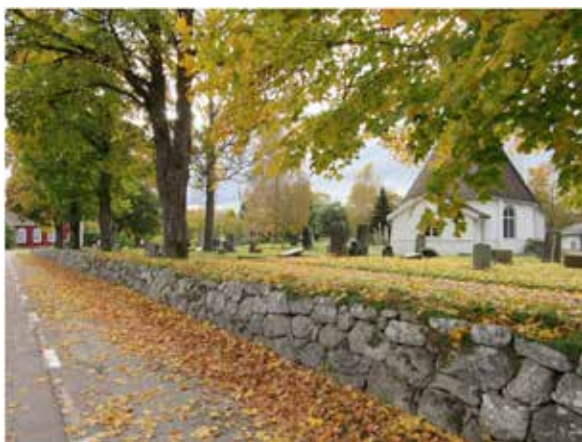
Kyrkogårdsmuren är kallmurad av fältsten. Bitvis fungerar den som stödmur vilket syns i den högra bilden.
