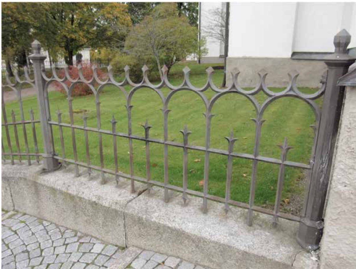
Gjutjärnsstaketet som omgärdar större delen av kyrkogården är från år 1879 och det utfördes då utav Aktie Bolaget Karlstads Mekaniska Werkstad.
