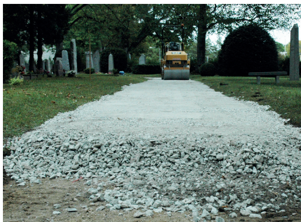
Bärlager på Södra Kyrkogården under komprimering.
