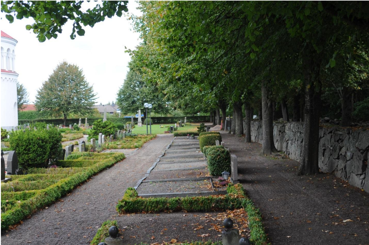
Kyrkogården omges av en trädram av lindar med olika ålder. Här ger de relativt unga träden en tät grönska mot i gränsen mot öster. Träden är planterade alltför nära kyrkogårdsmuren och kommer på sikt att få rötter som skadar stenmurverket.
