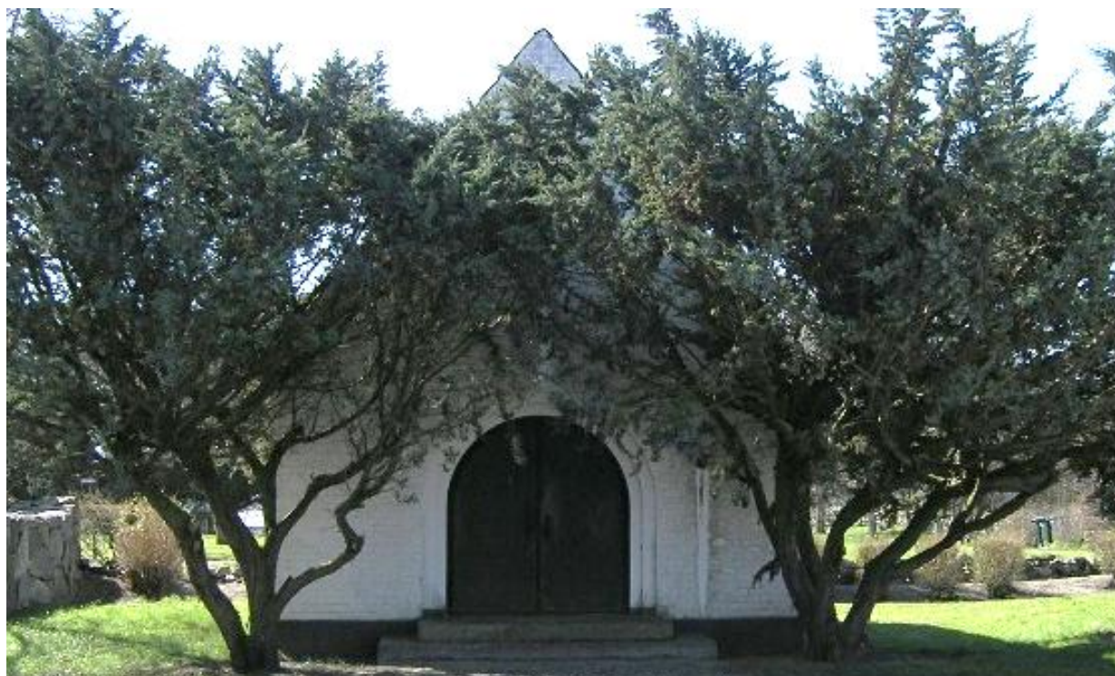
Bårhusets gavel mot norr har en välvd kopparskodd port och en trappa av blocksteg i granit.
