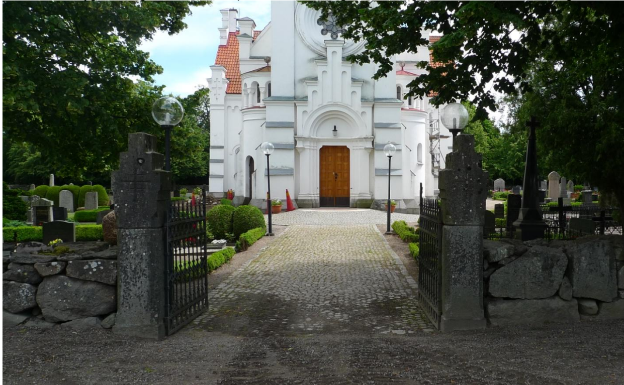
Huvudentrén mot väster har smidesgrindar i kraftfulla grindstolpar av grå granit med trappgavelmotiv. Gången har smågatsten liksom den halvcirkulära rampen till kyrkans västportal. Kyrkogårdsmuren är en kallmur av sprängsten med inslag av fältsten.
