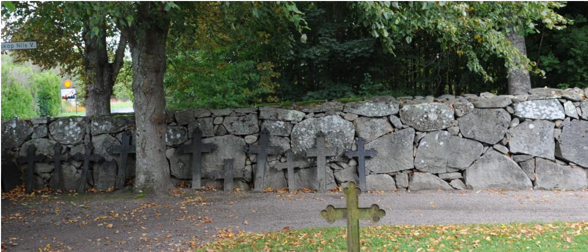
Kyrkogårdsmuren mot nordöst är av fältsten, vackert kilad och med en samling äldre tillvaratagna gjutjärns kors.
