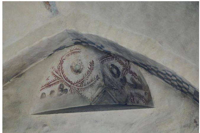
Rest av äldre fönster vid norra valvbågen
