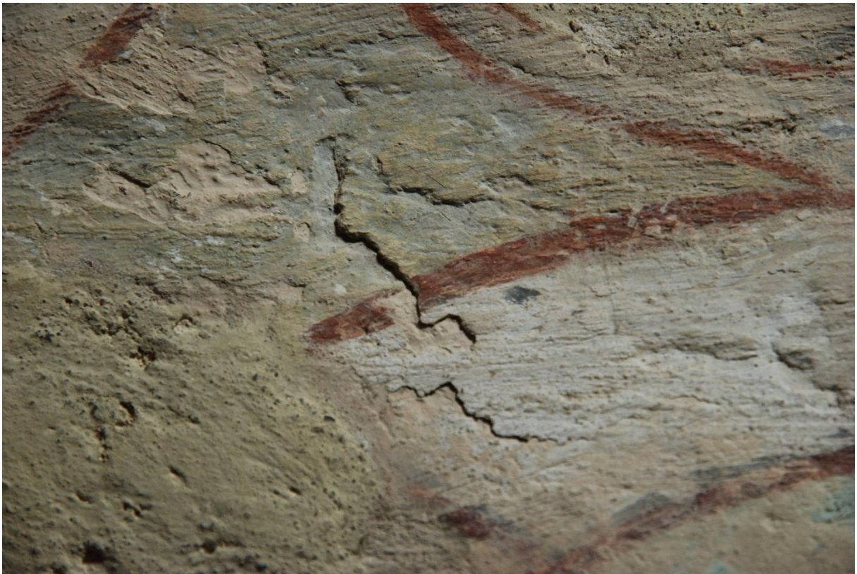
Bild 8: spjälkningar i färgskiktet
