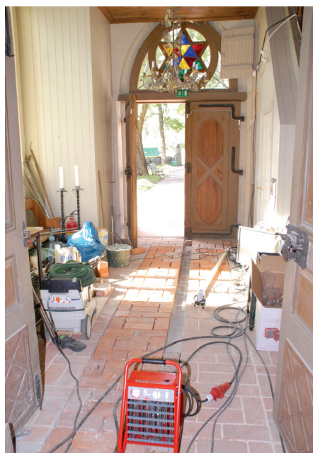
Golvet i vapenhuset blev lagt i september.
