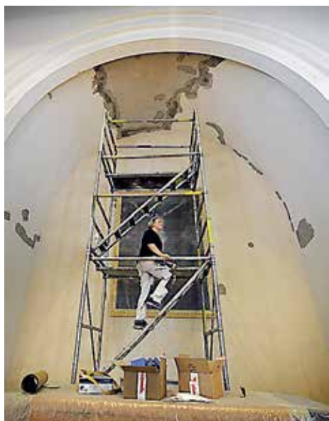
Renoveringen av S:t Örjans kyrka pågick under drygt sex veckor.
