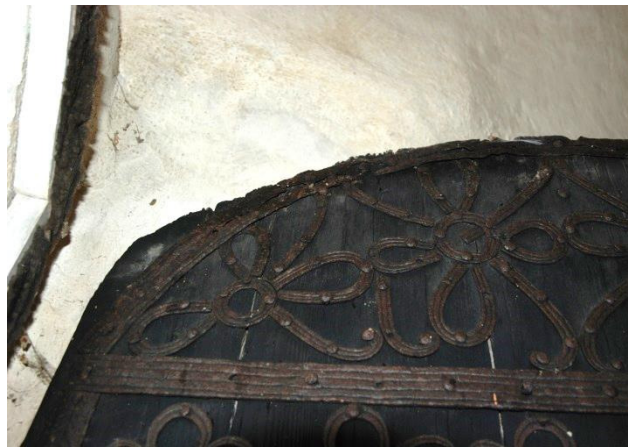
Bild 3-5. Till vänster: insidan av dörren med sentida brädning och stocklås. Uppe till höger: fårskinnsstättningen vid dörranslagets överkant. Nedan till höger: rostskadorna är som värst där smidet har legat emot fårskinnet.
