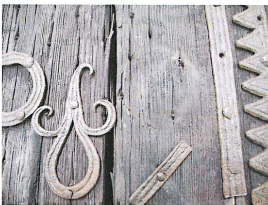
Bild 2 .Detaljbild. Lösa metalldelar.
