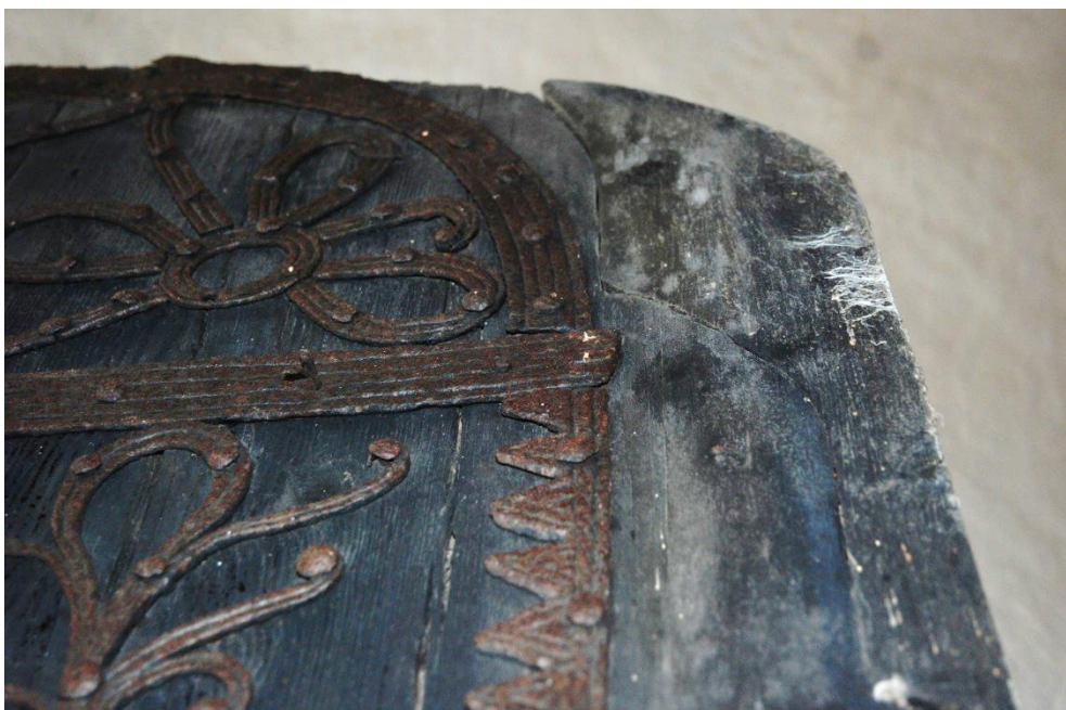
Bild 6: Dörrens över högra kant, där en bräda tillfogats för att passa i den nuvarande dörröppningen.
