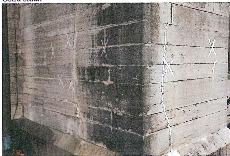
Västra och södra sidan (till höger)
