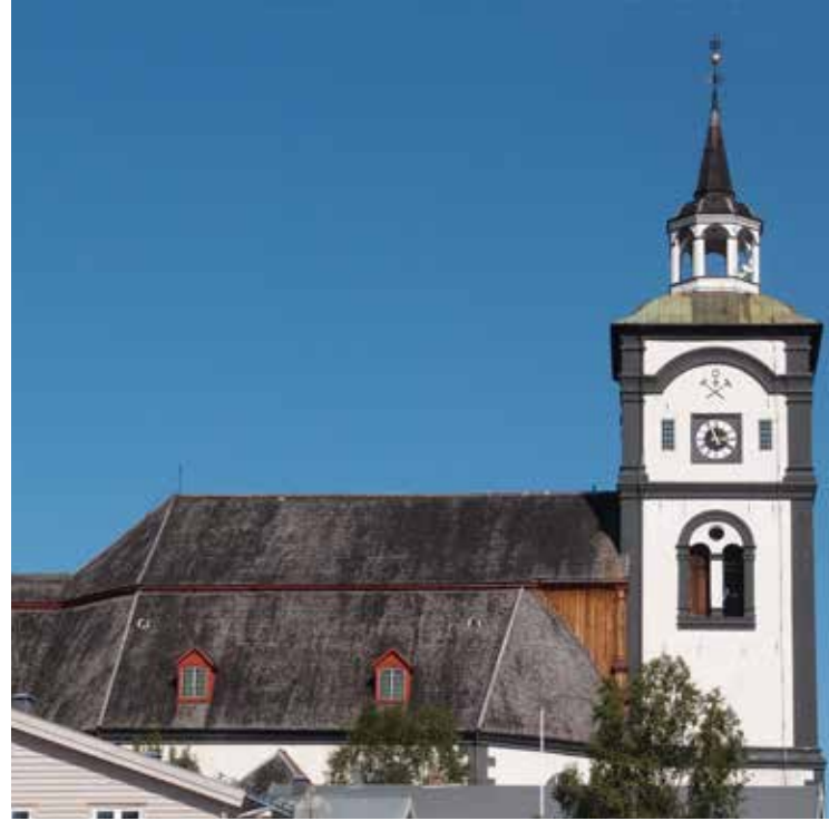
Stavspånen med "pansarskikt" av tjära, kol och sand på Røros kyrka i Norge, är från 1700-talet. Foto: Sara Höglund.
