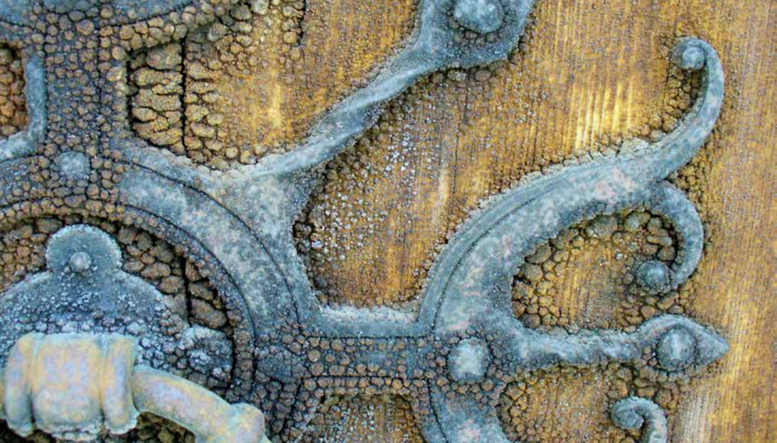
Underhåll av tjärskiktet under lång tid bygger ett karakteristiskt mönster, då underlaget är mättat och tjäran rör sig med temperaturen. Foto: Arja Källbom.
