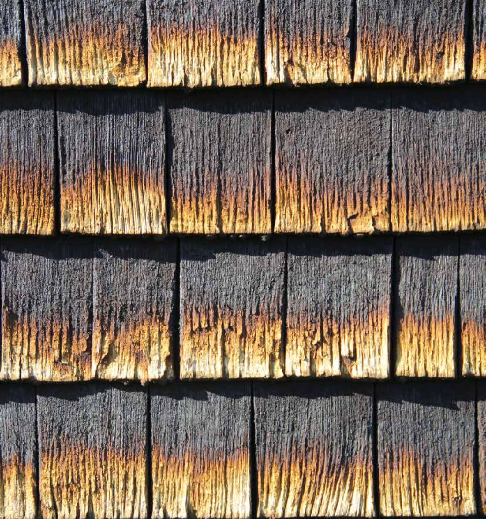
Stenkolstjärad och uppluckrad fasad på Pelarne kyrka i Småland. Foto: Arja Källbom.
