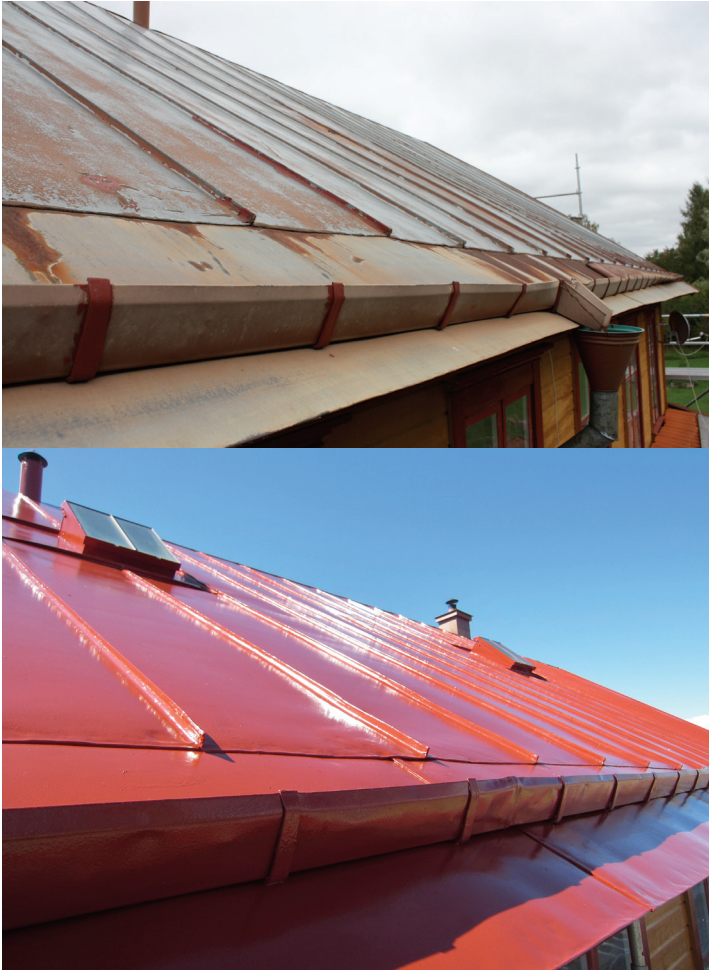
Fig. 8-9. Bandtäckt, fabriksmålade (flagande Plastisol) plåttak från 1990-talet. Det sandblästras och slipas manuellt, tvättas, innan det målas med fosfatrisk alkydolja grundfärg och sedan modifierad linolja färg. Idelunds Möbelfabrik. Foto: Arja Källbom
