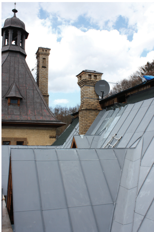
Fig. 10. Delvis ny, förprimad plåt (polyester) som sedan målas med linoljefärg. Slottsvillan i Huskvarna, byggnadsminne. Foto: Arja Källbom
