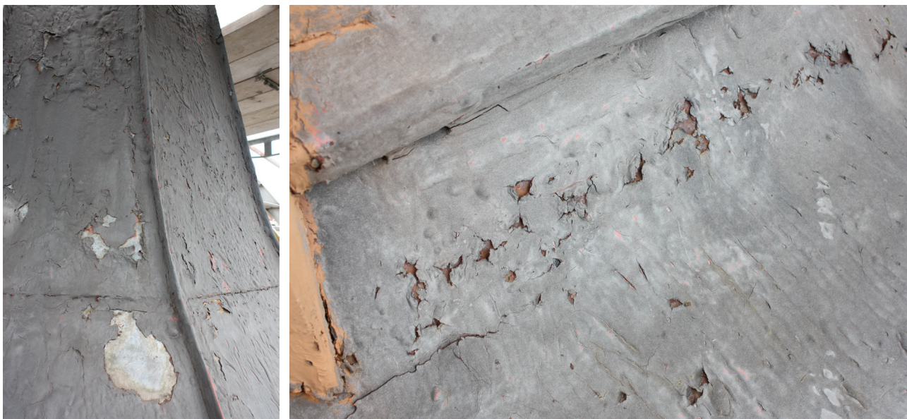
Fig. 12-13. Korrosionsskador föranleder takbyte. Orsakad av s k Hagmannitmassa. Foto: Arja Källbom
