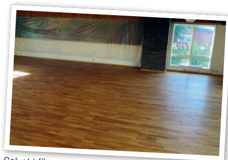
Golvet i församlingshemmet i Skillingaryd har slipats och oljats.
