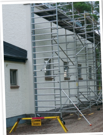
Kapellet får tillbaka sin ursprungliga färg på tak och plåtdelar.
