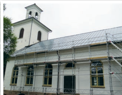
Tak, takfot och lanternin på Åkers kyrka målas.
