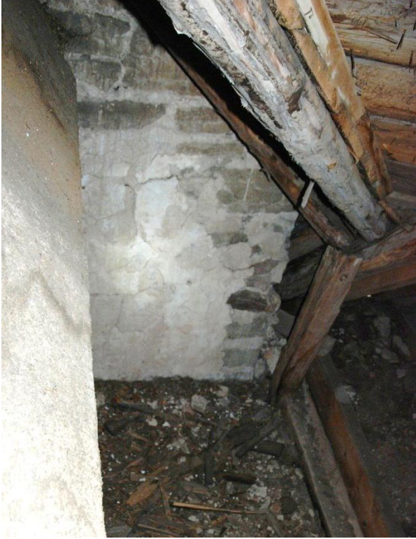
Bild 9: Långhusets östvägg med delvis bevarad puts, sedd från sakristievinden. Till vänster i bild den bevarade romanska taktrönen över koret.
