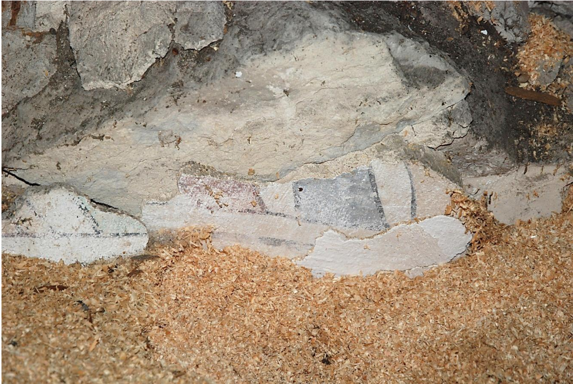
Bild 5: norra korväggen, öster om bindbjälken som syns på bild 4. Till vänster i bild syns ett stycke puts som är helt löst och vilar i sågspånet. Till höger syns den tunnare 1700-talsputsen som ligger över måleriet.
