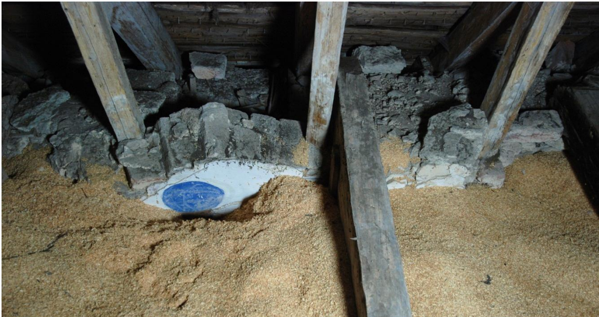
Bild 6: södra korväggen, med en lite större del av det medeltida valvet bevarat. Den blå cirkeln till vänster utgör toppen på draperimålningen från 1700-talet, en liten bit ner i sågspånet knyts det blå draperiet samman av ett gulfärgat tåg.
