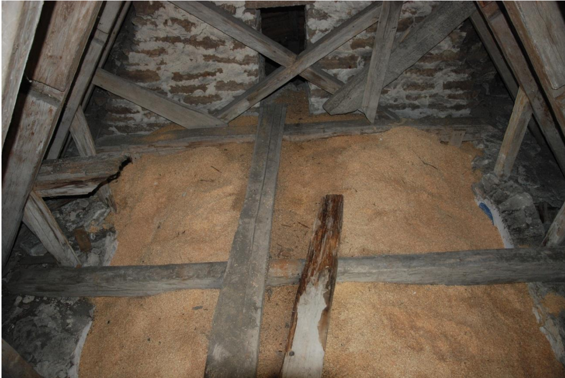
Bild 3: utsikt över korvinden. Överst i bild är passagen till absidvinden.
