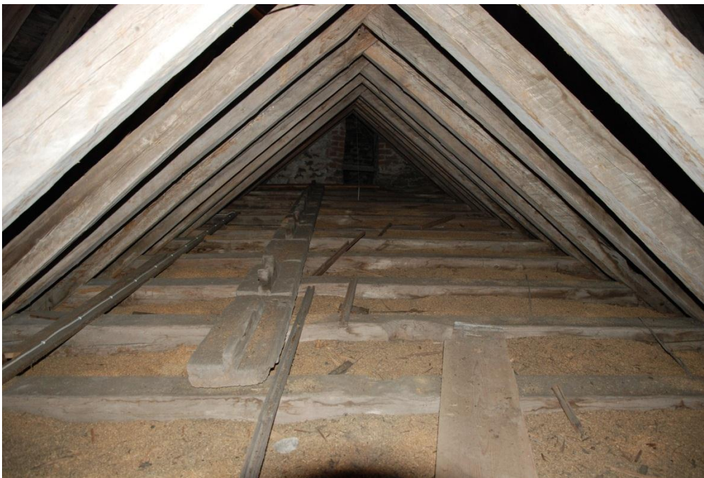
Bild 2: den romanska takstolen över långhuset. Den dekorerade styrplankan syns till vänster.
