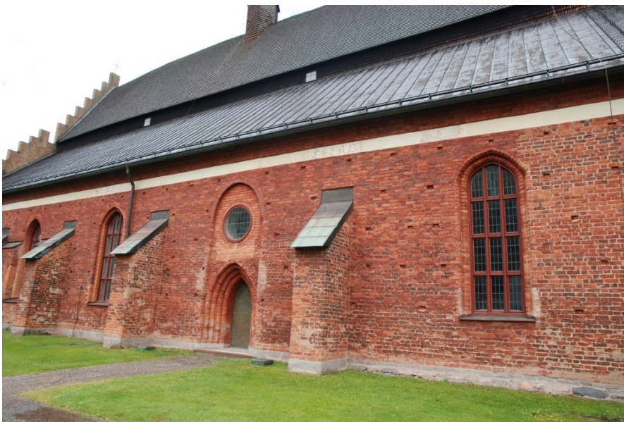
Sydfasaden med blinderingslist under takfoten
