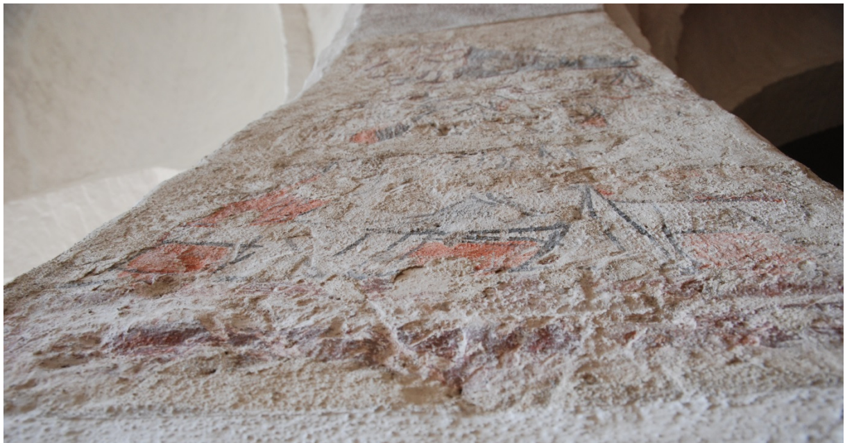
Biskopsbilden sedd nedifrån. Trots att putsen är mycket ojämn är målningen elegant tecknad. En liten öppen putskant syns längst ned på målningen, ungefär i mitten. Denna behöver egentligen inte åtgärdas, men kan kittas i samband med annat konservatorsarbete.
