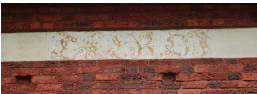
Sydfasaden, mitten. Text i blinderingslist.
