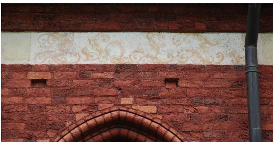
Sydfasaden, väster. Text i blinderingslist.
