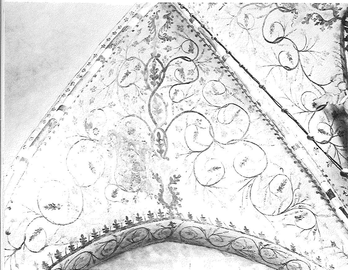
Kalkmålningar i korets norra valvkappa.
