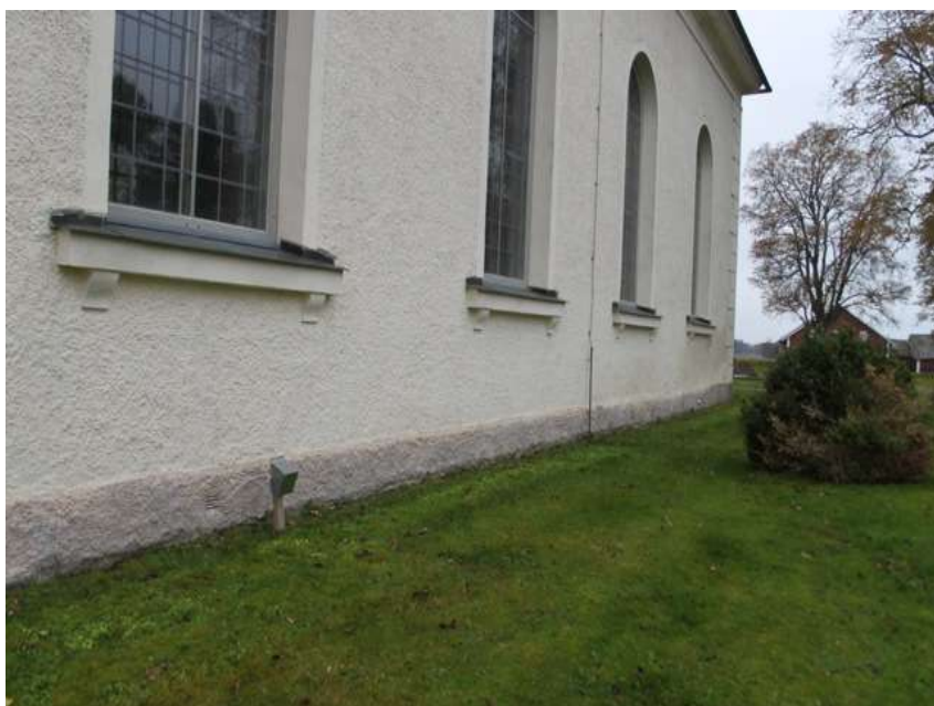
Fig. 4: Transmitter vid kyrkans nordöstra hörn.
